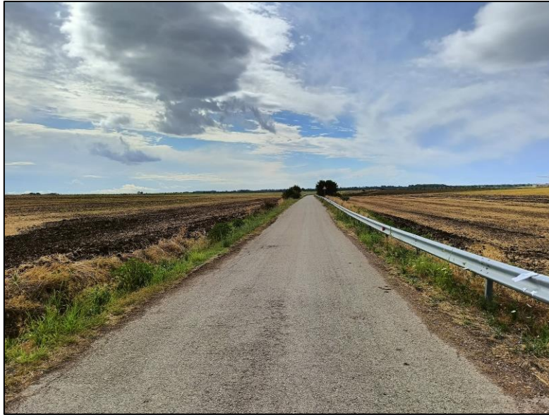
FIGURA 35 GRAVINA IN PUGLIA (BA): PANORAMICA SULLE RCG_5, 6, 8 DA N/E
