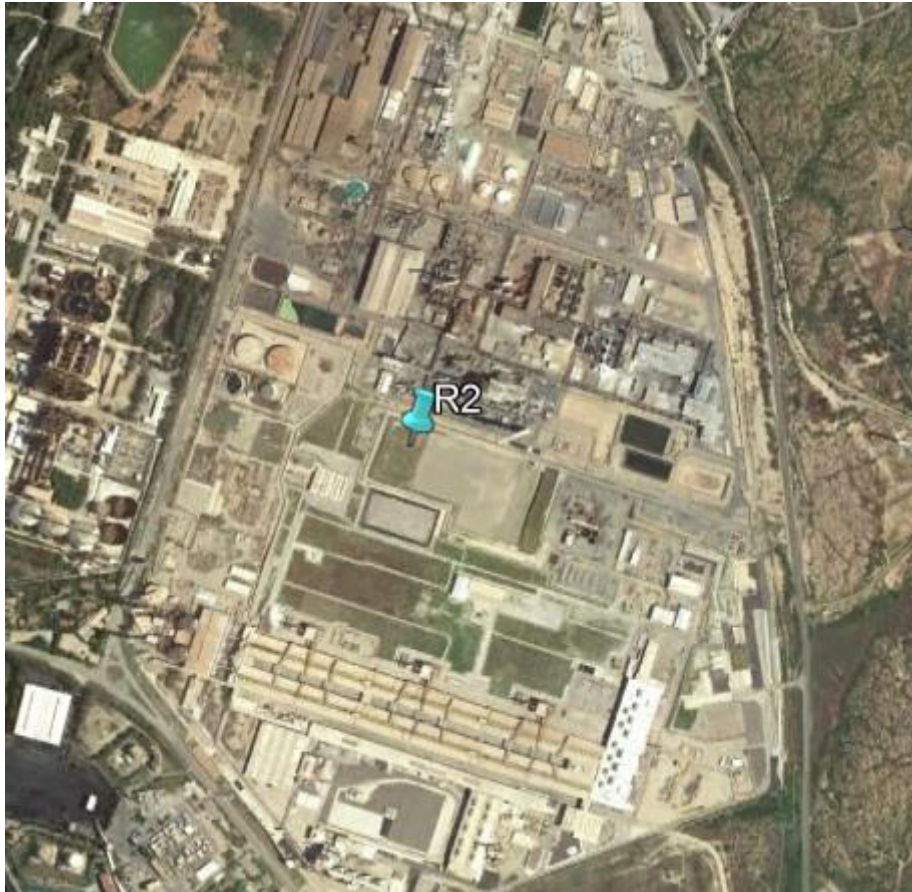
Figura 3-3 - Portovesme s.r.l., foto aerea
