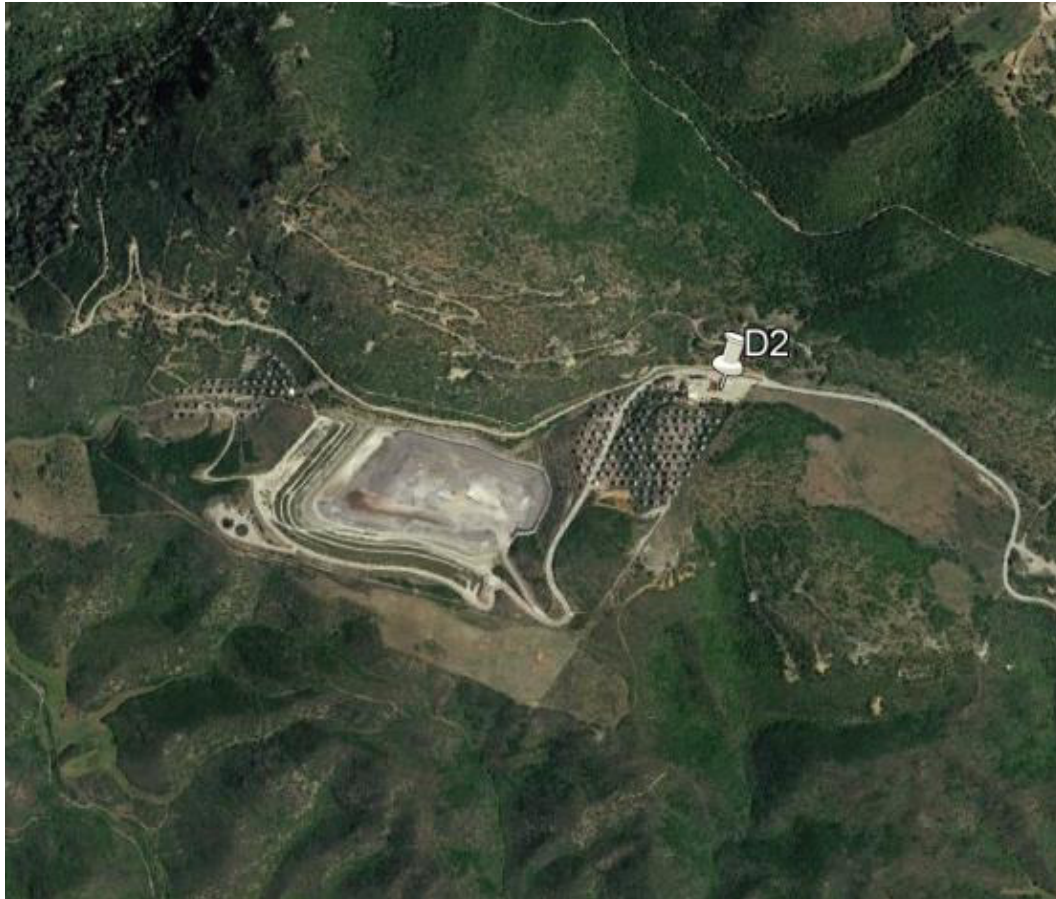
Figura 3-6 - RIVERSO SPA, foto aerea
