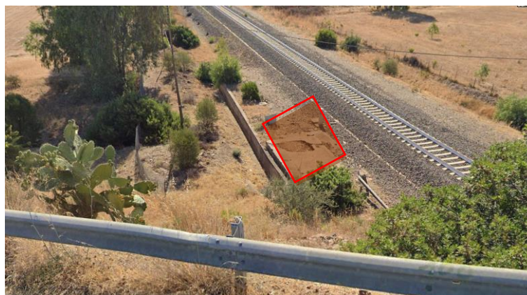
Figura 15 Vista Opera civile 5
