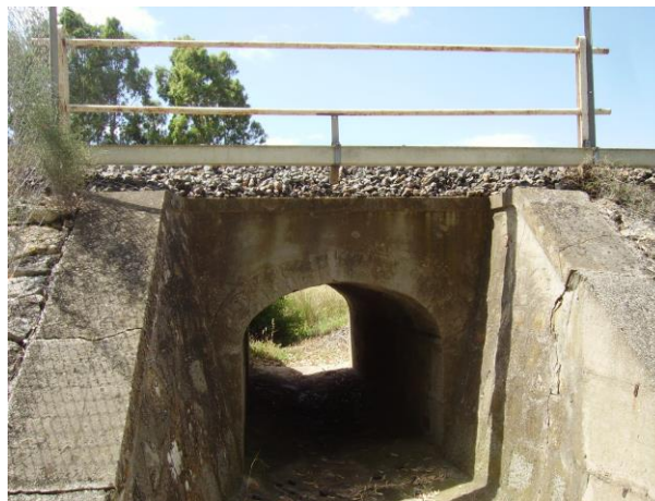
Figura 27 Vista Opera civile 11
