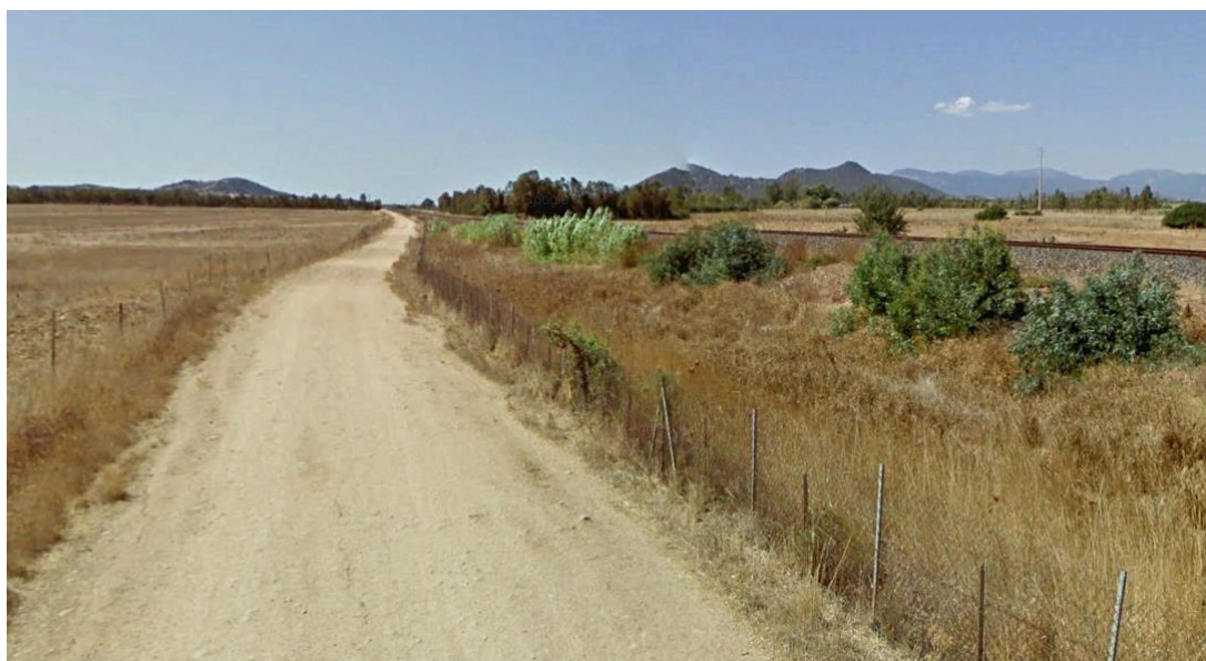
Figura 6-32 Strada adiacente alla rete ferroviaria oggetto di adeguamento con la NV01
