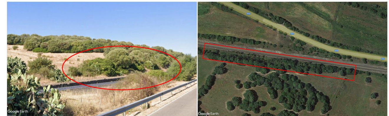
Figura B-22 Rilievo fotografico della vegetazione naturale interessata dall'opera lineare. In rosso sono evidenziate le piante interessate dall'opera
