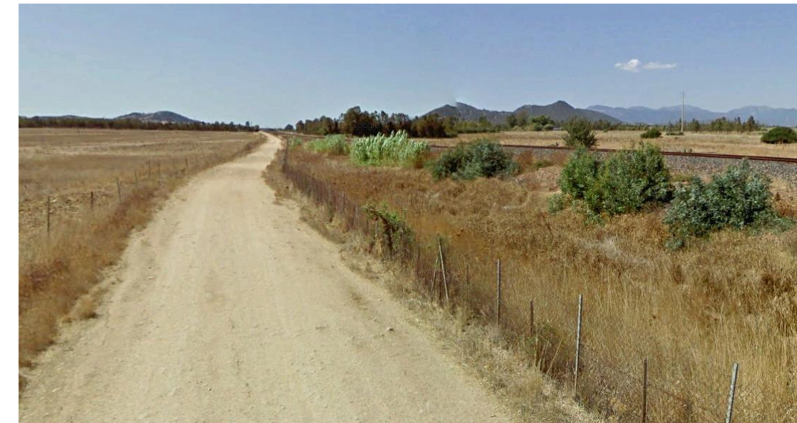
Figura B-27 Strada adiacente alla rete ferroviaria oggetto di adeguamento con la NV01
