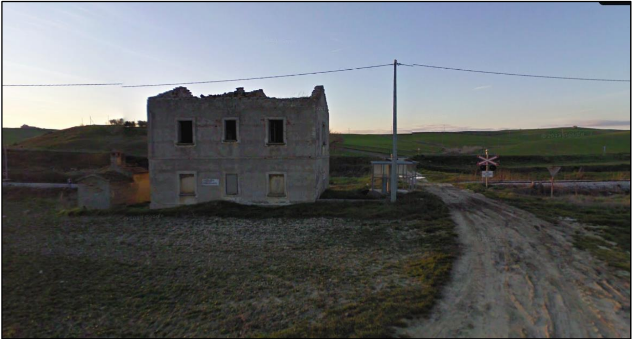
Figura 7.1.5.2: Ex Casa cantoniera, Comune di Irsina (MT) (Fonte Google Earth)
