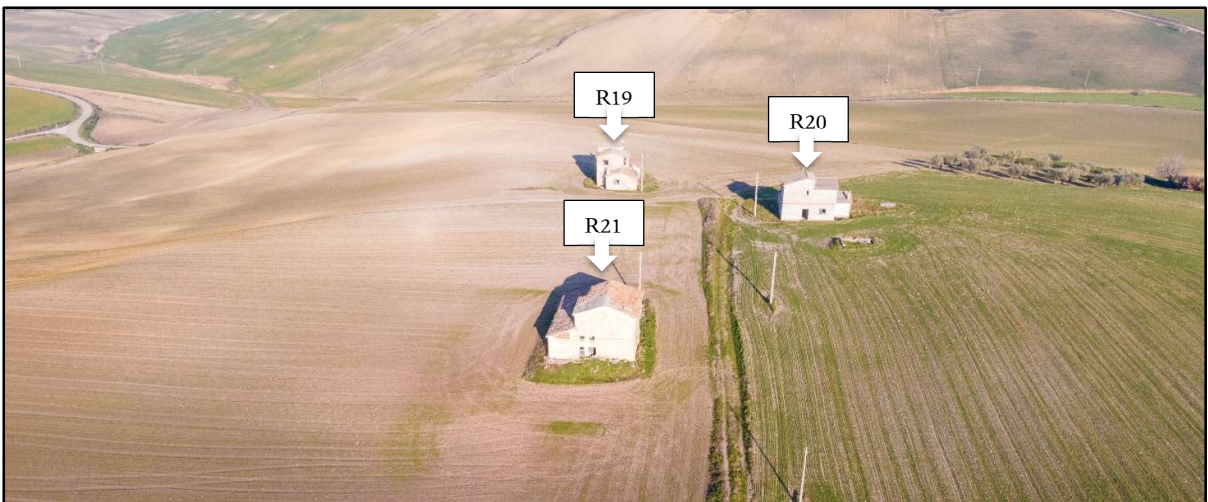
Foto 18a: R19-Fabbricato Diruto; R20-Fabbricato Diruto; R21-Fabbricato Diruto
