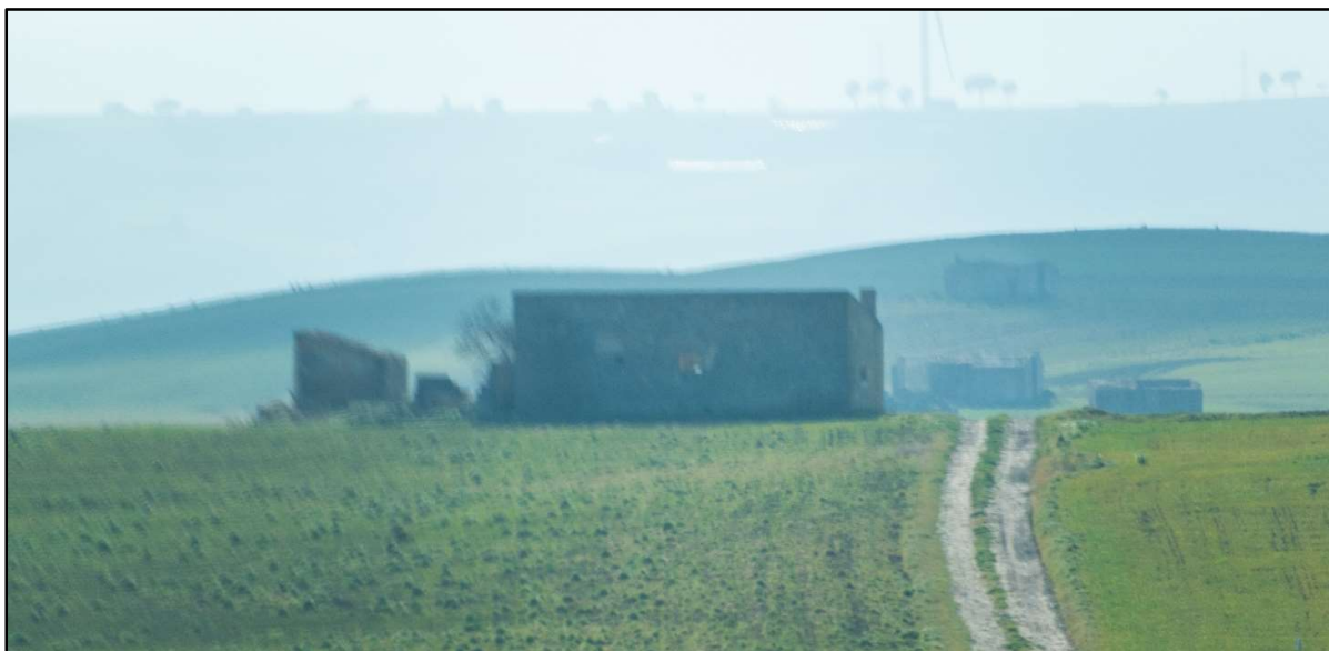
Foto 3a: R03-Fabbricato Diruto
