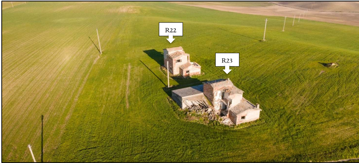
Foto 19a: R22-Fabbricato Diruto; R23-Fabbricato Diruto
