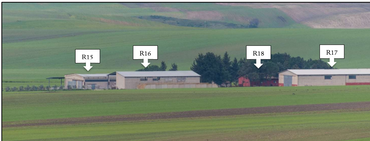
Foto 14a: R15-Non Abitazione; R16-Non Abitazione; R17-Non Abitazione; R18-Non Abitazione
