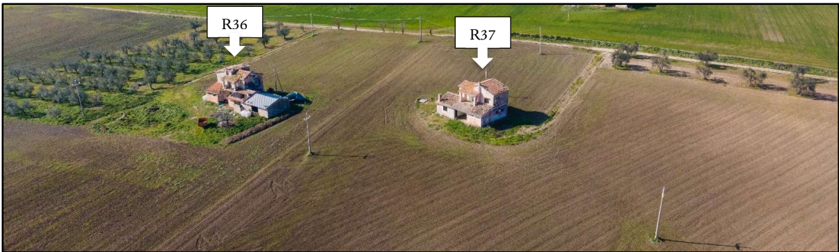
Foto 25a: R36-Fabbricato Diruto; R37-Fabbricato Diruto
