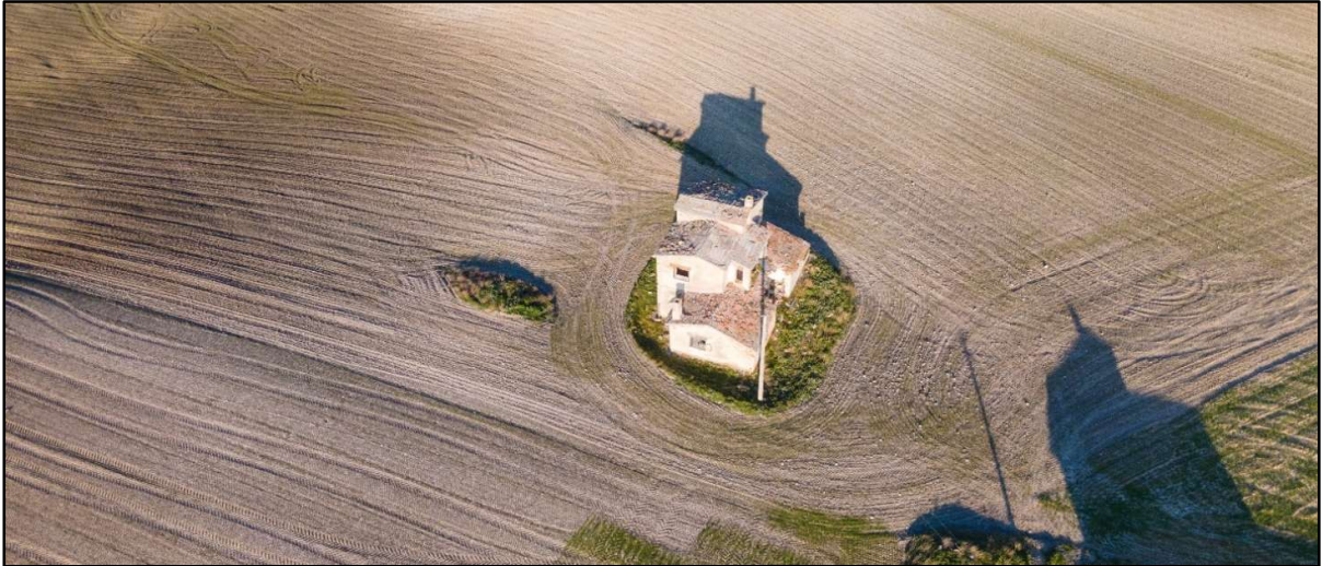
Foto 16a: R19-Fabbricato Diruto
