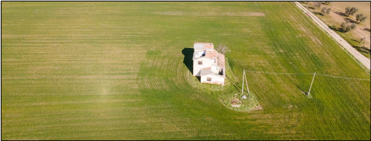
Foto 27a: R38-Fabbricato Diruto
