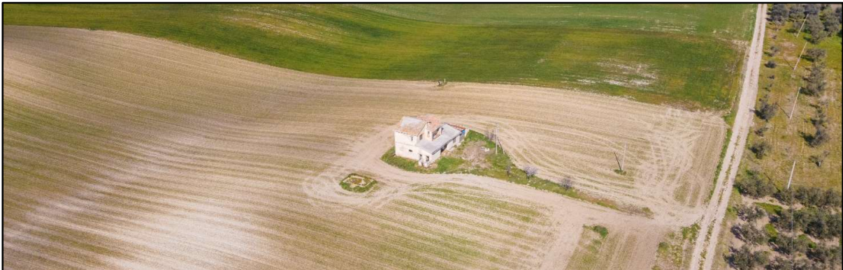
Foto 31a: R42-Fabbricato Diruto
