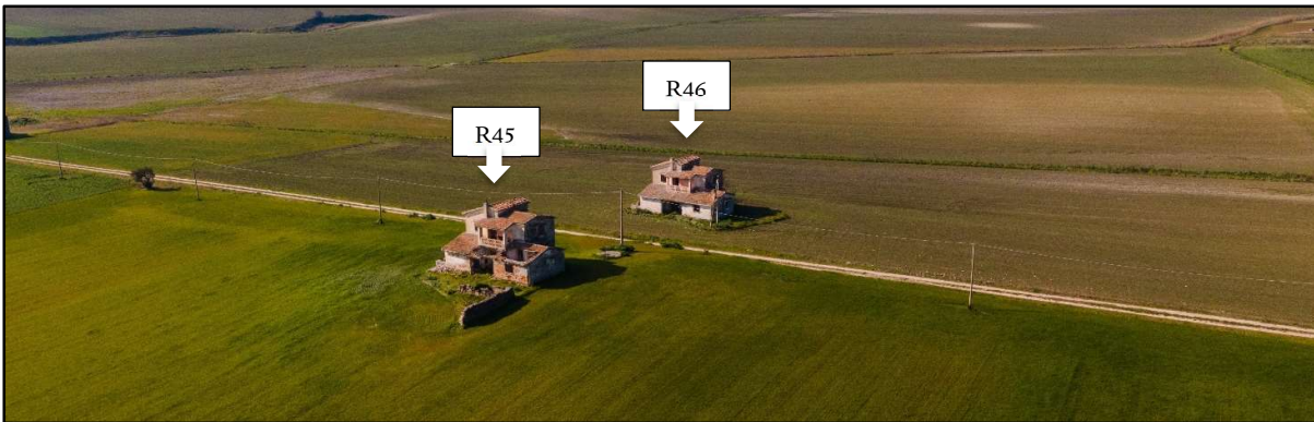
Foto 34a: R45-Fabbricato Diruto; R46-Fabbricato Diruto
