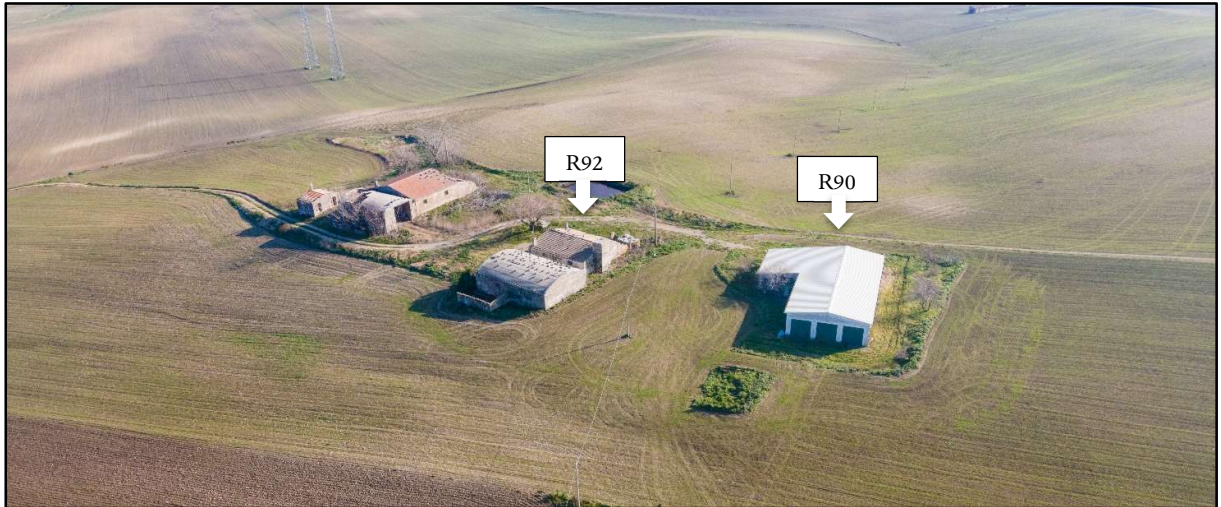
Foto 63a: R90-Non Abitazione; R92-Fabbricato Diruto
