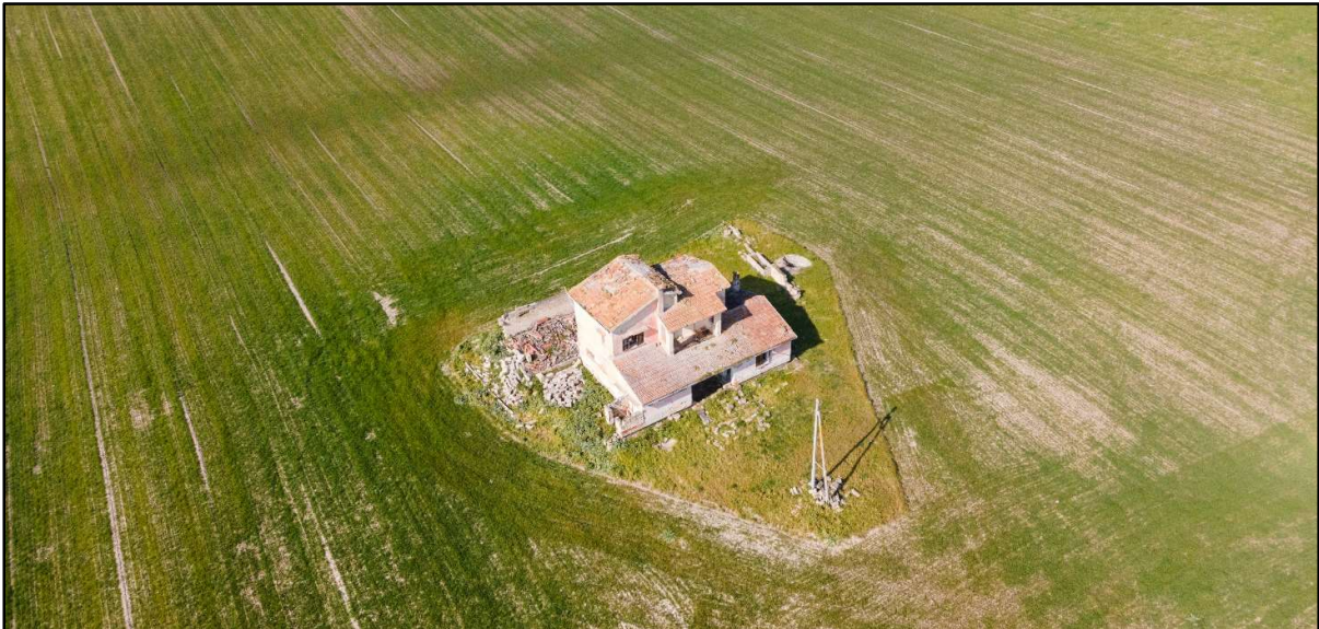
Foto 29a: R40-Fabbricato Diruto
