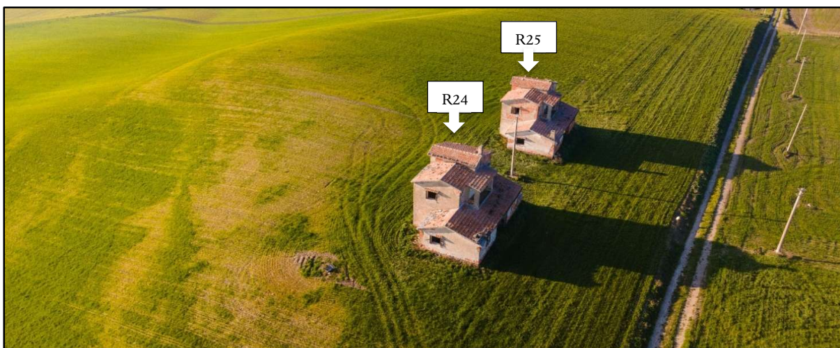
Foto 20a: R24-Fabbricato Diruto; R25-Fabbricato Diruto
