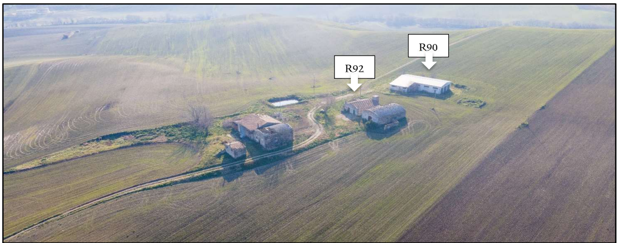
Foto 64a: R90-Non Abitazione; R92-Fabbricato Diruto
