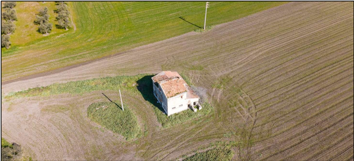
Foto 30a: R41-Fabbricato Diruto
