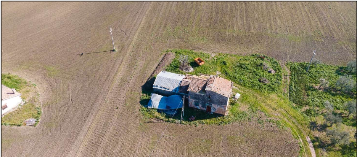
Foto 24a: R36-Fabbricato Diruto
