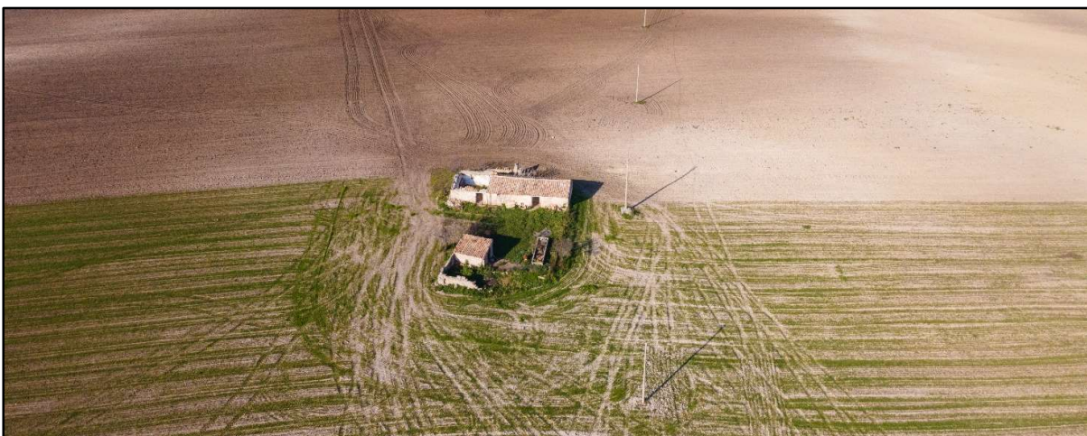
Foto 44a: R65-Fabbricato Diruto
