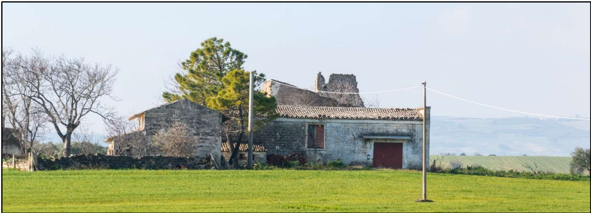
Foto 55a: R79-Fabbricato Diruto
