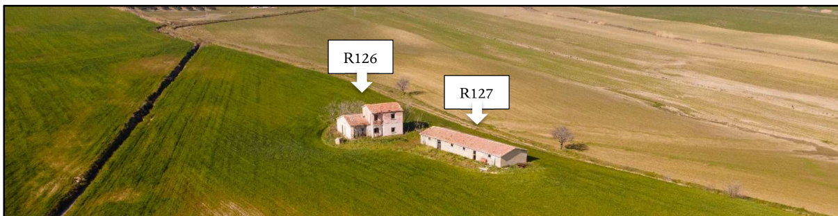
Foto 95a: R126-Fabbricato Diruto; R127-Fabbricato Diruto
