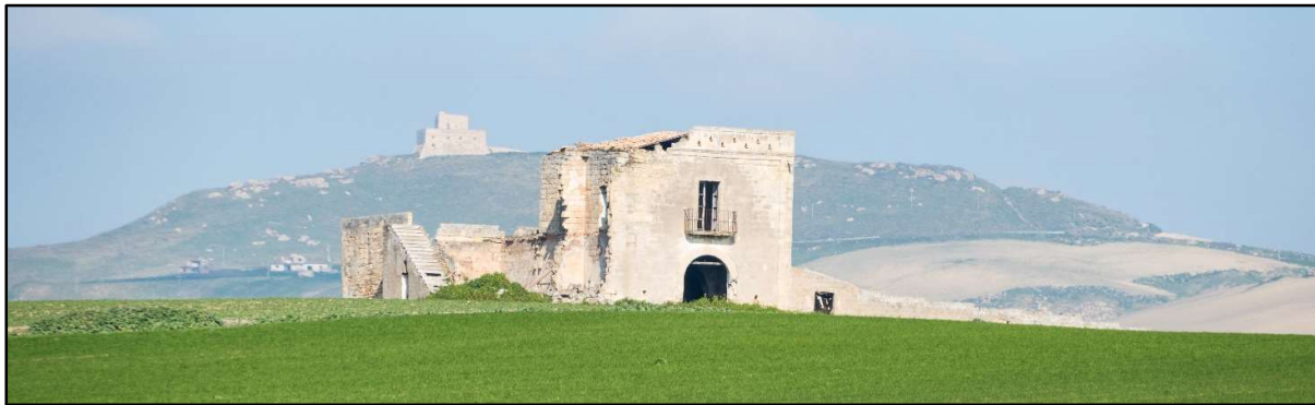
Foto 99a: R132-Fabbricato Diruto
