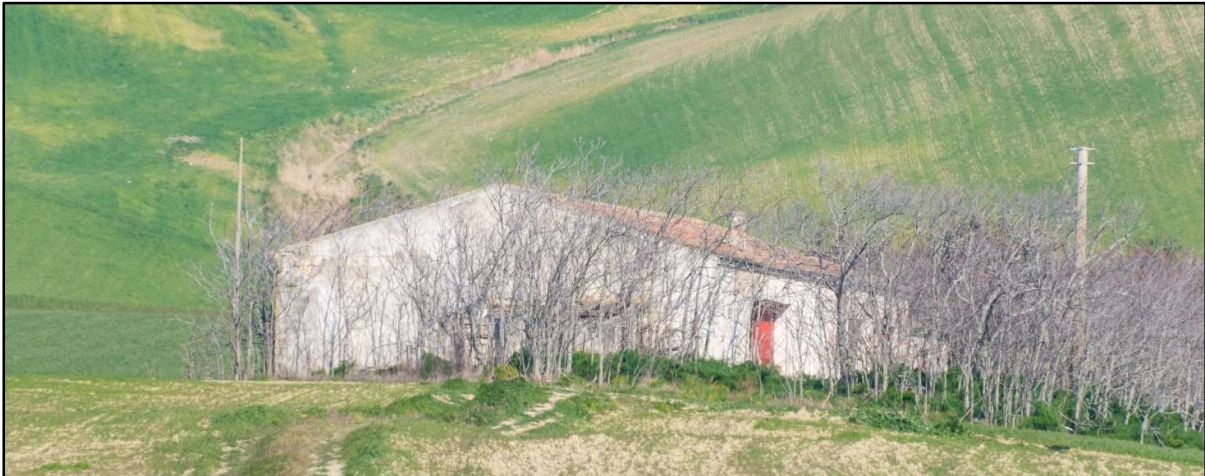
Foto 81a: R109-Fabbricato Diruto
