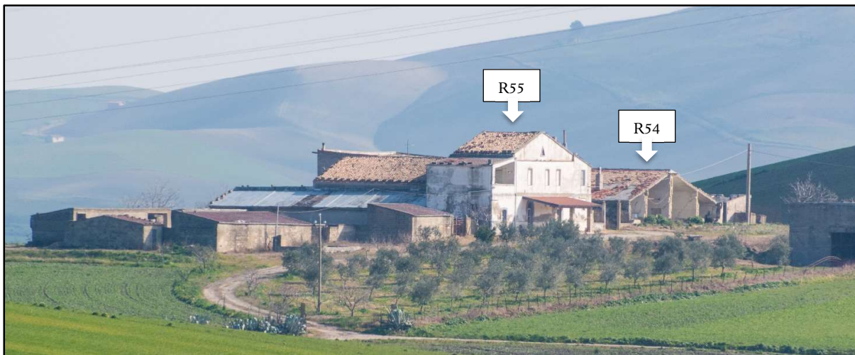
Foto 40a: R54-Fabbricato Diruto; R55-Abitazione
