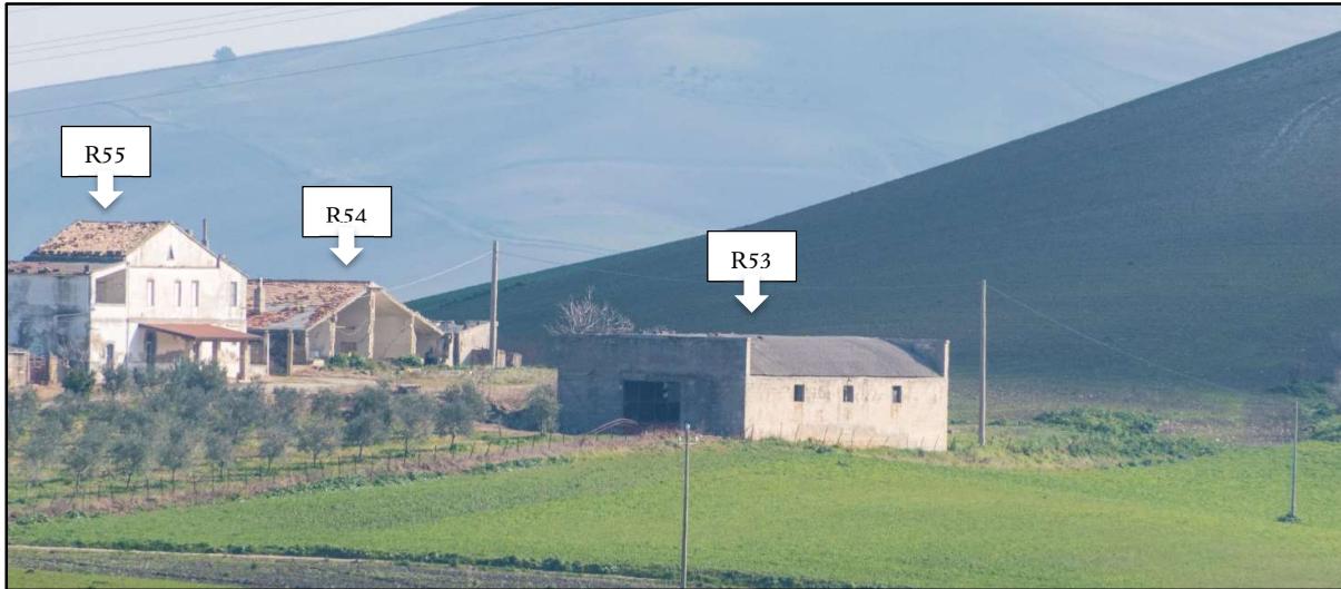
Foto 39a: R53-Non Abitazione; R54-Fabbricato Diruto; R55-Abitazione
