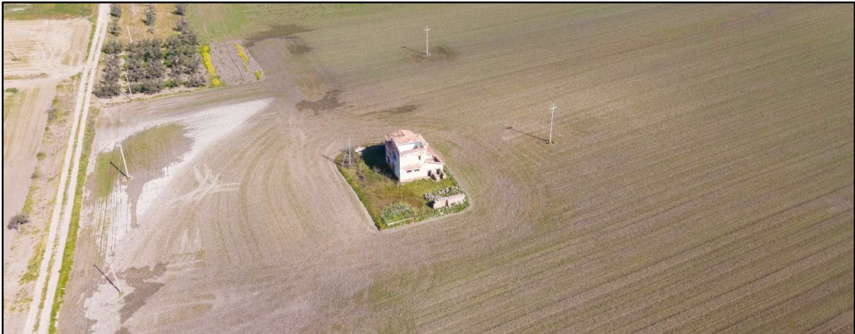
Foto 32a: R43-Fabbricato Diruto
