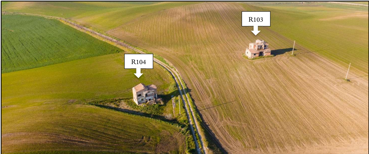
Foto 76a: R103-Fabbricato Diruto; R104-Fabbricato Diruto
