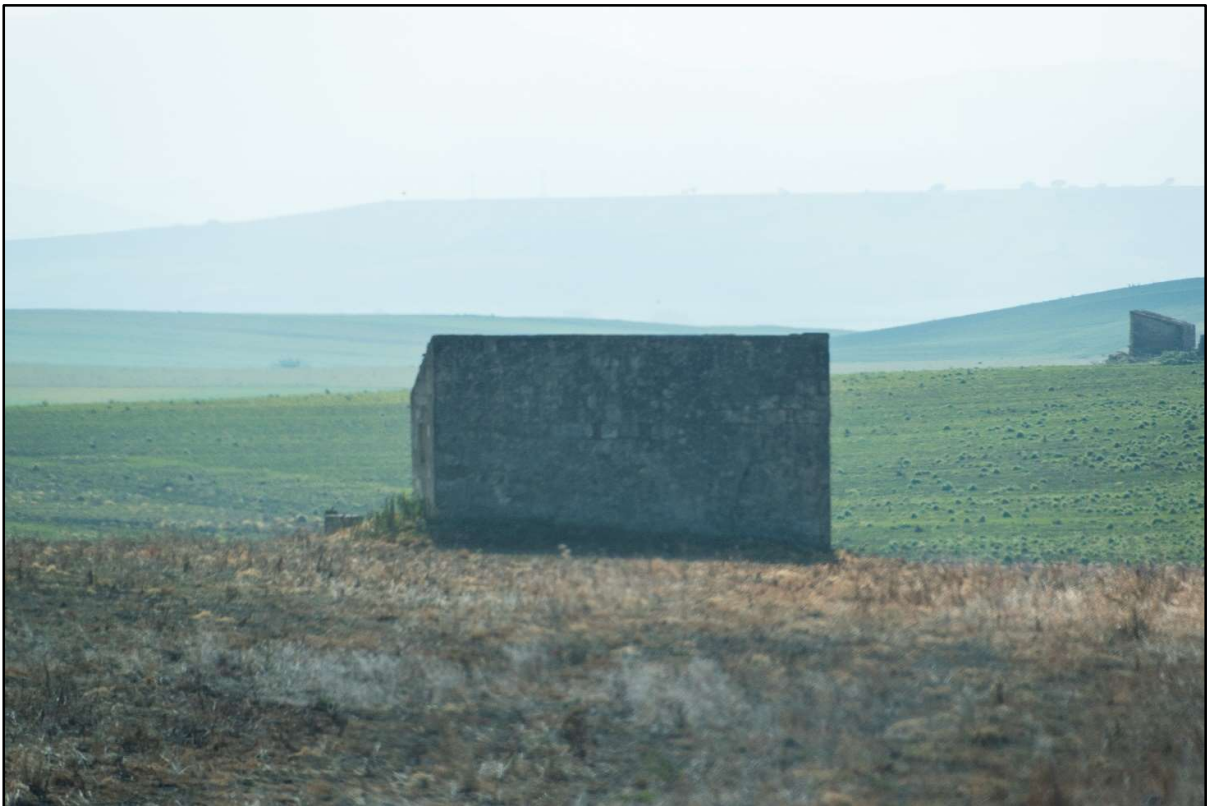
Foto 2a: R02-Fabbricato Diruto
