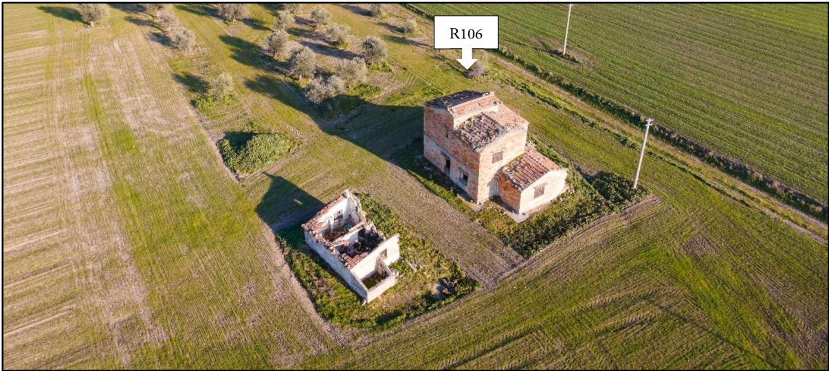
Foto 78a: R106-Fabbricato Diruto
