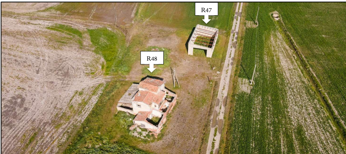
Foto 35a: R47-Fabbricato Diruto; R48-Fabbricato Diruto
