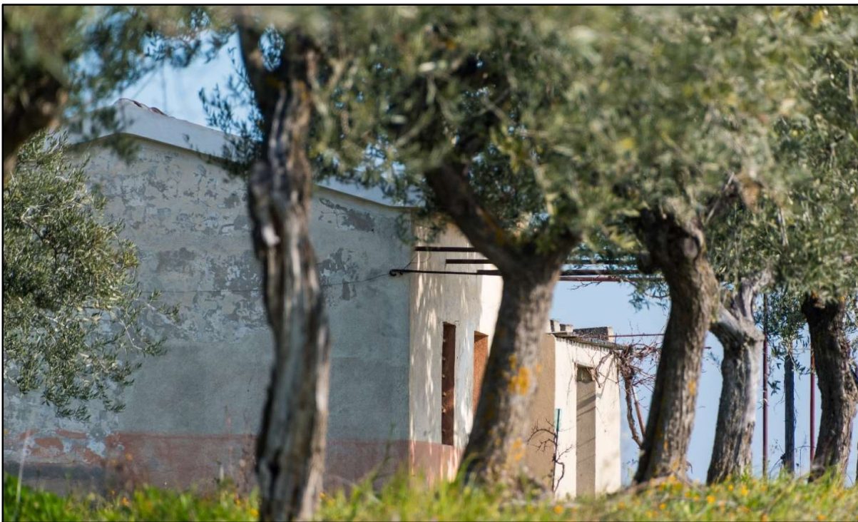
Foto 58a: R82-Fabbricato Diruto
