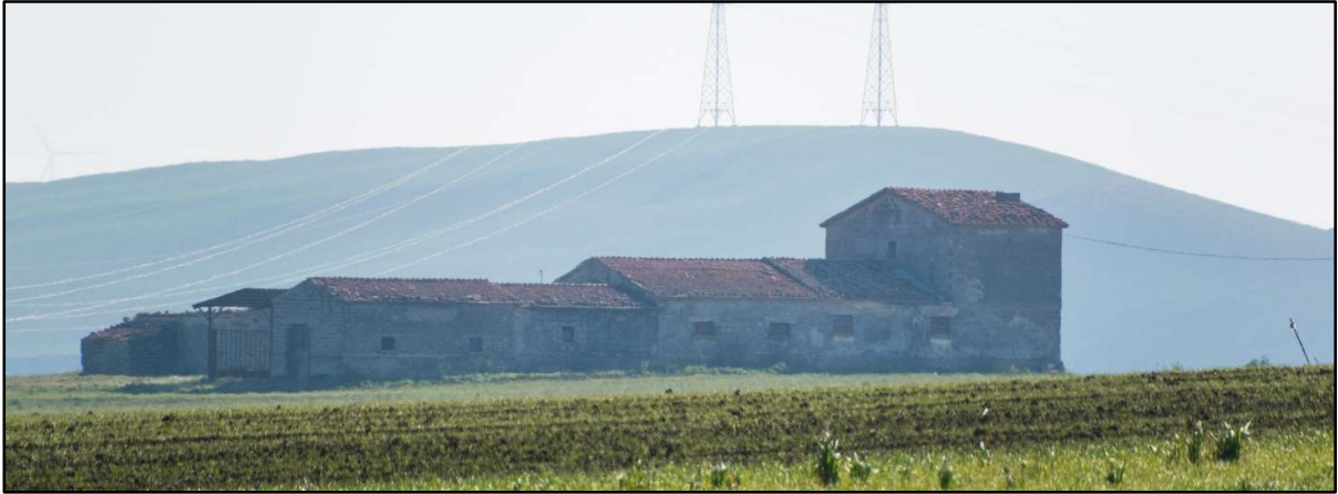
Foto 84b: R113-Fabbricato Diruto
