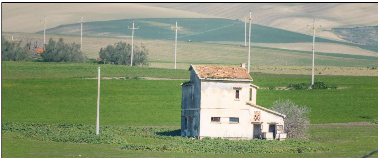
Foto 23a: R35-Fabbricato Diruto
