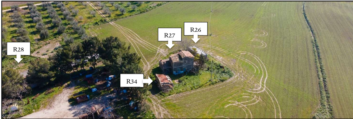
Foto 21a: R26-Fabbricato Diruto; R27-Non Abitazione; R28-Fabbricato Diruto; R34-Fabbricato Diruto
