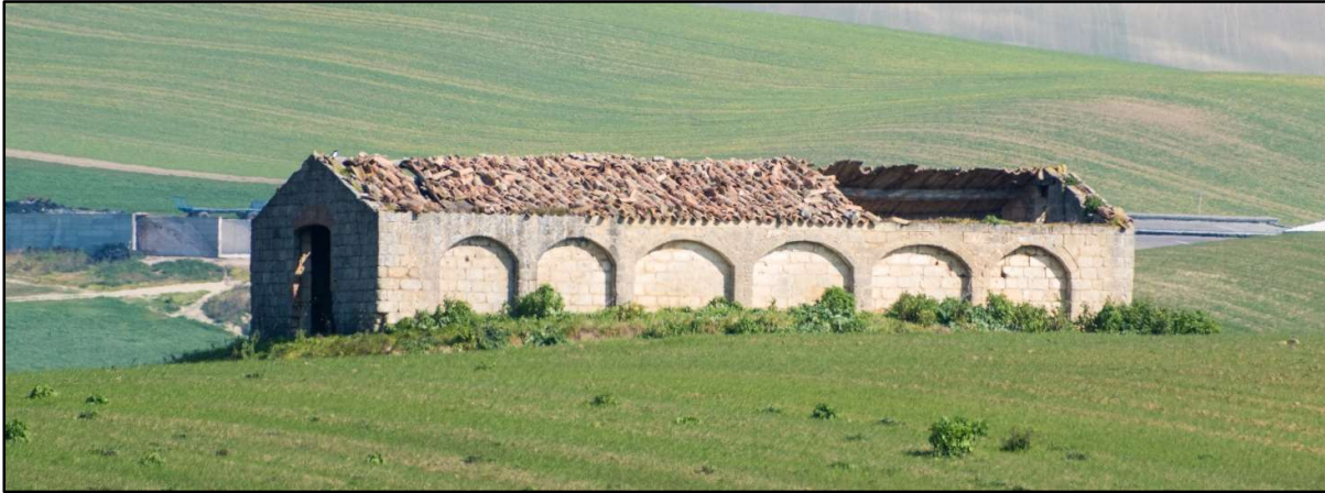
Foto 82a: R110-Fabbricato Diruto
