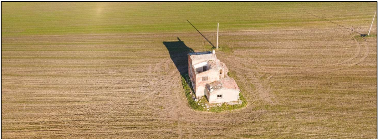
Foto 75a: R103-Fabbricato Diruto
