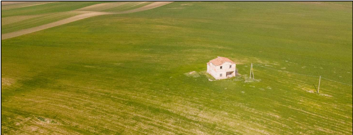
Foto 28a: R39-Fabbricato Diruto
