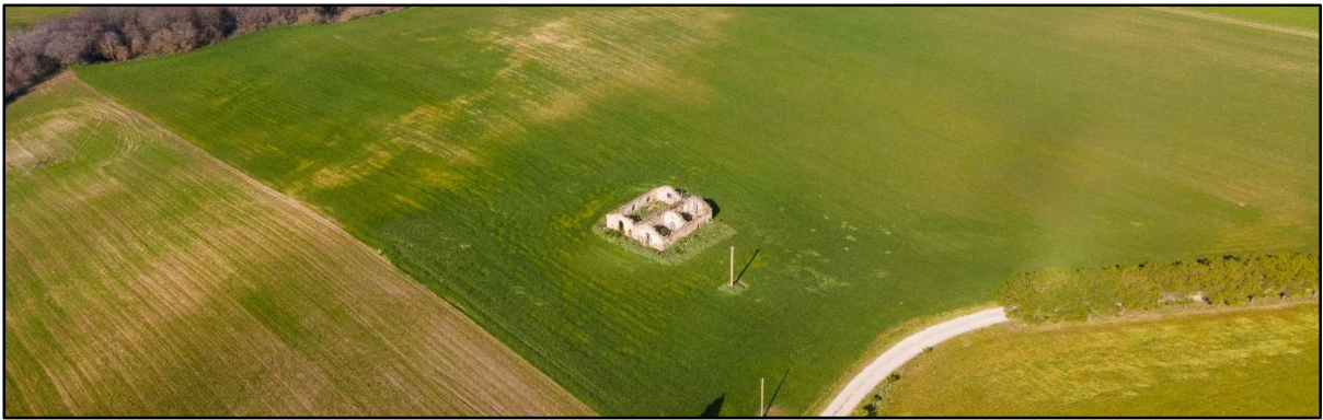
Foto 85a: R114-Fabbricato Diruto
