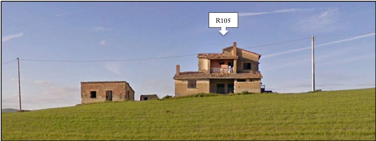
Foto 77a: R105-Fabbricato Diruto
