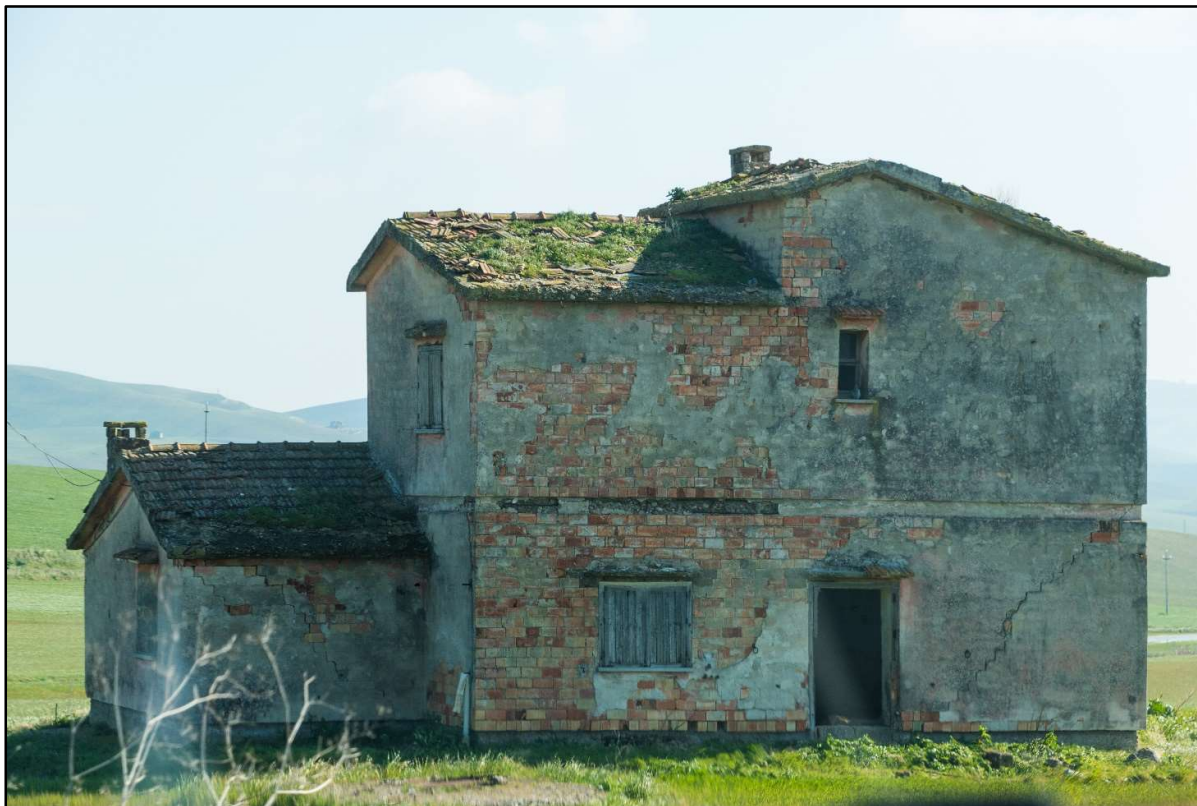
Foto 66a: R93-Fabbricato Diruto
