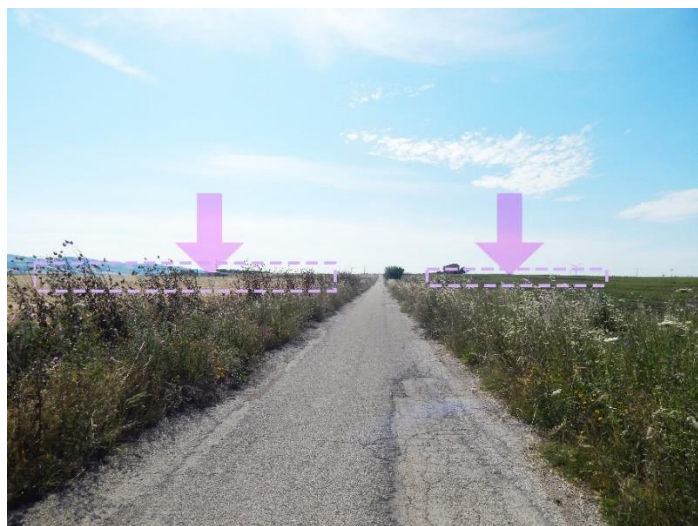
Figura 16 - Vista 4716 - Stato di fatto
