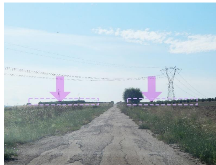
Figura 14 - Vista 4700 - Stato di fatto
