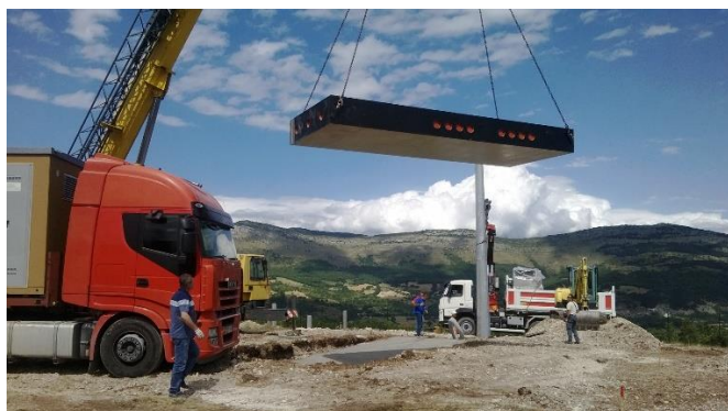
Figura 6-Messa in opera vasca di fondazione
