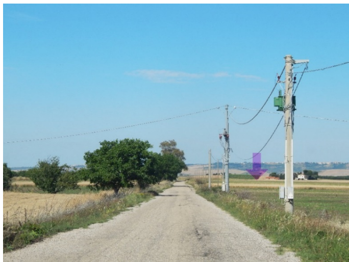
Figura 25 - Vista 4760 - Stato di fatto
