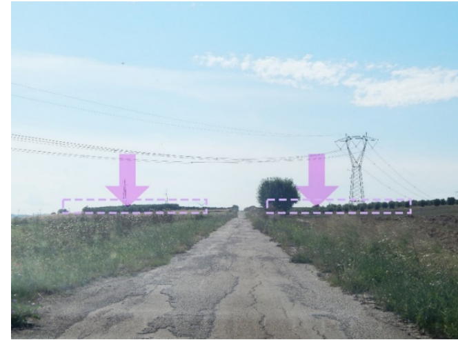
Figura 19 - Vista 4700 - Stato di fatto
