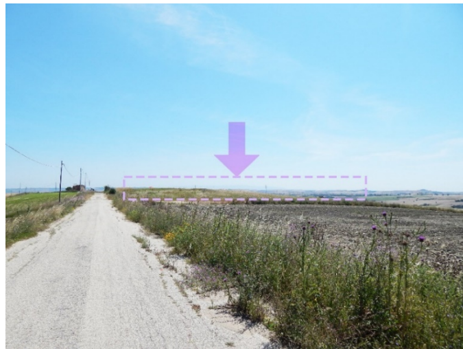
Figura 18 - Vista 4664 - Stato di fatto
