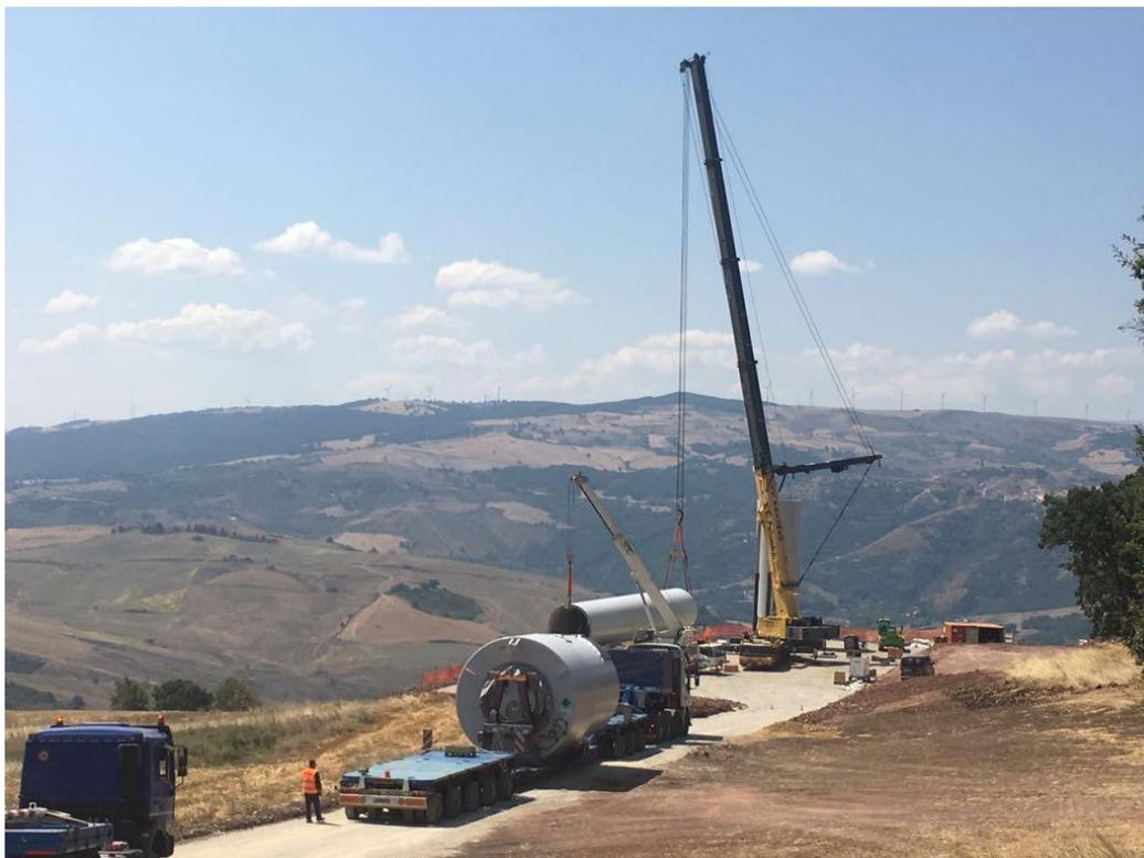
Figura 5.2: Fasi di preassemblaggio a terra della navicella
