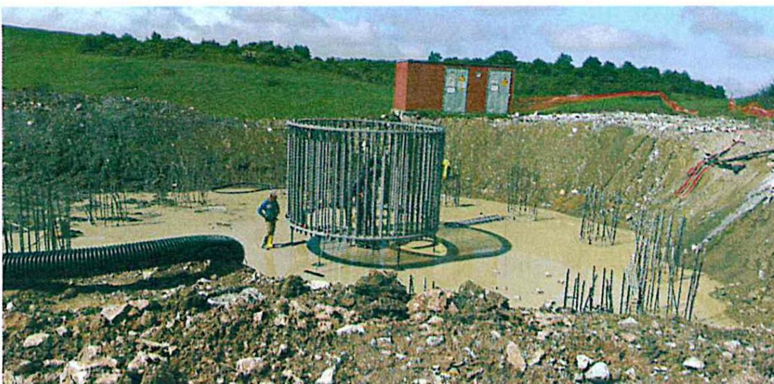
Figura 5.9: Particolare posizionamento anchor cage
