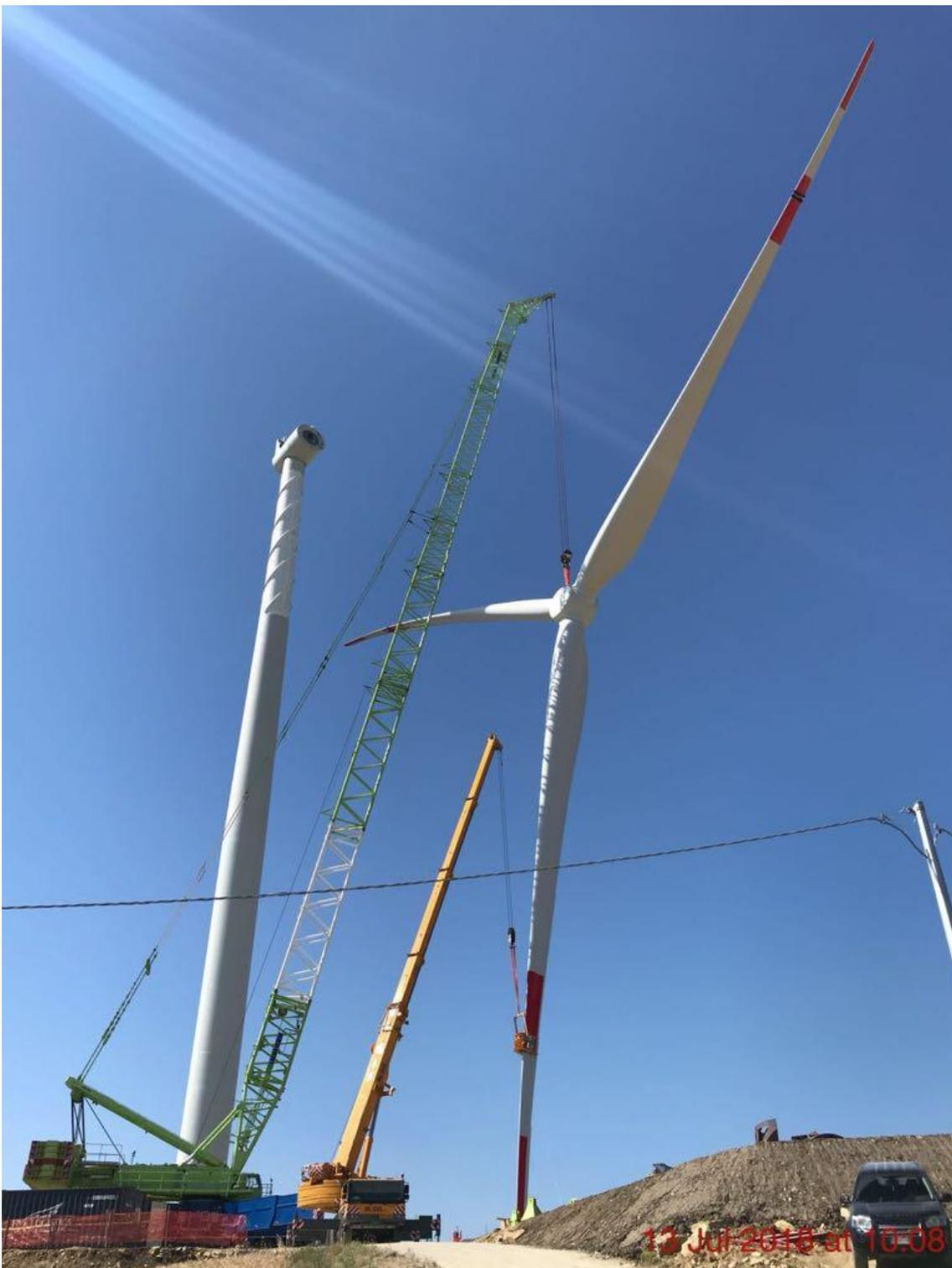
Figura 5.3: Issaggio della "stella" con main crane e autogru ausiliaria
