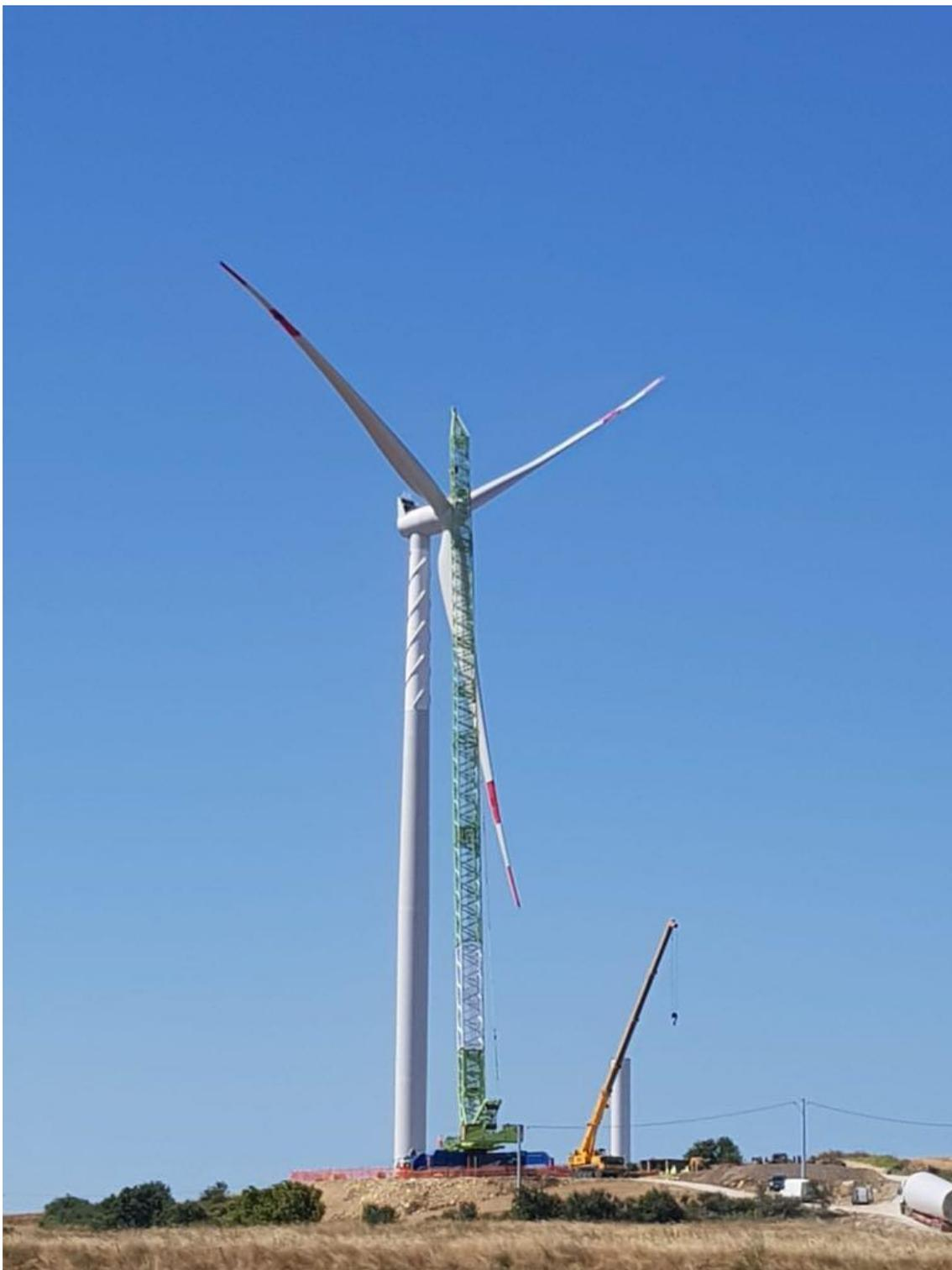
Figura 5.4: Fase di montaggio delle pale dell'aerogeneratore (il preassemblaggio avviene sulla piazzola)
