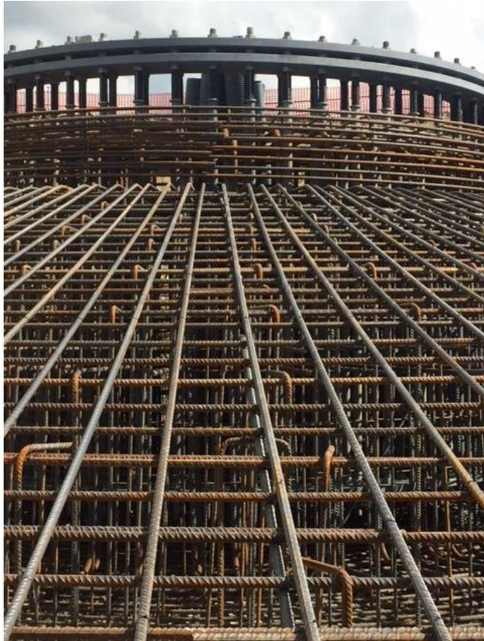
Figura 5.11: Particolare armatura plinto di fondazione
