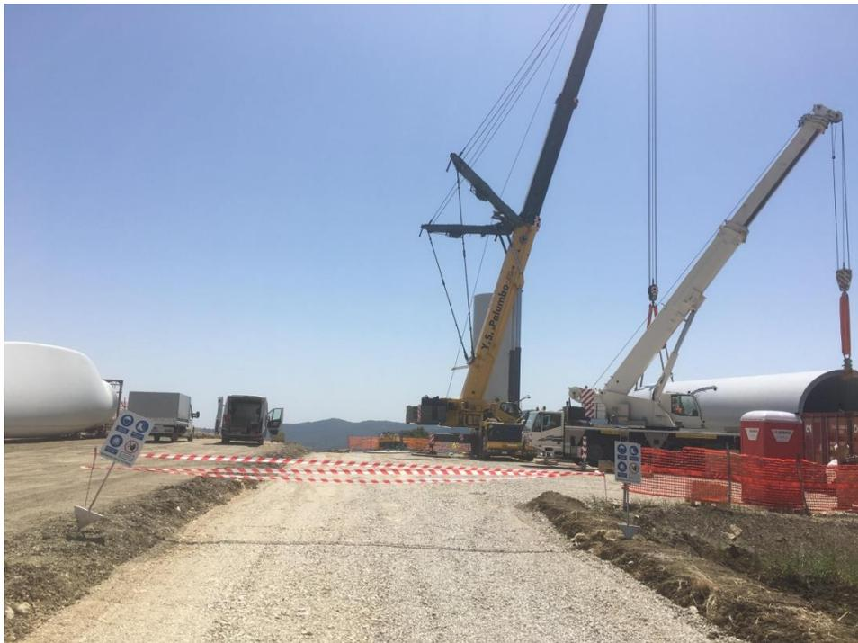
Figura 5.1: Fase di montaggio seconda sezione della torre
