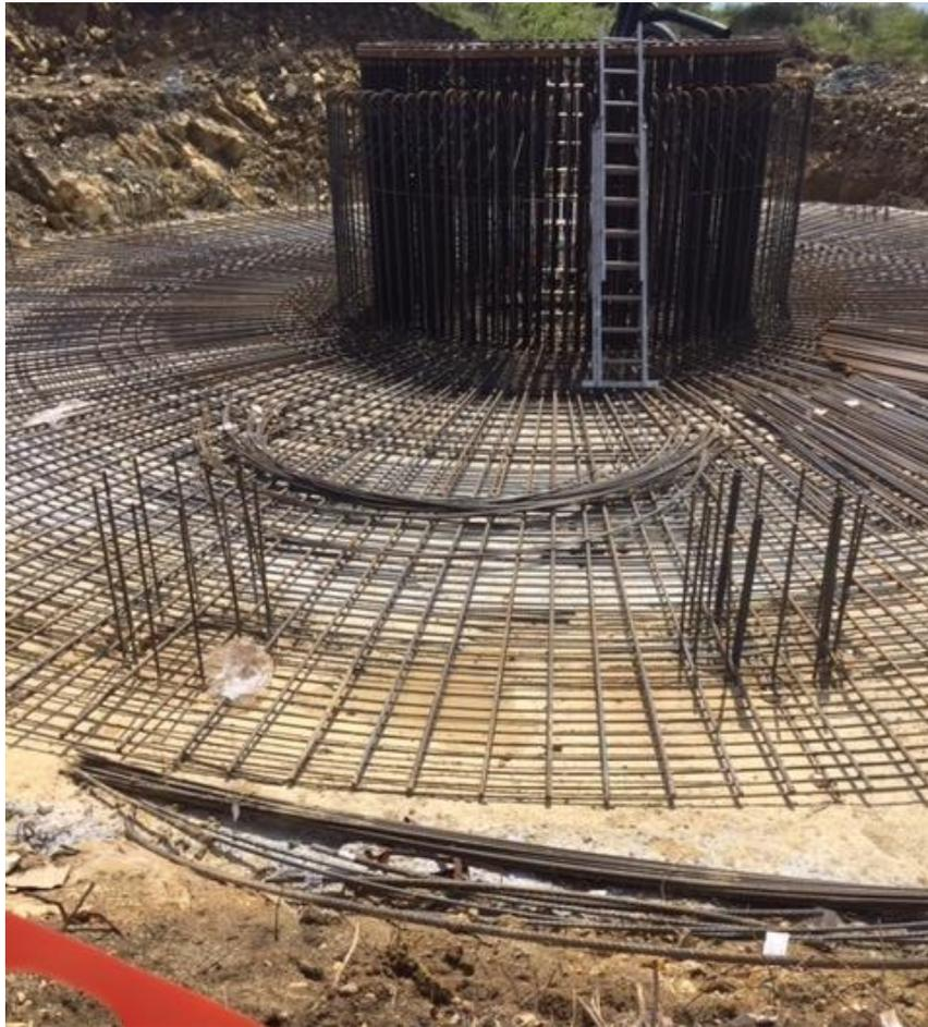
*Figura 5.10: Particolare Armatura plinto di fondazione*
