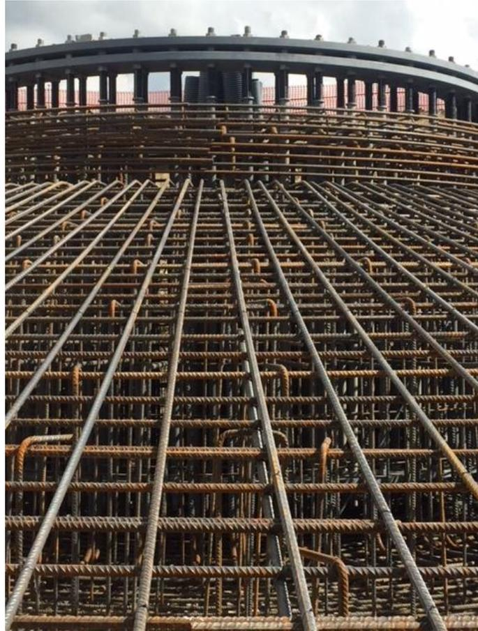
Figura 2.9: Particolare armatura plinto di fondazione
