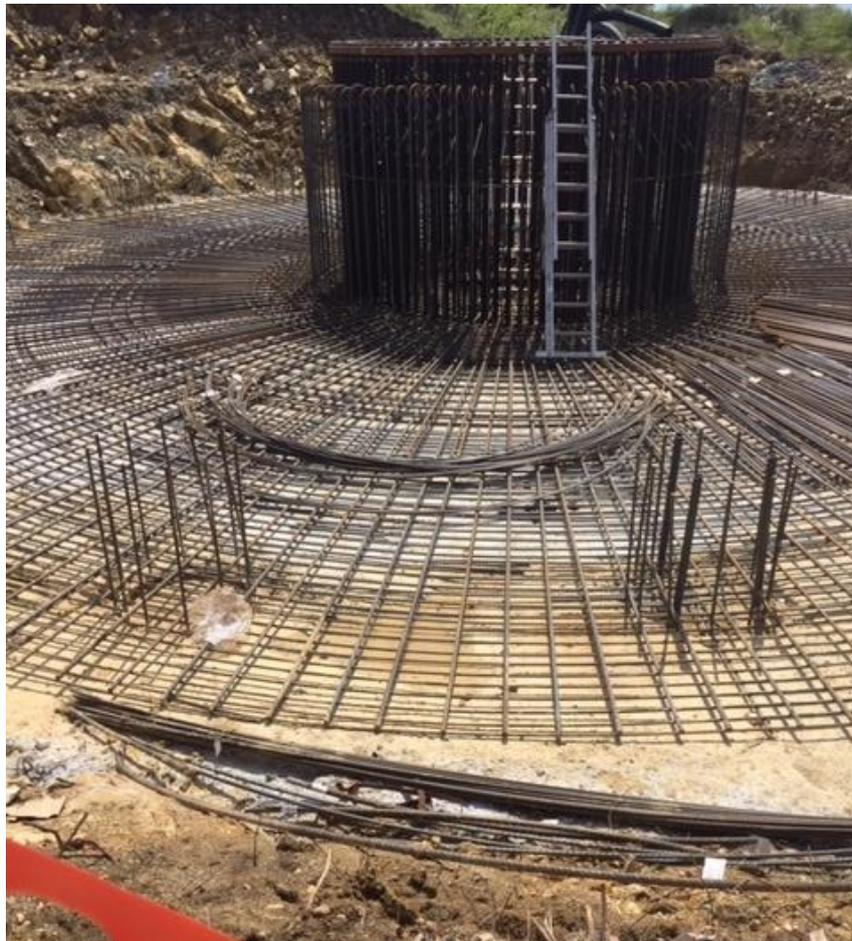
Figura 2.8: Particolare Armatura plinto di fondazione
