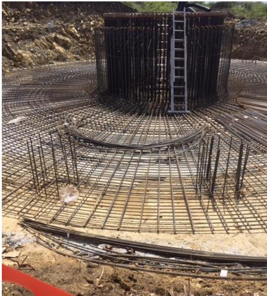
Figura 2.7: Particolare Armatura plinto di fondazione
