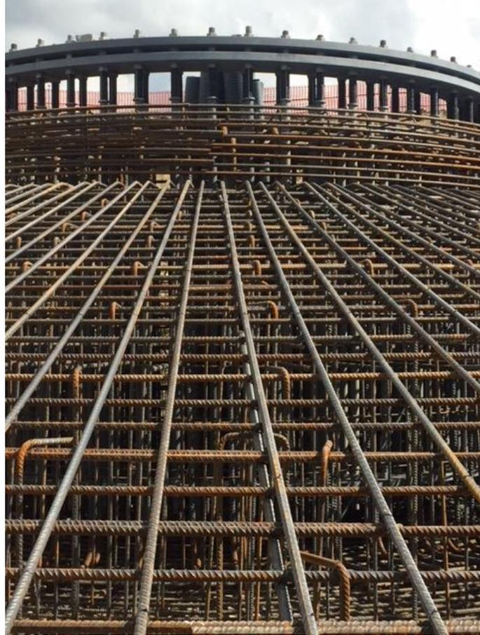
Figura 2.8: Particolare armatura plinto di fondazione
