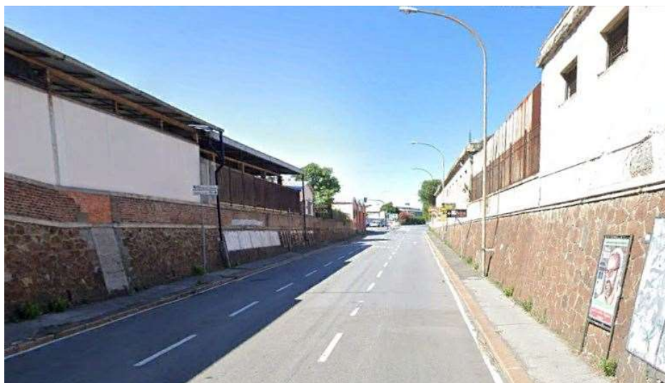
Figura 2-31. Vista stradale (da est) dell'area ove è prevista la nuova viabilità di immissione con la Via Aurelia (sullo sfondo)
