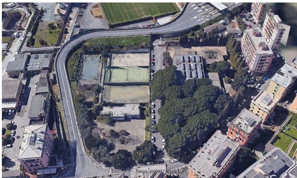
Figura 2-23. Vista aerea zona nord con il casello autostradale di Genova-Pegli, da est
