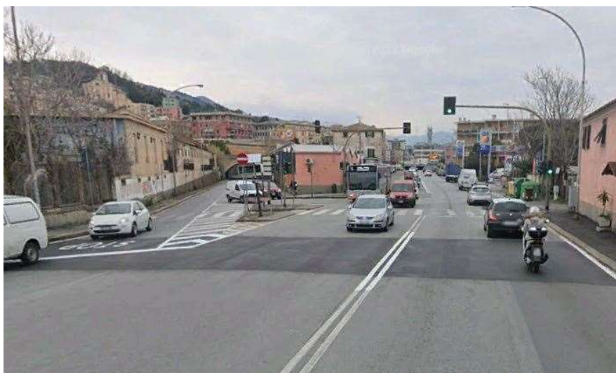
Figura 2-29. Vista stradale (da ovest) della zona di progetto sud, dove è prevista la nuova rotondella per l'immissione sulla Via Aurelia: sullo sfondo si vede l'area dove è previsto l'imbocco della galleria artificiale
