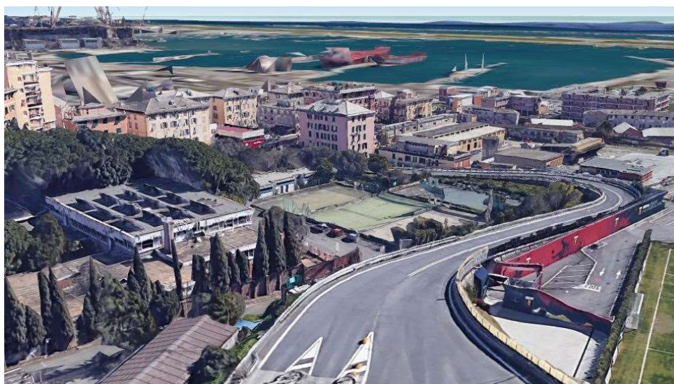
Figura 2-24. Vista aerea zona nord con il casello autostradale di Genova-Pegli, da nord-ovest
