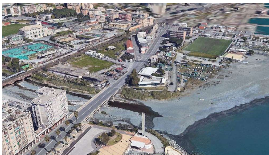
Figura 2-26. Vista aerea (da ovest) della zona di progetto sud, dove è prevista la nuova rotatoria per l'immissione del nuovo svincolo sulla Via Aurelia
