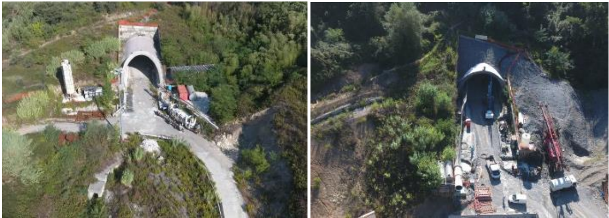
Figura 2: - Stato lavorazioni – imbocco sud GN Felettino I e tombino AI13; imbocco nord
