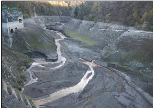
Figura 2-4: La quota dello scarico di alleggerimento è ricolma di sedimento il 23 novembre 2020
