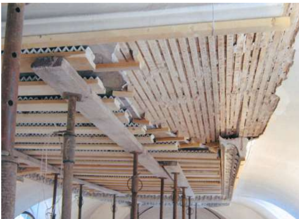
Figura 6-11. PUNTELLAZIONE CONSERVATIVA – Esempio di puntellazioni solai piani di pregio
