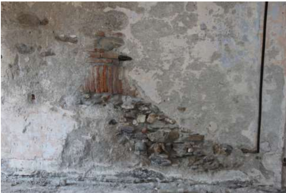
Figura 2-8: Muratura con inclusioni lapidei posta all'interno dell'edificio
