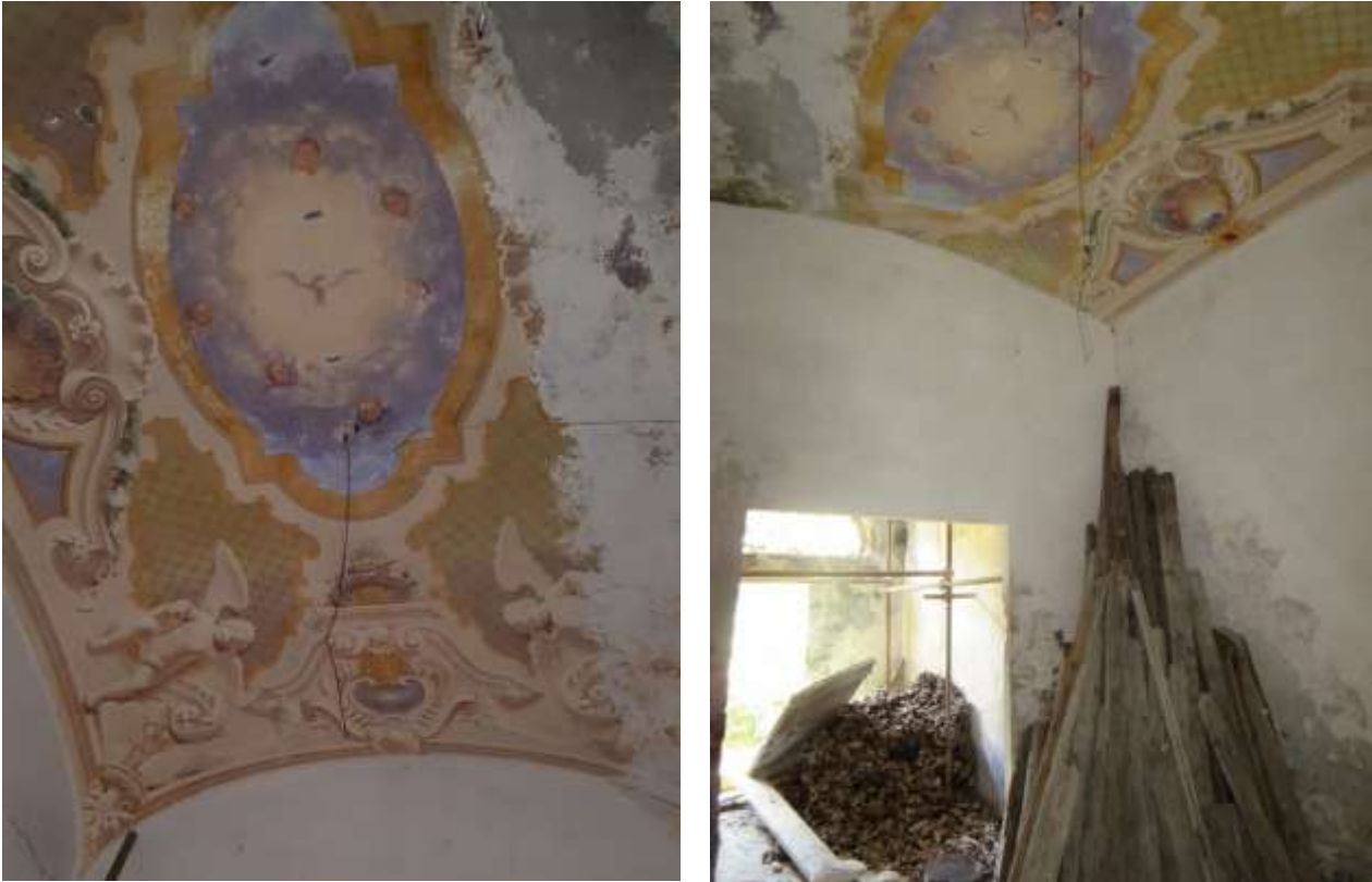
Figura 3-6:--Elementi di pregio presenti nei controsoffitti del piano terra all'interno del vano n°12
