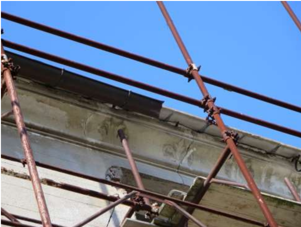
Figura 3-16:--Elementi decorativi presenti all'esterno dell'edificio principale a livello copertura
