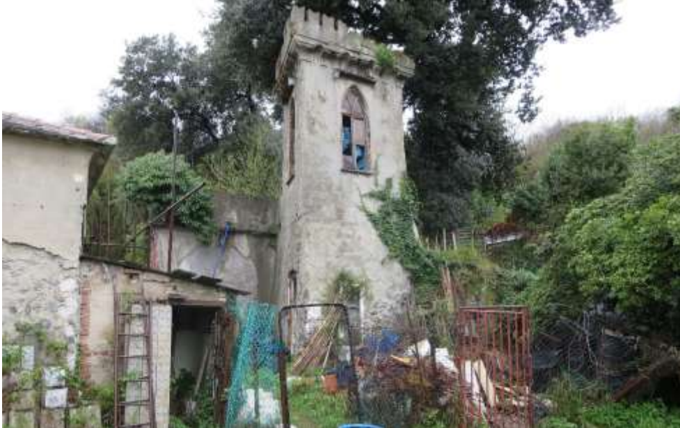
Figura 2-17: TORRETTA - Vista esterno della "TORRETTA"
