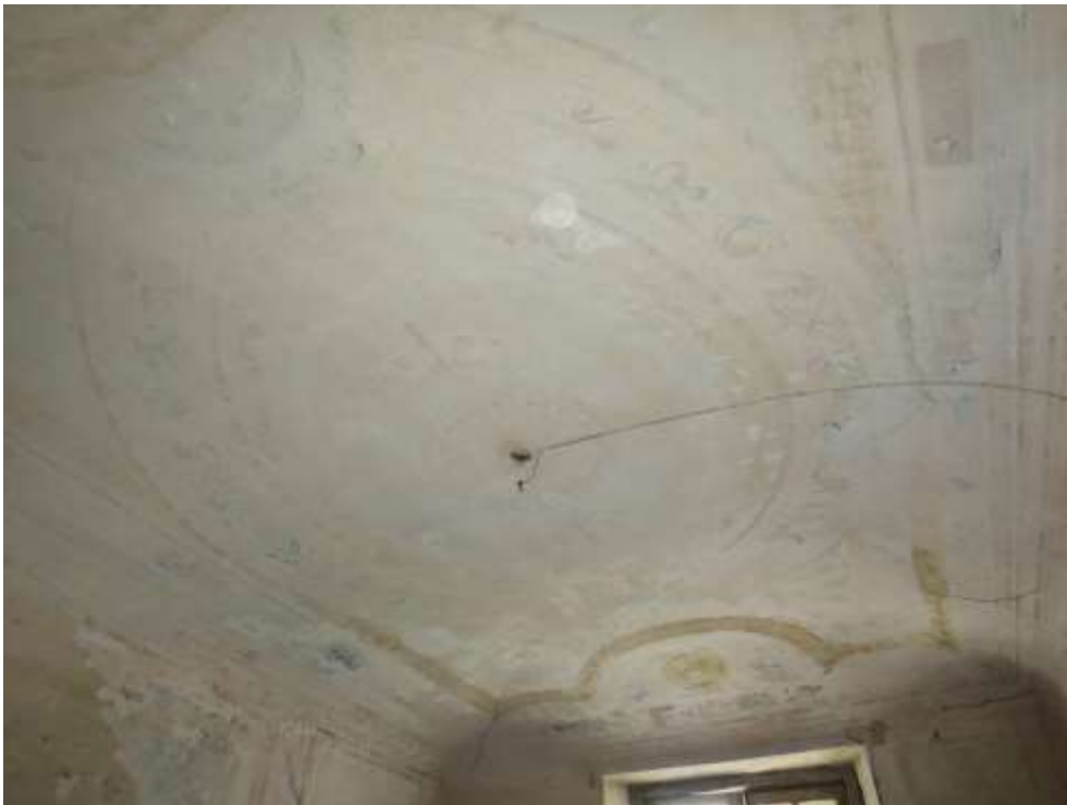
Figura 3-11:--Decorazioni presenti nei controsoffitti del piano primo all'interno del vano n°11
