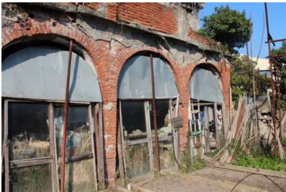
Figura 2-14: SERRA - Vista esterna lato sud dell'edificio denominato "SERRA"
