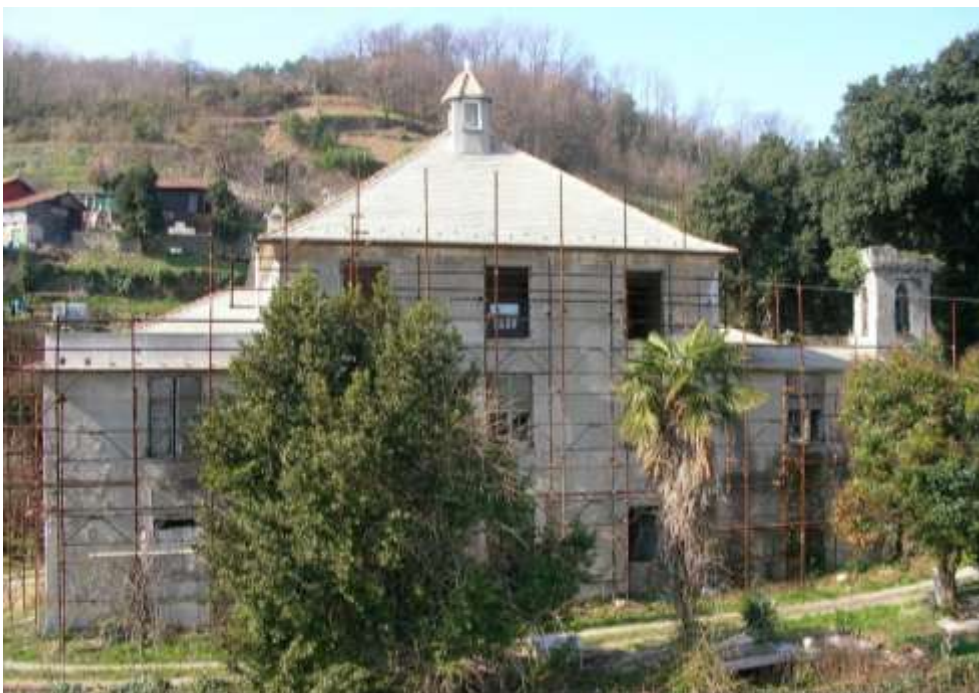
Figura 2-10: Vista completa delle coperture (foto anno 2011)
