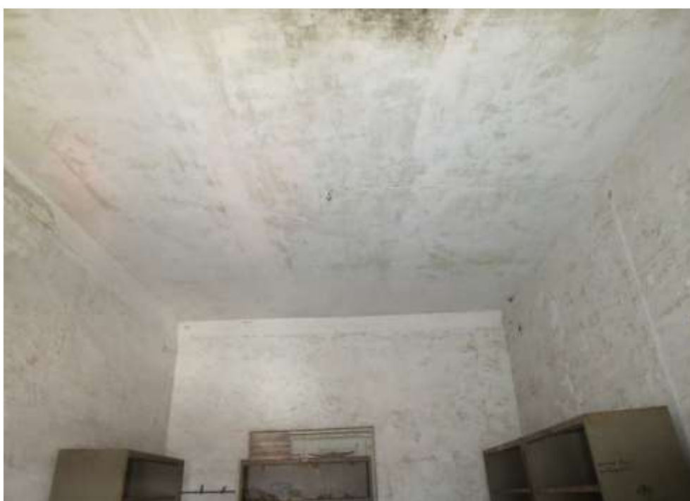
Figura 3-9:--Elementi di pregio presenti nei controsoffitti del piano primo all'interno del vano n°6
