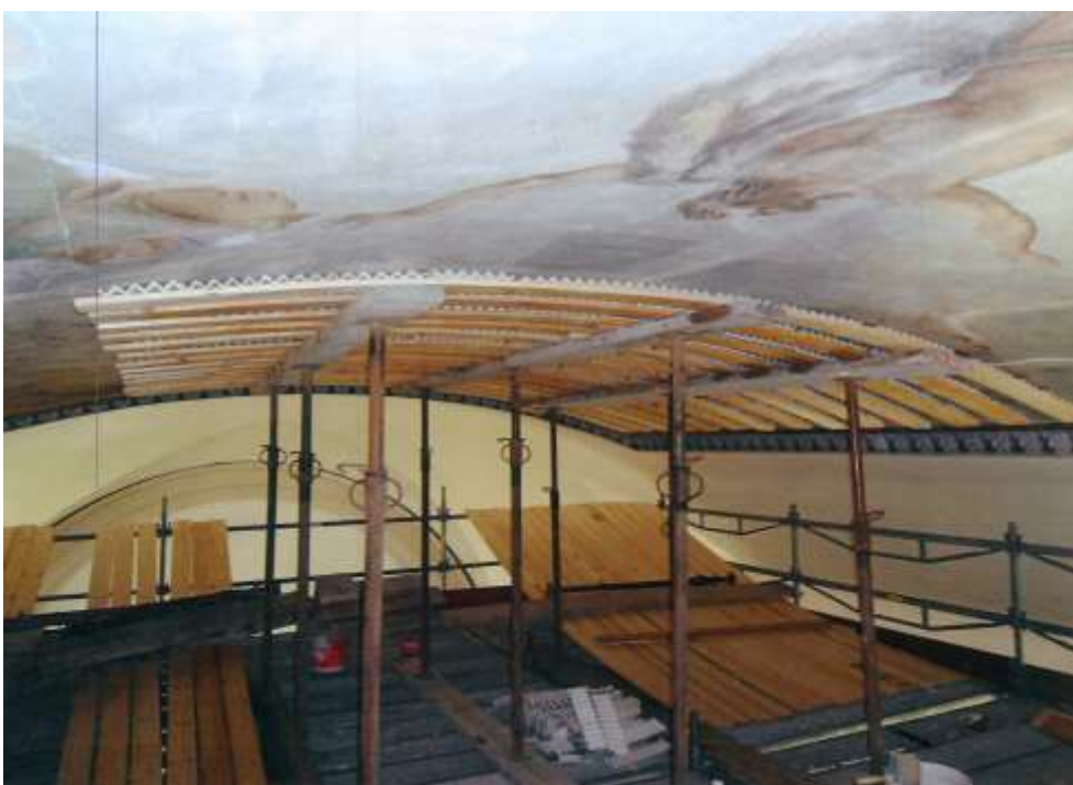
Figura 6-12. PUNTELLAZIONE CONSERVATIVA – Esempio di puntellazioni solai voltati di pregio
