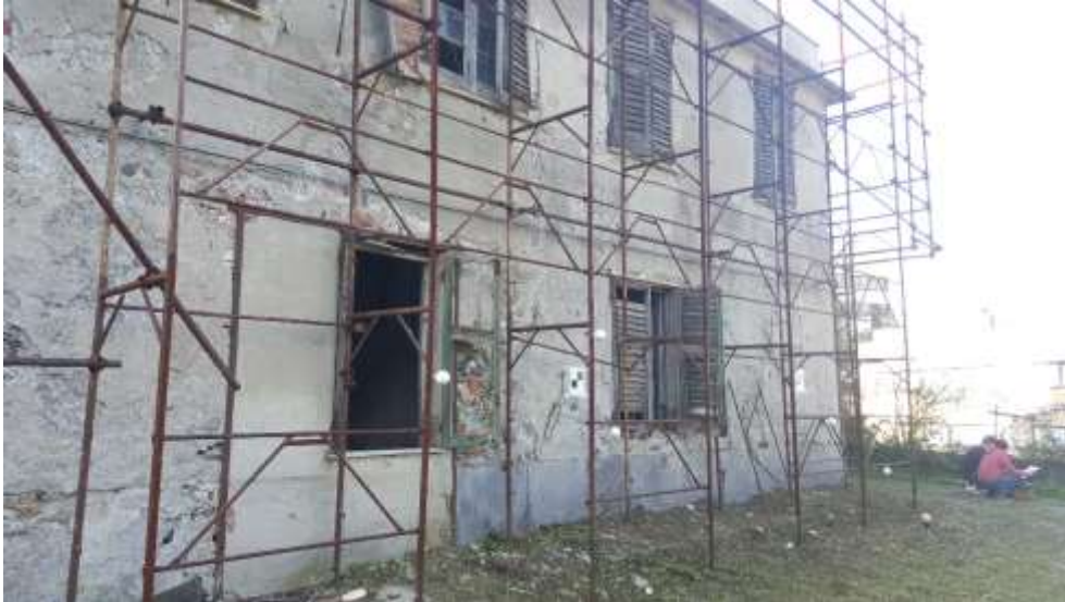
Figura 2-7: Muratura con inclusioni lapidei posta nel lato sud dell'edificio principale
