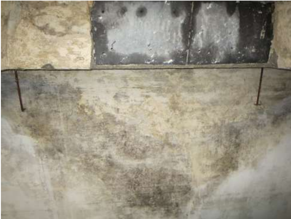
Figura 3-10:--Presenza di muffe e infiltrazioni nei controsoffitti del piano primo all'interno del vano n°6
