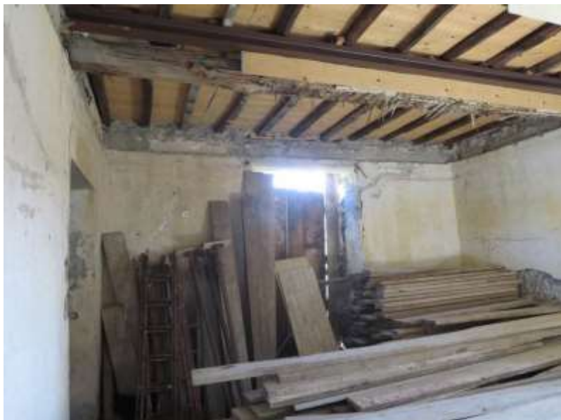
Figura 6-4. RIMOZIONE MATERIALE PRESENTE – Esempio di vano con all'interno materiale da rimuovere (vano 1)
