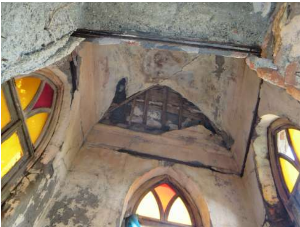
Figura 2-18: TORRETTA - Vista interna della copertura del fabbricato "TORRETTA"
