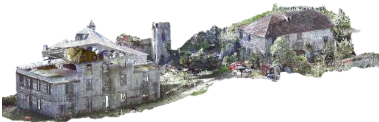
Figura 2-2: Vista assonometrica del complesso lato S-E
