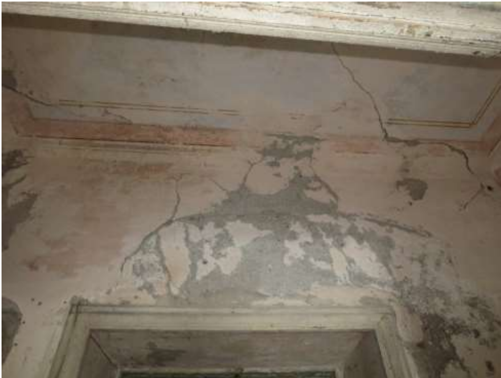
Figura 3-14:--Elementi decorativi presenti all'interno del vano n°6
