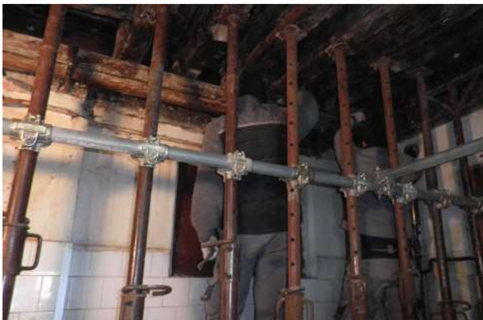
Figura 6-10. PUNTELLAZIONE NORMALE – Esempio di puntellazioni "NORMALE" dei solai lignei di piano
