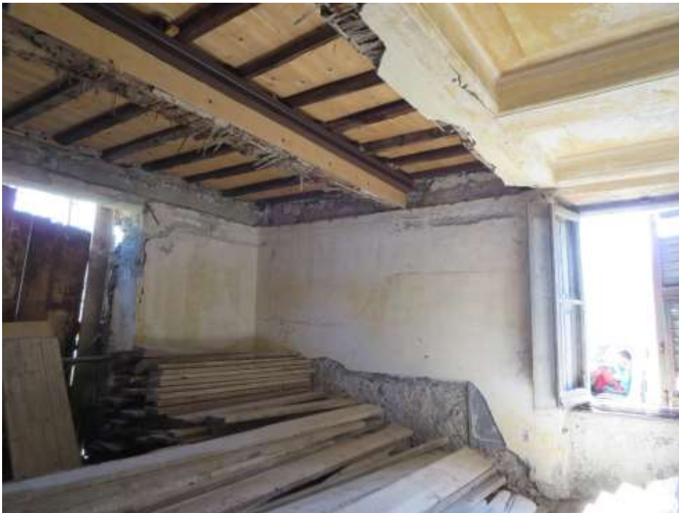
Figura 2-9: Solaio in legno presente nel vano 01 al piano terra dell'edificio
