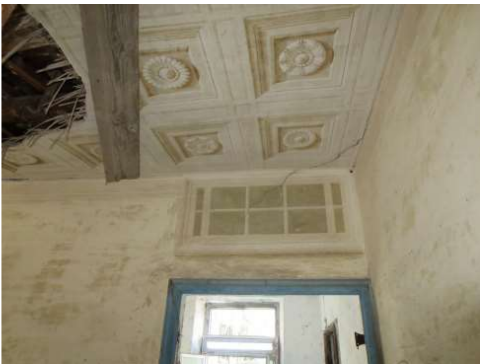
Figura 3-13:--Elementi decorativi presenti all'interno del vano n°6
