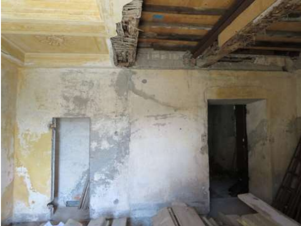
Figura 3-4:--Controsoffitto al piano terra all'interno del vano n°1'
