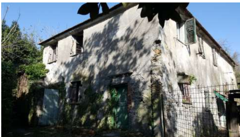
Figura 2-12: ANNESSO RUSTICO - Vista esterna lato sud dell'edificio denominato "ANNESSO RUSTICO"
