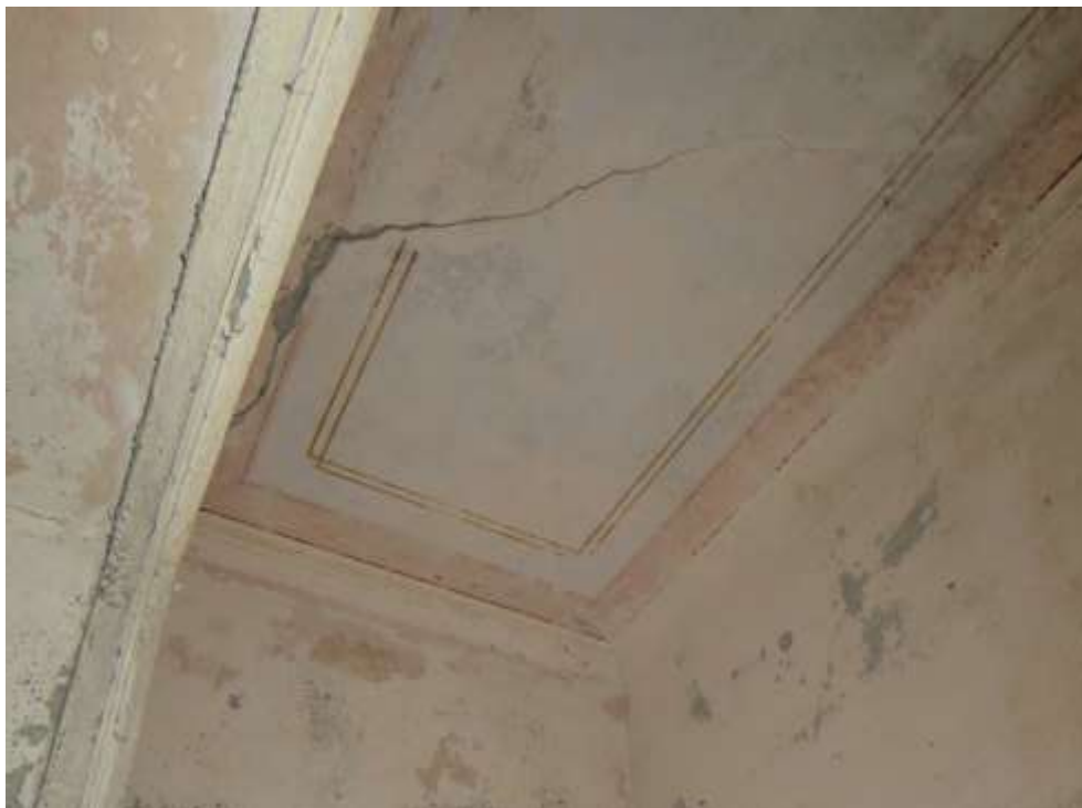
Figura 3-15:--Elementi decorativi presenti all'interno del vano n°13
