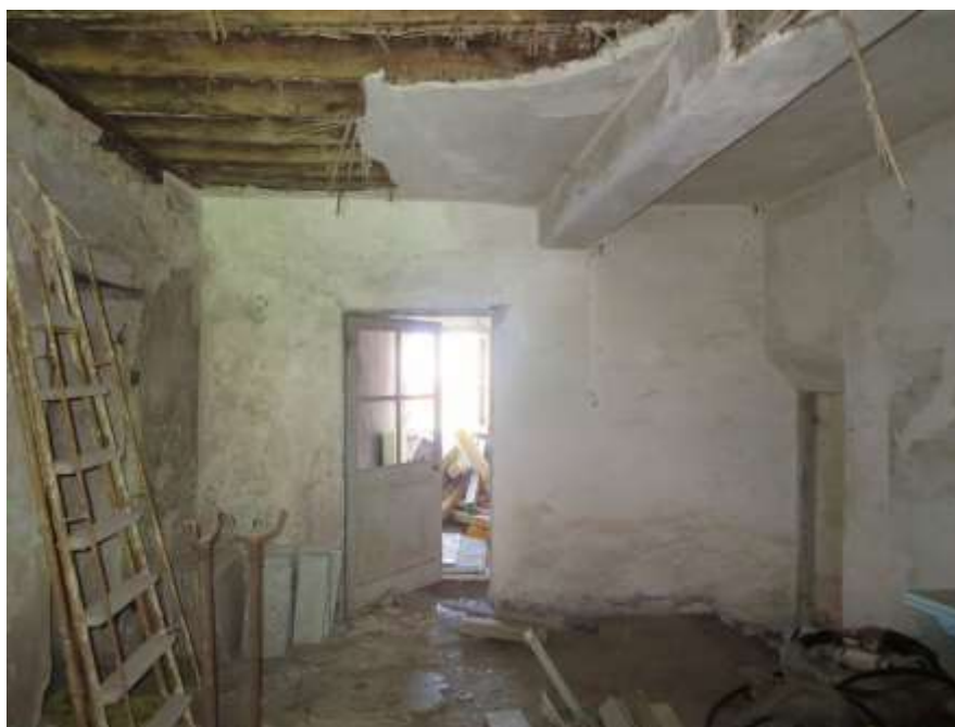
Figura 4-26. PALAZZO PARETO – PT - Vano 6 – Parete A
