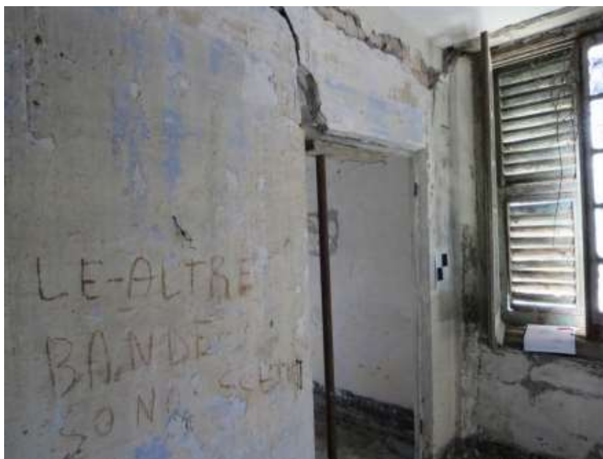
Figura 4-121. PALAZZO PARETO – P1 - Vano 9 – Pareti A e B
