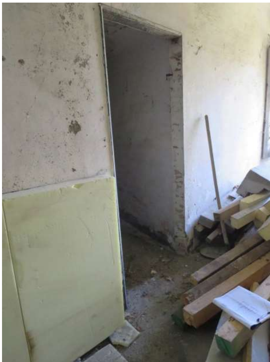
Figura 4-19. PALAZZO PARETO – PT - Vano 4 – Parete D
