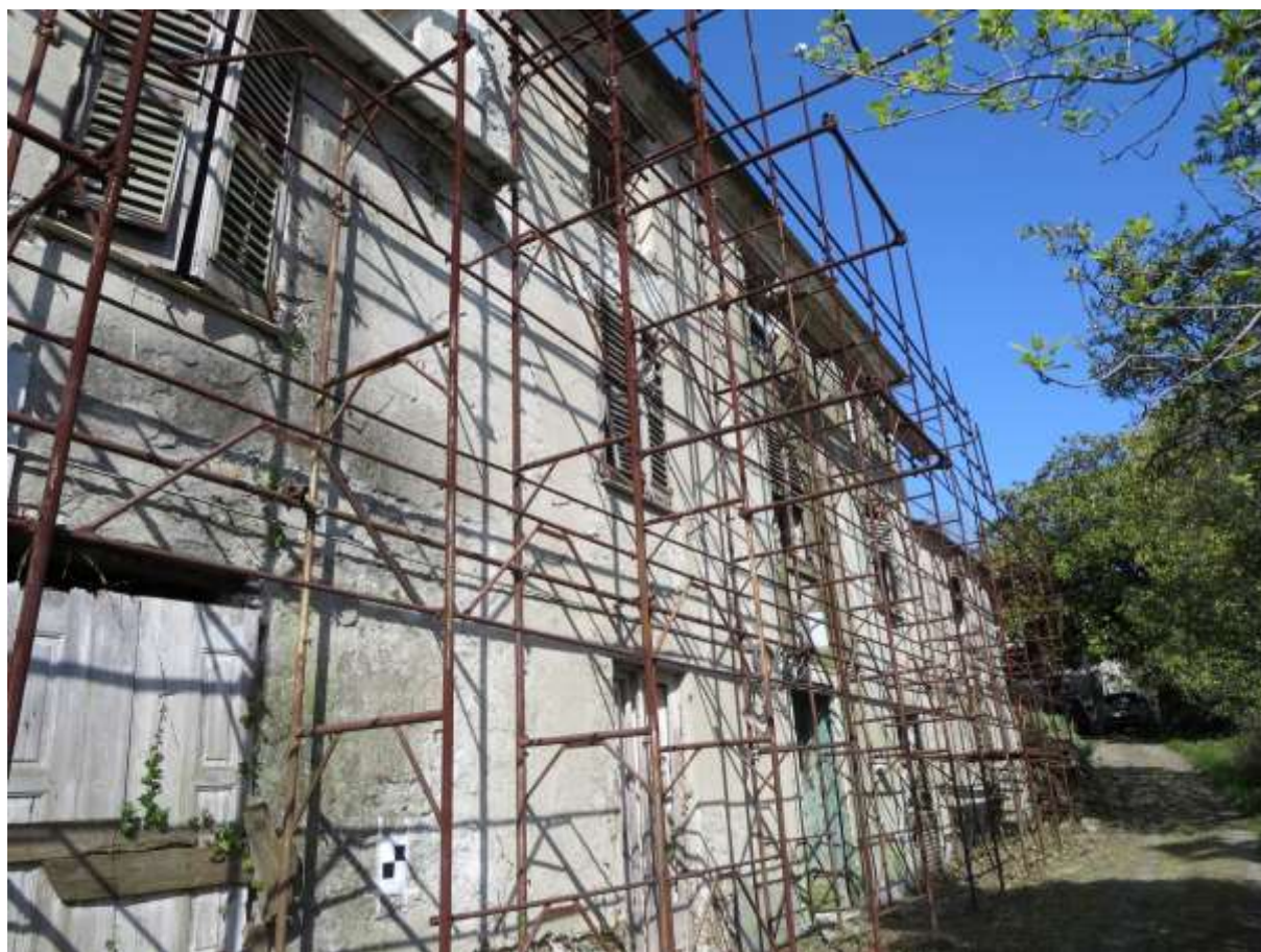
Figura 4-176. PALAZZO PARETO – Facciata est
