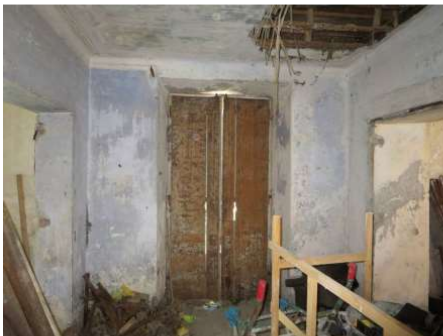
Figura 4-7. PALAZZO PARETO – PT - Vano 2 – Parete A
