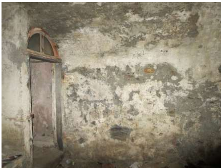
Figura 4-33. PALAZZO PARETO – PT - Vano 7 – Pareti B e C
