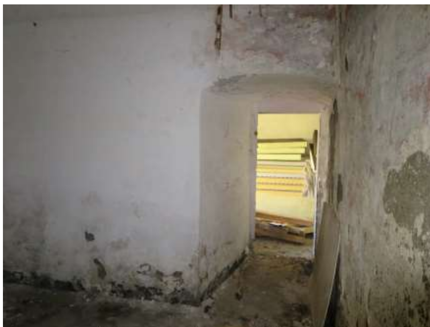
Figura 4-22. PALAZZO PARETO – PT - Vano 5 – Parete B
