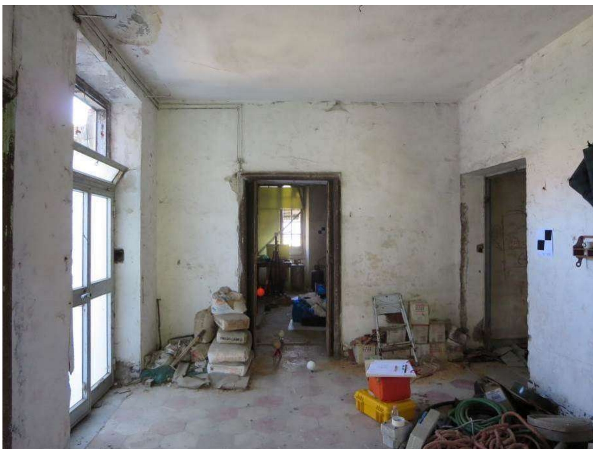
Figura 4-110. PALAZZO PARETO – P1 - Vano 7 – Parete A
