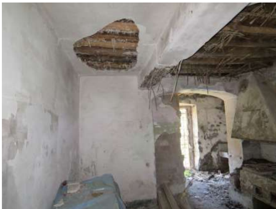
Figura 4-28. PALAZZO PARETO – PT - Vano 6 – Parete C
