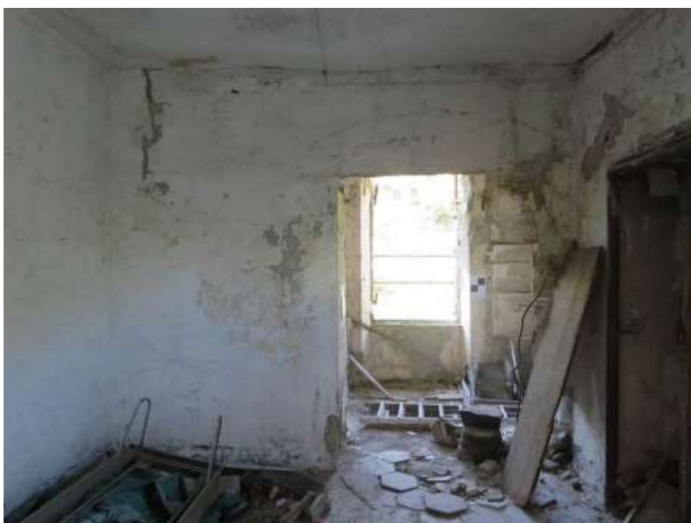
Figura 4-112. PALAZZO PARETO – P1 - Vano 7 – Parete C
