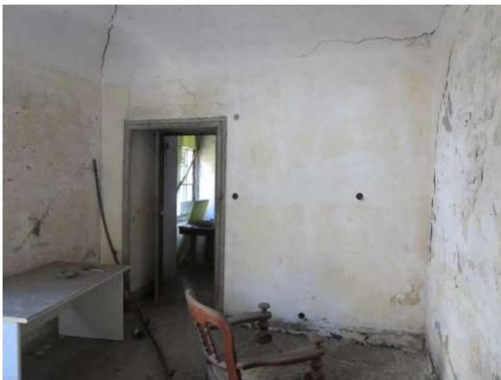
Figura 4-96. PALAZZO PARETO – P1 - Vano 4 – Parete B
