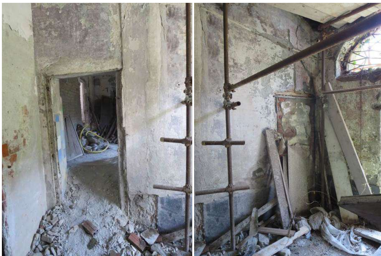
Figura 4-56. PALAZZO PARETO – PT - Vano 11 – Parete B
