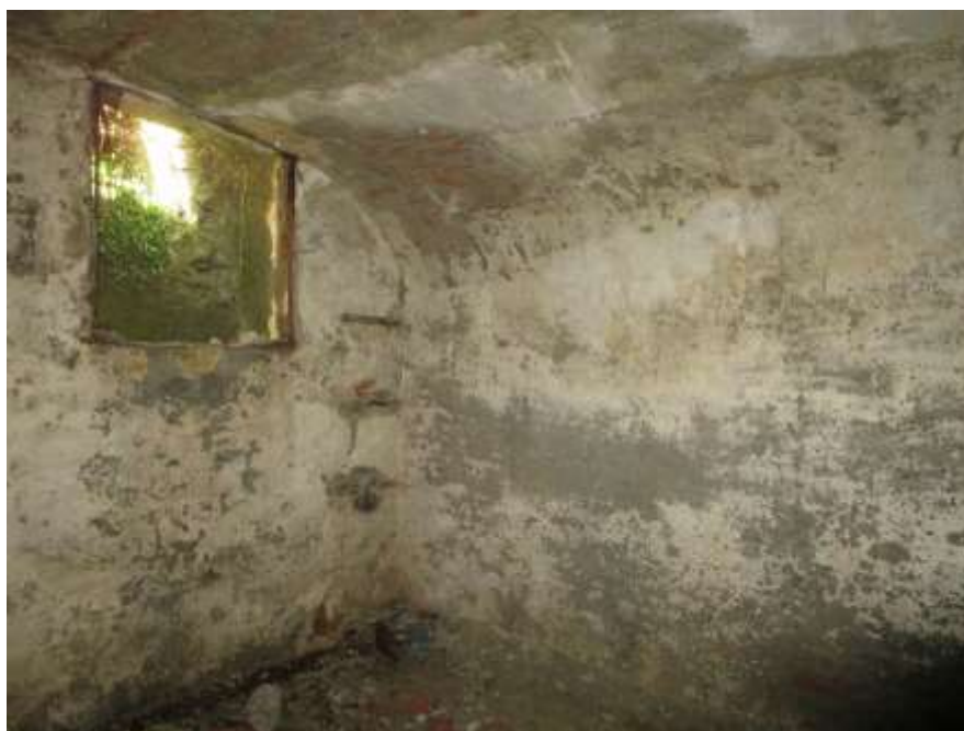
Figura 4-31. PALAZZO PARETO – PT - Vano 7 – Pareti D e A
