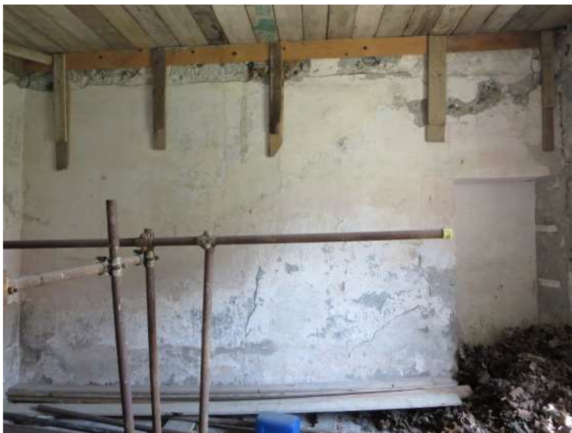
Figura 4-70. PALAZZO PARETO – PT - Vano 14 – Parete A
