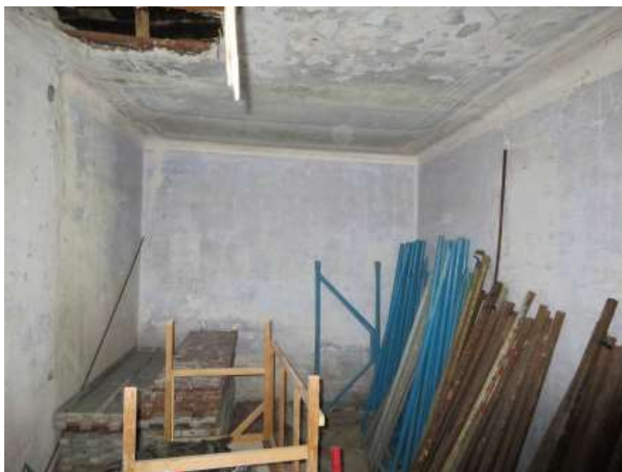
Figura 4-9. PALAZZO PARETO – PT - Vano 2 – Parete C
