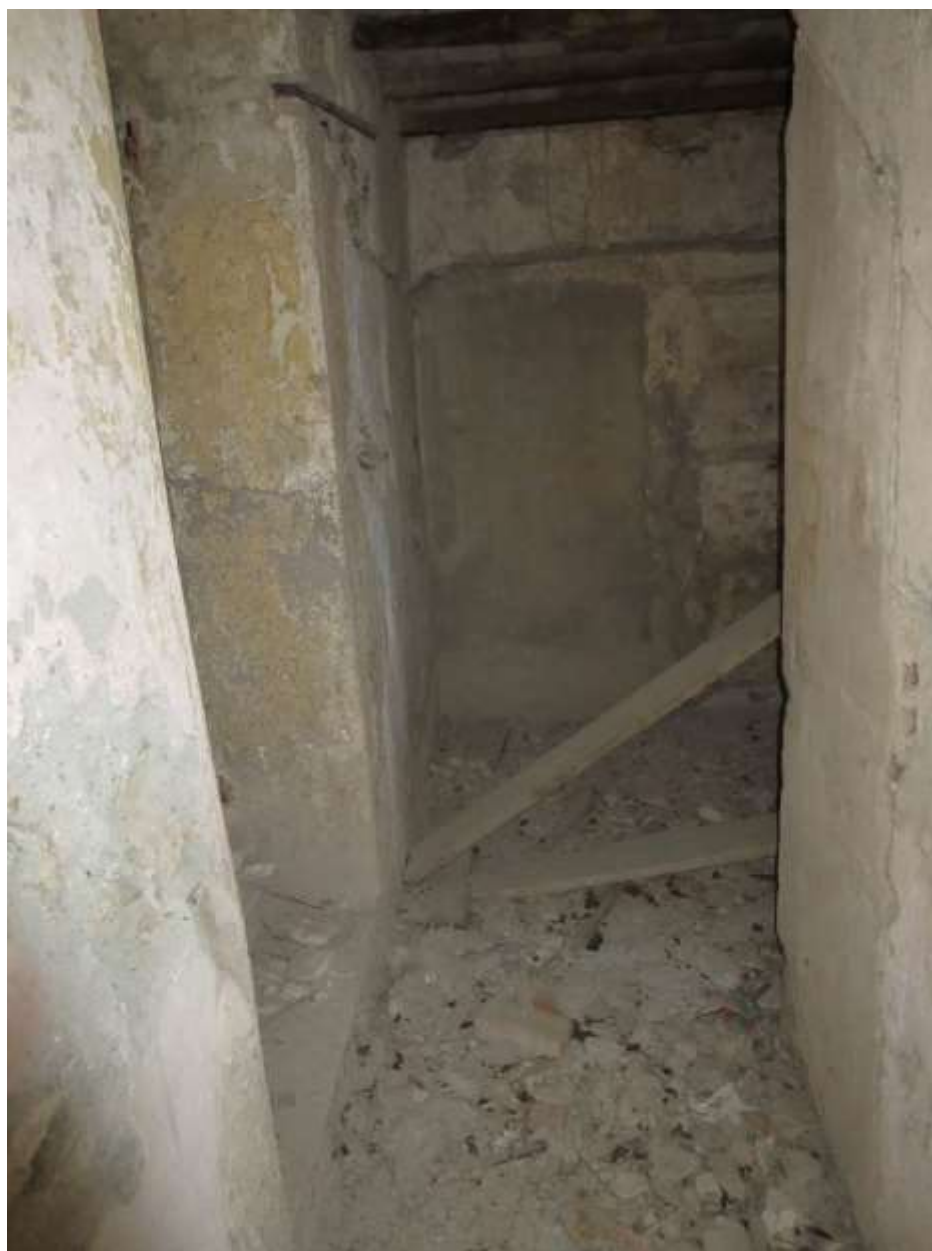
Figura 4-42. PALAZZO PARETO – PT - Vano 9' – Parete B
