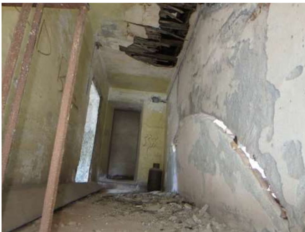
Figura 4-166. PALAZZO PARETO – P2 - Vano 1 – Pareti D, A e B
