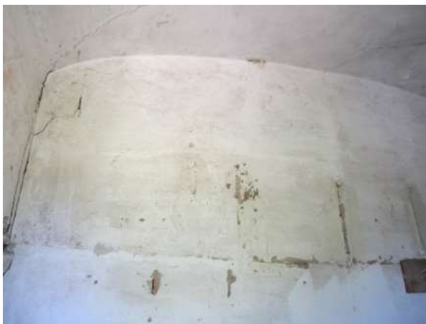
Figura 4-138. PALAZZO PARETO – P1 - Vano 12 – Parete B
