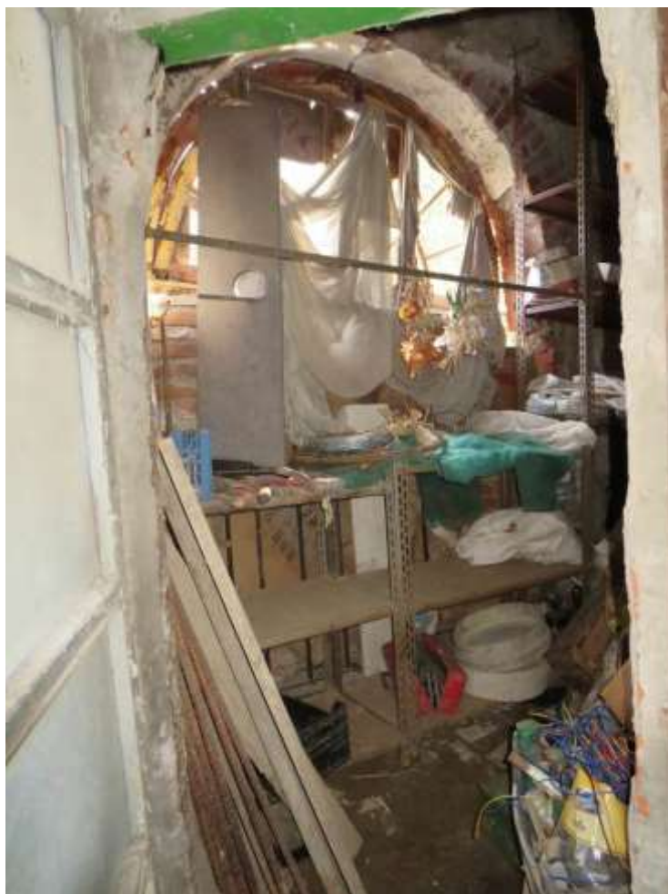
Figura 5-6. SERRA – PT - Vano 2 – Parete B
