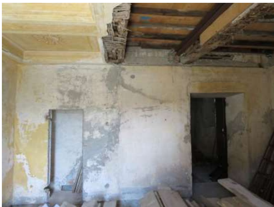
Figura 4-5. PALAZZO PARETO – PT - Vano 1 – Parete D
