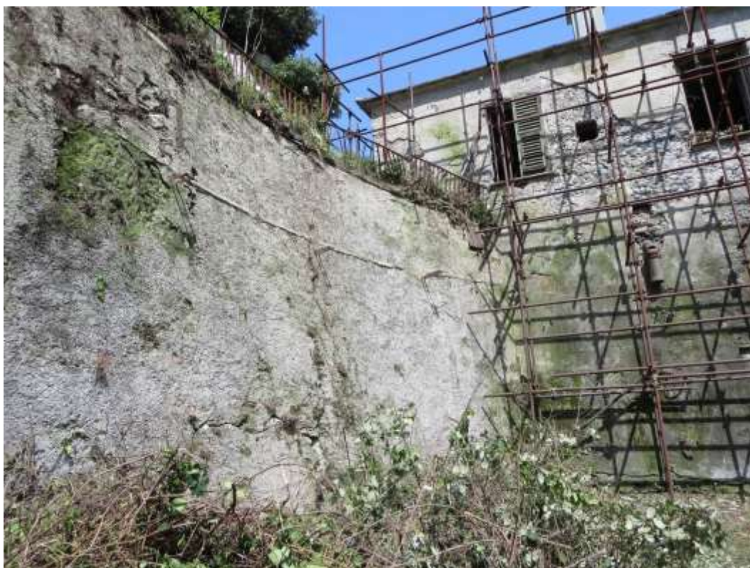
Figura 4-174. PALAZZO PARETO – Facciata ovest e muro di contenimento
