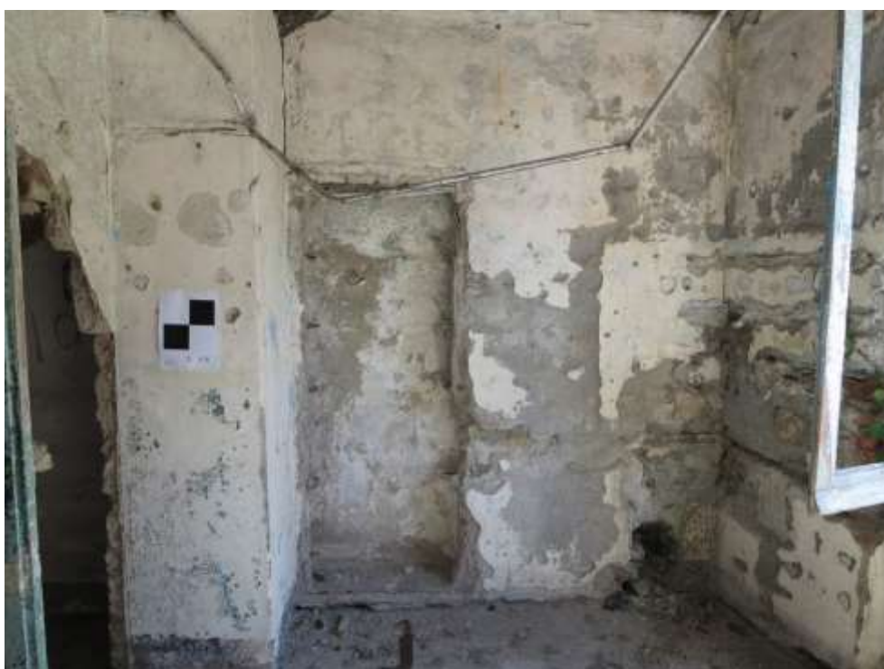
Figura 4-153. PALAZZO PARETO – P1 - Vano 15 – Parete B
