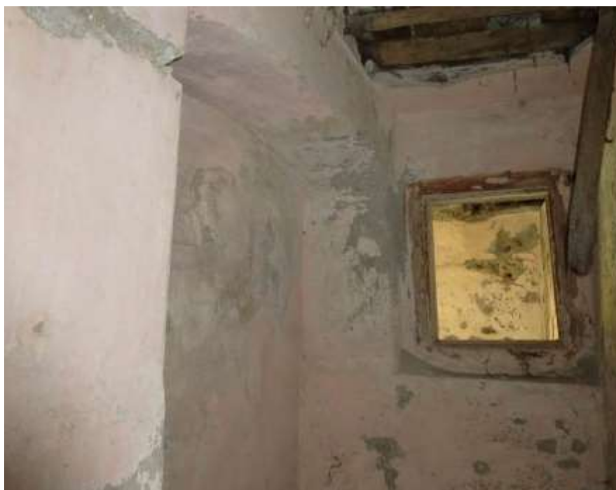
Figura 4-37. PALAZZO PARETO – PT - Vano 8 – Pareti B e C
