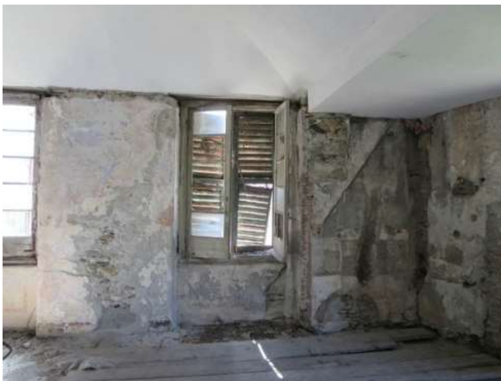
Figura 4-116. PALAZZO PARETO – P1 - Vano 8 – Parete B
