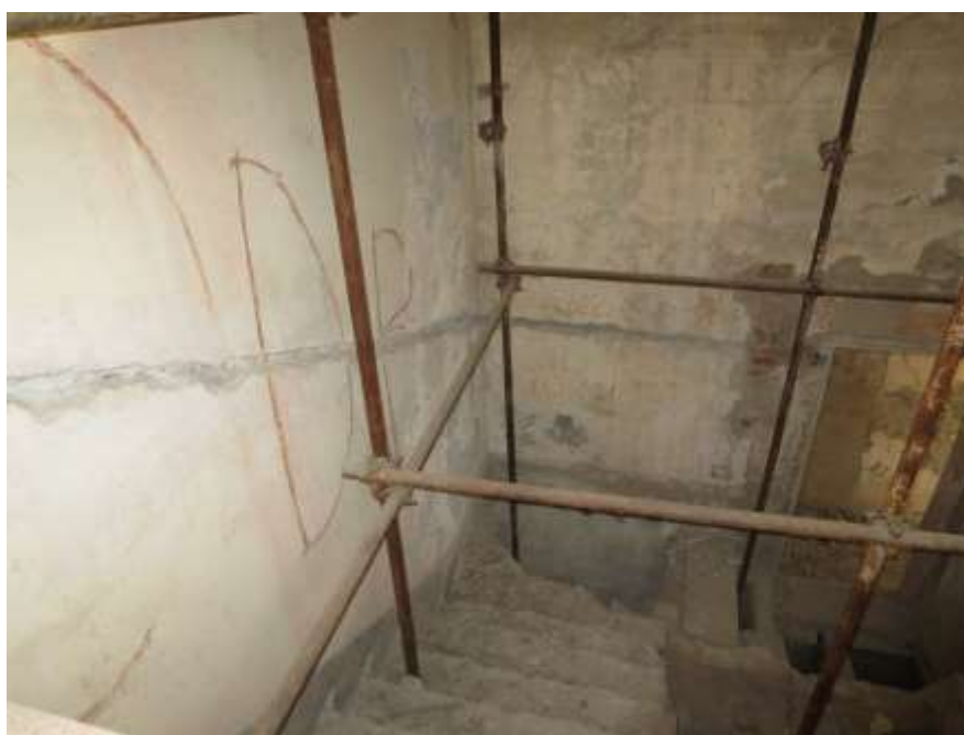
Figura 4-160. PALAZZO PARETO – P1 - Vano 16 – Pareti B e C
