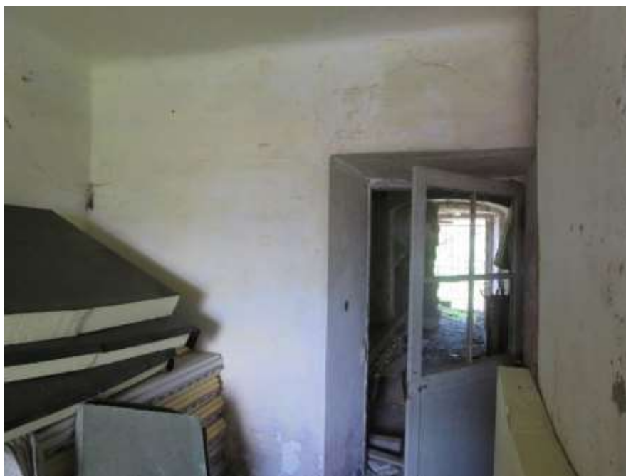
Figura 4-18. PALAZZO PARETO – PT - Vano 4 – Parete C
