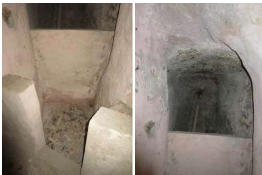
Figura 4-39. PALAZZO PARETO – PT - Vano 8 – Parete D
