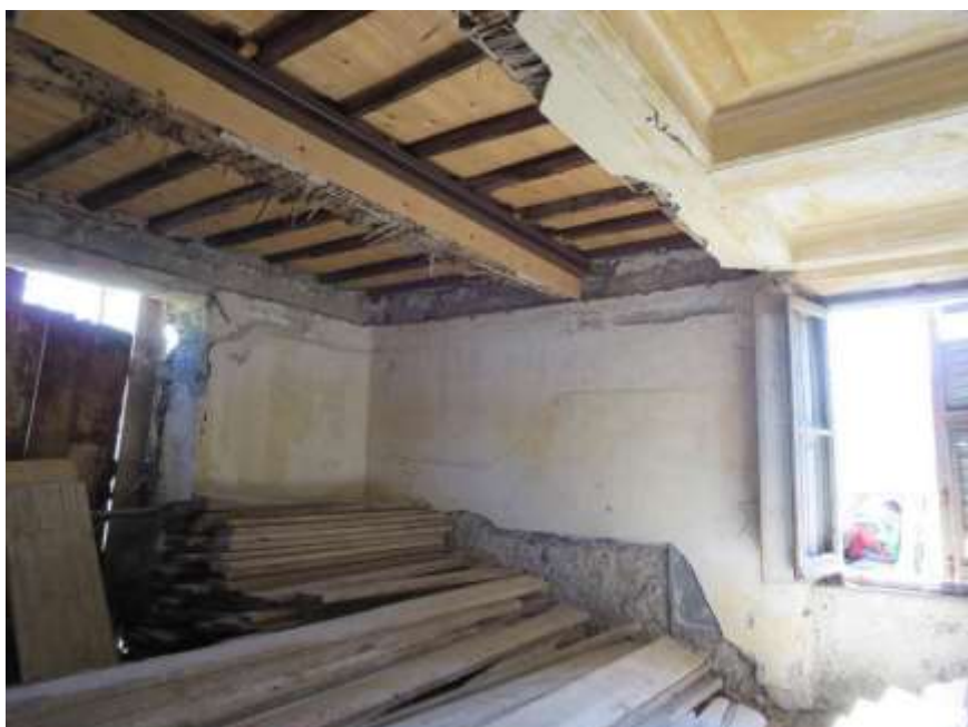
Figura 4-3. PALAZZO PARETO – PT - Vano 1 – Parete B
