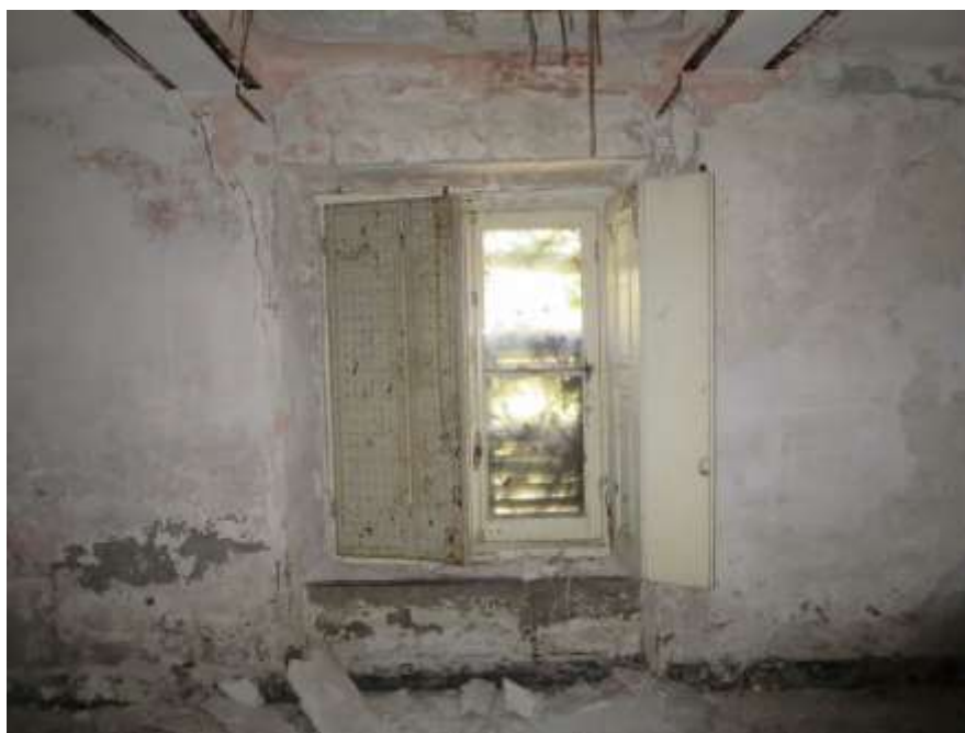
Figura 4-21. PALAZZO PARETO – PT - Vano 5 – Parete A
