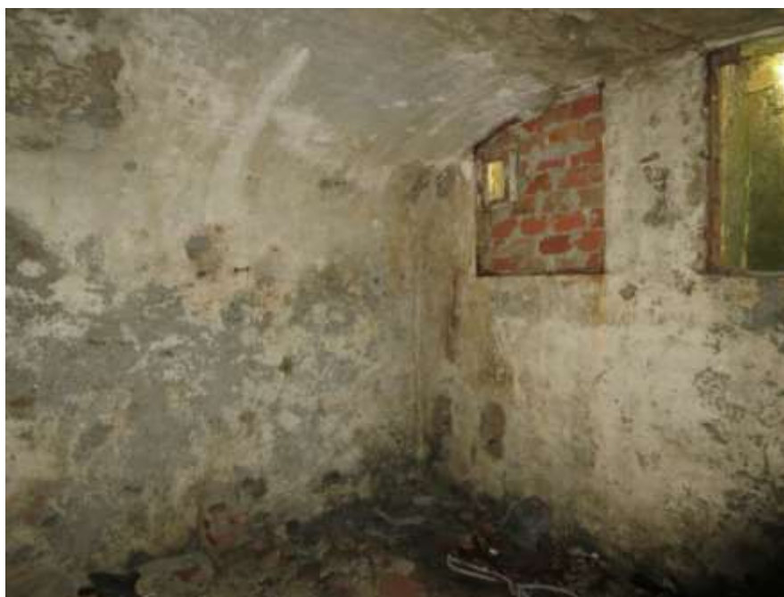
Figura 4-34. PALAZZO PARETO – PT - Vano 7 – Pareti C e D
