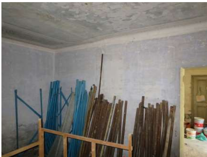
Figura 4-10. PALAZZO PARETO – PT - Vano 2 – Parete D
