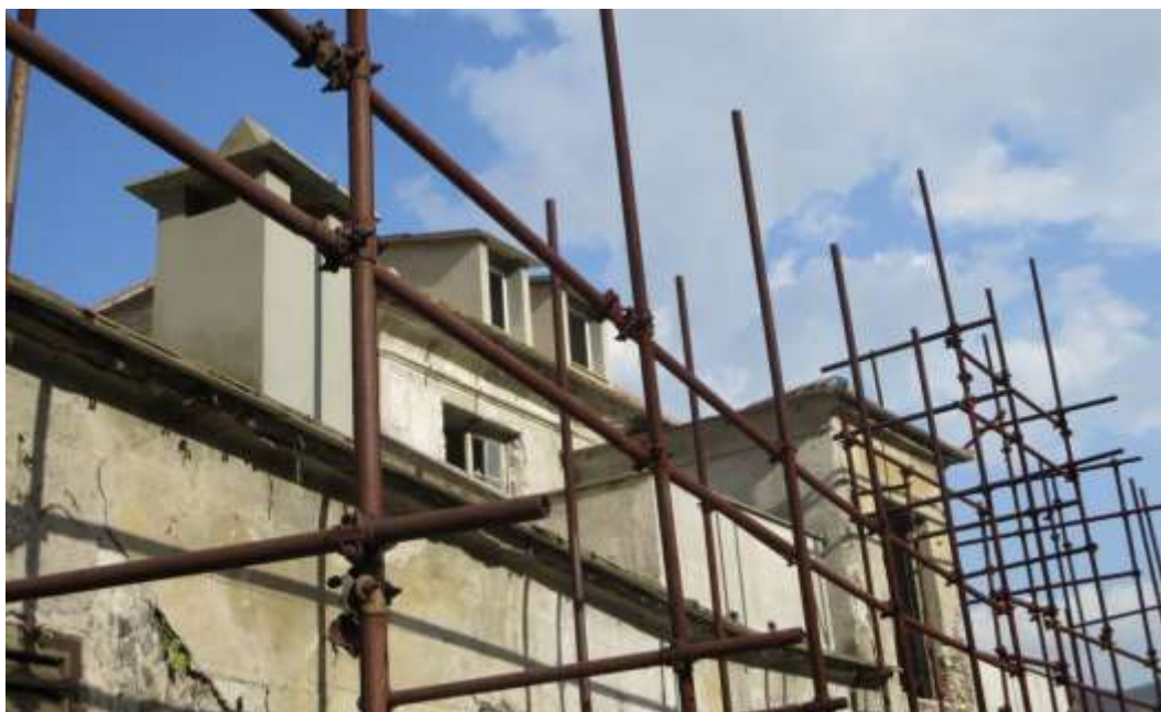
Figura 4-173. PALAZZO PARETO – Facciata ovest (particolare abbaini)
