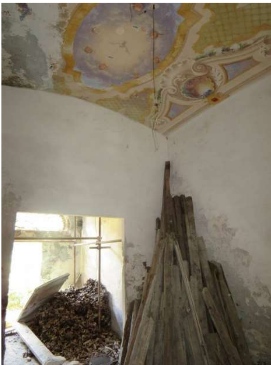
Figura 4-63. PALAZZO PARETO – PT - Vano 12 – Pareti C e D
