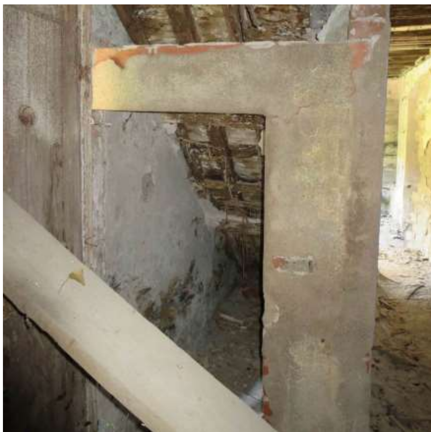
Figura 4-44. PALAZZO PARETO – PT - Vano 9' – Parete D
