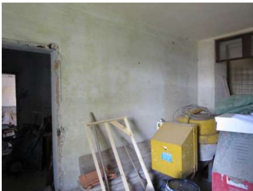
Figura 4-13. PALAZZO PARETO – PT - Vano 3 – Parete B
