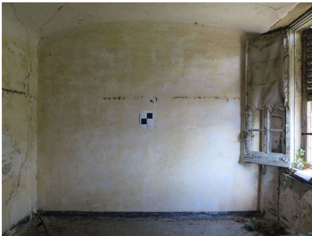
Figura 4-98. PALAZZO PARETO – P1 - Vano 4 – Parete D
