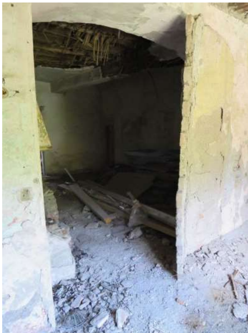
Figura 4-46. PALAZZO PARETO – PT - Vano 9" – Parete A
