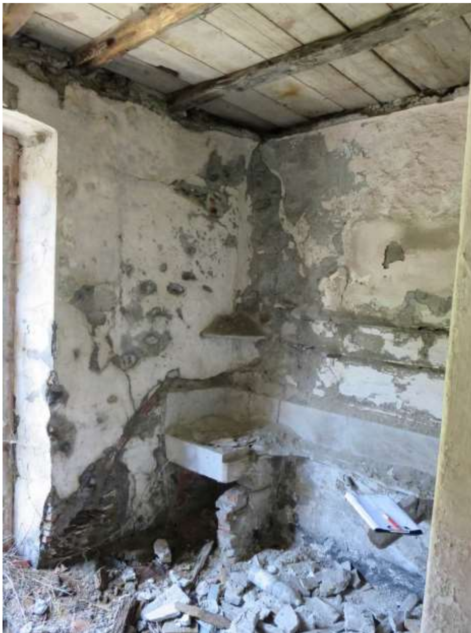
Figura 4-48. PALAZZO PARETO – PT - Vano 9” – Pareti C e D
