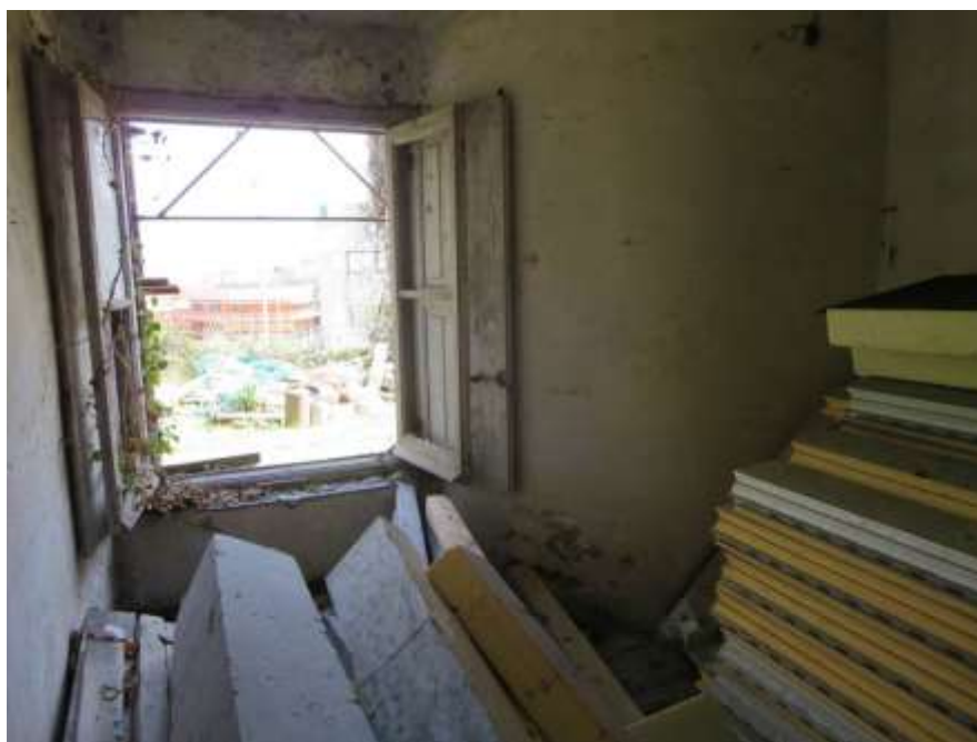
Figura 4-17. PALAZZO PARETO – PT - Vano 4 – Parete A
