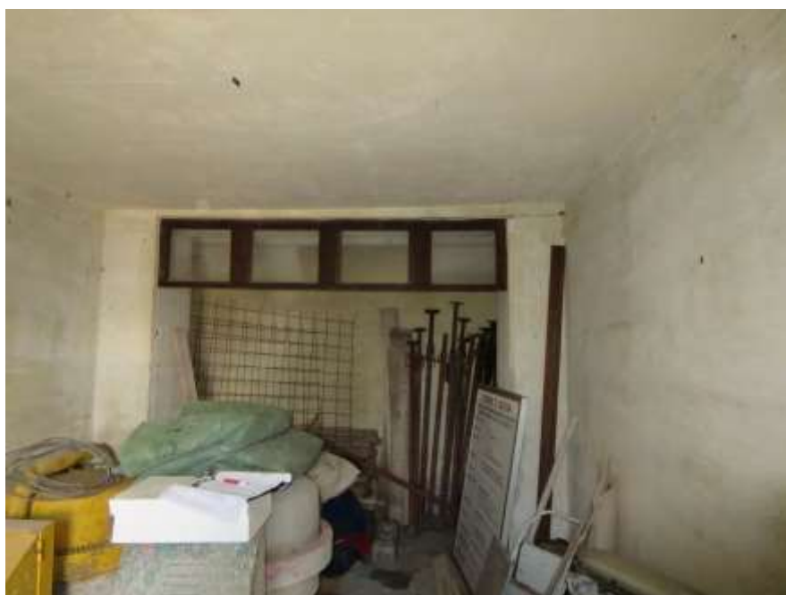
Figura 4-14. PALAZZO PARETO – PT - Vano 3 – Parete C
