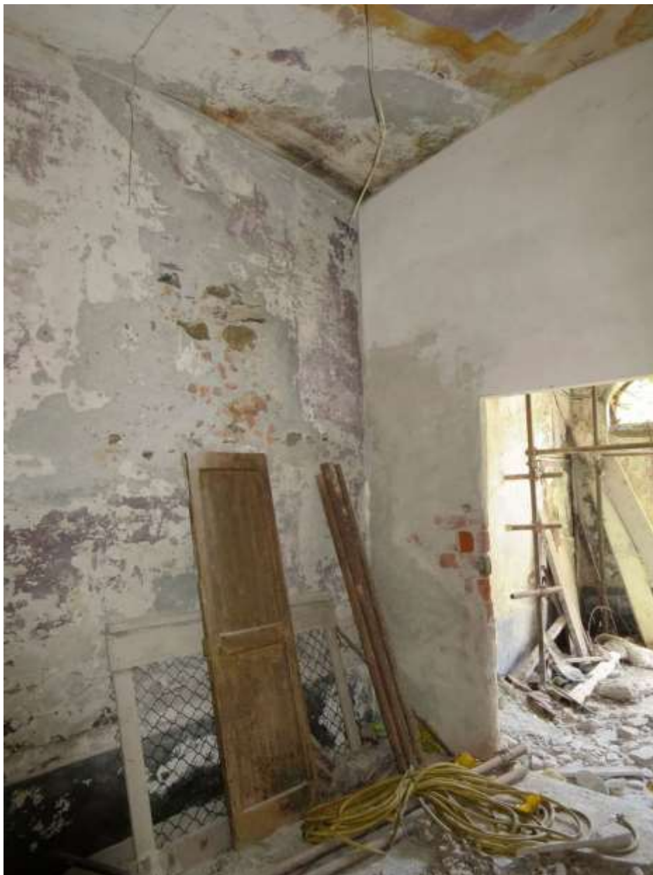
Figura 4-62. PALAZZO PARETO – PT - Vano 12 – Pareti B e C
