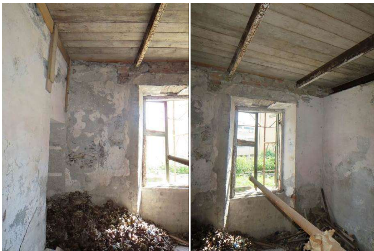
Figura 4-71. PALAZZO PARETO – PT - Vano 14 – Parete B
