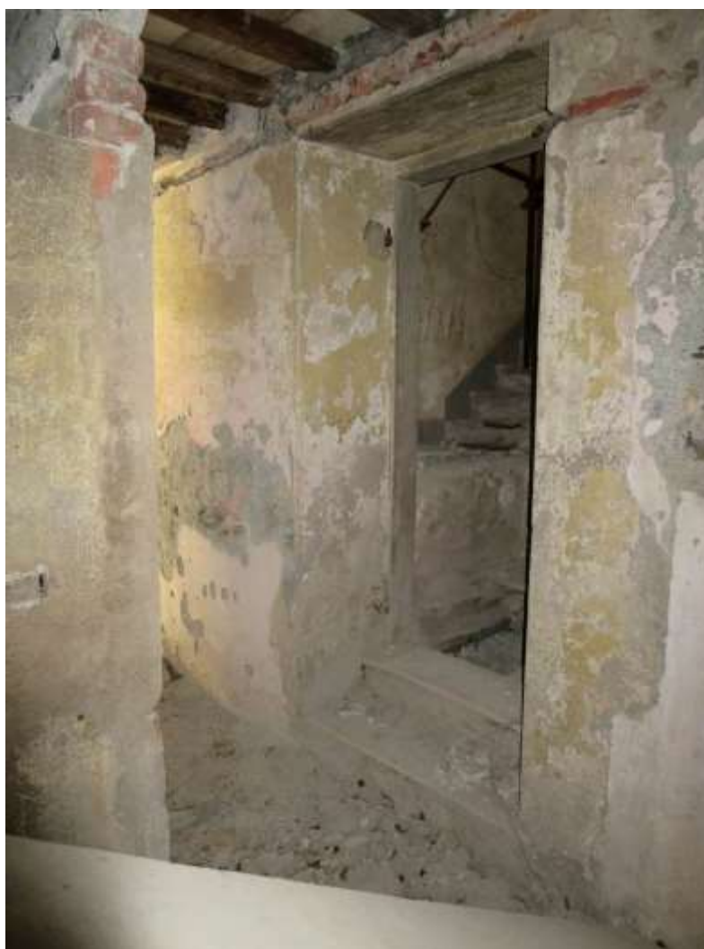
Figura 4-41. PALAZZO PARETO – PT - Vano 9' – Parete A
