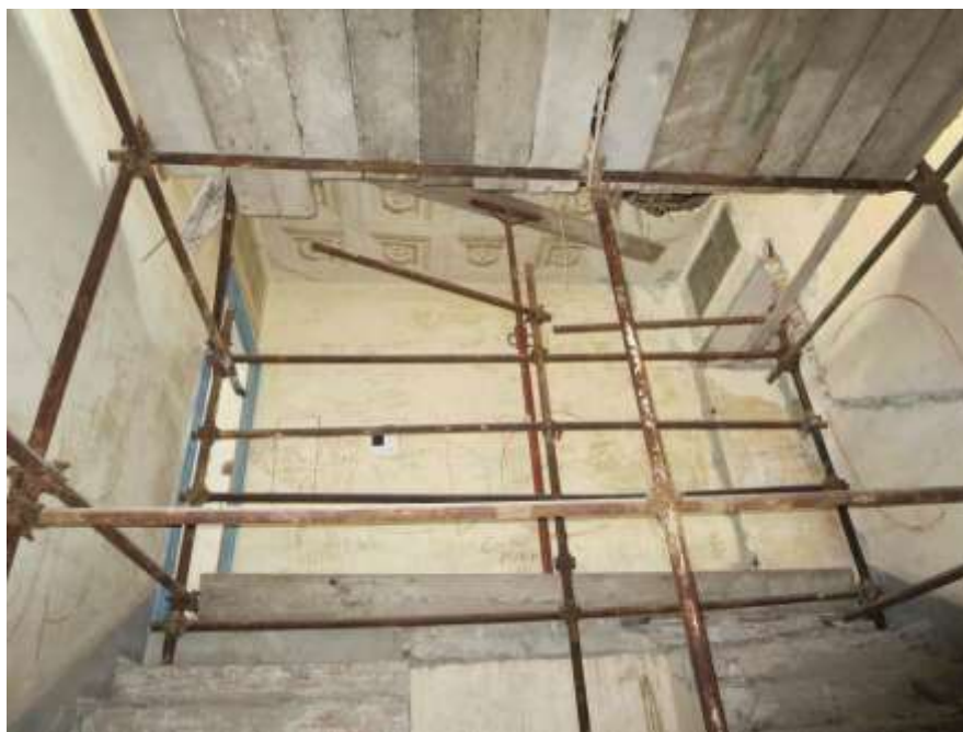
Figura 4-51. PALAZZO PARETO – PT - Vano 10 – Parete A
