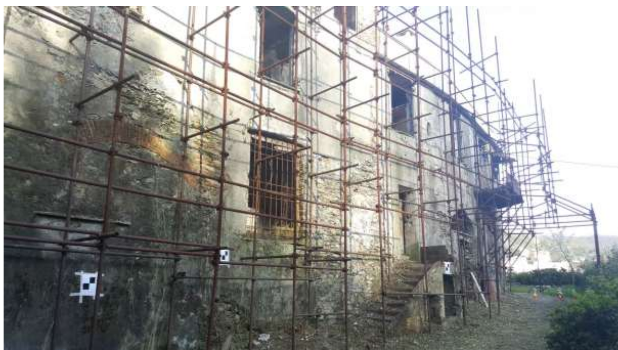
Figura 4-171. PALAZZO PARETO – Facciata ovest
