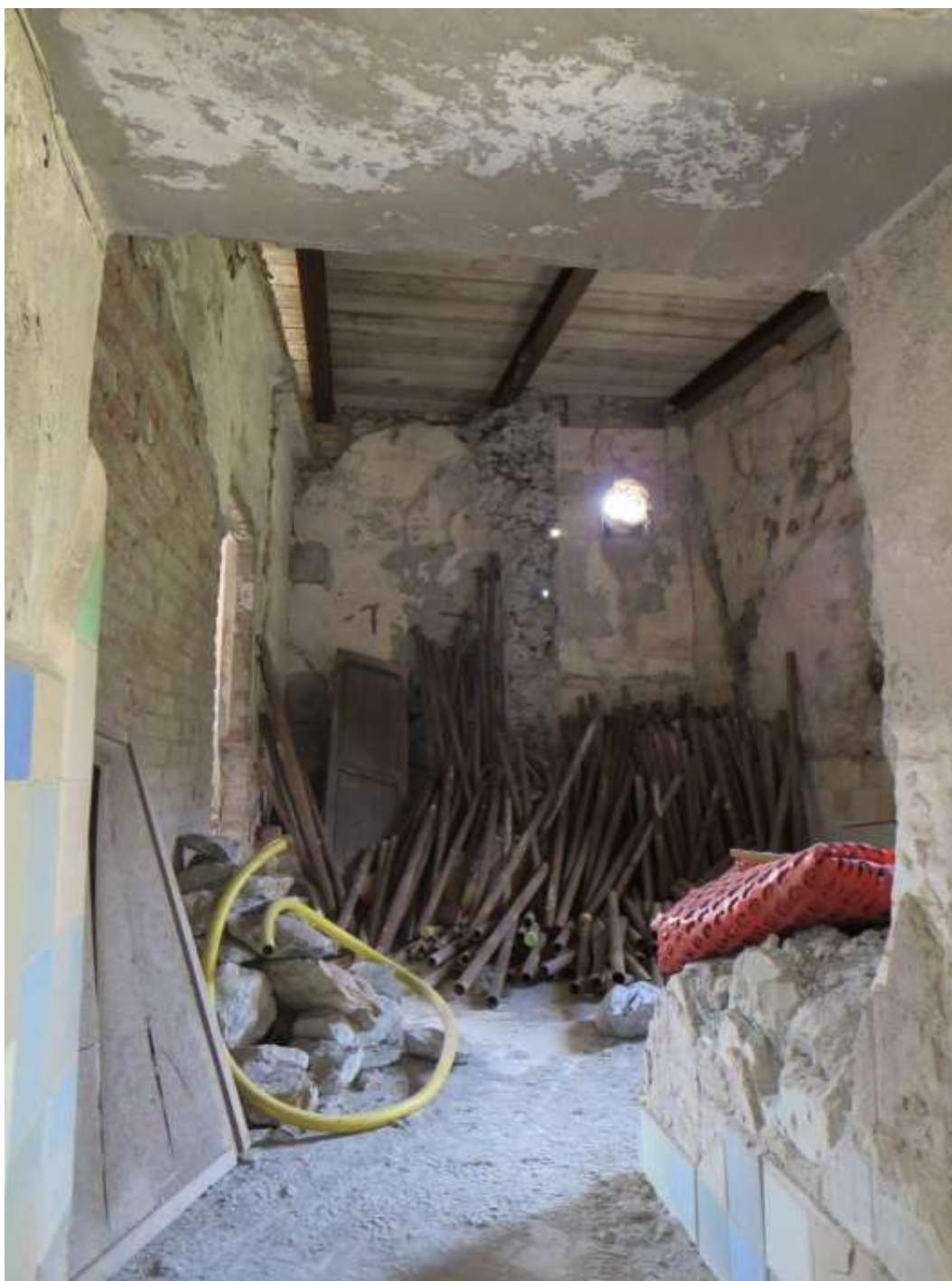
Figura 4-66. PALAZZO PARETO – PT - Vano 13 – Parete B
