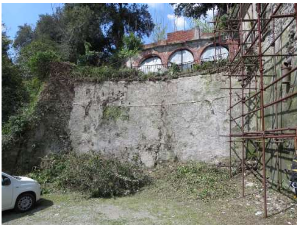
Figura 4-175. PALAZZO PARETO – Muro di contenimento
