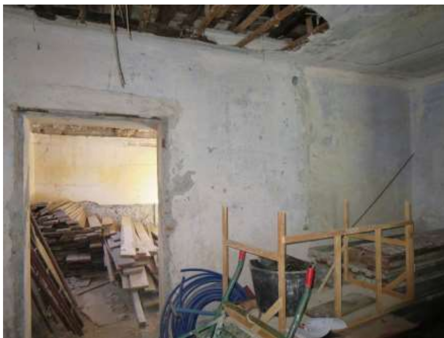
Figura 4-8. PALAZZO PARETO – PT - Vano 2 – Parete B
