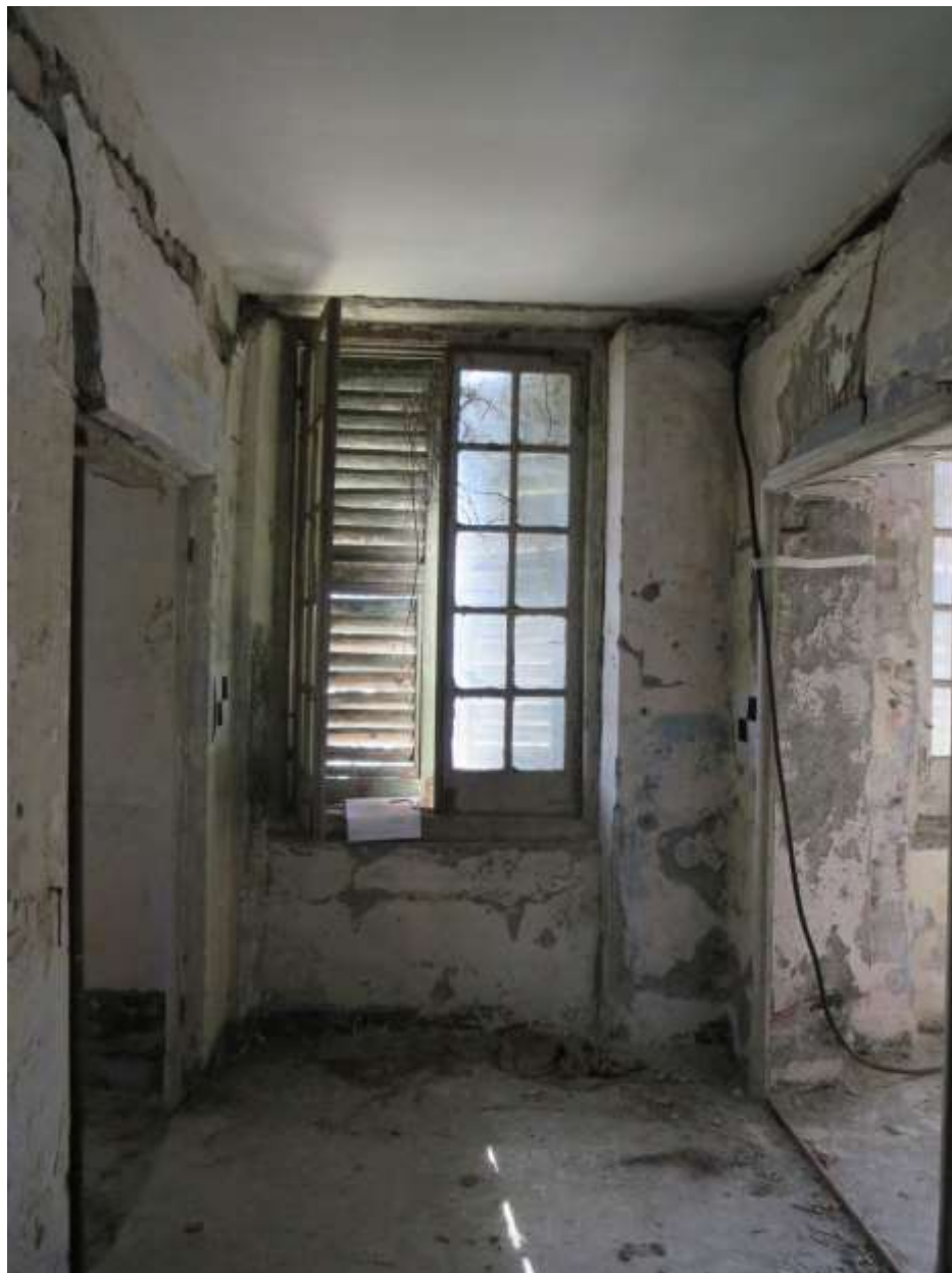
Figura 4-122. PALAZZO PARETO – P1 - Vano 9 – Parete B
