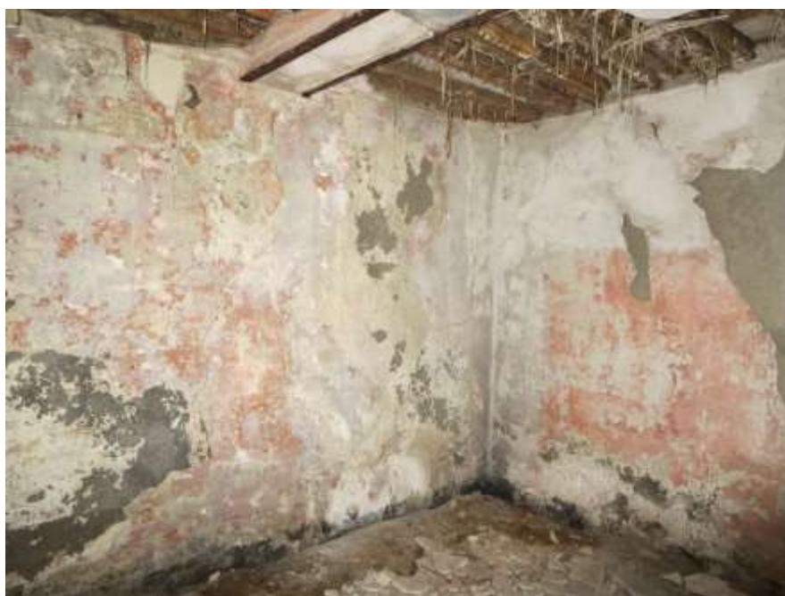
Figura 4-23. PALAZZO PARETO – PT - Vano 5 – Parete C
