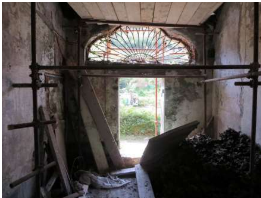
Figura 4-57. PALAZZO PARETO – PT - Vano 11 – Parete C
