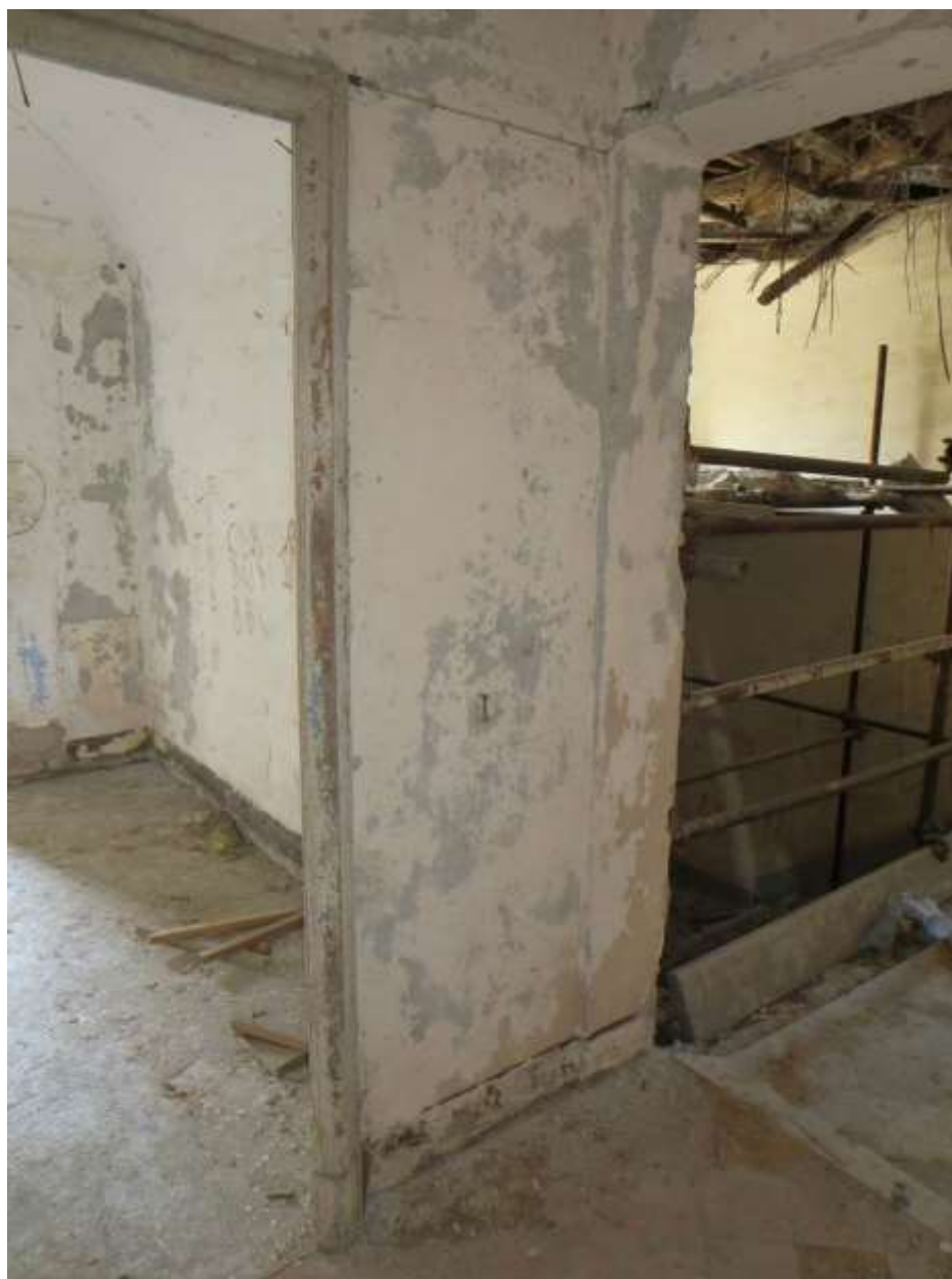
Figura 4-144. PALAZZO PARETO – P1 - Vano 13 – Pareti C e D
