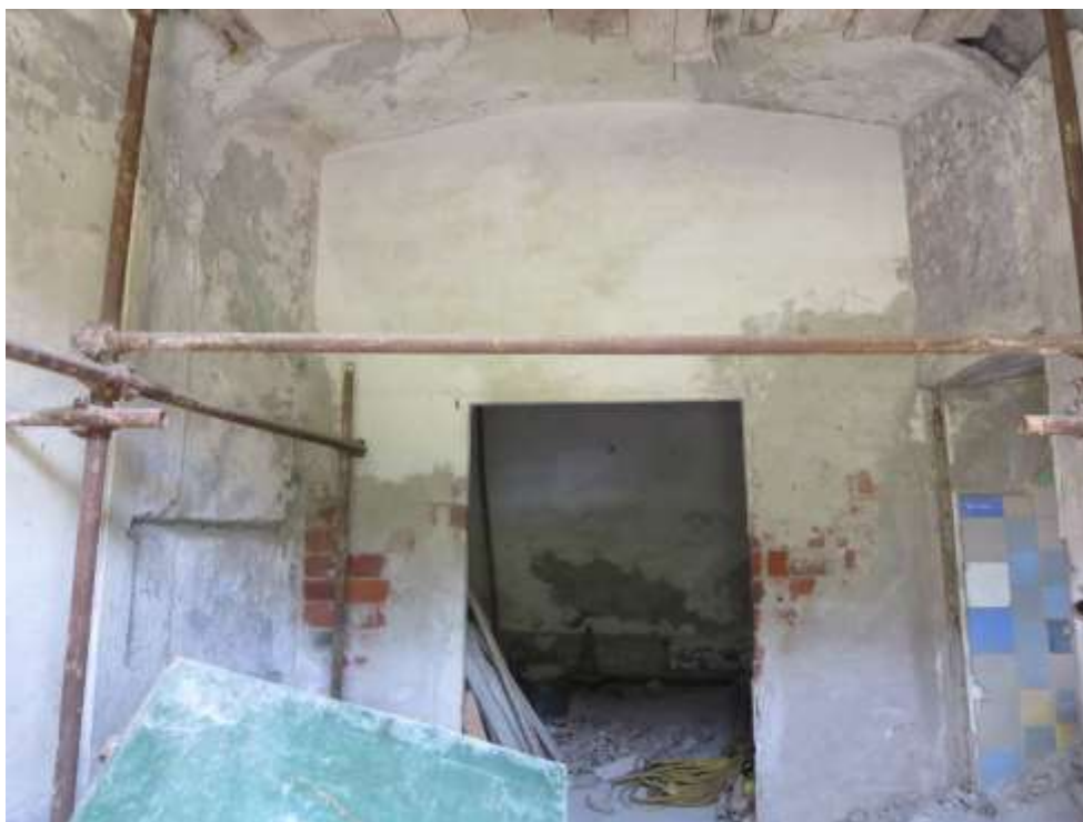
Figura 4-55. PALAZZO PARETO – PT - Vano 11 – Parete A
