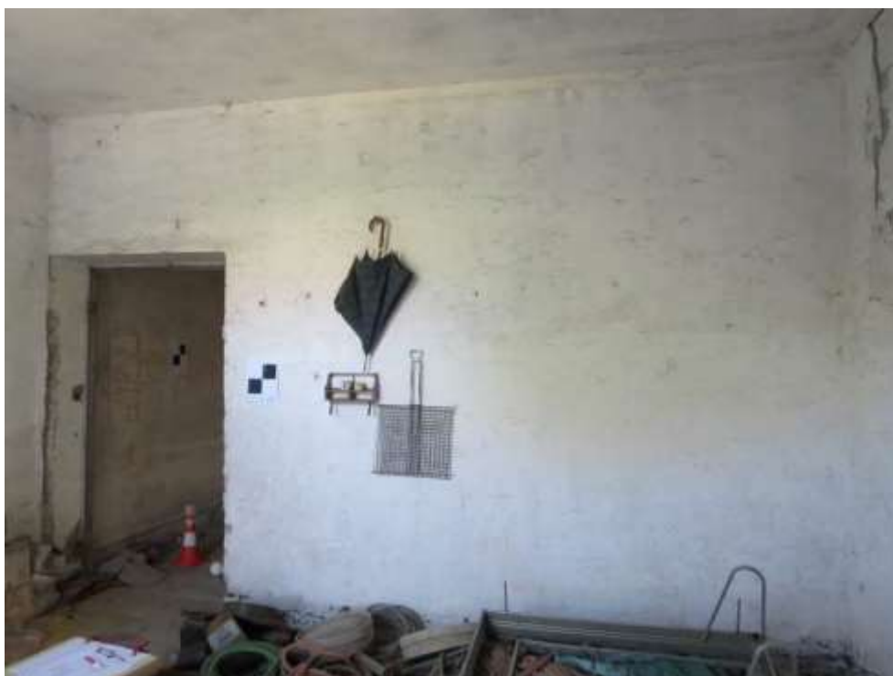
Figura 4-111. PALAZZO PARETO – P1 - Vano 7 – Parete B
