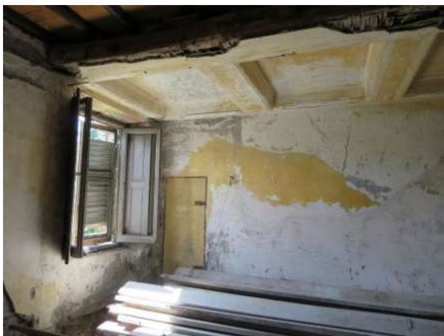
Figura 4-4. PALAZZO PARETO – PT - Vano 1 – Parete C
