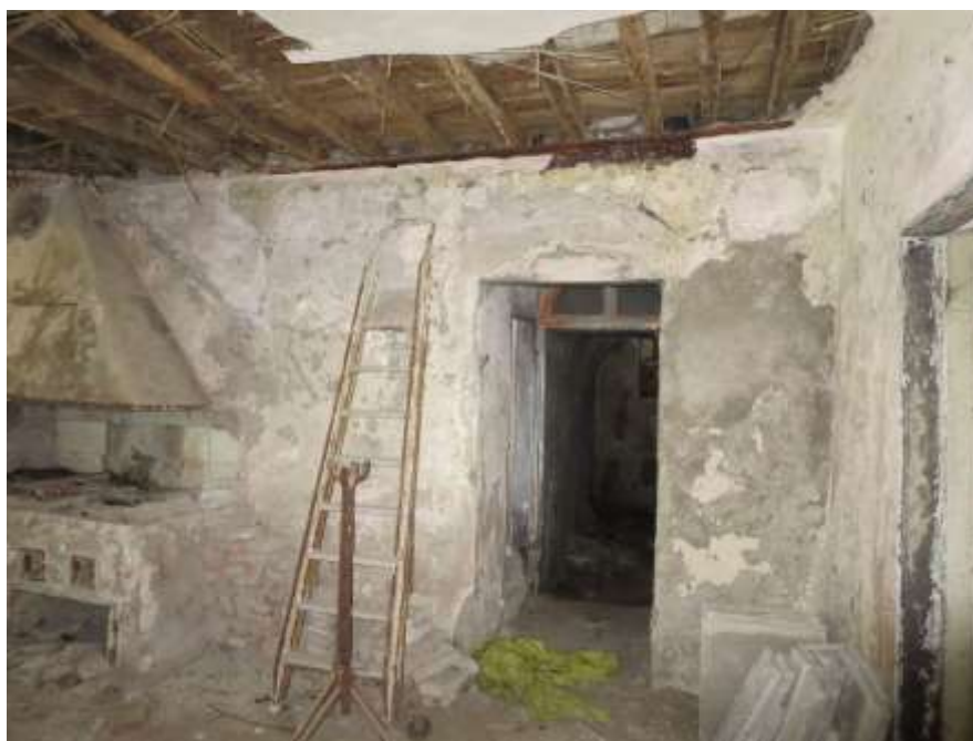
Figura 4-29. PALAZZO PARETO – PT - Vano 6 – Parete D
