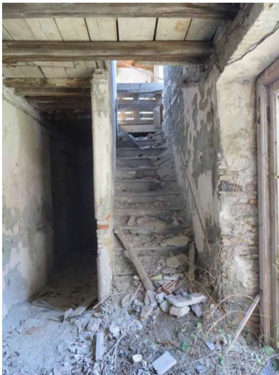
Figura 4-47. PALAZZO PARETO – PT - Vano 9” – Parete B
