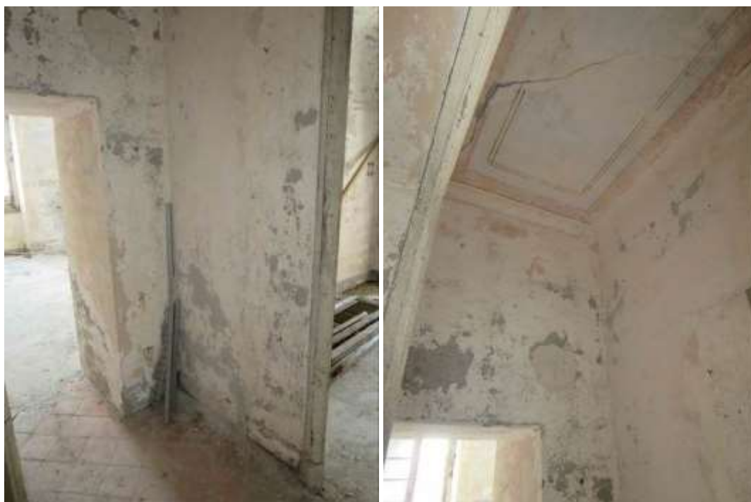
Figura 4-142. PALAZZO PARETO – P1 - Vano 13 – Pareti B e C
