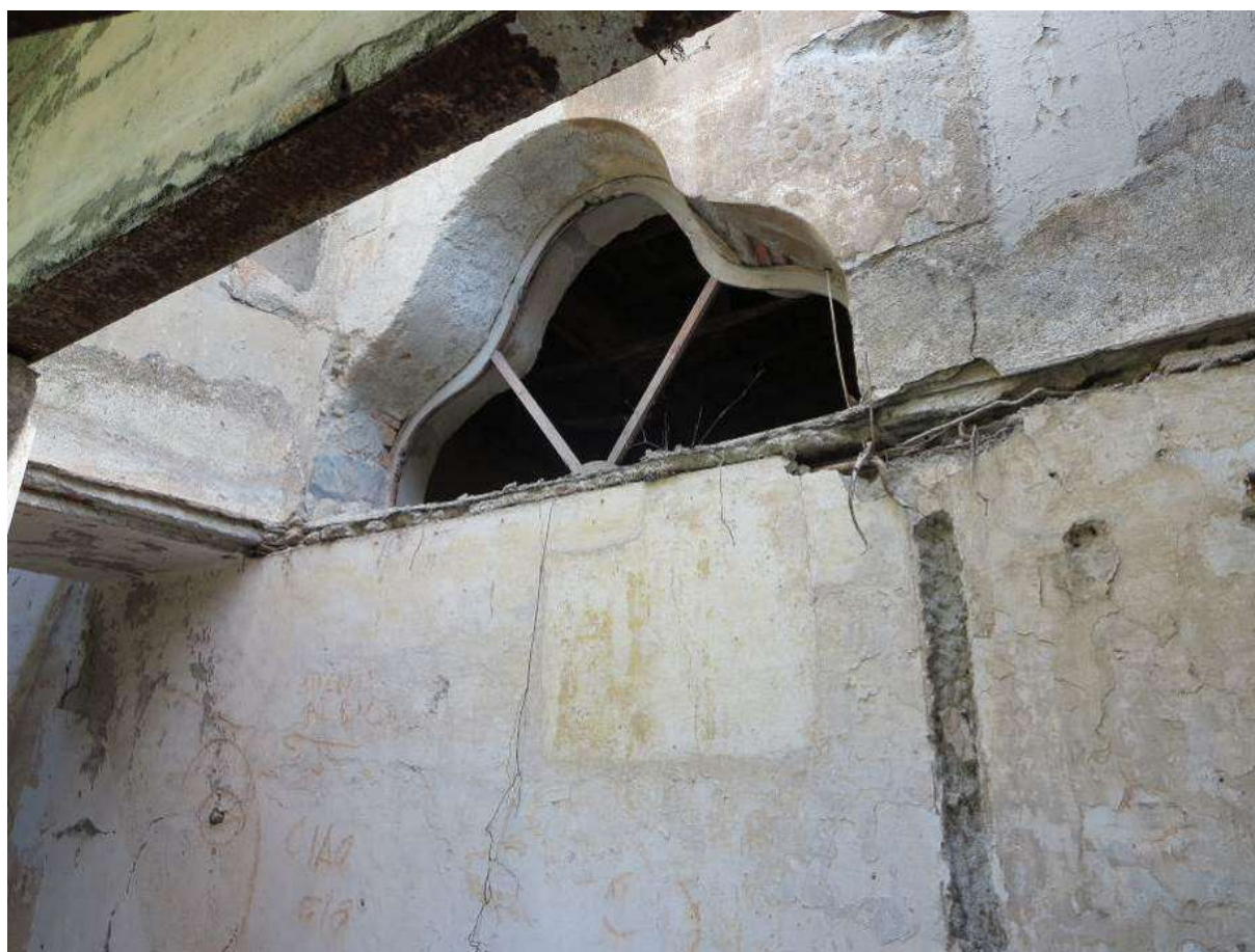
Figura 4-85. PALAZZO PARETO – P1 - Vano 3' – Pareti A
