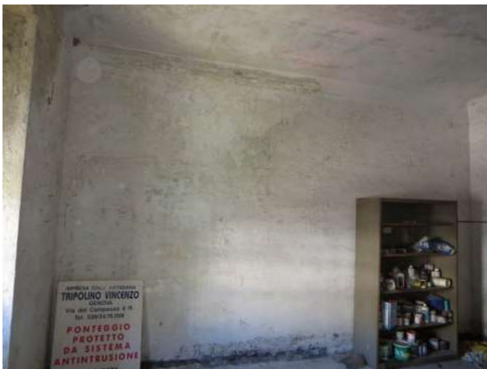
Figura 4-106. PALAZZO PARETO – P1 - Vano 6 – Parete B
