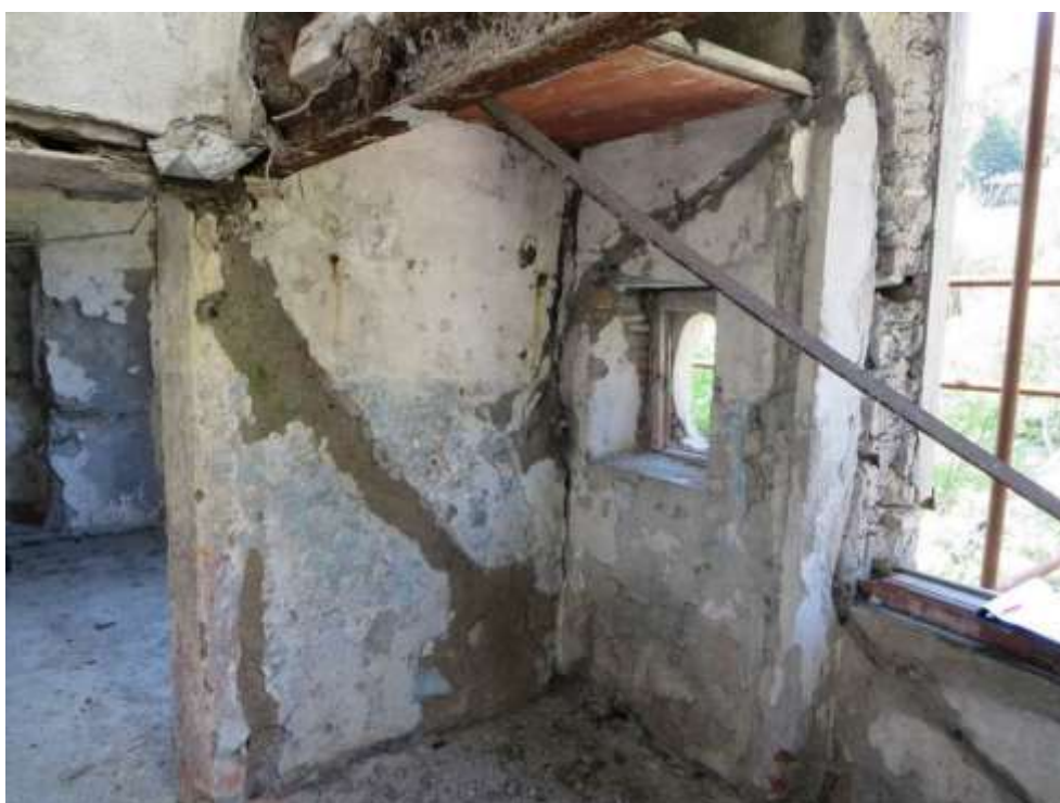
Figura 4-87. PALAZZO PARETO – P1 - Vano 3' – Pareti B e C
