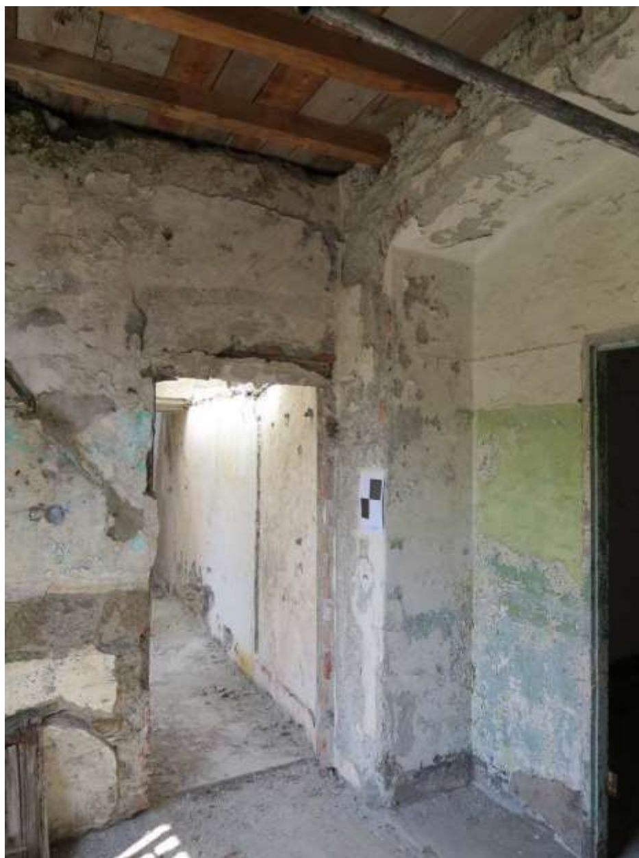
Figura 4-156. PALAZZO PARETO – P1 - Vano 15 – Pareti D e A
