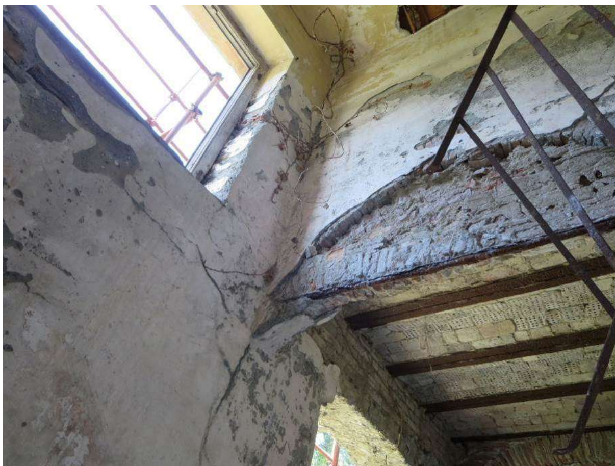
Figura 4-88. PALAZZO PARETO – P1 - Vano 3' – Pareti C e D
