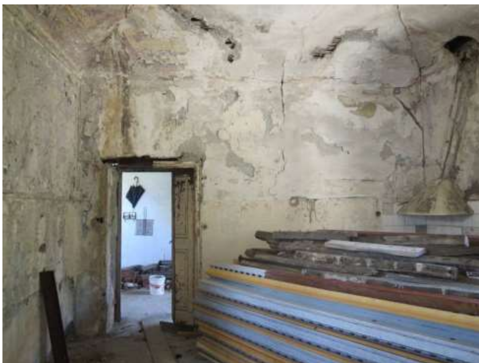
Figura 4-81. PALAZZO PARETO – P1 - Vano 2 – Parete B
