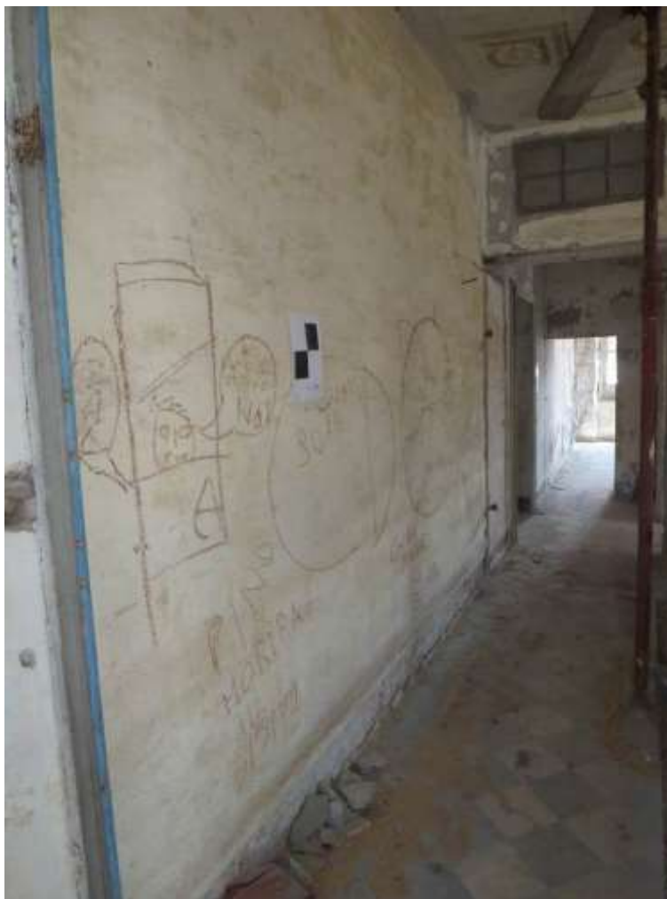
Figura 4-158. PALAZZO PARETO – P1 - Vano 16 – Pareti A e B
