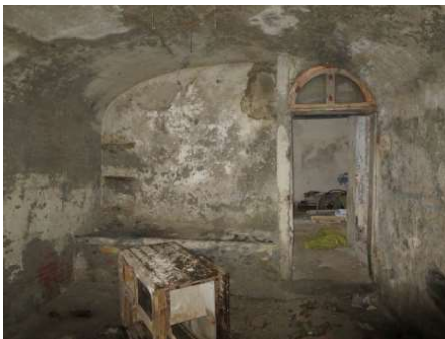
Figura 4-32. PALAZZO PARETO – PT - Vano 7 – Parete B
