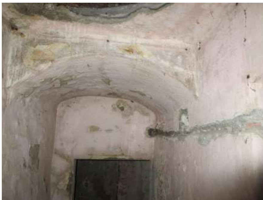
Figura 4-36. PALAZZO PARETO – PT - Vano 8 – Parete A
