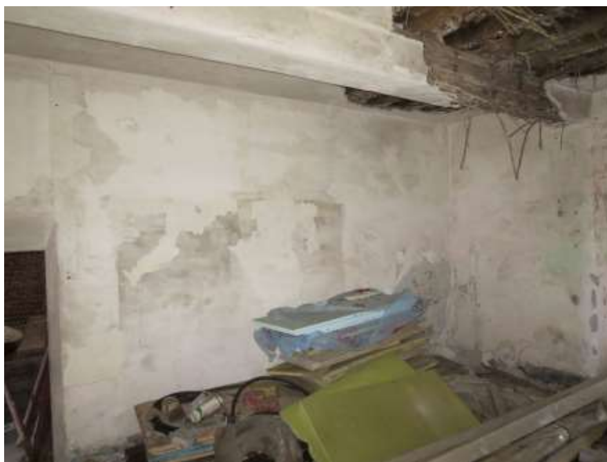
Figura 4-27. PALAZZO PARETO – PT - Vano 6 – Parete B
