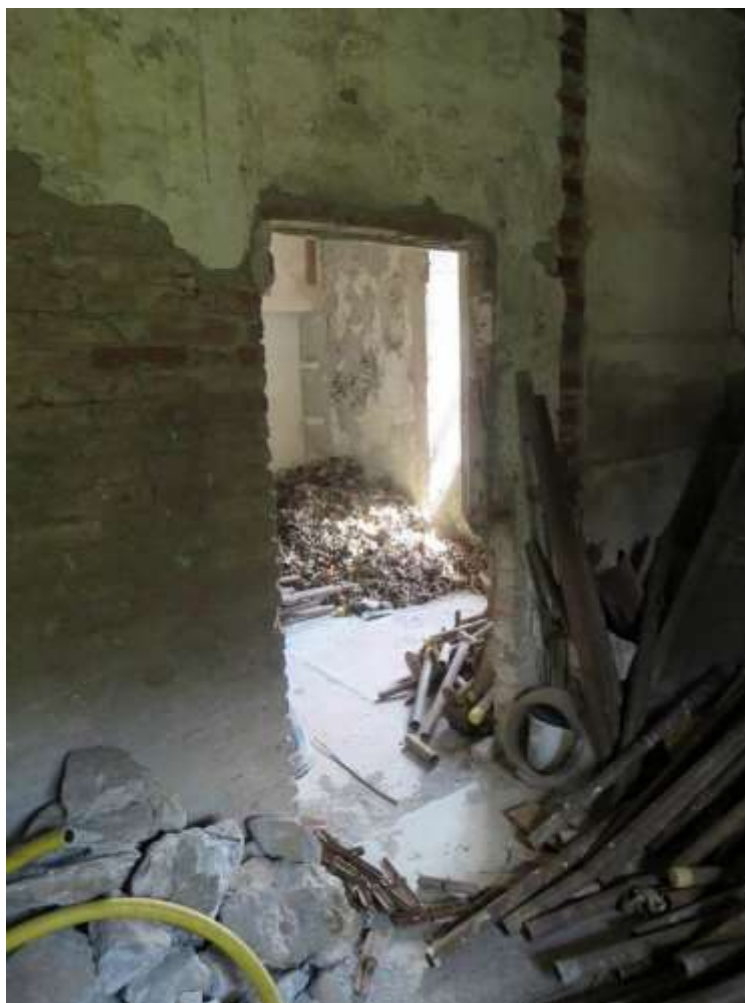
Figura 4-65. PALAZZO PARETO – PT - Vano 13 – Parete A
