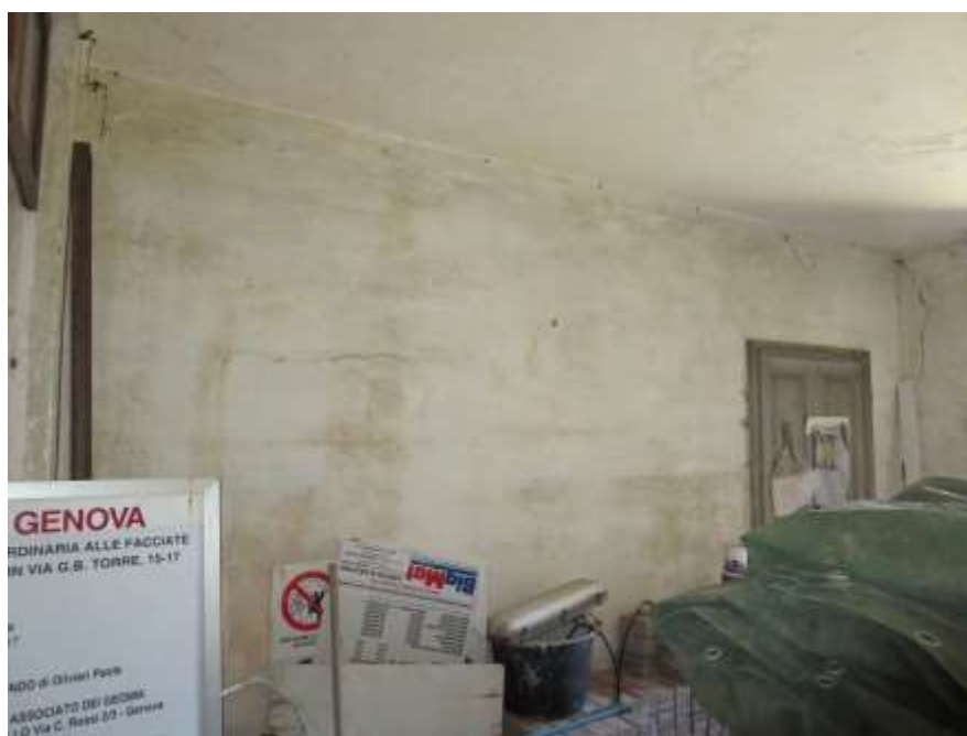
Figura 4-15. PALAZZO PARETO – PT - Vano 3 – Parete D
