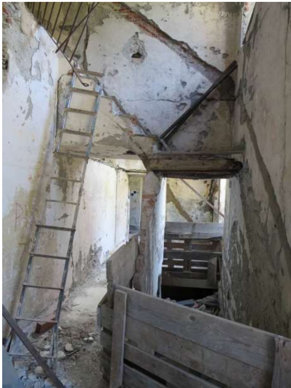
Figura 4-91. PALAZZO PARETO – P1 - Vano 3” – Parete B
