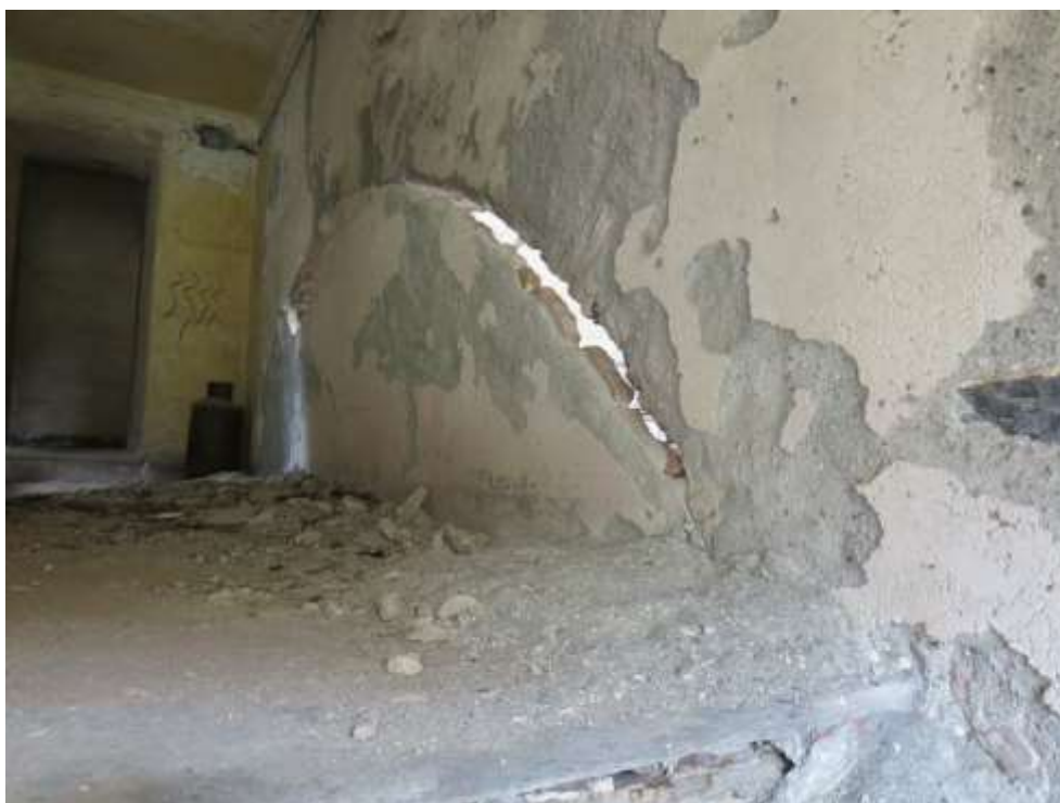
Figura 4-167. PALAZZO PARETO – P2 - Vano 1 – Pareti A e B
