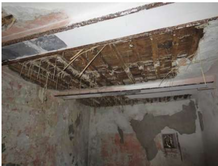
Figura 4-24. PALAZZO PARETO – PT - Vano 5 – Parete D
