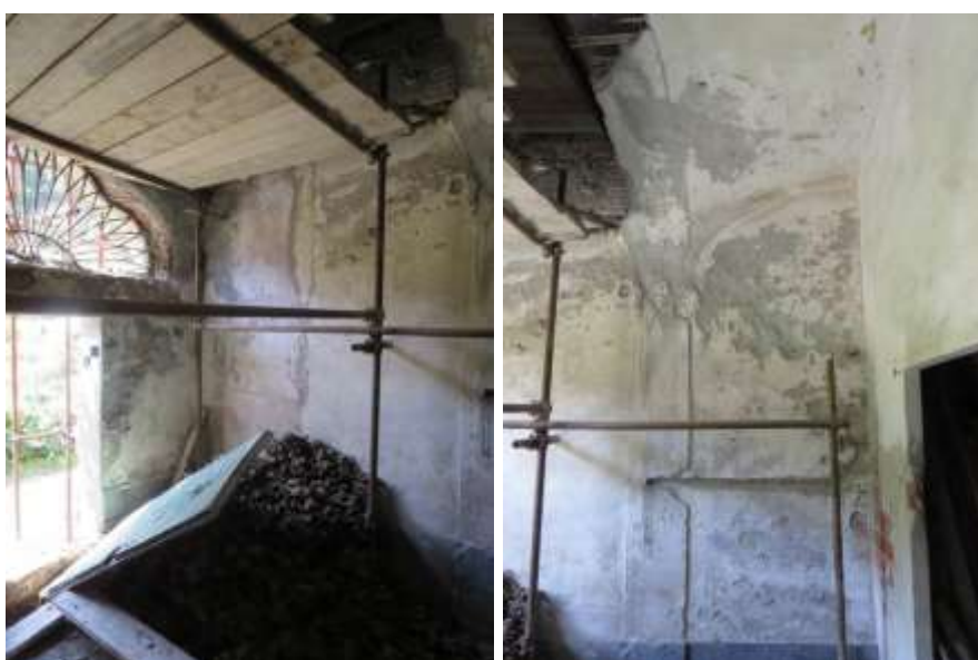
Figura 4-58. PALAZZO PARETO – PT - Vano 11 – Parete D
