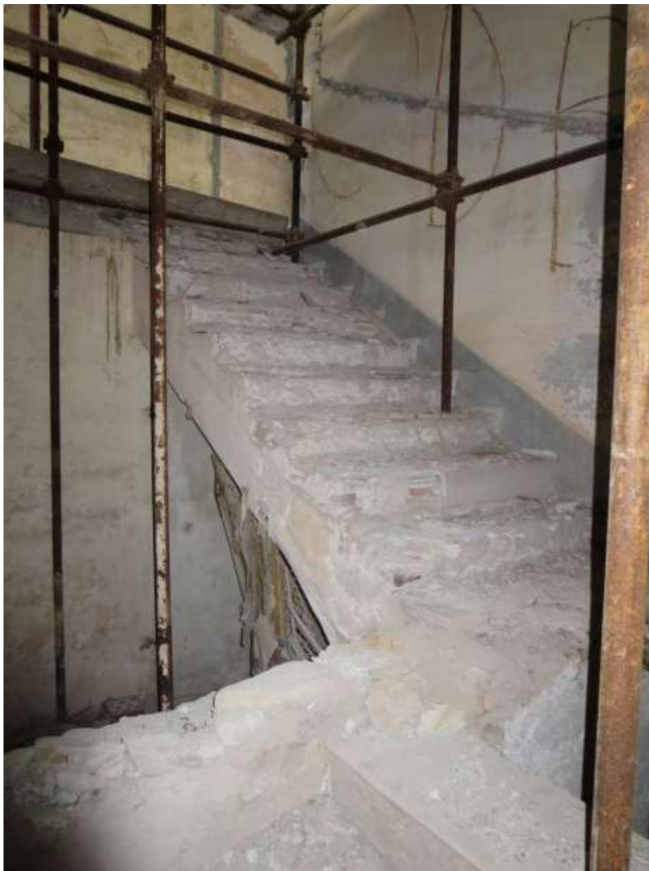
Figura 4-52. PALAZZO PARETO – PT - Vano 10 – Pareti A e B
