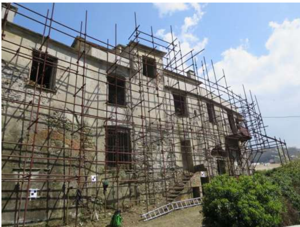
Figura 4-172. PALAZZO PARETO – Facciata ovest
