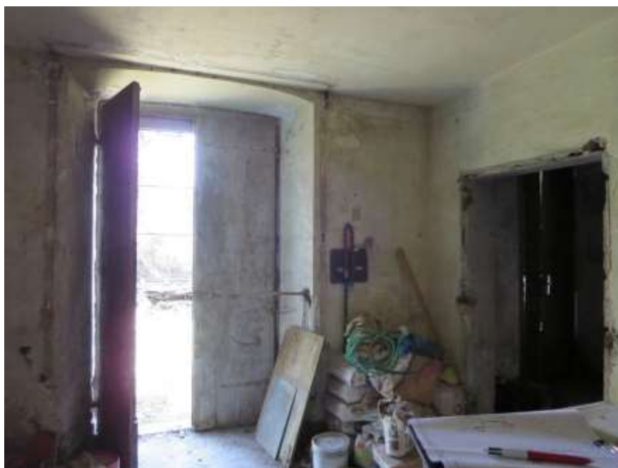
Figura 4-12. PALAZZO PARETO – PT - Vano 3 – Parete A
