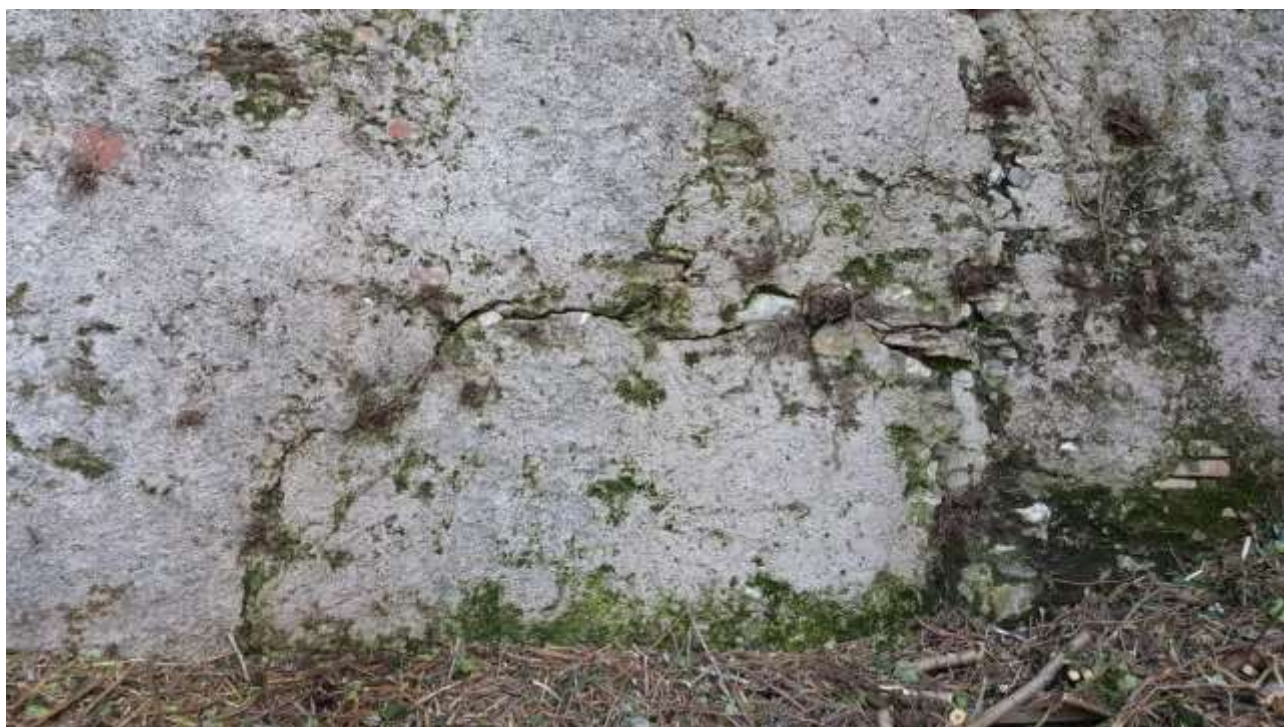
Figura 4-227. PALAZZO PARETO – Muro di contenimento, dettaglio
