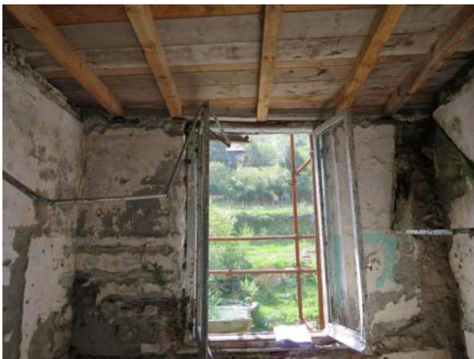
Figura 4-201. PALAZZO PARETO – P1 - Vano 15 – Parete C
