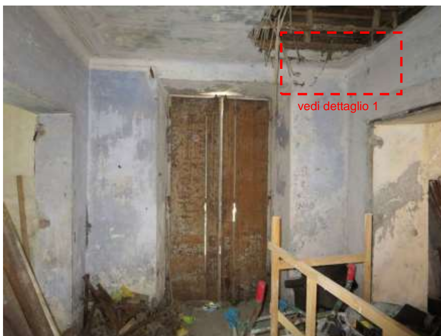
Figura 4-12. PALAZZO PARETO – PT - Vano 2 – Parete A
