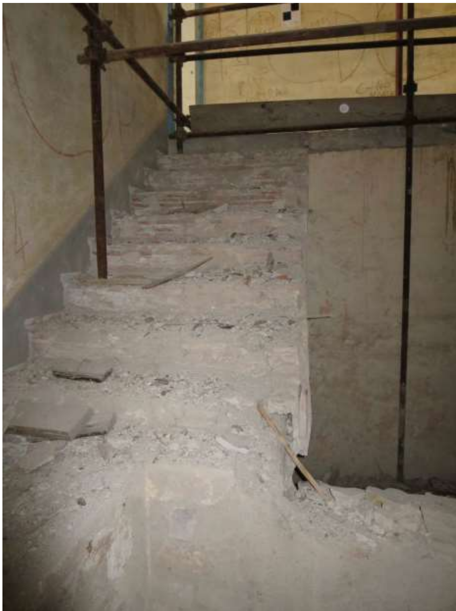
Figura 4-71. PALAZZO PARETO – PT - Vano 10 – Pareti D e A
