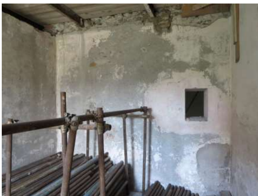
Figura 4-98. PALAZZO PARETO – PT - Vano 14 – Parete D
