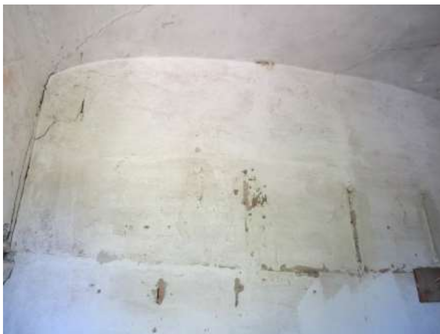
Figura 4-180. PALAZZO PARETO – P1 - Vano 12 – Parete B
