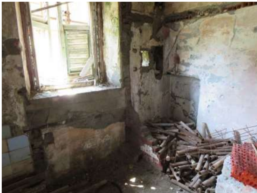
Figura 4-92. PALAZZO PARETO – PT - Vano 13 – Pareti C e D
