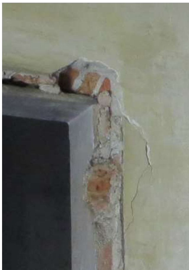
Figura 4-21. PALAZZO PARETO – PT - Vano 3 – Dettaglio spalla porta Parete B
