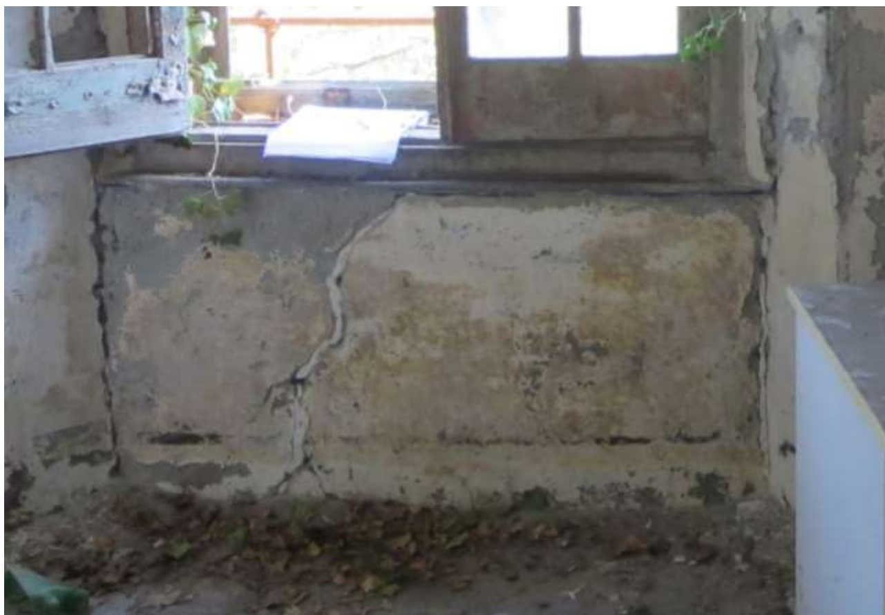
Figura 4-123. PALAZZO PARETO – P1 - Vano 4 – Sottodavanzale Parete A
