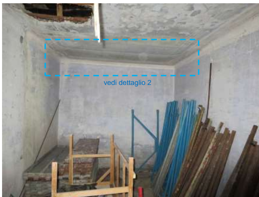
Figura 4-15. PALAZZO PARETO – PT - Vano 2 – Parete C
