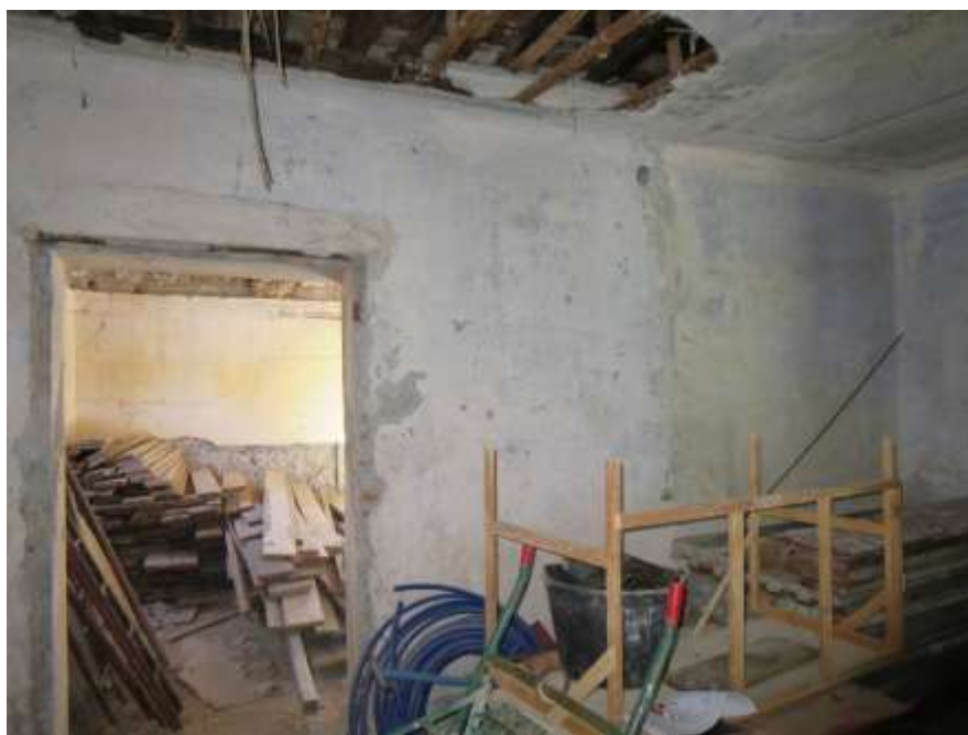
Figura 4-14. PALAZZO PARETO – PT - Vano 2 – Parete B
