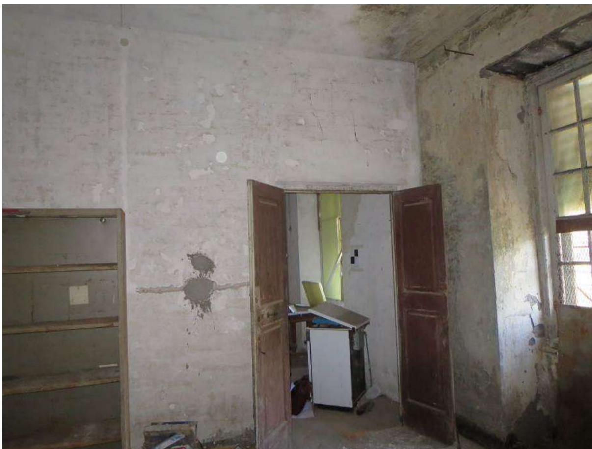
Figura 4-141. PALAZZO PARETO – P1 - Vano 6 – Parete D
