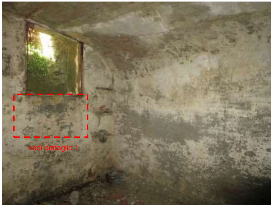
Figura 4-46. PALAZZO PARETO – PT - Vano 7 – Pareti D e A
