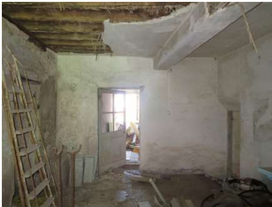
Figura 4-41. PALAZZO PARETO – PT - Vano 6 – Parete A
