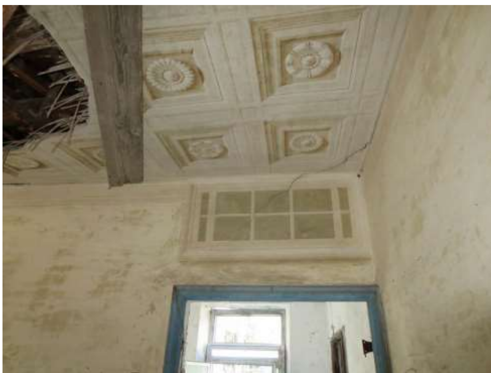
Figura 4-211. PALAZZO PARETO – P1 - Vano 16 – Parete D
