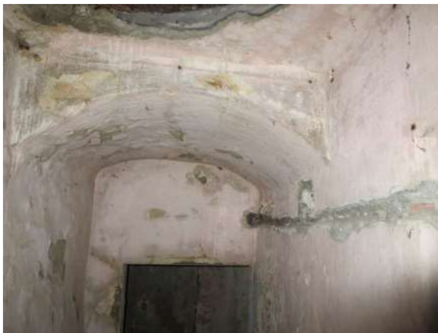
Figura 4-53. PALAZZO PARETO – PT - Vano 8 – Parete A
