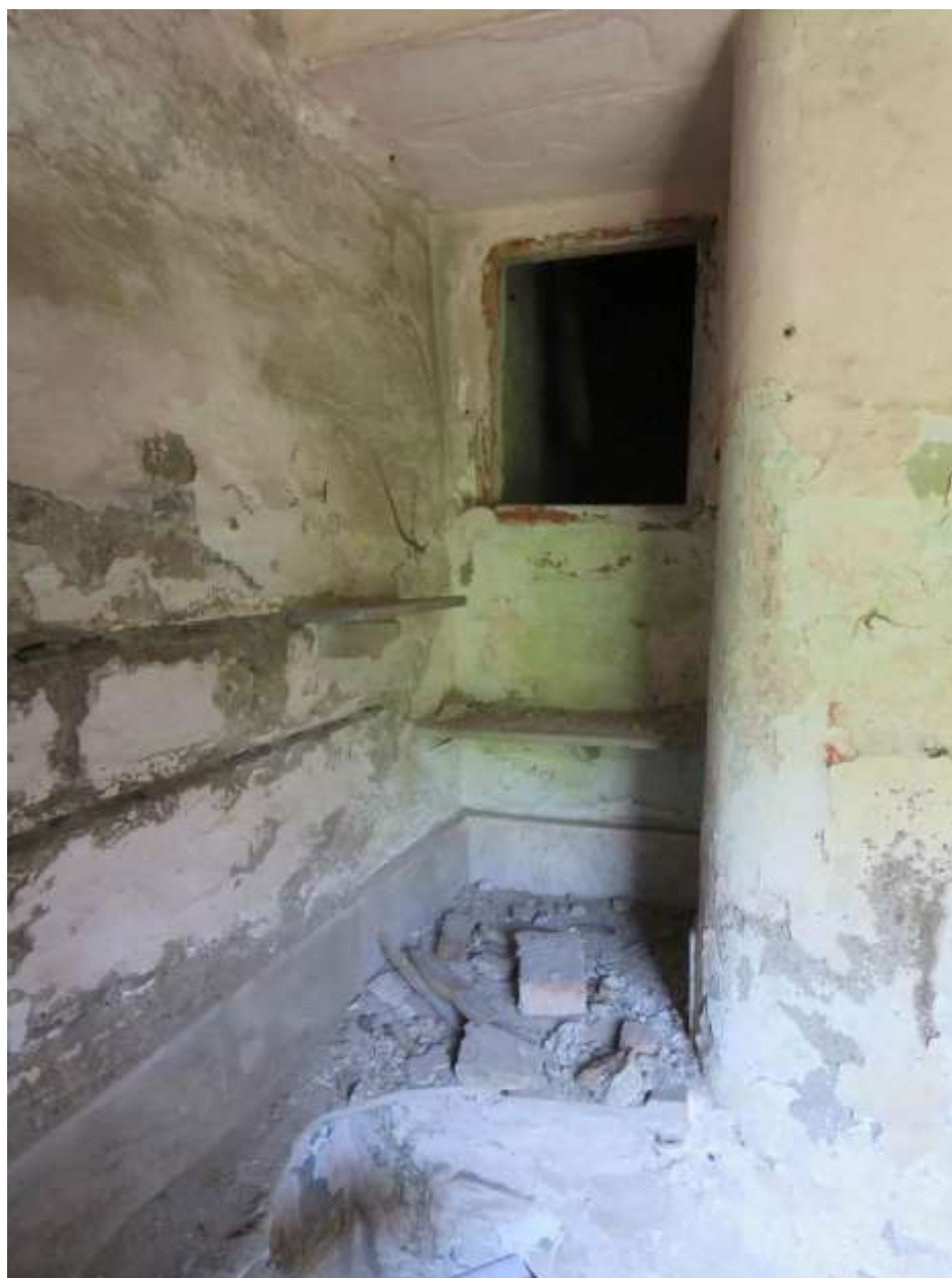
Figura 4-67. PALAZZO PARETO – PT - Vano 9” – Pareti D e A
