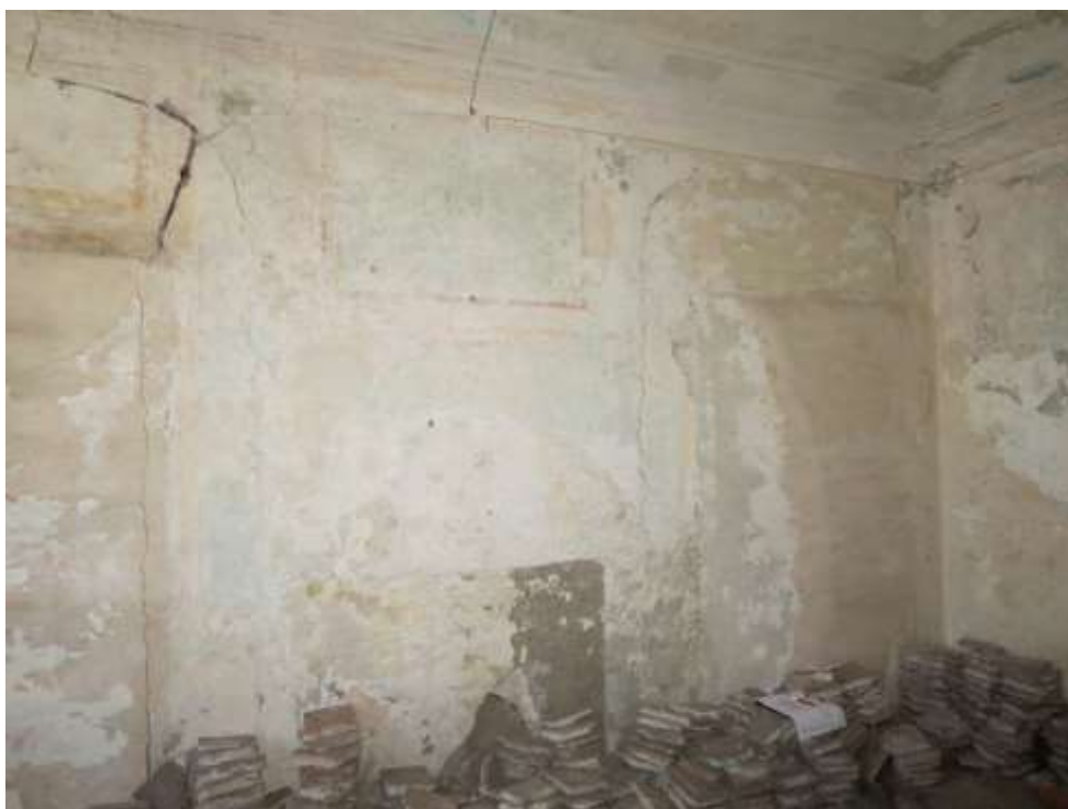
Figura 4-169. PALAZZO PARETO – P1 - Vano 11 – Parete B
