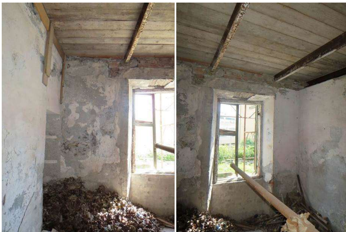
Figura 4-96. PALAZZO PARETO – PT - Vano 14 – Parete B
