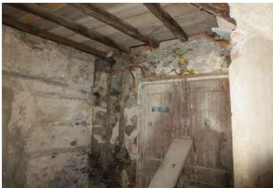
Figura 4-60. PALAZZO PARETO – PT - Vano 9' – Parete C
