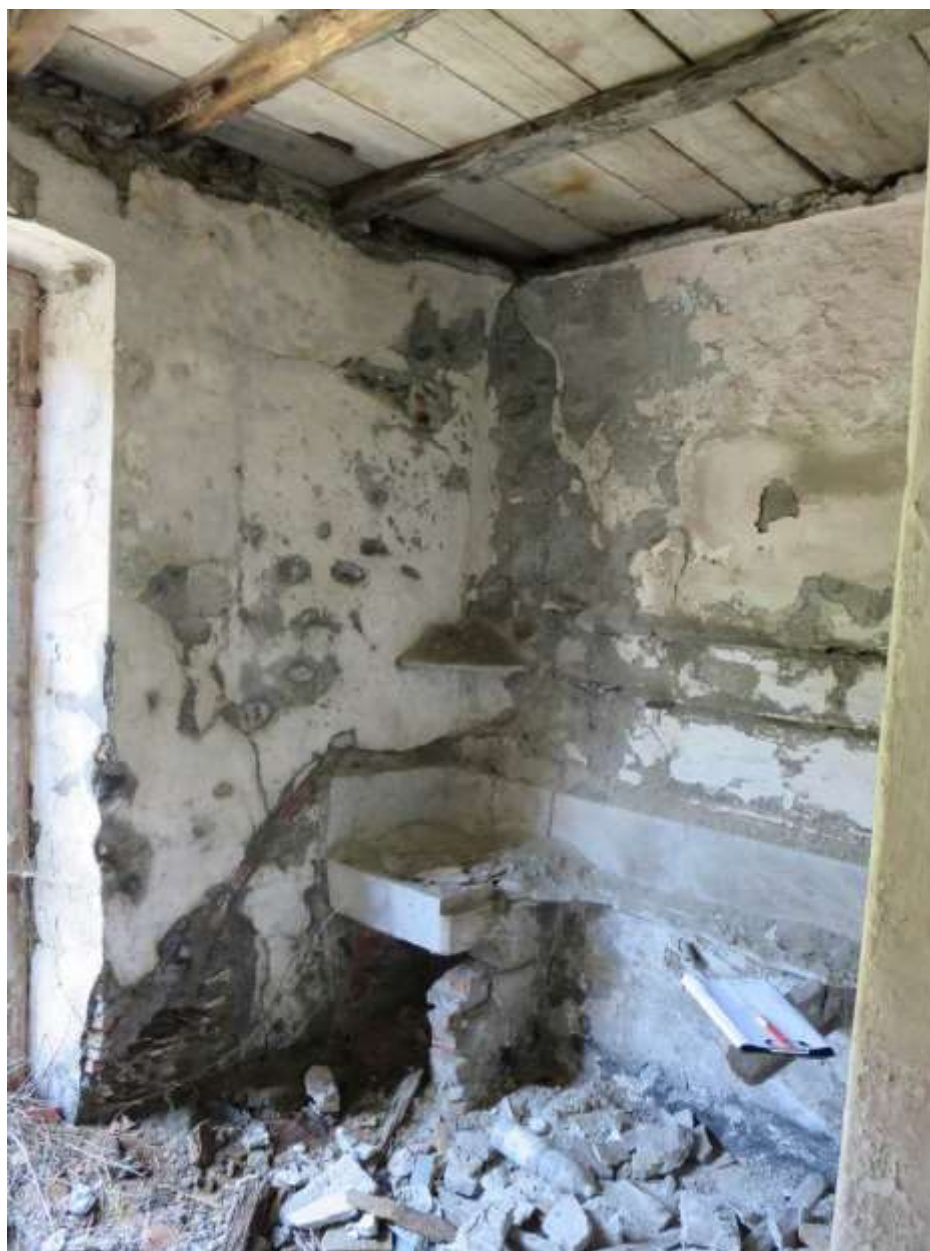
Figura 4-66. PALAZZO PARETO – PT - Vano 9” – Pareti C e D
