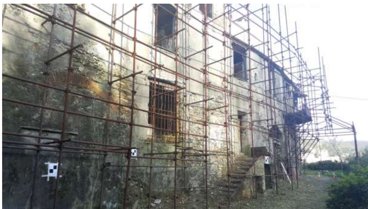
Figura 4-219. PALAZZO PARETO – Facciata ovest
