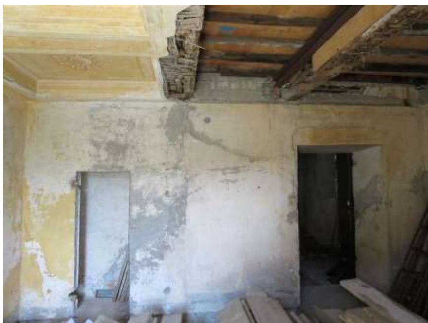
Figura 4-10. PALAZZO PARETO – PT - Vano 1 – Parete D
