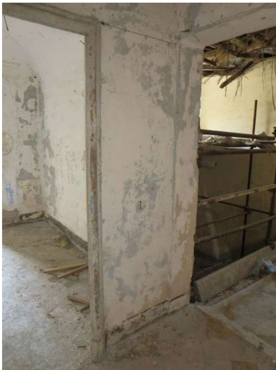
Figura 4-187. PALAZZO PARETO – P1 - Vano 13 – Pareti C e D
