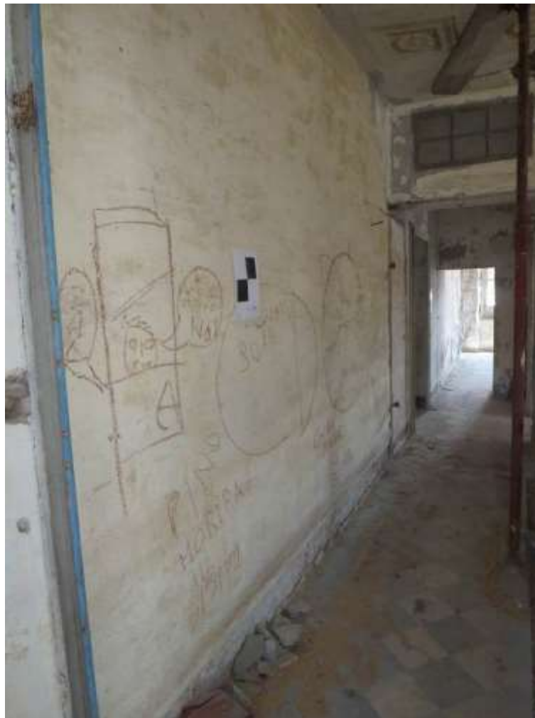
Figura 4-205. PALAZZO PARETO – P1 - Vano 16 – Pareti A e B
