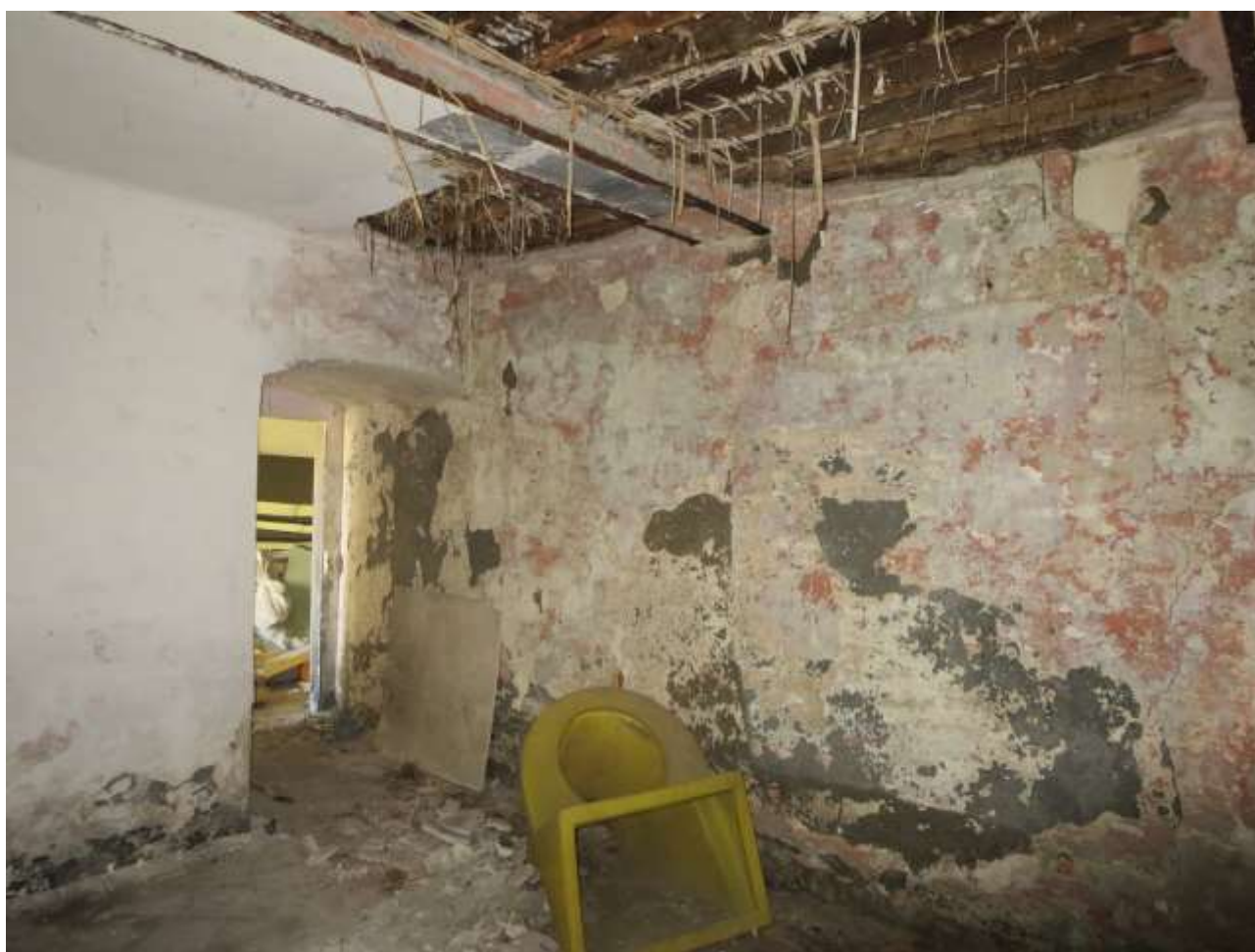
Figura 4-36. PALAZZO PARETO – PT - Vano 5 – Parete C
