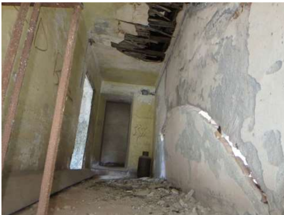
Figura 4-214. PALAZZO PARETO – P2 - Vano 1 – Pareti D, A e B
