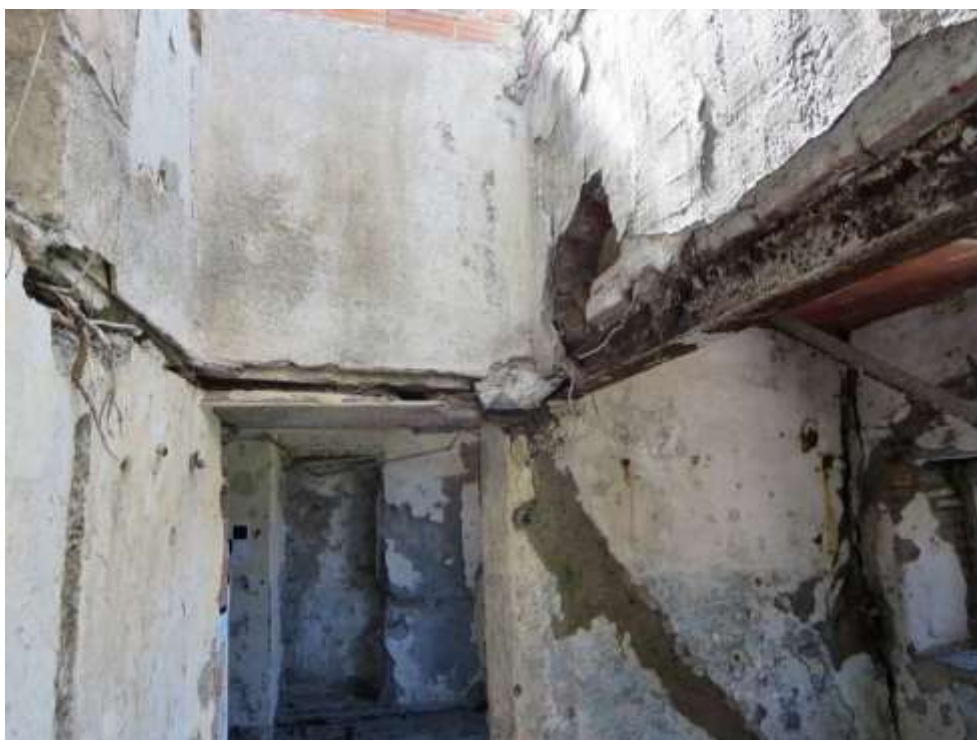
Figura 4-113. PALAZZO PARETO – P1 - Vano 3' – Parete B
