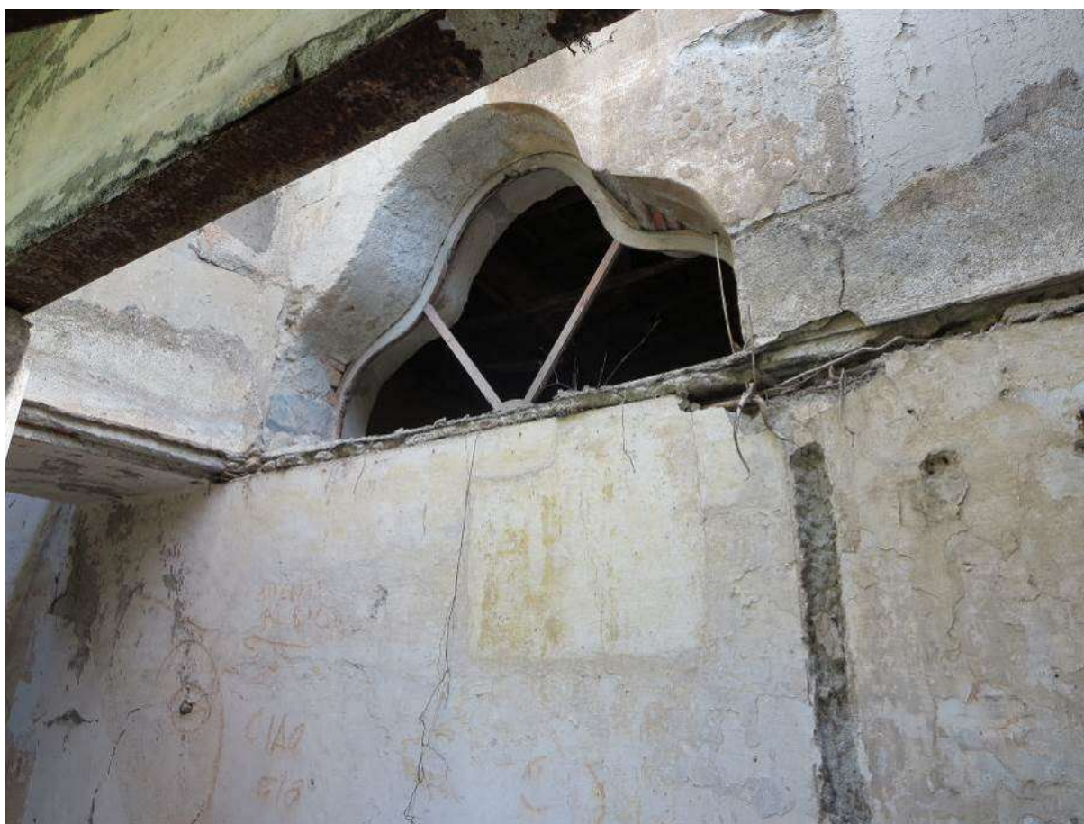
Figura 4-112. PALAZZO PARETO – P1 - Vano 3' – Pareti A
