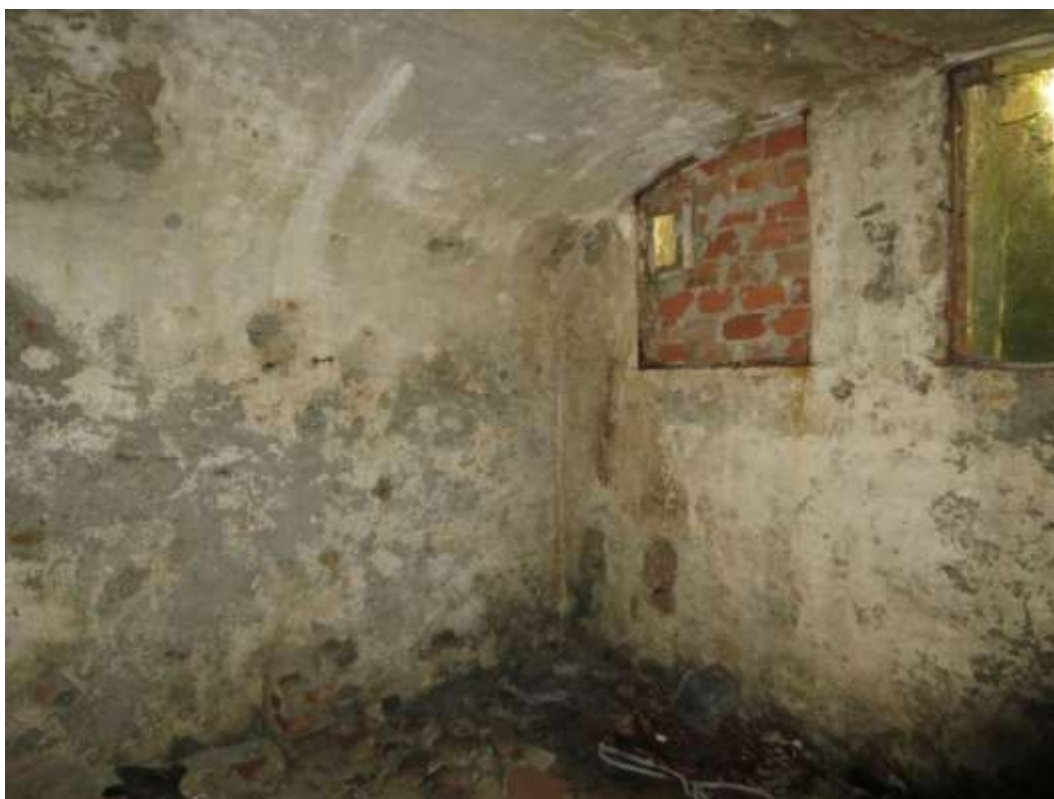
Figura 4-51. PALAZZO PARETO – PT - Vano 7 – Pareti C e D
