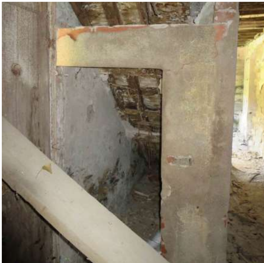
Figura 4-62. PALAZZO PARETO – PT - Vano 9' – Parete D
