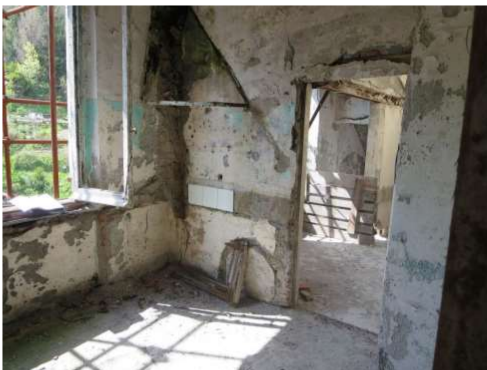
Figura 4-202. PALAZZO PARETO – P1 - Vano 15 – Pareti C e D
