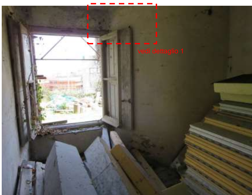
Figura 4-27. PALAZZO PARETO – PT - Vano 4 – Parete A
