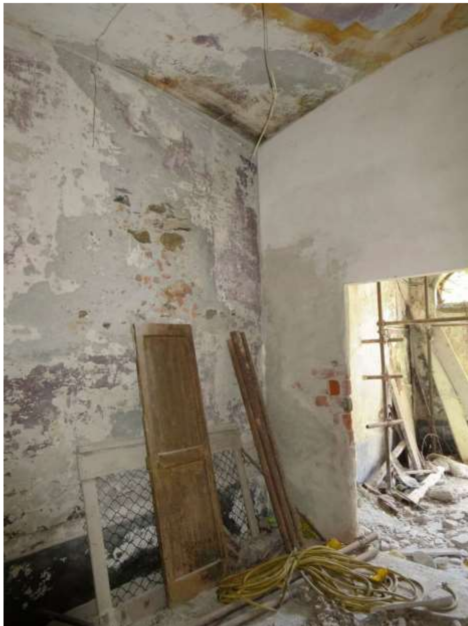
Figura 4-84. PALAZZO PARETO – PT - Vano 12 – Pareti B e C
