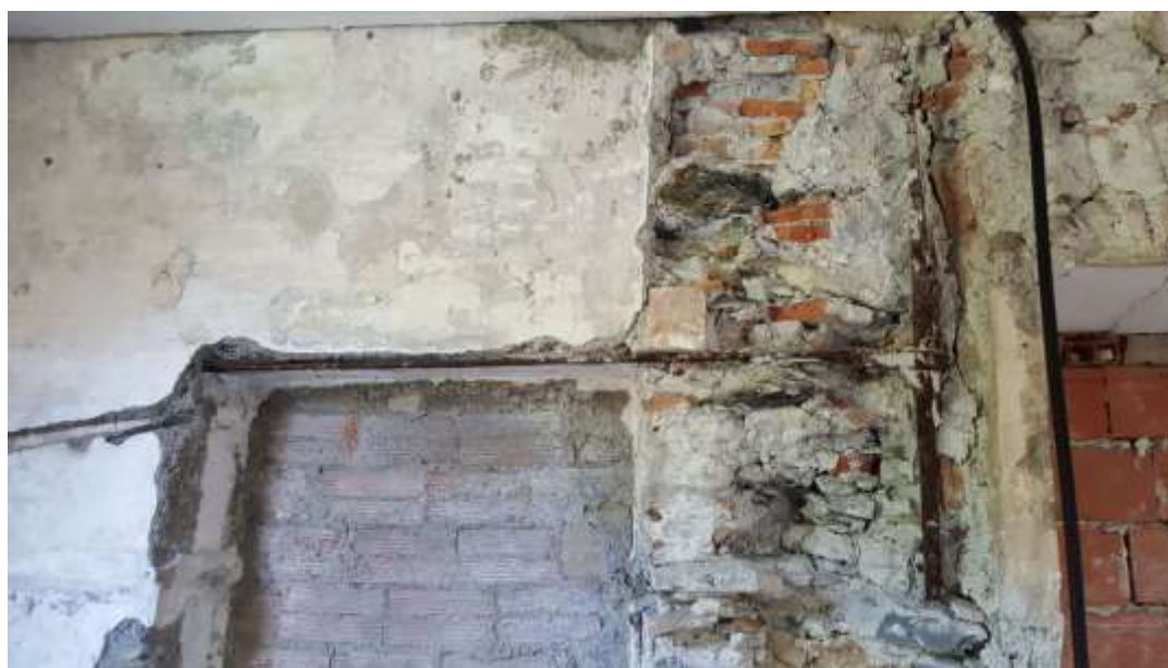
Figura 4-155. PALAZZO PARETO – P1 - Vano 8 – Particolare Angolo Parete D (martello della catena portata in evidenza post demolizione del muro)
