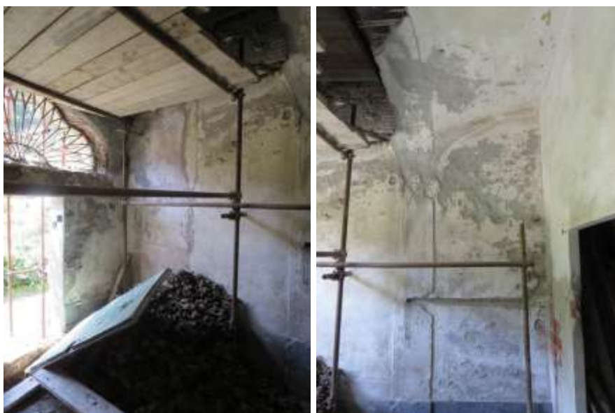
Figura 4-79. PALAZZO PARETO – PT - Vano 11 – Parete D
