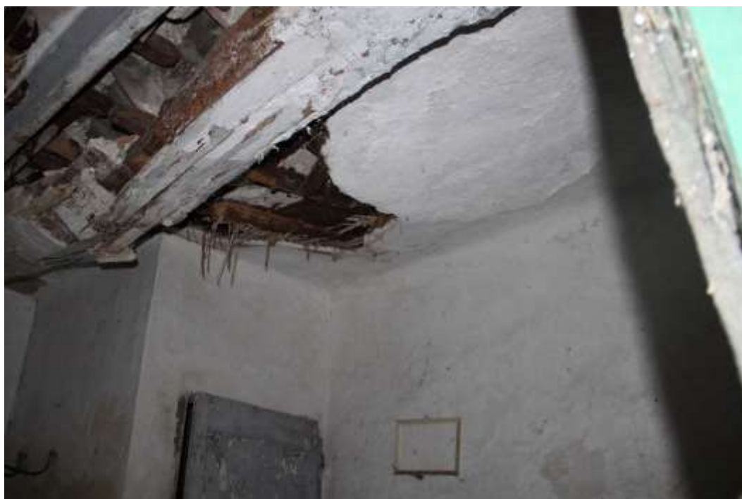
Figura 7-2. ANNESSO RUSTICO – Interno
