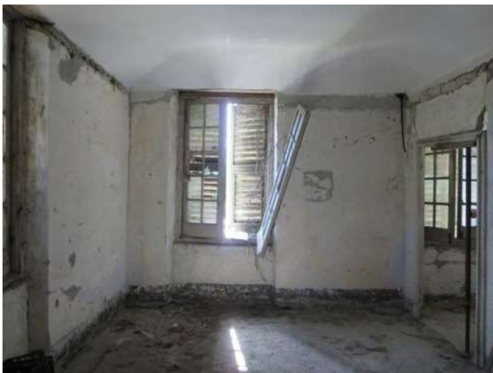
Figura 4-164. PALAZZO PARETO – P1 - Vano 10 – Parete B
