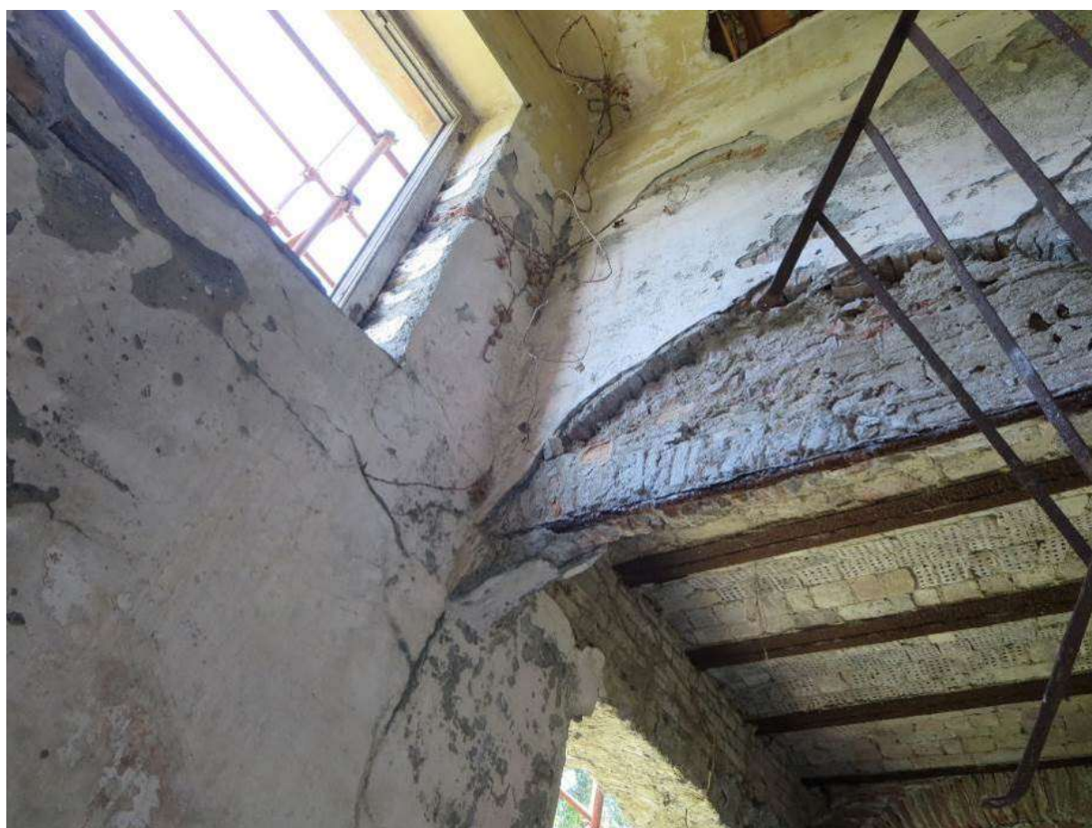
Figura 4-115. PALAZZO PARETO – P1 - Vano 3' – Pareti C e D
