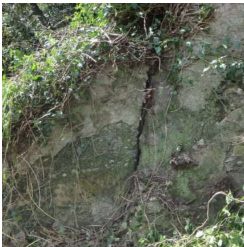
Figura 4-225. PALAZZO PARETO – Muro di contenimento, dettaglio
