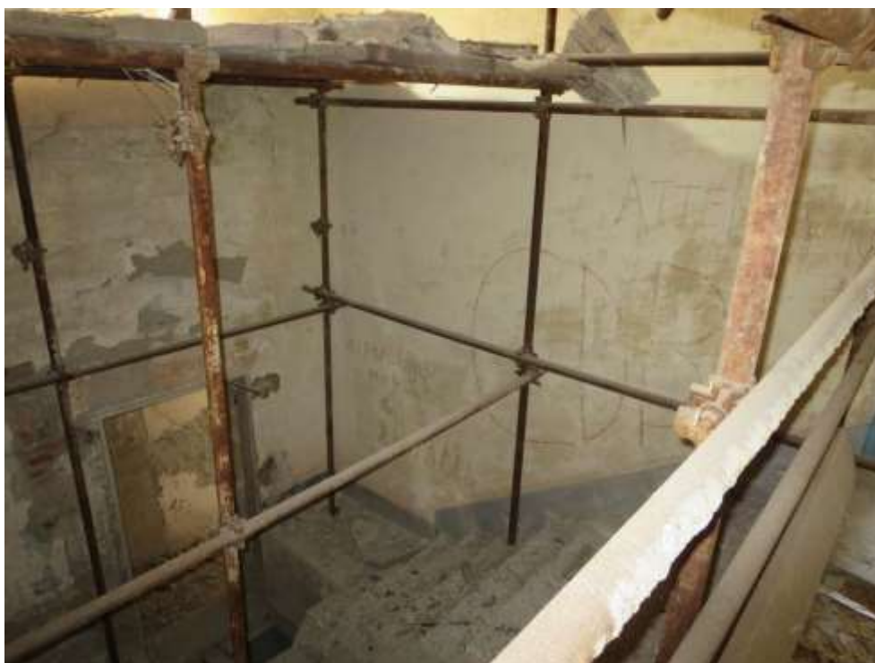
Figura 4-210. PALAZZO PARETO – P1 - Vano 16 – Pareti C e D
