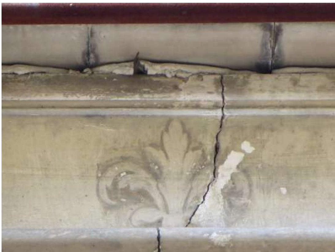
Figura 4-232. PALAZZO PARETO – Dettaglio cornice
