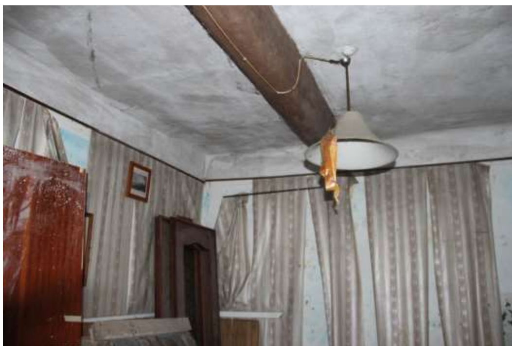
Figura 7-3. ANNESSO RUSTICO – Interno
