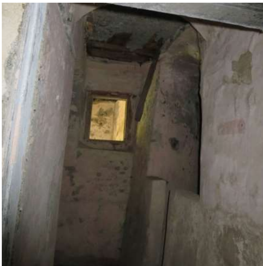
Figura 4-55. PALAZZO PARETO – PT - Vano 8 – Pareti C e D
