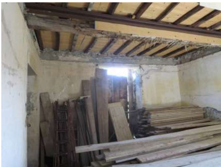
Figura 4-2. PALAZZO PARETO – PT - Vano 1 – Parete A
