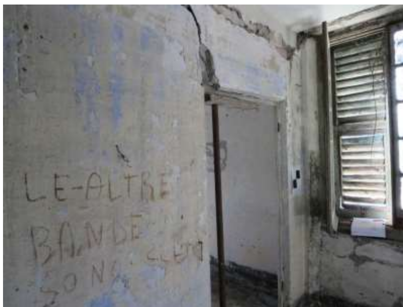
Figura 4-158. PALAZZO PARETO – P1 - Vano 9 – Pareti A e B
