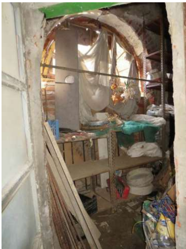
Figura 5-6. SERRA – PT - Vano 2 – Parete B
