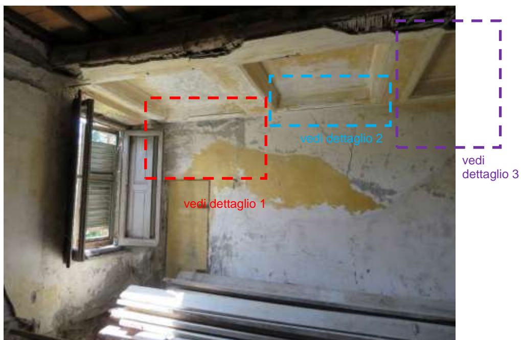
Figura 4-6. PALAZZO PARETO – PT - Vano 1 – Parete C
