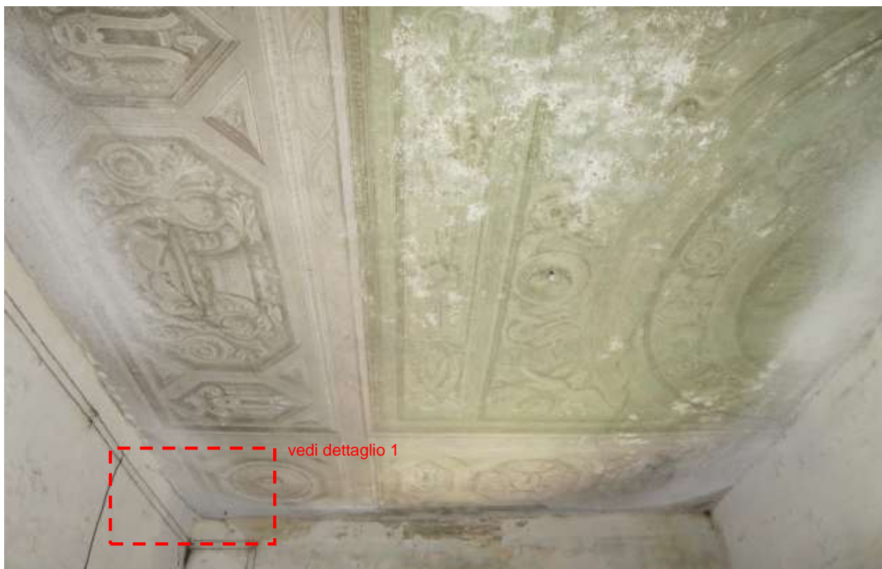
Figura 4-133. PALAZZO PARETO – P1 - Vano 5 – Soffitto (sul fondo Parete A)
