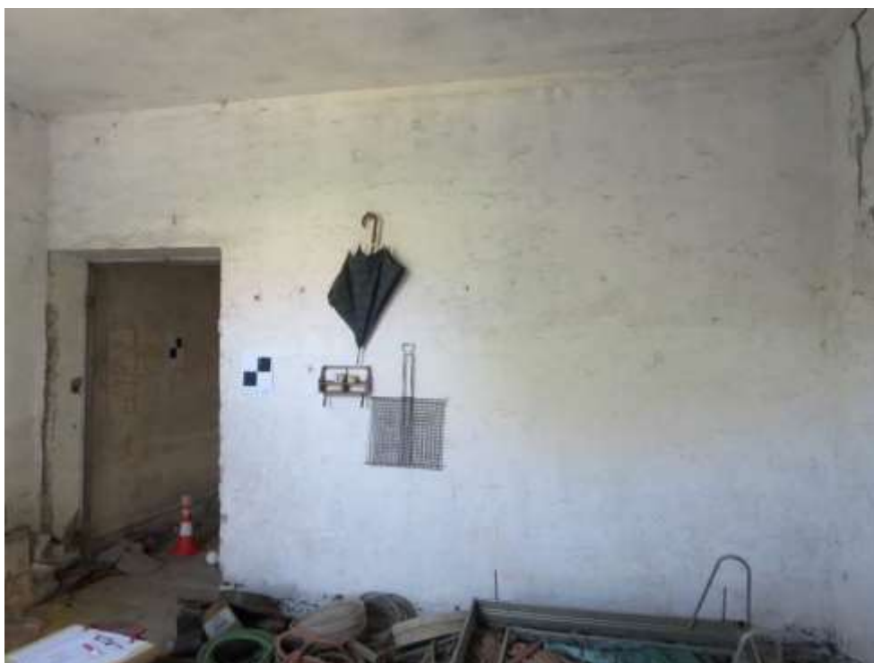
Figura 4-145. PALAZZO PARETO – P1 - Vano 7 – Parete B
