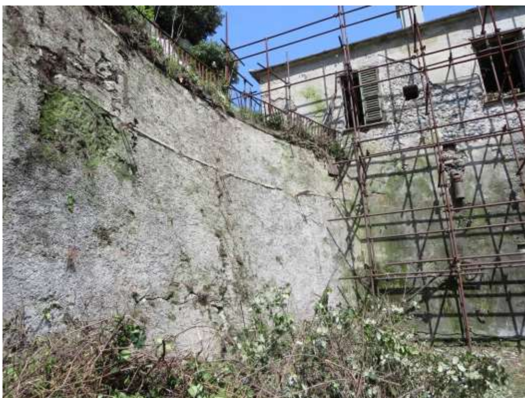
Figura 4-223. PALAZZO PARETO – Facciata ovest e muro di contenimento
