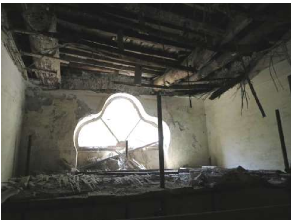
Figura 4-208. PALAZZO PARETO – P1 - Vano 16 – Parete C
