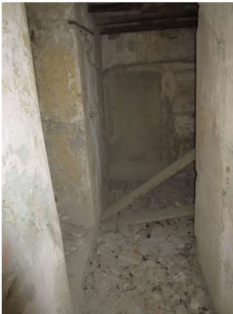
Figura 4-59. PALAZZO PARETO – PT - Vano 9' – Parete B
