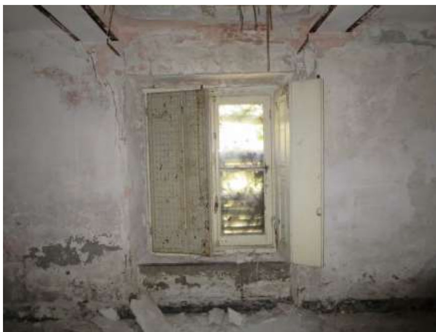
Figura 4-34. PALAZZO PARETO – PT - Vano 5 – Parete A
