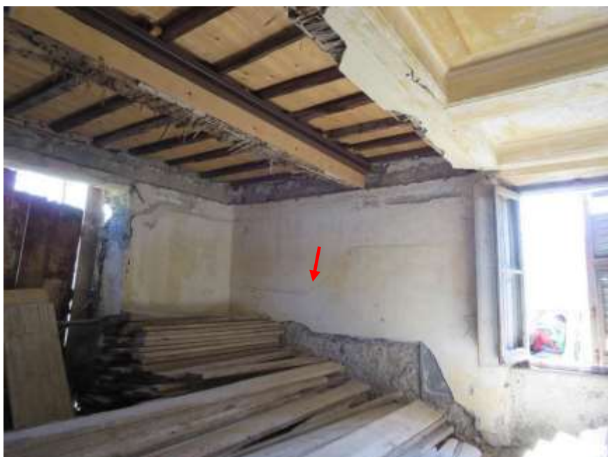
Figura 4-3. PALAZZO PARETO – PT - Vano 1 – Parete B
