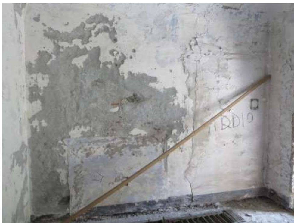
Figura 4-190. PALAZZO PARETO – P1 - Vano 14 – Parete B
