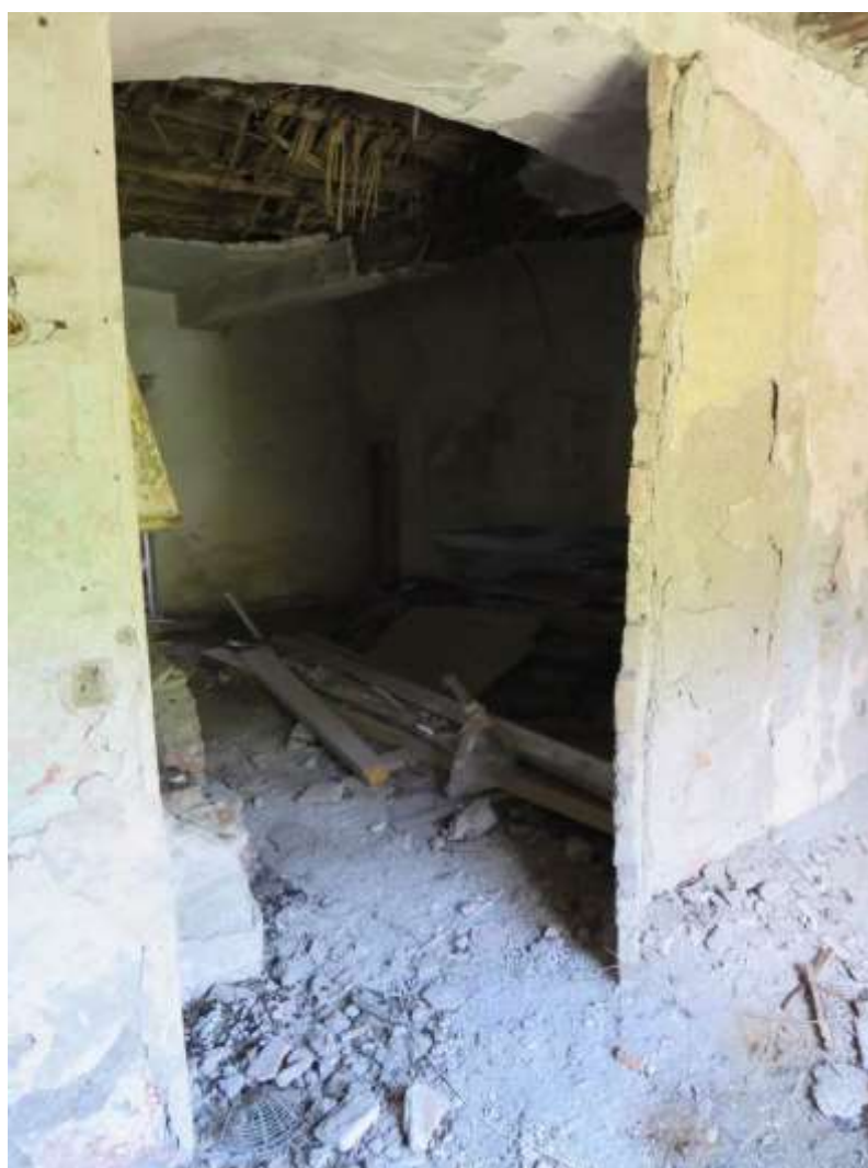
Figura 4-64. PALAZZO PARETO – PT - Vano 9" – Parete A
