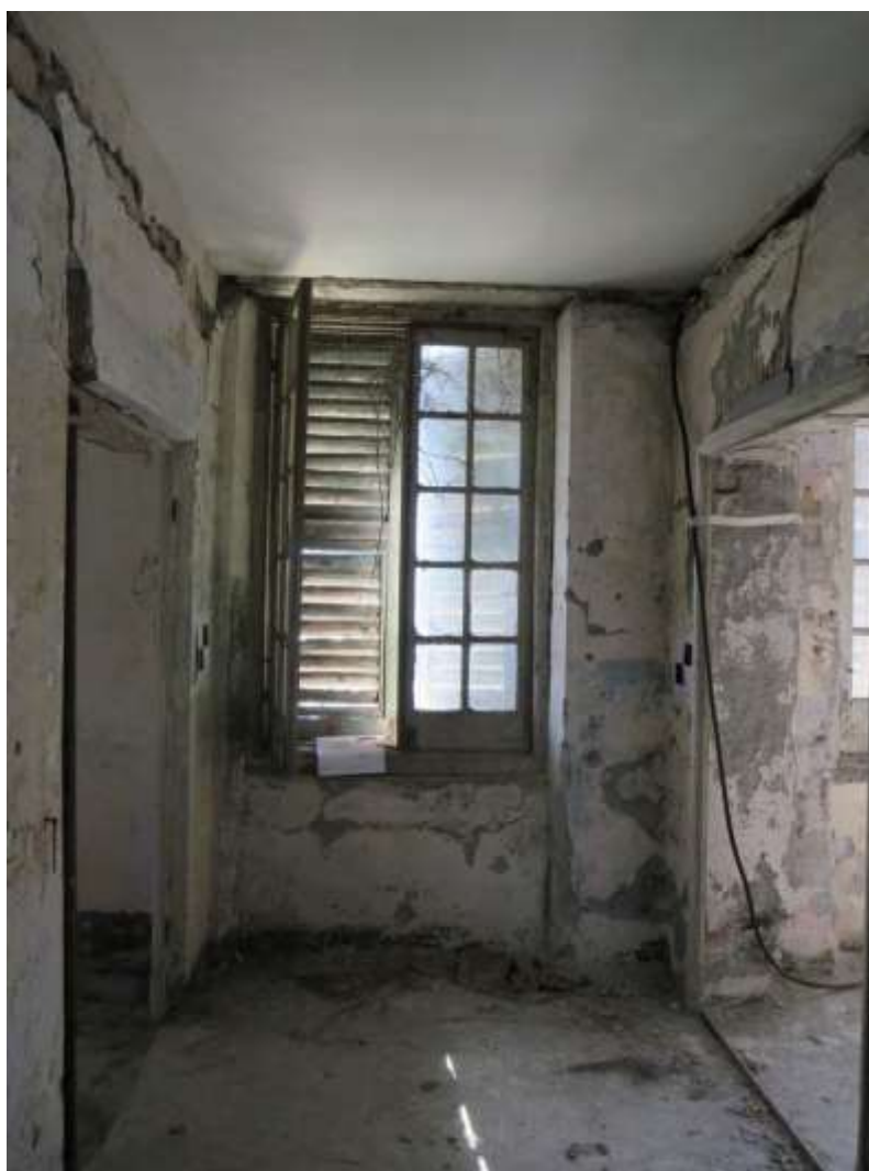
Figura 4-159. PALAZZO PARETO – P1 - Vano 9 – Parete B
