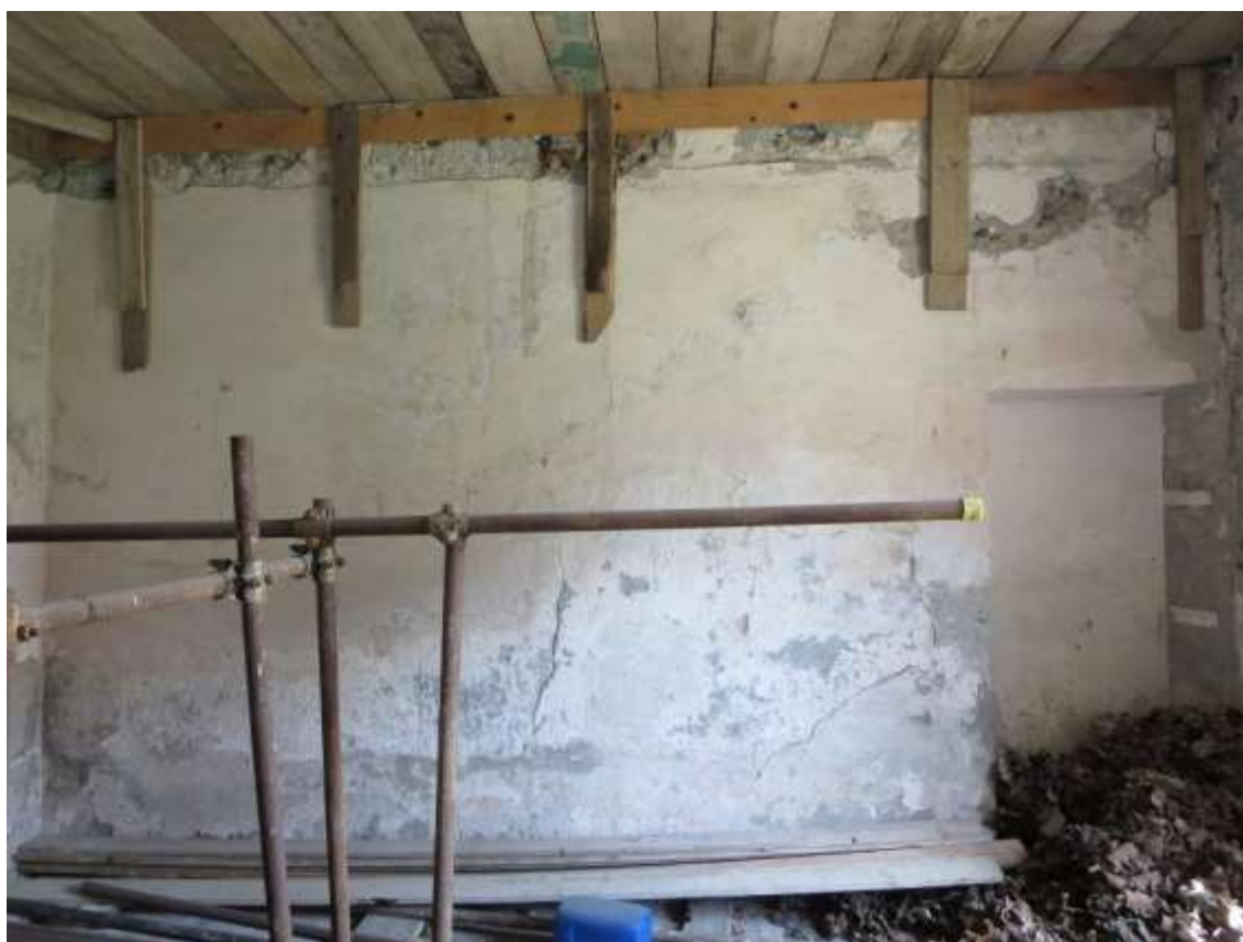
Figura 4-95. PALAZZO PARETO – PT - Vano 14 – Parete A
