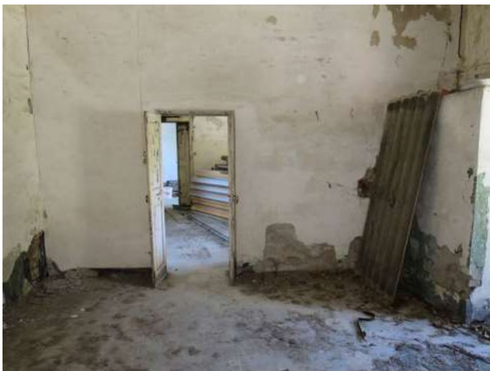
Figura 4-101. PALAZZO PARETO – P1 - Vano 1 – Parete B
