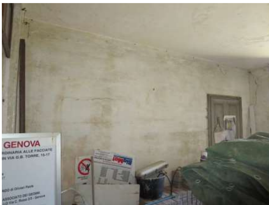
Figura 4-24. PALAZZO PARETO – PT - Vano 3 – Parete D
