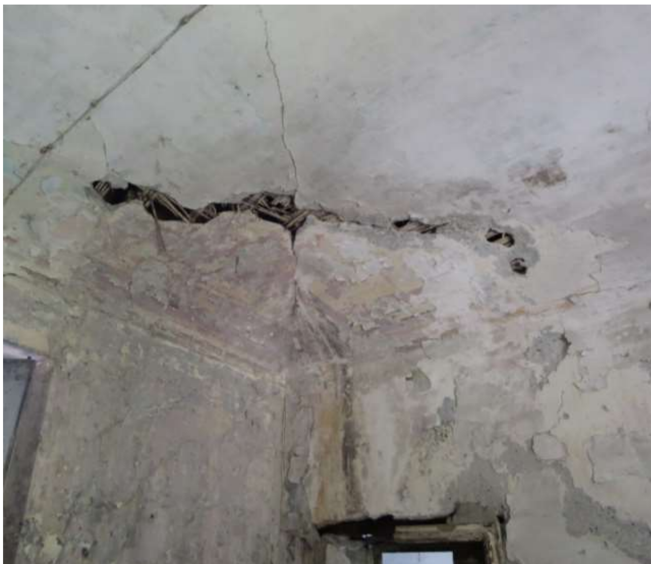
Figura 4-107. PALAZZO PARETO – P1 – Dettaglio 2 resti di probabili decorazioni sul soffitto Vano 2 seriamente ammalorate e con cedimenti delle arelle
