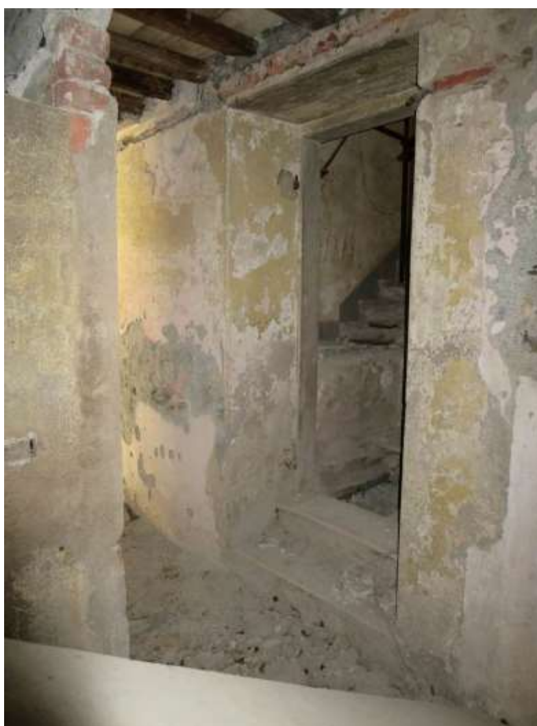
Figura 4-58. PALAZZO PARETO – PT - Vano 9' – Parete A
