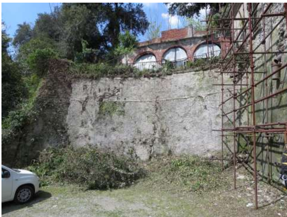
Figura 4-224. PALAZZO PARETO – Muro di contenimento
