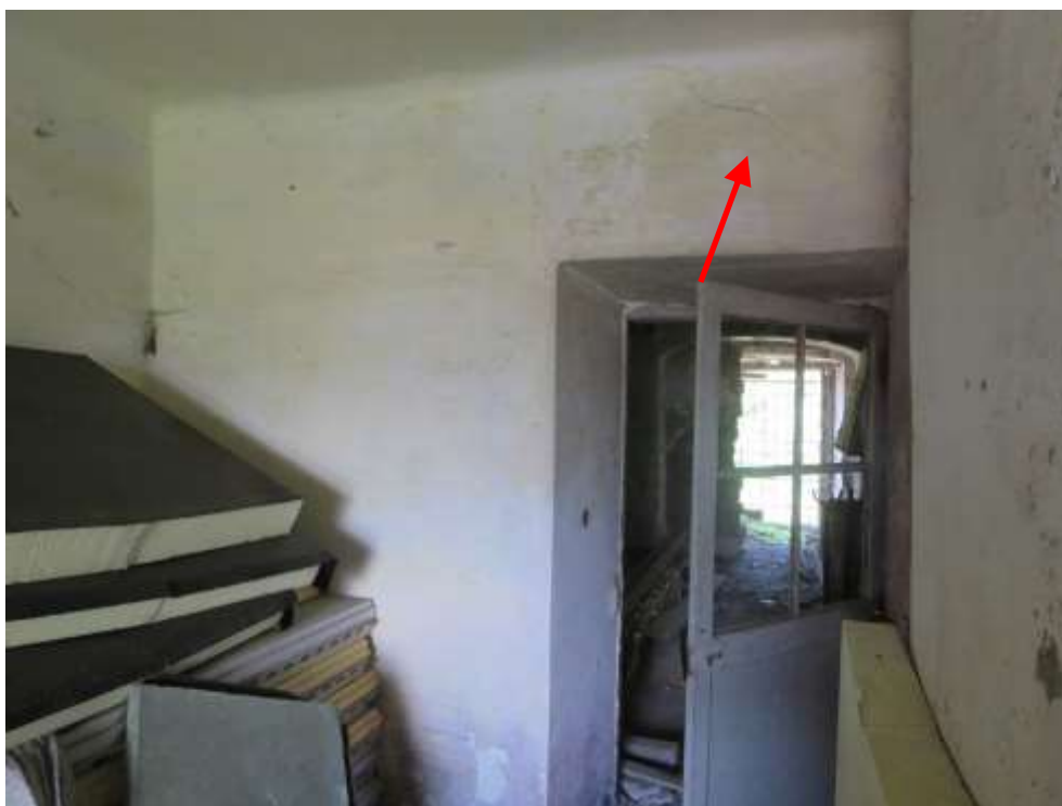
Figura 4-30. PALAZZO PARETO – PT - Vano 4 – Parete C
