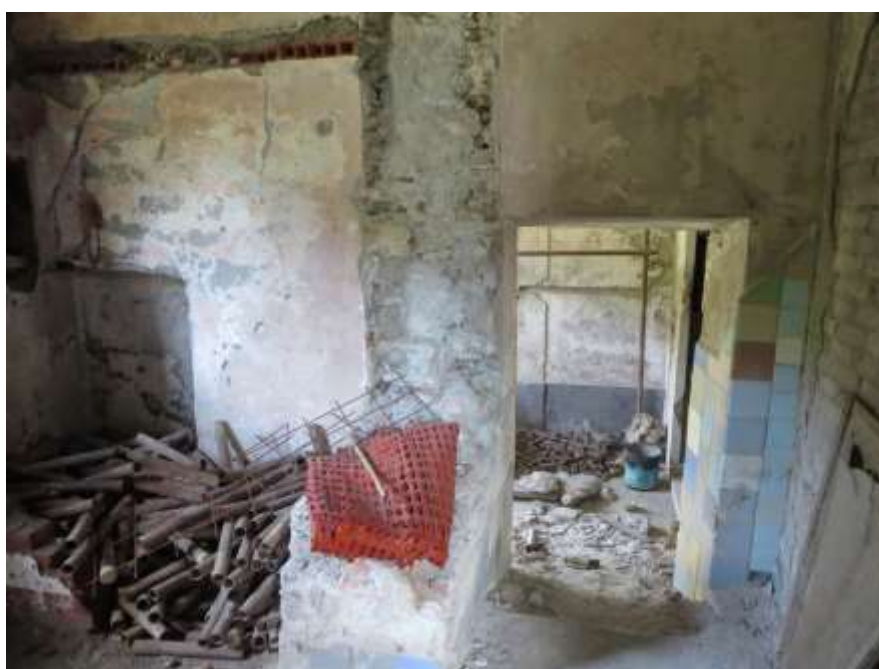
Figura 4-93. PALAZZO PARETO – PT - Vano 13 – Parete D
