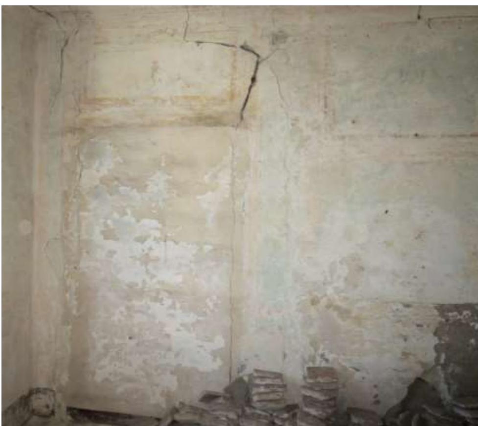
Figura 4-170. PALAZZO PARETO – P1 - Vano 11 – Dettaglio Parete B con porta di sinistra tamponata
