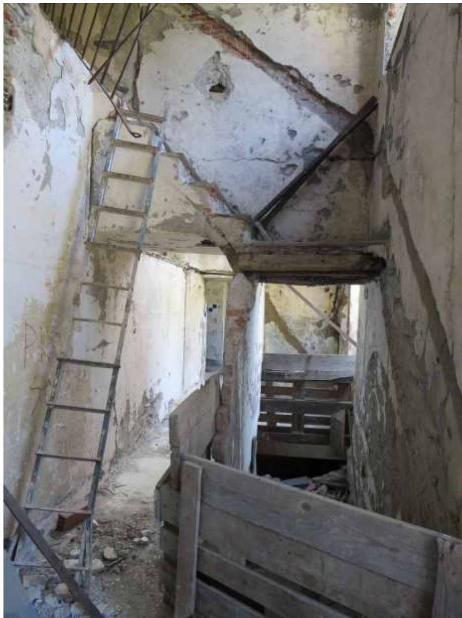
Figura 4-118. PALAZZO PARETO – P1 - Vano 3” – Parete B
