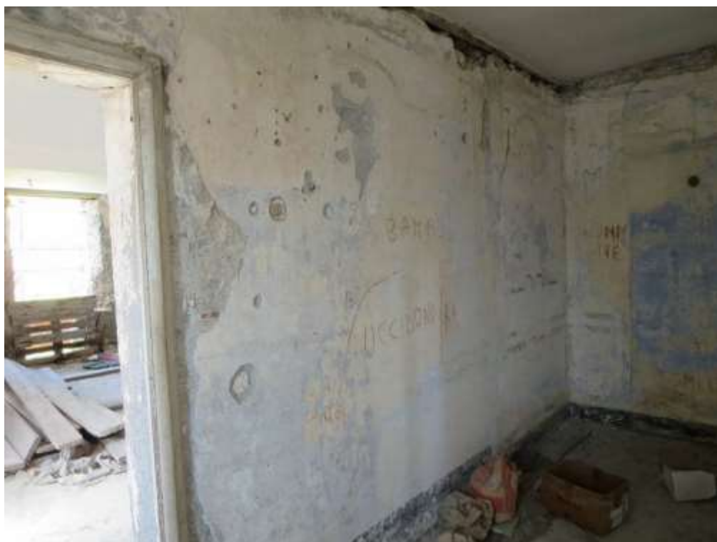
Figura 4-160. PALAZZO PARETO – P1 - Vano 9 – Parete C
