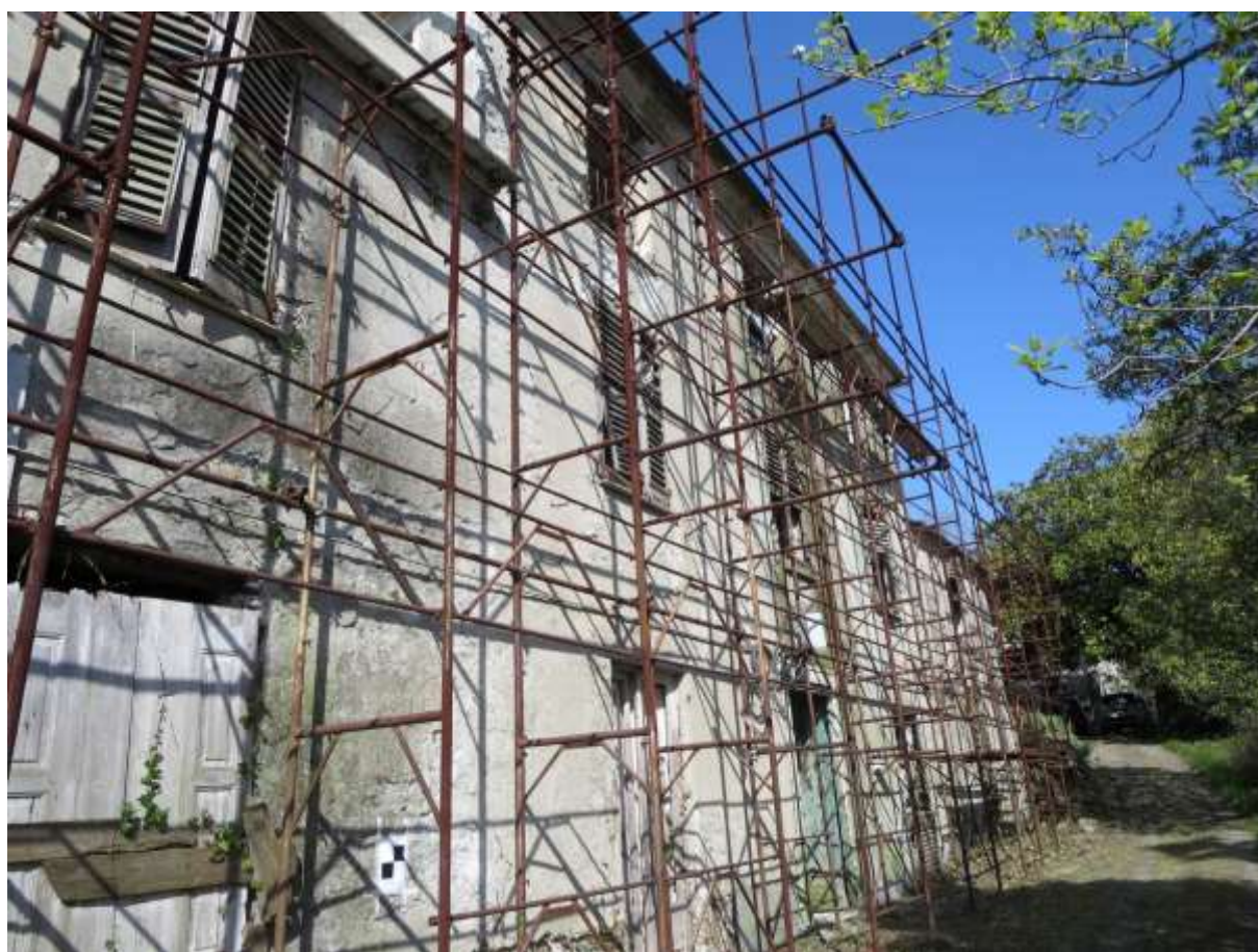
Figura 4-228. PALAZZO PARETO – Facciata est
