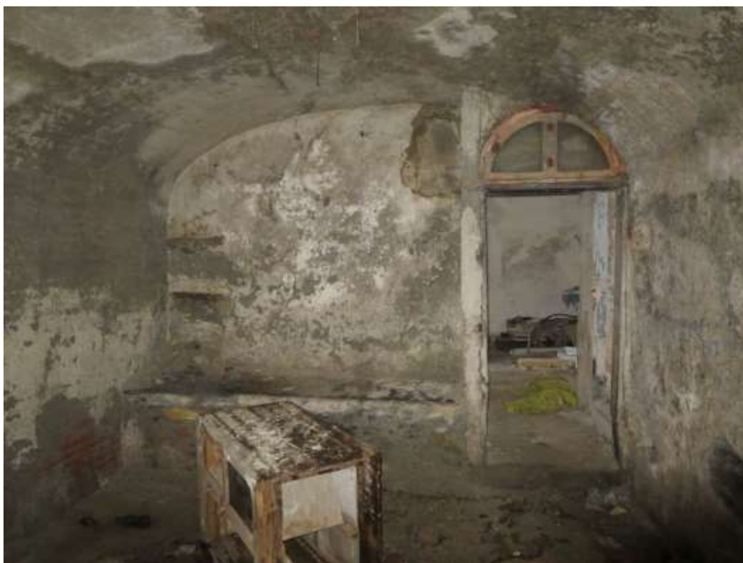
Figura 4-49. PALAZZO PARETO – PT - Vano 7 – Parete B
