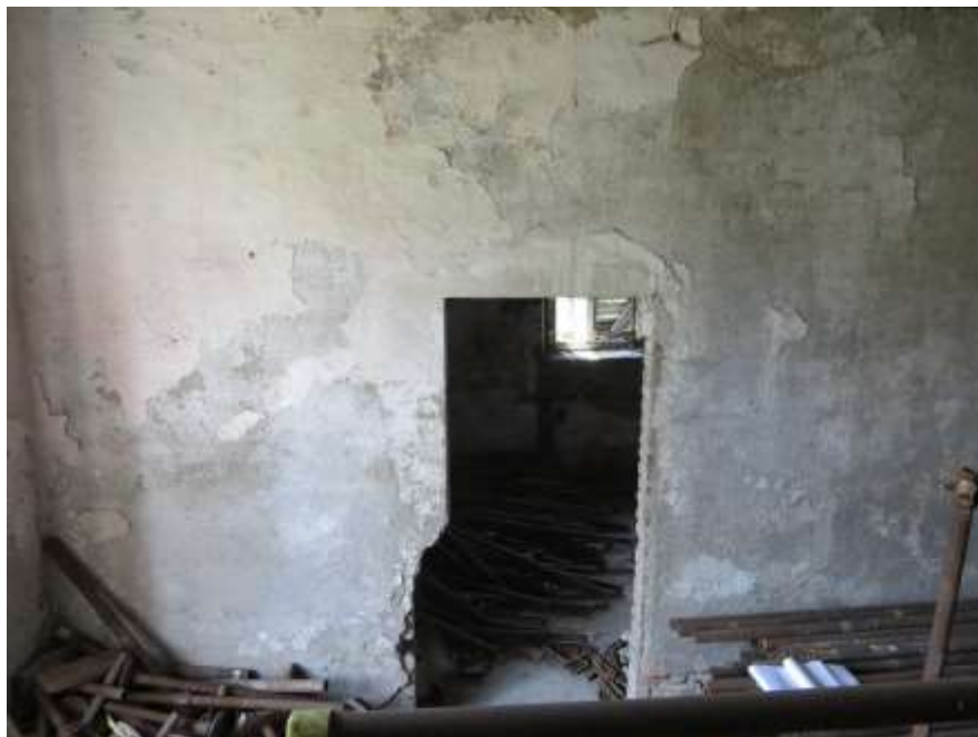
Figura 4-97. PALAZZO PARETO – PT - Vano 14 – Parete C
