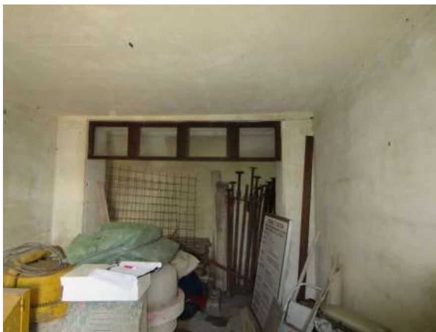
Figura 4-23. PALAZZO PARETO – PT - Vano 3 – Parete C
