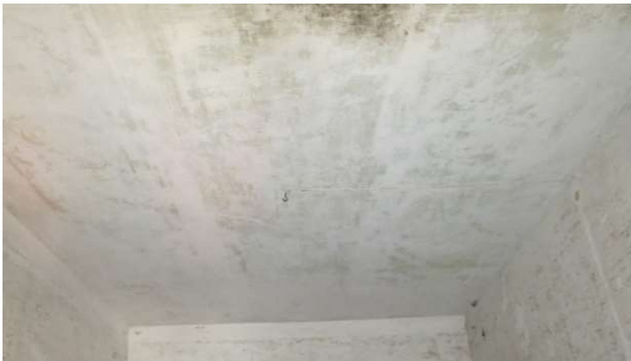
Figura 4-142. PALAZZO PARETO – P1 - Vano 6 – Soffitto
