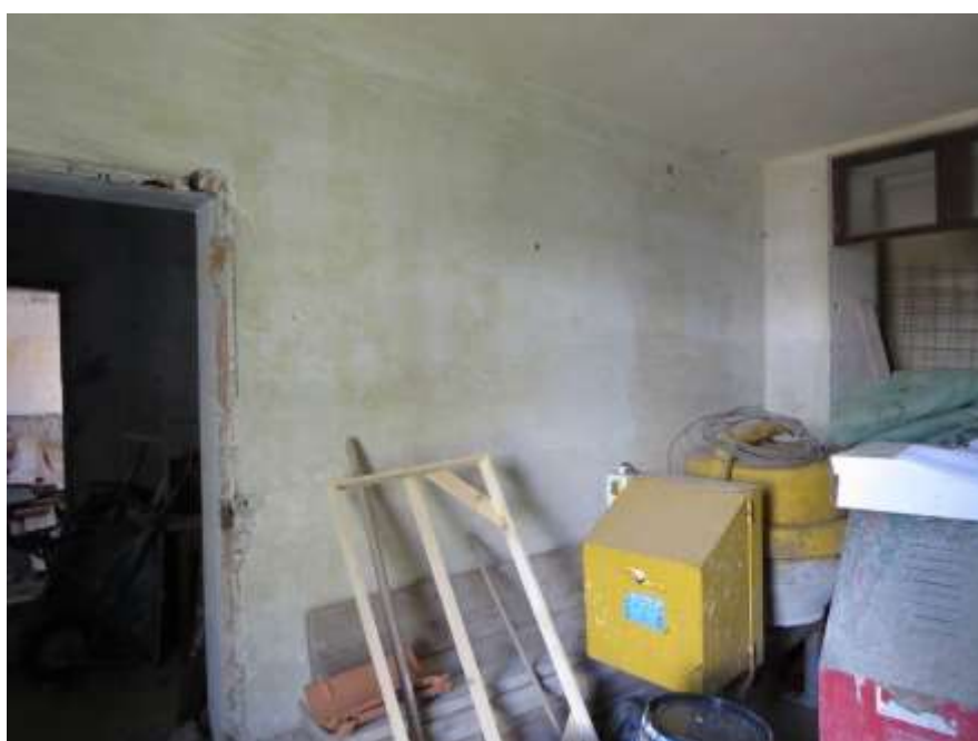
Figura 4-22. PALAZZO PARETO – PT - Vano 3 – Parete B
