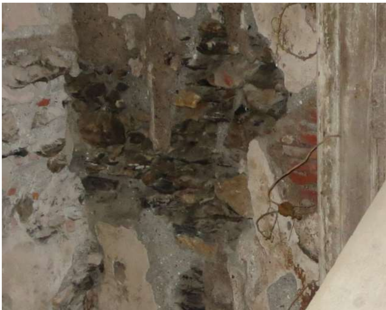
Figura 4-61. PALAZZO PARETO – PT - Vano 9' – Particolare muratura Parete C
