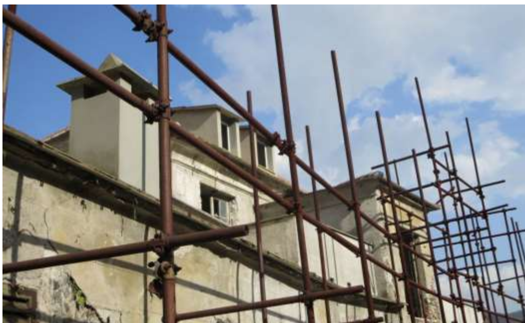
Figura 4-222. PALAZZO PARETO – Facciata ovest (particolare abbaini)
