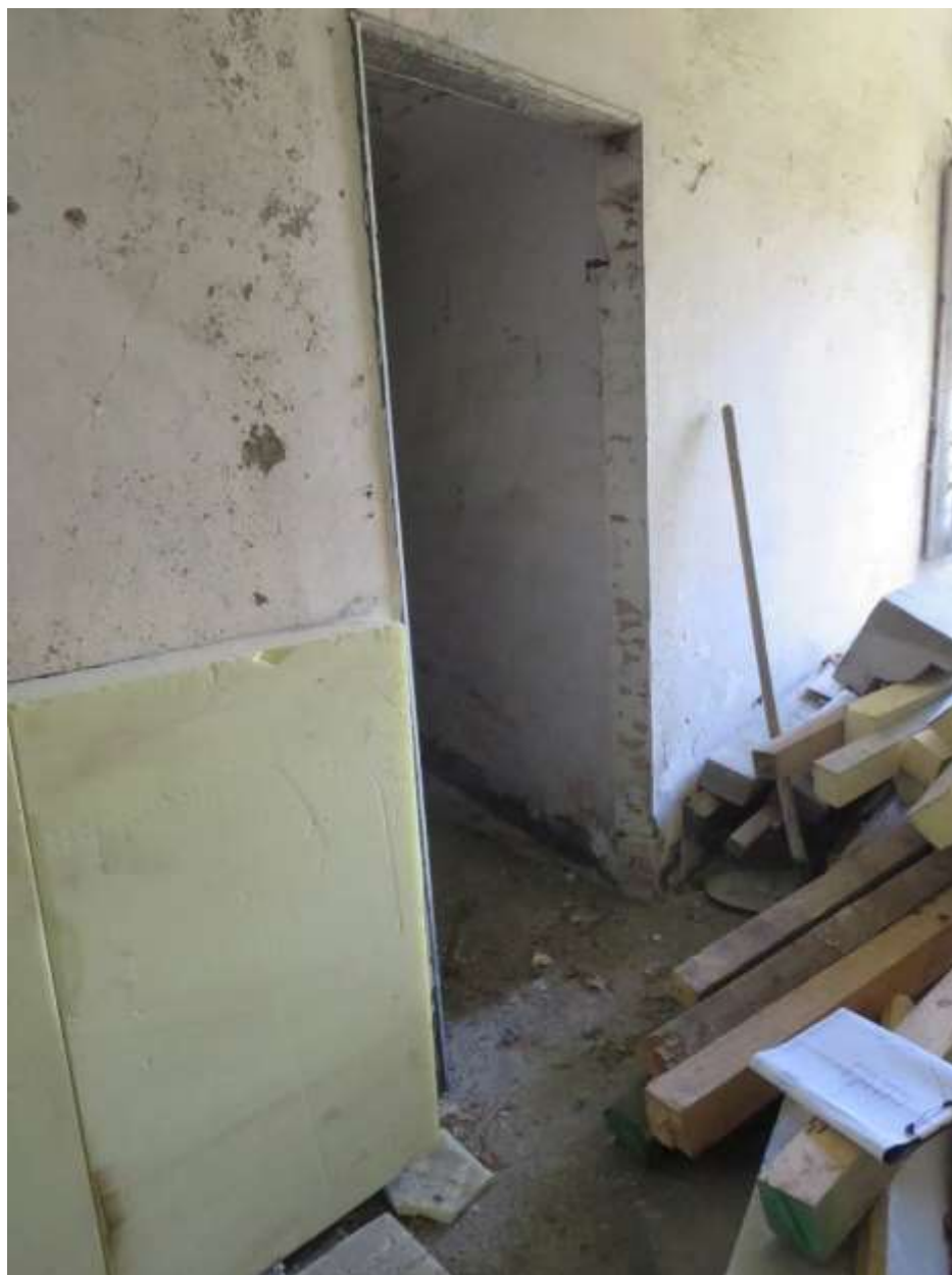
Figura 4-32. PALAZZO PARETO – PT - Vano 4 – Parete D
