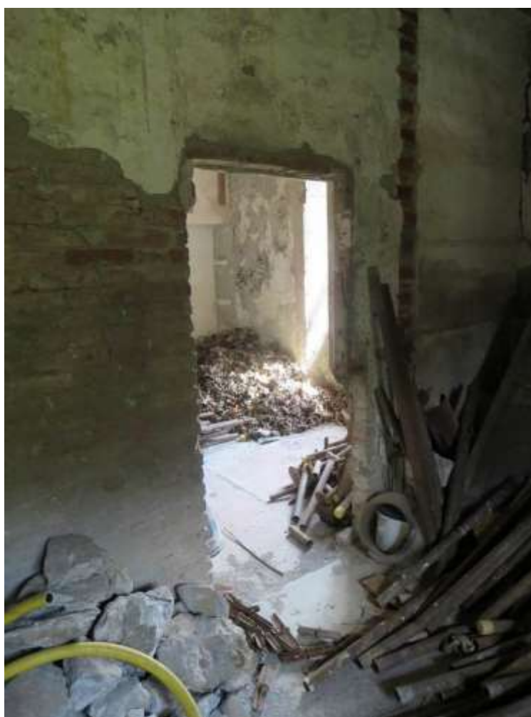
Figura 4-90. PALAZZO PARETO – PT - Vano 13 – Parete A
