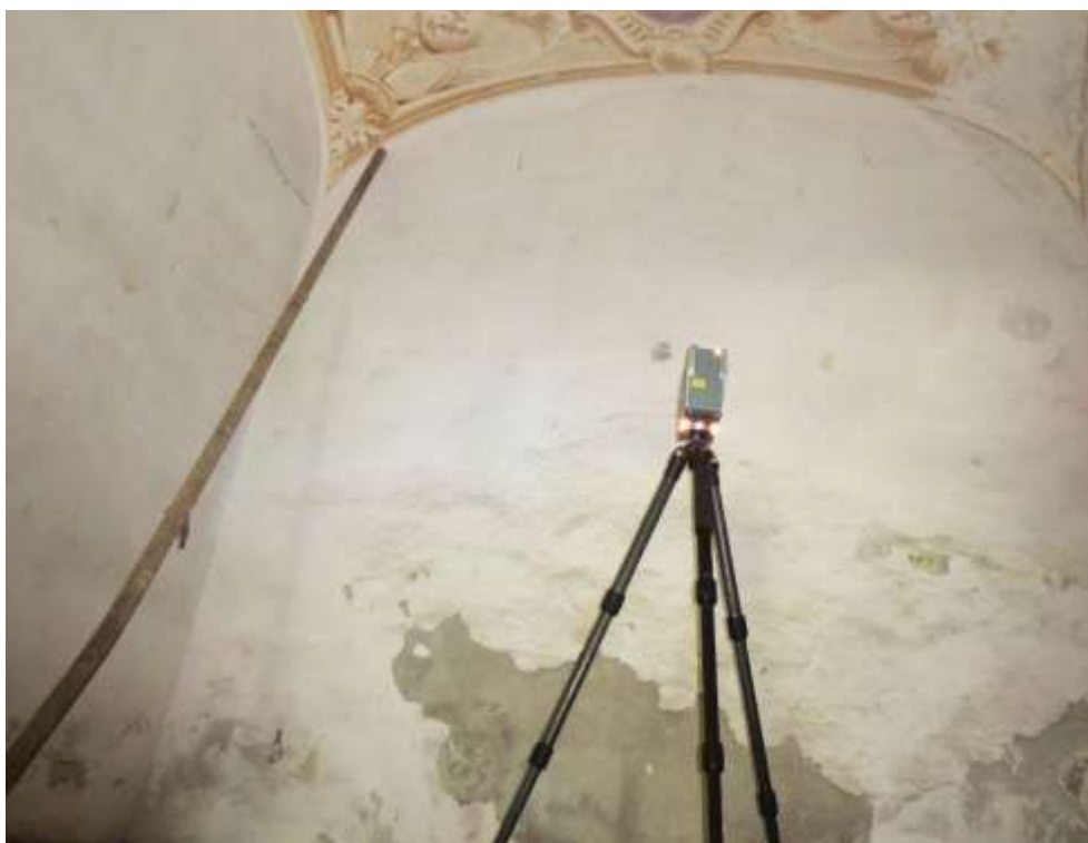
Figura 4-82. PALAZZO PARETO – PT - Vano 12 – Parete A
