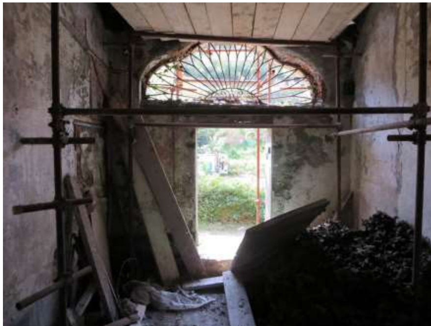
Figura 4-78. PALAZZO PARETO – PT - Vano 11 – Parete C
