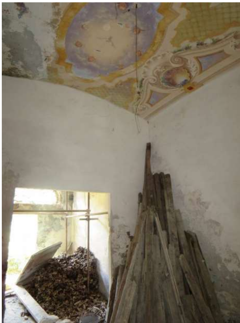
Figura 4-85. PALAZZO PARETO – PT - Vano 12 – Pareti C e D
