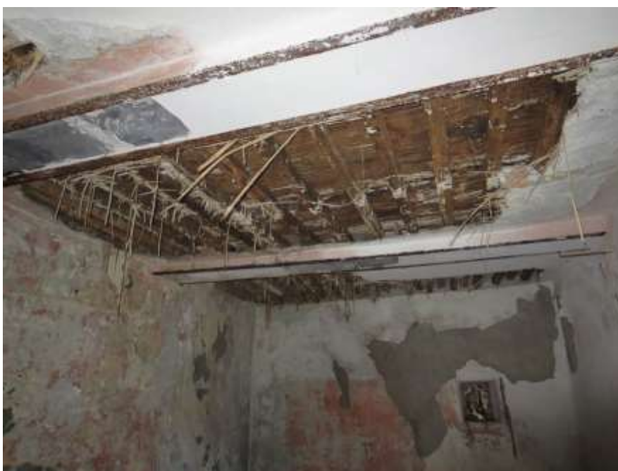
Figura 4-38. PALAZZO PARETO – PT - Vano 5 – Parete D
