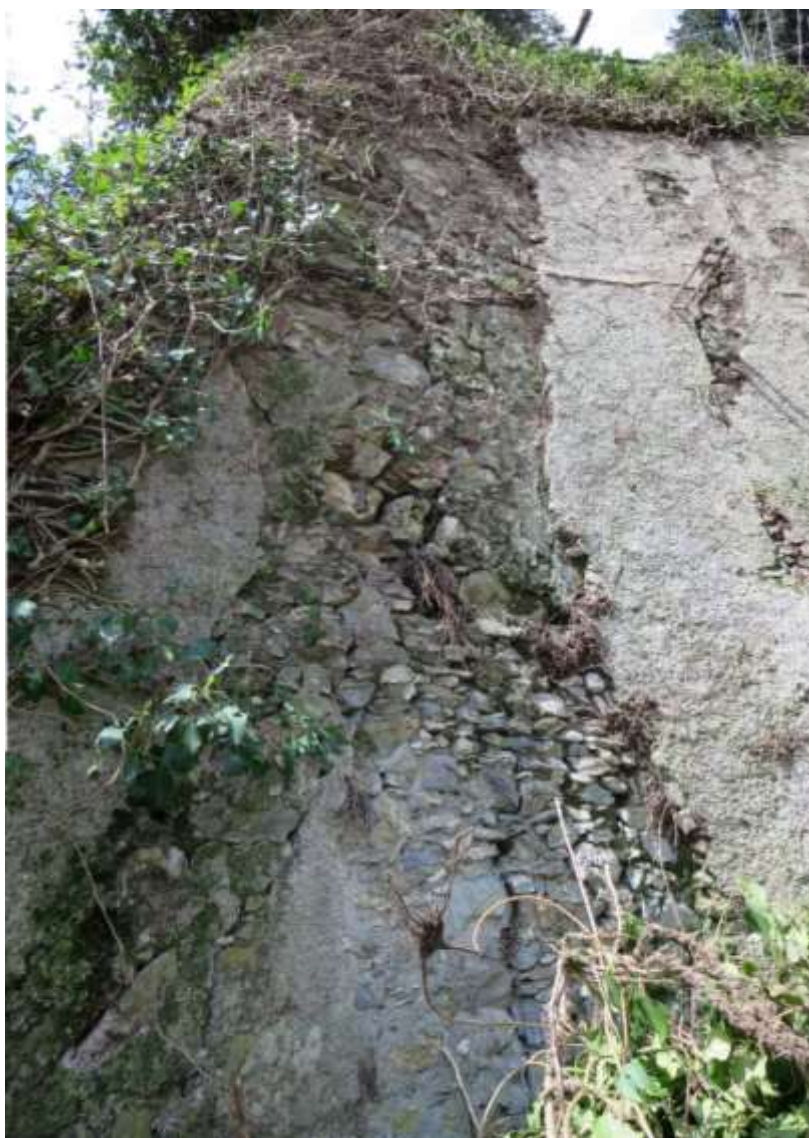
Figura 4-226. PALAZZO PARETO – Muro di contenimento, dettaglio
