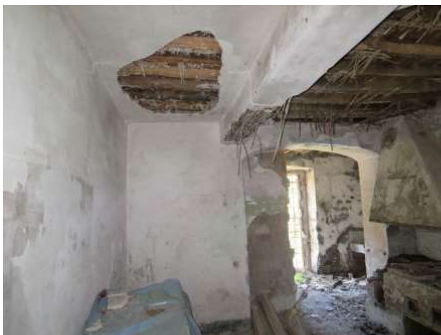
Figura 4-43. PALAZZO PARETO – PT - Vano 6 – Parete C
