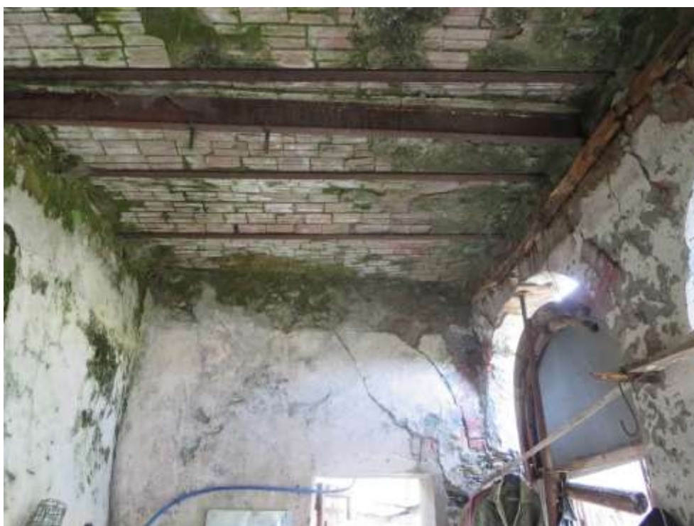
Figura 5-4. SERRA – PT - Vano 1 – Soffitto
