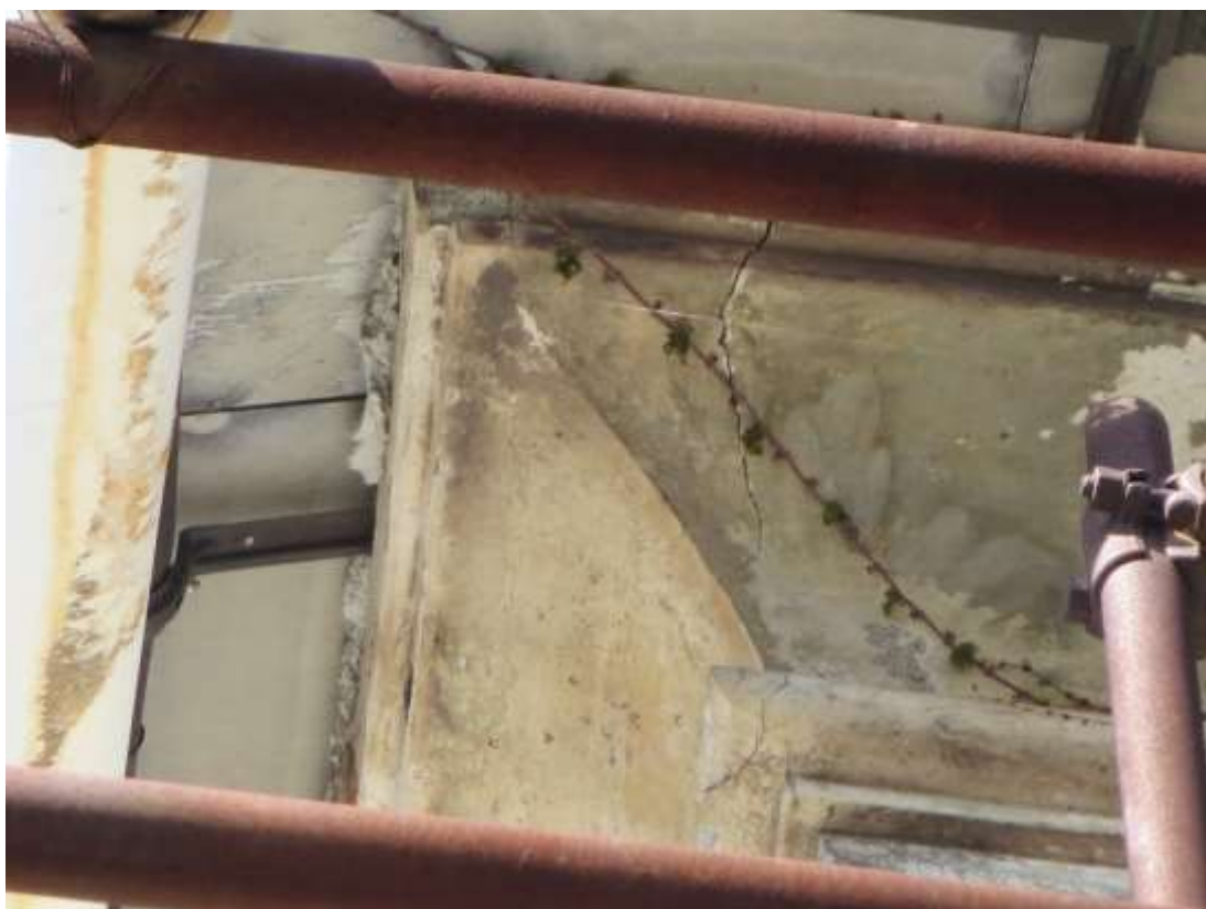
Figura 4-233. PALAZZO PARETO – Dettaglio cornice angolo sud-est
