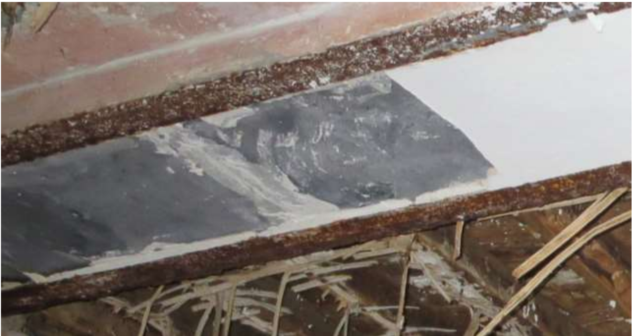
Figura 4-39. PALAZZO PARETO – PT - Vano 5 – Parete D
