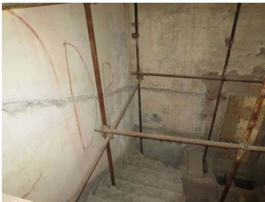
Figura 4-207. PALAZZO PARETO – P1 - Vano 16 – Pareti B e C
