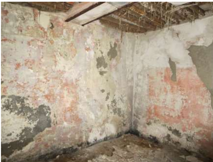
Figura 4-37. PALAZZO PARETO – PT - Vano 5 – Parete C
