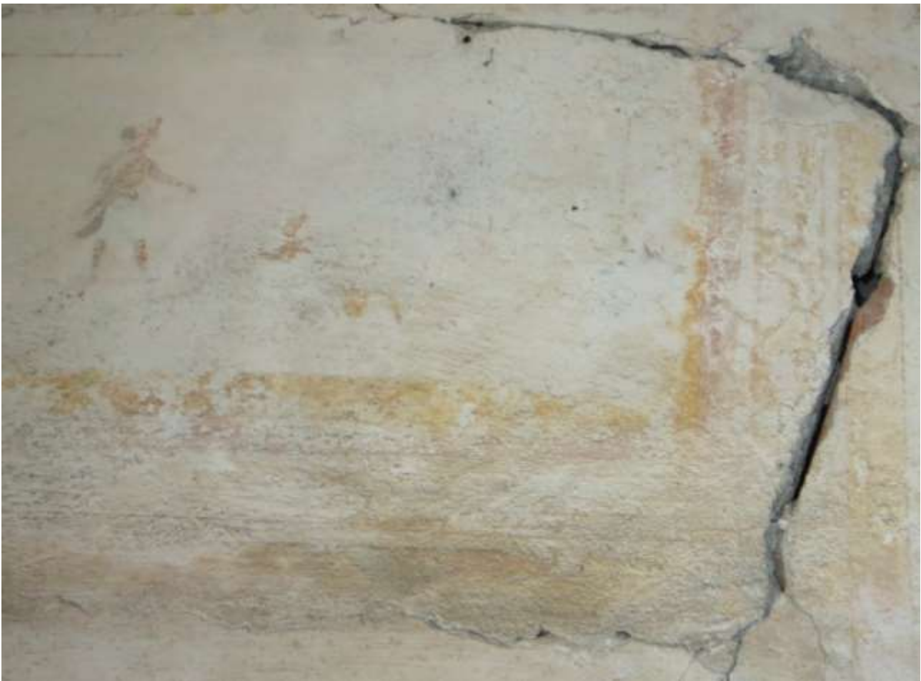
Figura 4-172. PALAZZO PARETO – P1 - Vano 11 – Dettaglio Parete B con porta di sinistra tamponata (particolare decorazione sopraporta)
