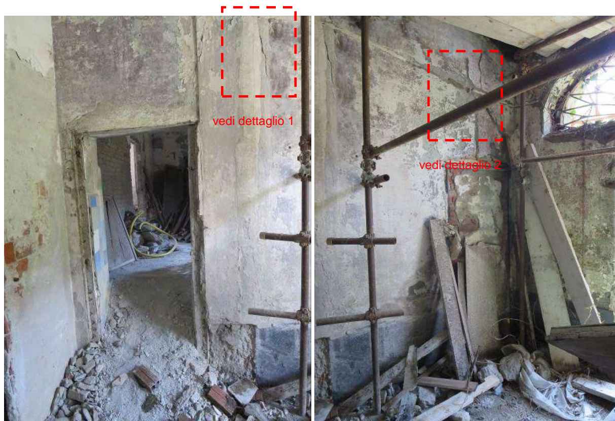
Figura 4-75. PALAZZO PARETO – PT - Vano 11 – Parete B
