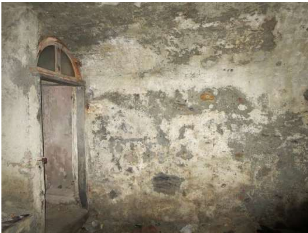
Figura 4-50. PALAZZO PARETO – PT - Vano 7 – Pareti B e C
