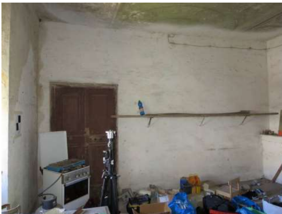
Figura 4-130. PALAZZO PARETO – P1 - Vano 5 – Parete B
