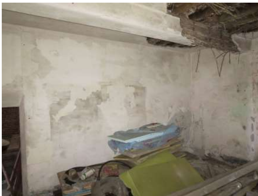
Figura 4-42. PALAZZO PARETO – PT - Vano 6 – Parete B
