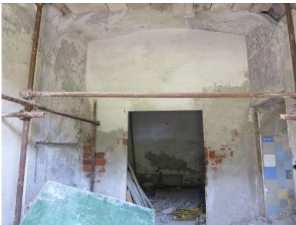
Figura 4-73. PALAZZO PARETO – PT - Vano 11 – Parete A
