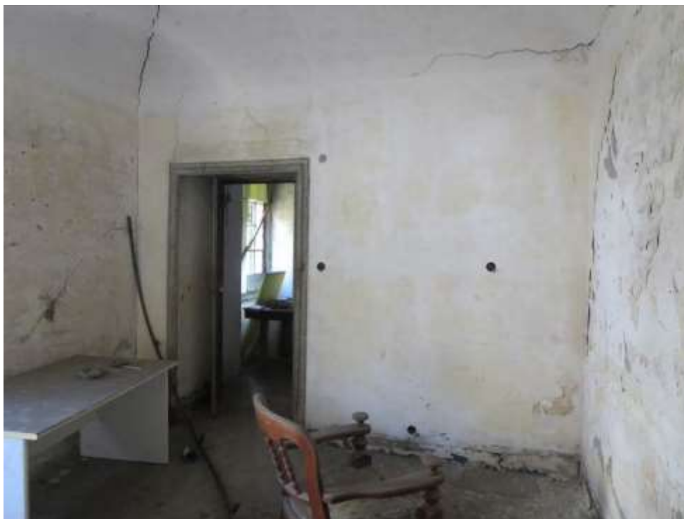
Figura 4-125. PALAZZO PARETO – P1 - Vano 4 – Parete B
