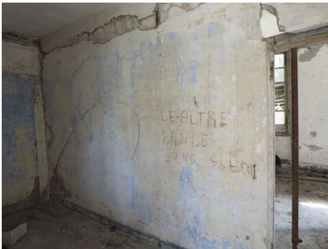
Figura 4-157. PALAZZO PARETO – P1 - Vano 9 – Parete A
