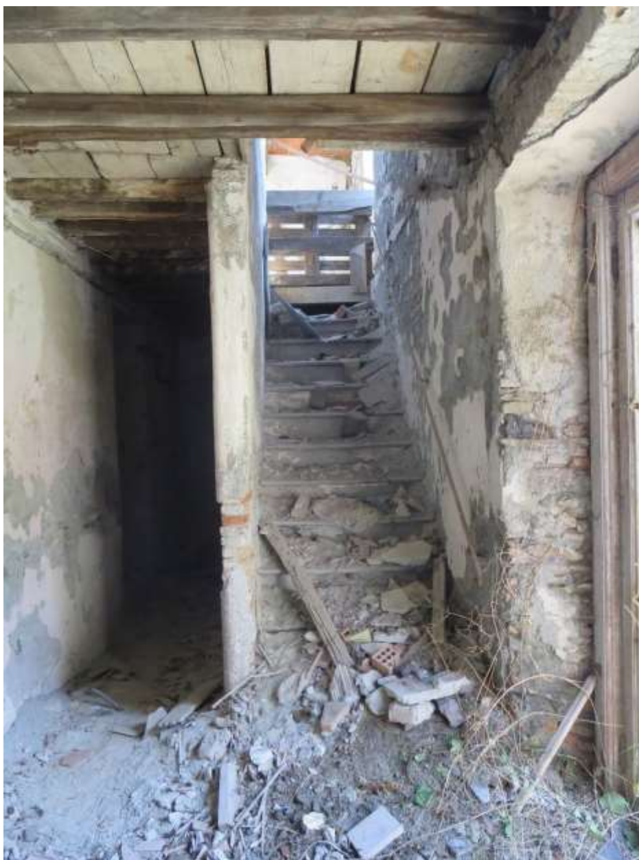
Figura 4-65. PALAZZO PARETO – PT - Vano 9” – Parete B
