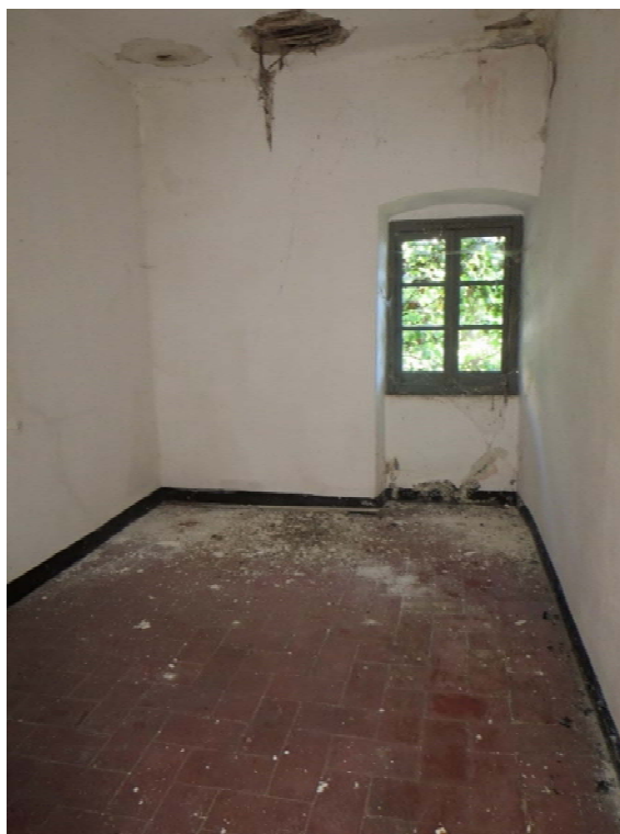
Figura 3-5. CASA DEL CUSTODE – P1 – Vano 6 – Parete C
