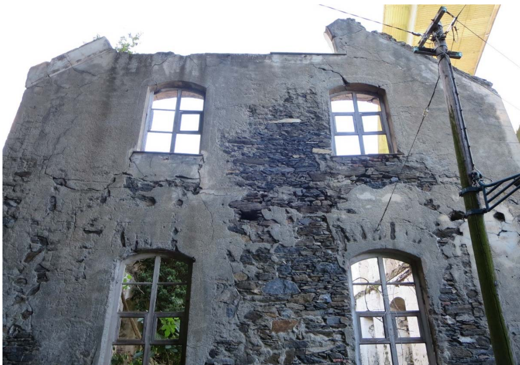
Figura 3-2. FILANDA – Prospetto sud-ovest porzione superiore
