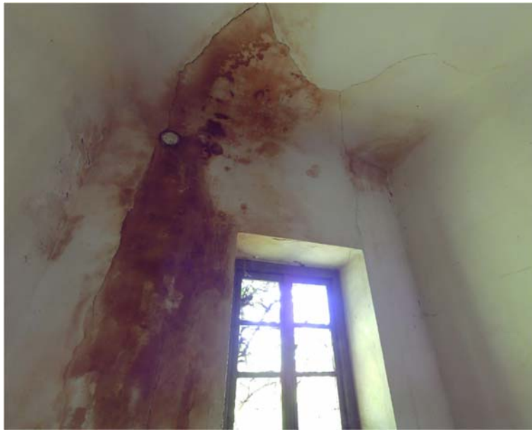
Figura 3-6. CASA DEL CUSTODE – P1 – Vano 8 – Angolo Parete C
