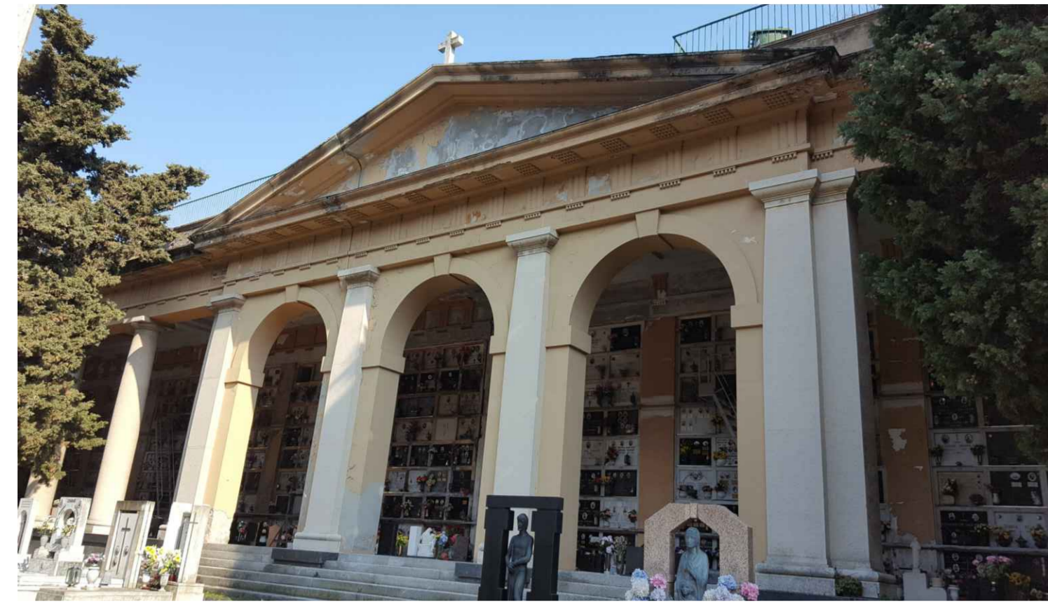
FOTO STATO DI FATTO TIMPANO CIMITERIALE LATO SUD
