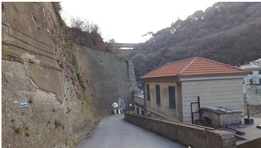
Figura 3-3: Parete contro terra accesso sud
