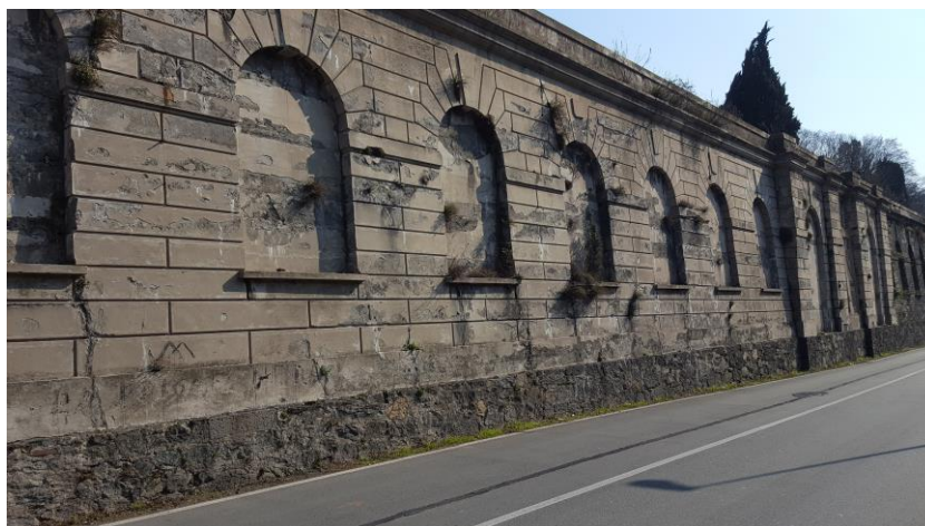
Figura 3-2: Fronte principale – parete complessa
