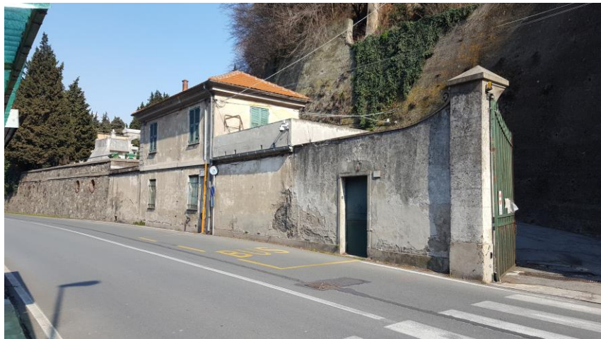
Figura 3-4: Edificio principale accesso sud
