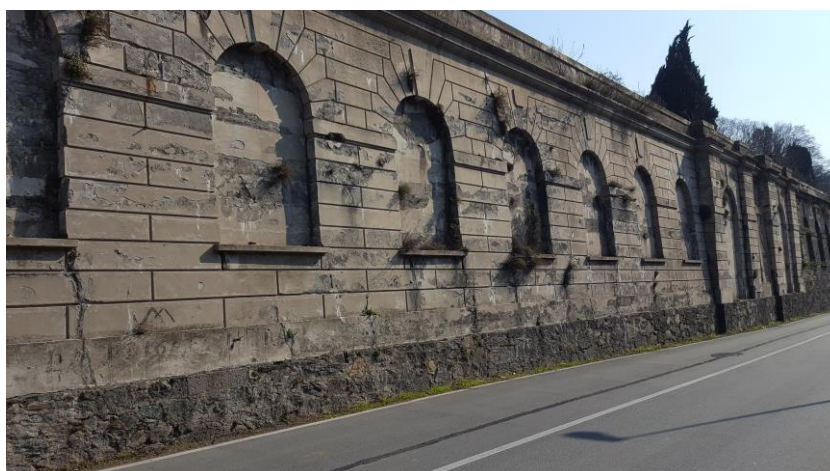
Figura 4-2: Fronte principale – parete complessa
