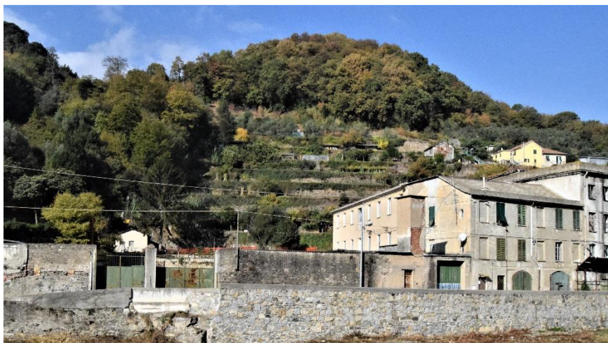
Figura 2-1: Terrazzamenti e in primo piano l'edificio ex Ansaldo.
