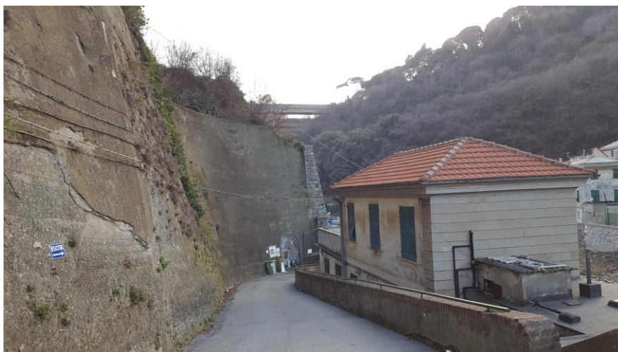
Figura 4-3: Parete contro terra accesso sud e parete nord edificio principale
