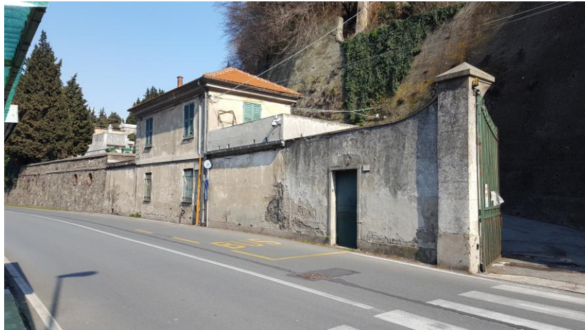
Figura 4-4: Edificio principale accesso sud
