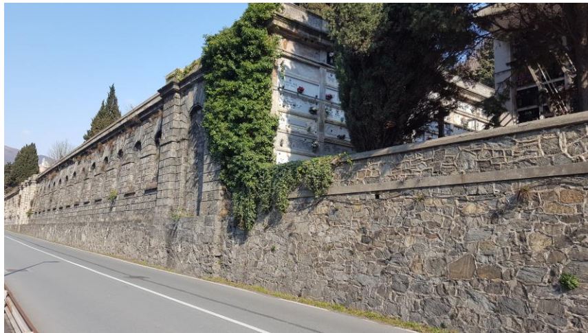
Figura 4-1: Fronte principale – parete con rivestimento in pietra
