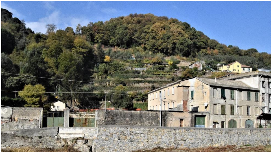
Figura 2-1: Terrazzamenti e in primo piano l'edificio ex Ansaldo.
