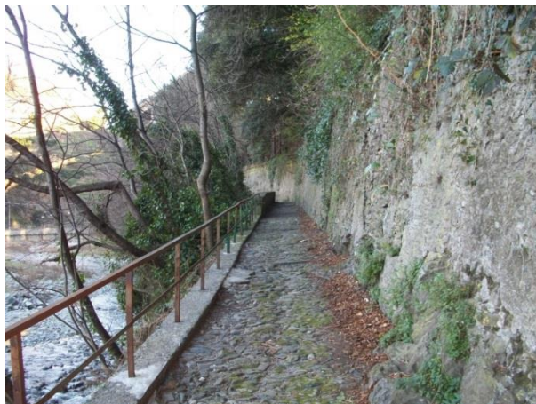
Figura 5-3: Pavimentazione esistente su via Molinetto di Voltri
