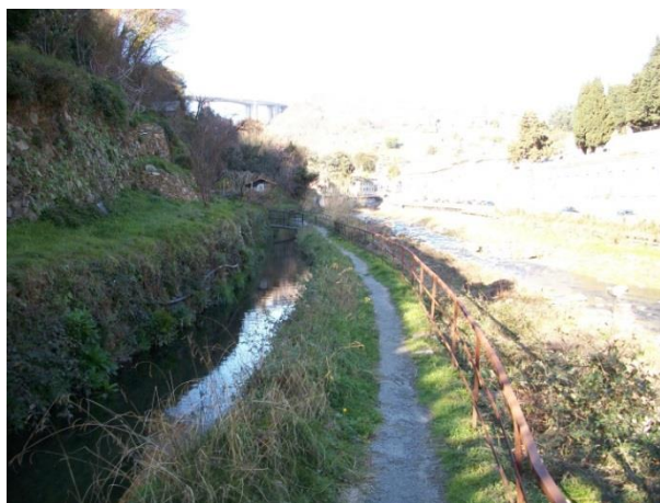
Figura 5-4: Pavimentazione esistente tra la destra del Torrente Leiro e il canale beudo
