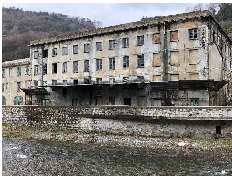
Figura 3-4: Ex impianto Ansaldo come appare oggi, riconoscibile per le aperture e la tettoia del piano inferiore
