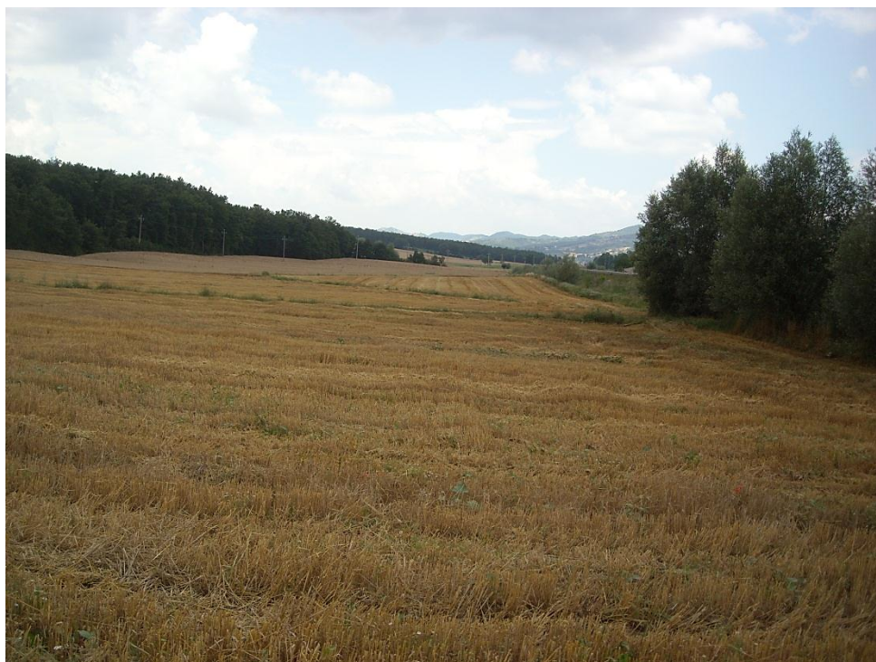
Foto 3.1/B: Panoramica dell'accumulo dell'Area 2 - frana per scivolamento quiescente
