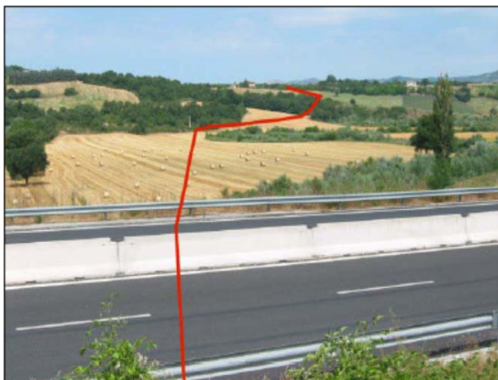
Foto 37: Attraversamento della piana del fiume Chiascio
