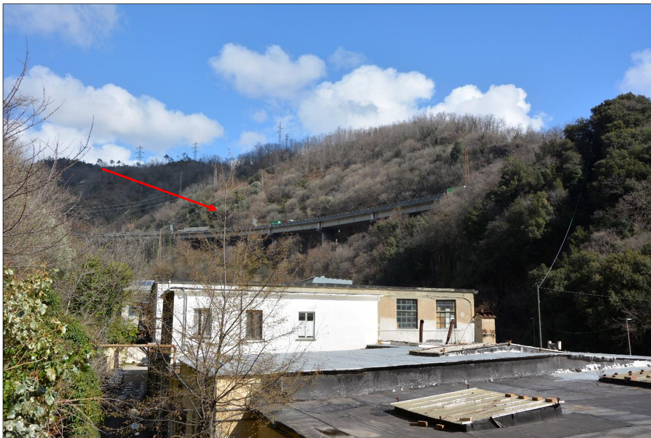
Figura 1 – Vista da area industriale lungo torrente Cerusa (la freccia in rosso indica la localizzazione del nuovo imbocco)
