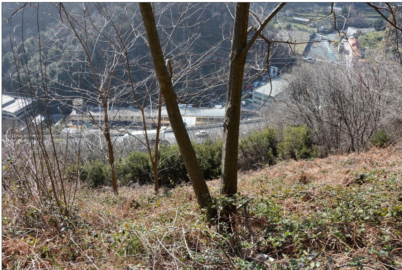
Figura 4 – copertura boschiva degradata sul versante interessato dall'intervento. (fonte: elaborato 110721-LL1B-PE-S2-G04-GP04N-0-D-AUA6023-1)
