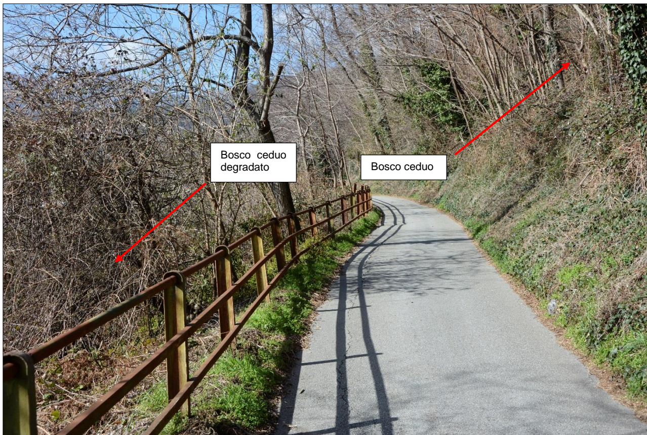
Figura 6 – strada secondaria asfaltata a mezza costa (fonte: elaborato 110721-LL1B-PE-S2-G04-GP04N-0-D-AUA6023-1)
