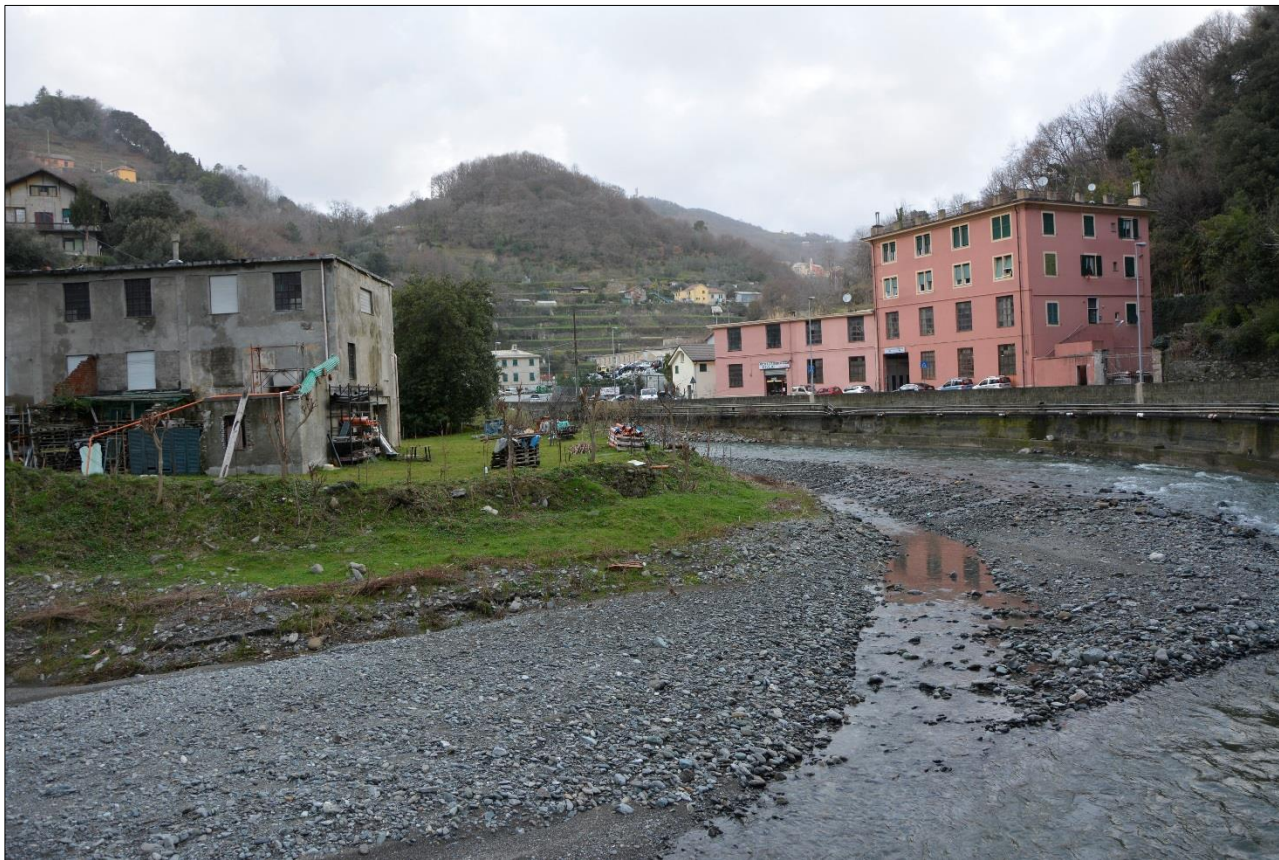
Figura 5 – vista del torrente Leiro da sotto viadotto autostradale esistente (fonte: elaborato 110721-LL1A-PE-DG-IPG-00000-0-R-AUA0041-1 area Voltri, foto 18)
