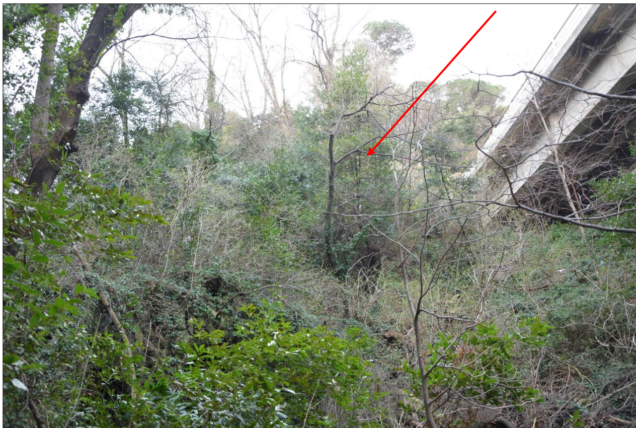
Figura 2 – vista dal basso di porzione di versante interessato dal nuovo imbocco (la freccia indica l'ubicazione del nuovo ingresso) – fonte: elaborato 110721-LL1B-PE-S2-G05-GP05E-0-R-AUA6522-1 foto 02
