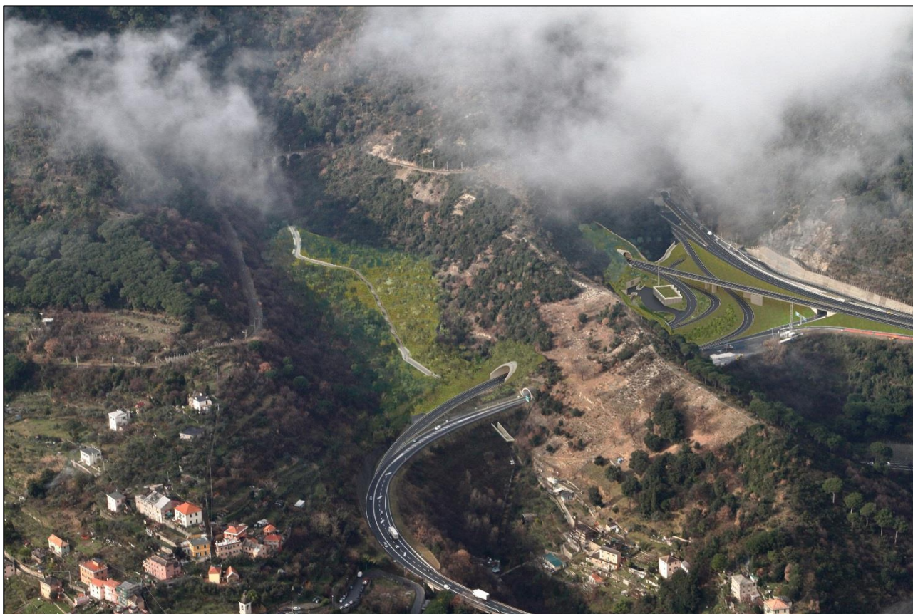
Figura 11 – fotosimulazione aerea della nuova area di imbocco, di fronte rimodellamento morfologico dei versanti del fosso esistente (fonte: elaborato 110725-LL9B-PE-DG-IPG-00000-00000-R-AUA0043-0 area Genova tavola 8/16)
