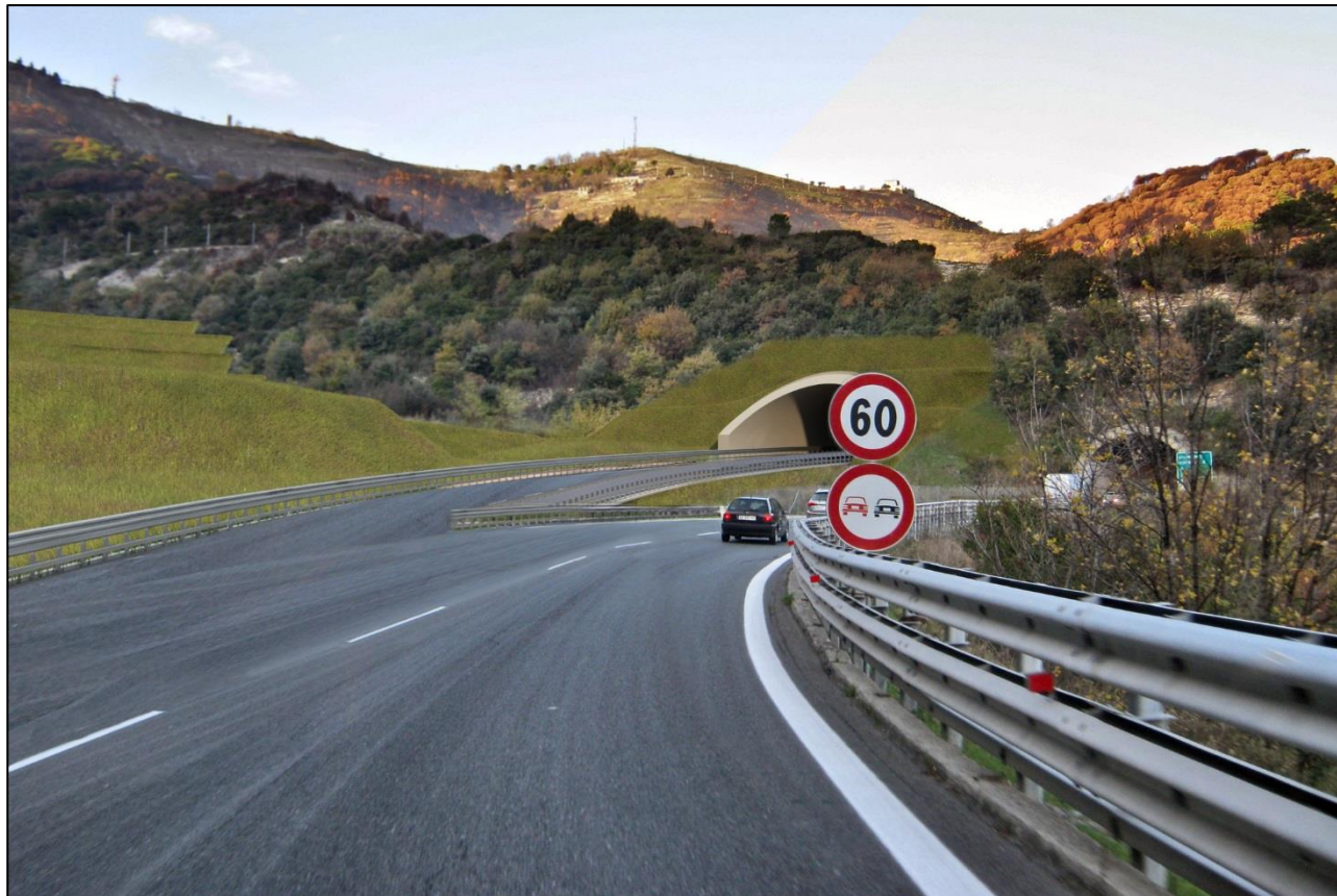
Figura 10 – fotosimulazione dal tracciato autostradale esistente verso il nuovo imbocco (fonte: elaborato 110725-LL9B-PE-DG-IPG-00000-00000-R-AUA0042-0 tavola 18/19 foto 64)
