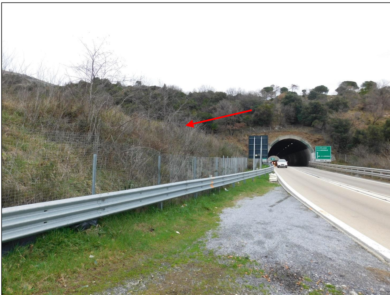
Figura 1 – Boscaglia pioniera sul versante nord (con la freccia rossa indicata la zona di imbocco della nuova galleria) – fonte: elaborato 110721-LL1B-PE-S6-G21-GP21S-0-R-AUA8401-1, foto 8
