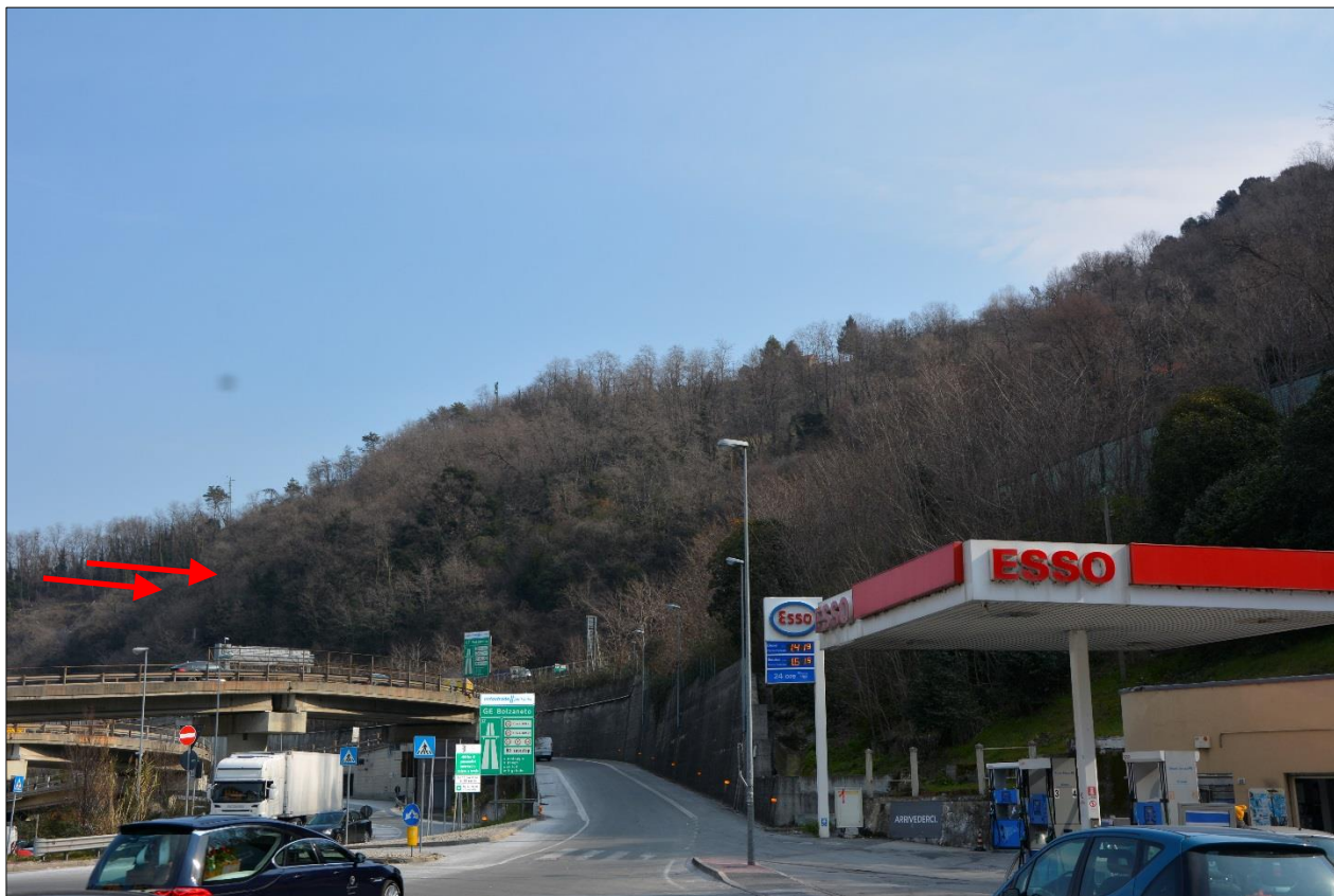
Foto 1 - Bosco ceduo degradato di versante (con la freccia rossa indicata la zona di imbocco Ovest della galleria Bric du Vento e Baccan) - (fonte – elaborato 110722-LL02-PE-A3-G12-GP12W-0-R-AUA1515-1, foto 2)
