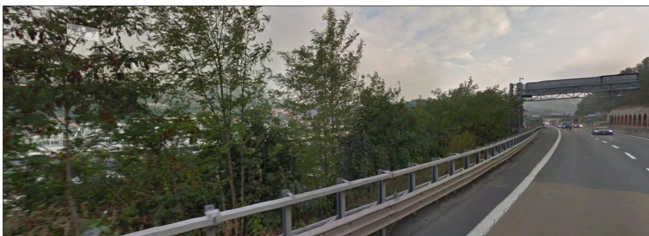
Foto 2 – tracciato autostradale esistente e relativa area di pertinenza con vegetazione pioniera di scarso valore (prevalentemente Robinia pseudacacia) - (foto ripresa dalla sede autostradale esistente)
