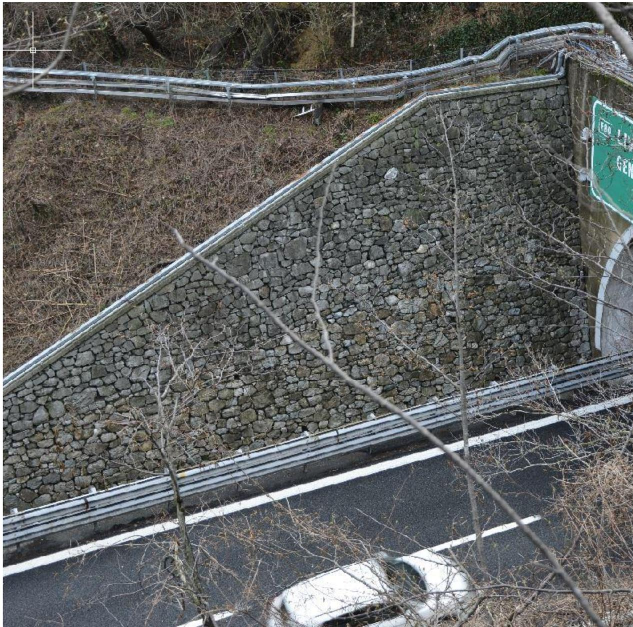
Foto 6 – Rivestimento muro in C.A. lungo l'autostrada esistente (fonte: elaborato 110722-LL03-PE-A3-G16-GP16N-0-D-AUA3743-1)
