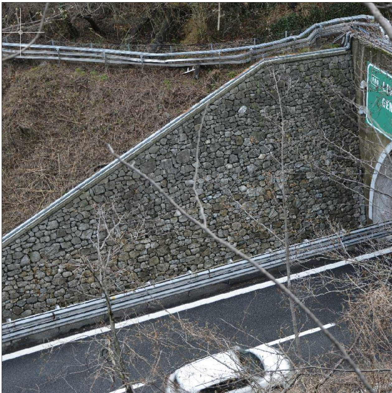
Figura 4 – Rivestimento muro in C.A. lungo l'autostrada esistente (fonte: elaborato 110722-LL03-PE-S4-G13-GP13W-0-D-AUA4993-1)
