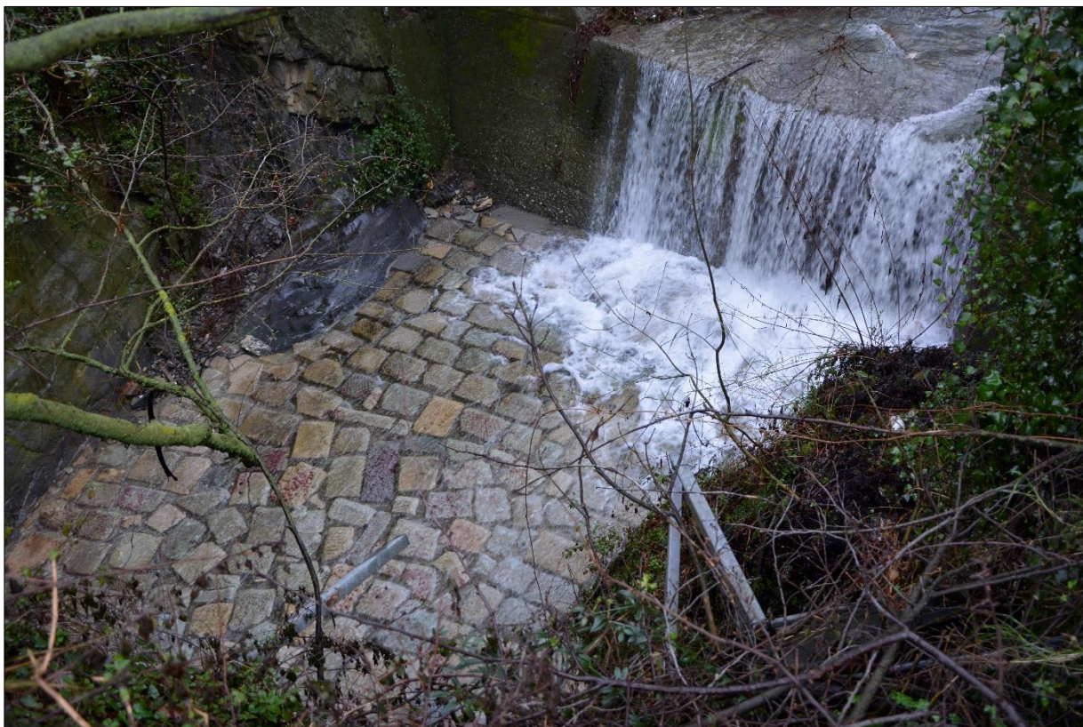
Foto 4 – briglia in cemento su canale artificiale (fonte: elaborato 110722-LL03-PE-S4-G13-GP13W-0-D-AUA4993-1)
