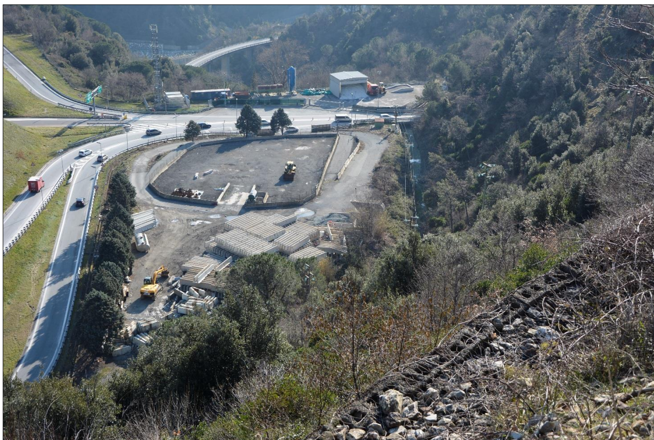
Figura 4 – Vista da ovest dell'area di pertinenza autostradale da cresta collinare (da sedime ferroviario), fonte: elaborato 110722-LL04-PE-A3-G16-GP16E-0-R-AUA1911-1, foto 1
