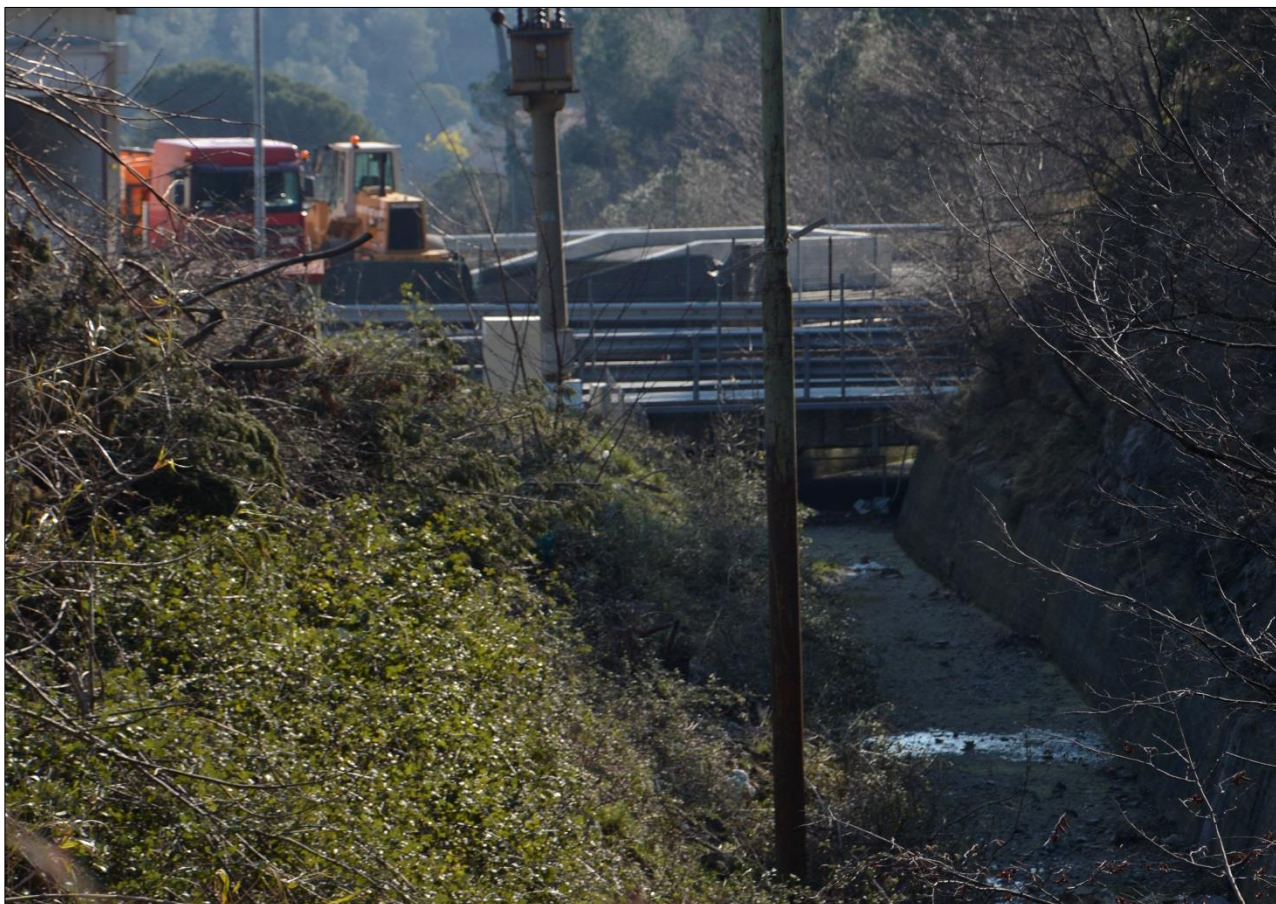
Figura 6 – tratto del canale prima del passaggio sotto l'autostrada esistente (fonte: elaborato 110722-LL04-PE-A3-G16-GP16E-0-R-AUA1911-1, zoom foto 3)
