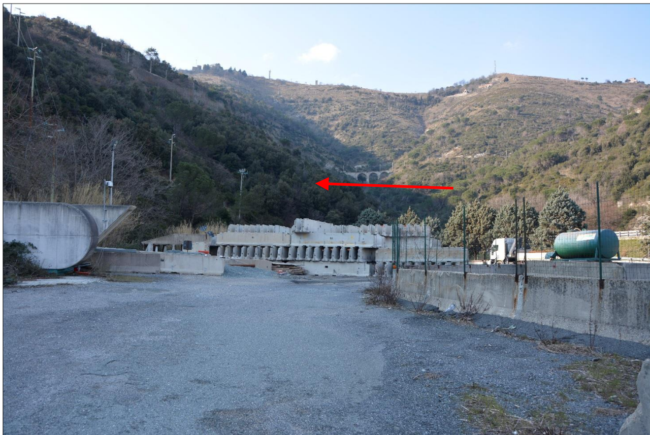
Figura 1 – Pineta degradata su versante nord con visibile la linea ferroviaria a mezza costa (con la freccia rossa indicata la zona di imbocco), fonte: elaborato 110722-LL04-PE-A3-G16-GP16E-0-D-AUA1912-1
