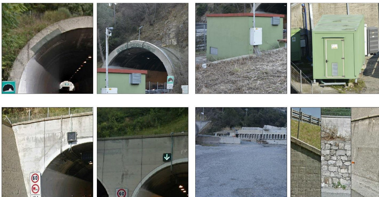
Figura 7 – Finiture rilevate nell'intorno dell'area di intervento (fonte: elaborato 110722-LL04-PE-A3-G16-GP16E-0-D-AUA1912-1)
