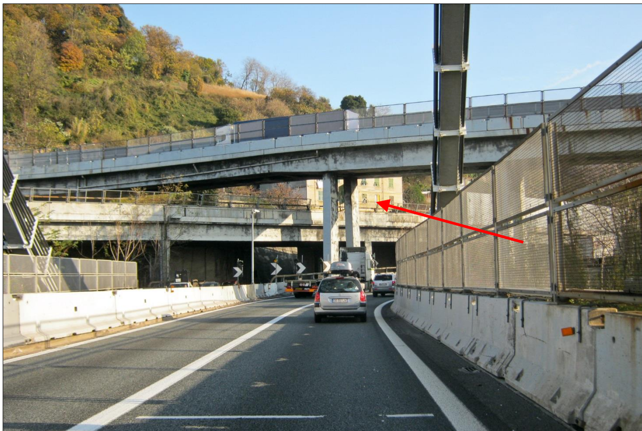
Foto 1 – Versante di fronte alla rampa elicoidale visto percorrendo il ponte Morandi (con la freccia rossa indicata la zona di intervento)
