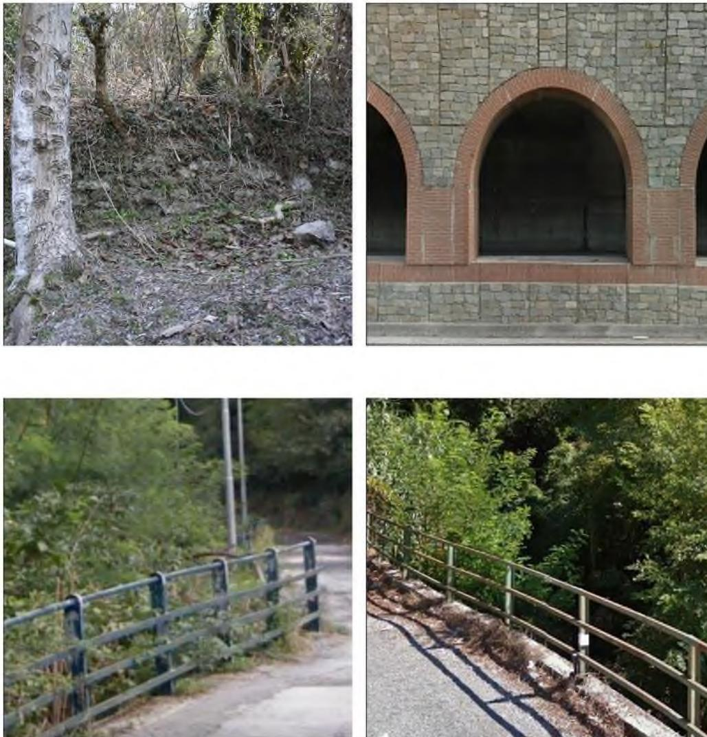
Figura 6-31 - Rivestimento muri galleria artificiale esistente, muri a secco e parapetti su strade secondarie (fonte – elaborato 110722-LL02-PE-A3-G12-GP12W-0-D-AUA1516-1)
