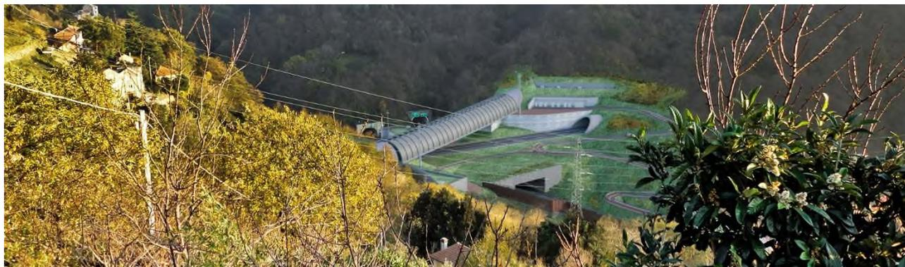
*Figura 12-11. FOA24: Copertura antifumi Viadotto Torbella.*
