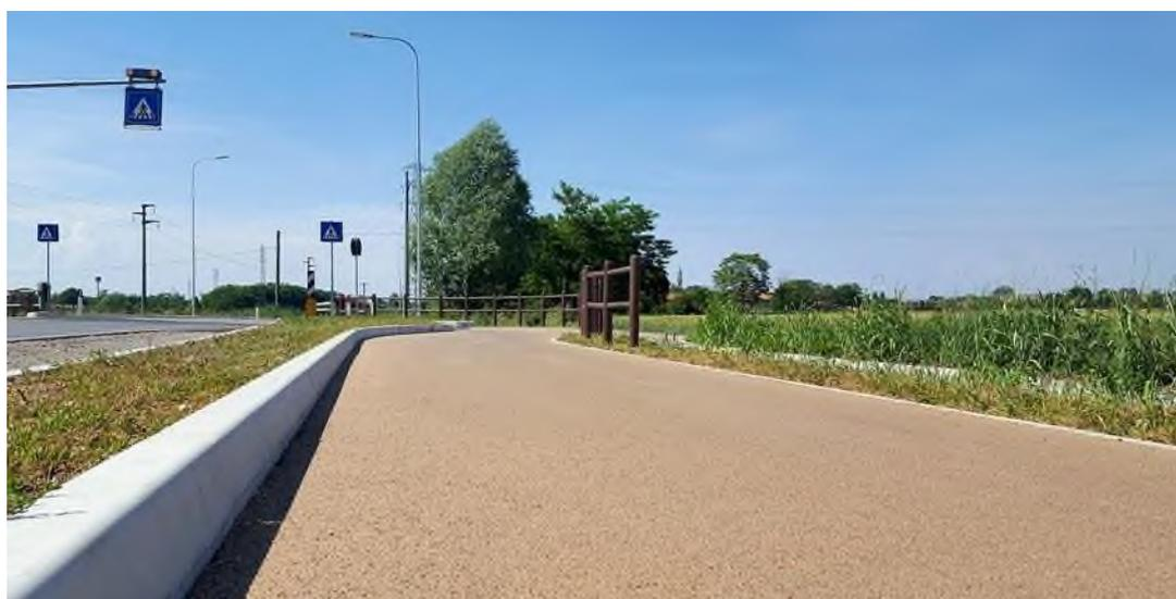
Figura 11-5. Esempio colorazione manto d'usura delle viabilità permanenti.
