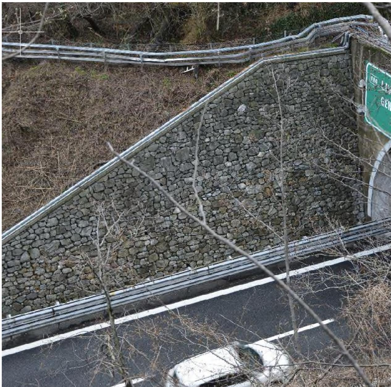
Figura 7-36 – Rivestimento muro in C.A. lungo l'autostrada esistente (fonte: elaborato 110722-LL03-PE-A3-G16-GP16N-0-D-AUA3743-1)
