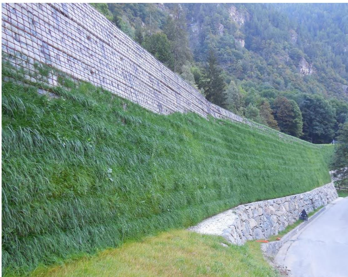
Figura 11-4. Esempio di realizzazione terra rinforzata verde.
