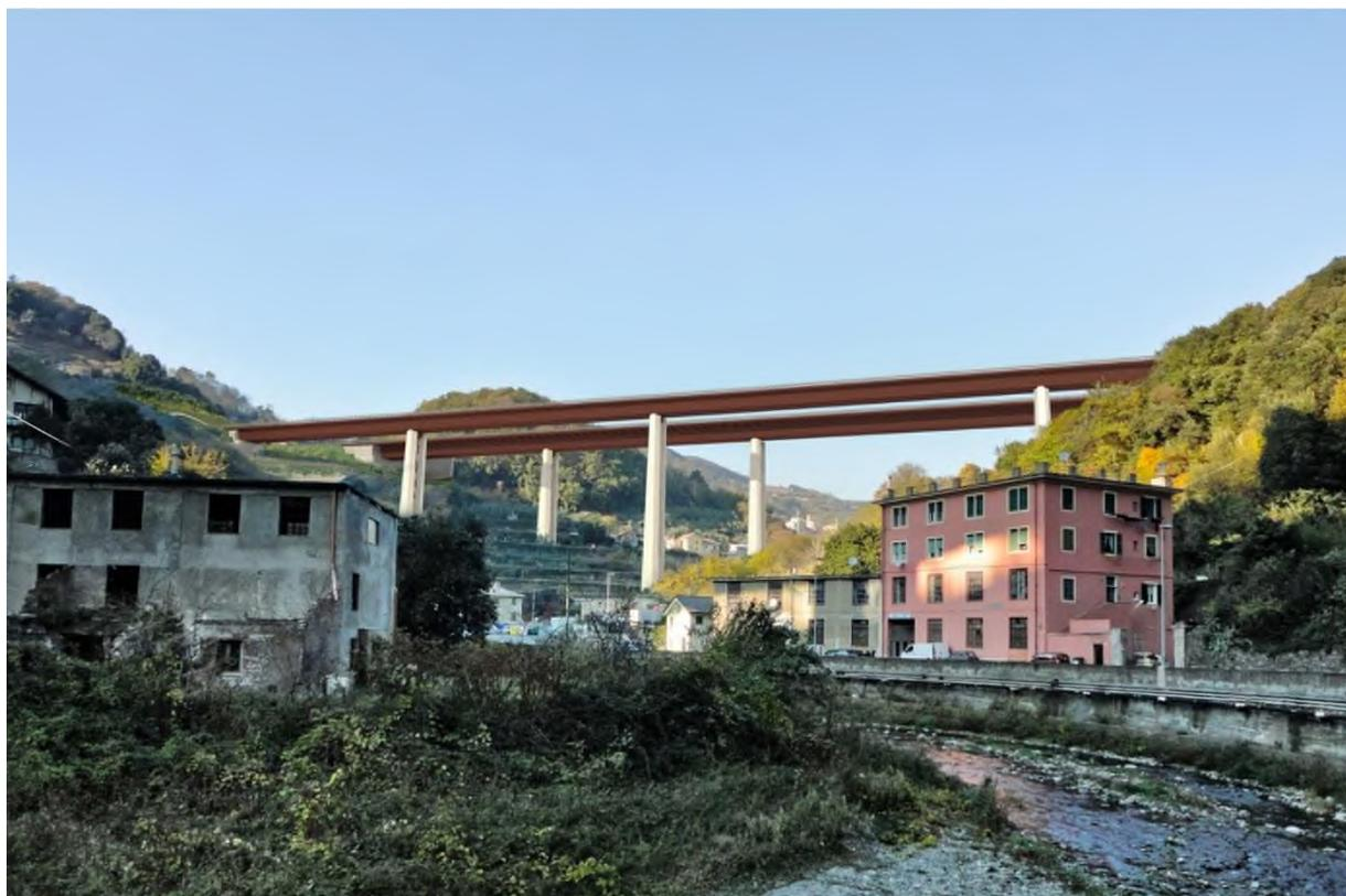
Figura 9-36. Progetto Definitivo Viadotto Leiro, con materiale impalcato e tralicciatura pile in acciaio corten .
