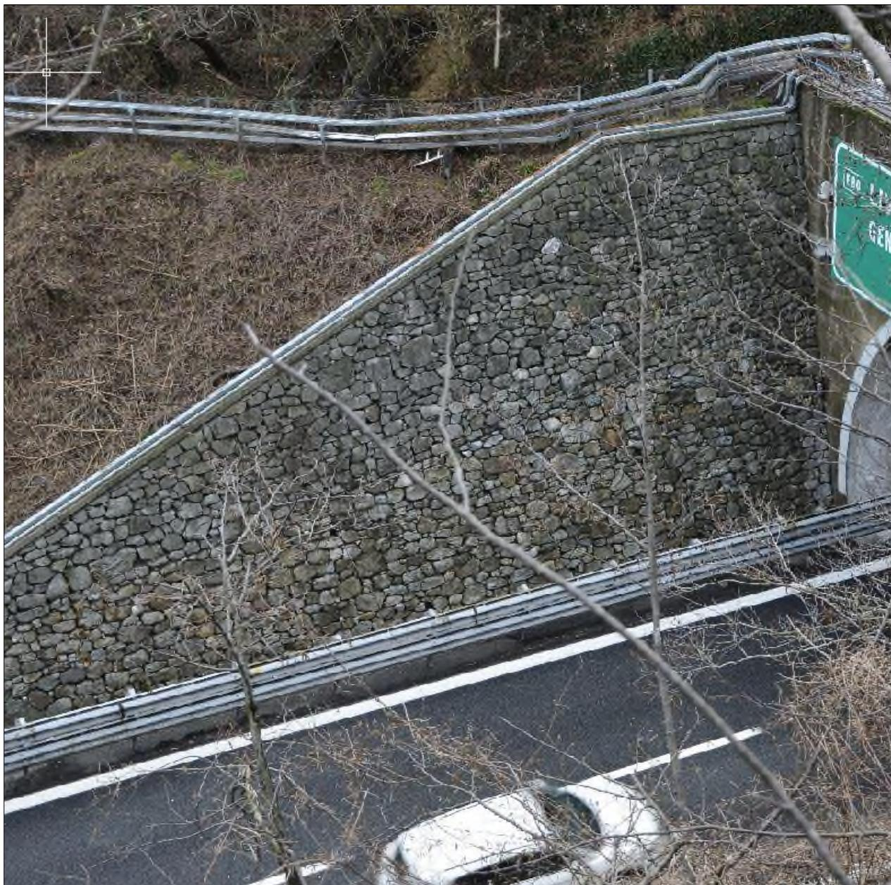
Figura 7-21 – Rivestimento muro in C.A. lungo l'autostrada esistente (fonte: elaborato 110722-LL03-PE-S4-G13-GP13W-0-D-AUA4993-1)
