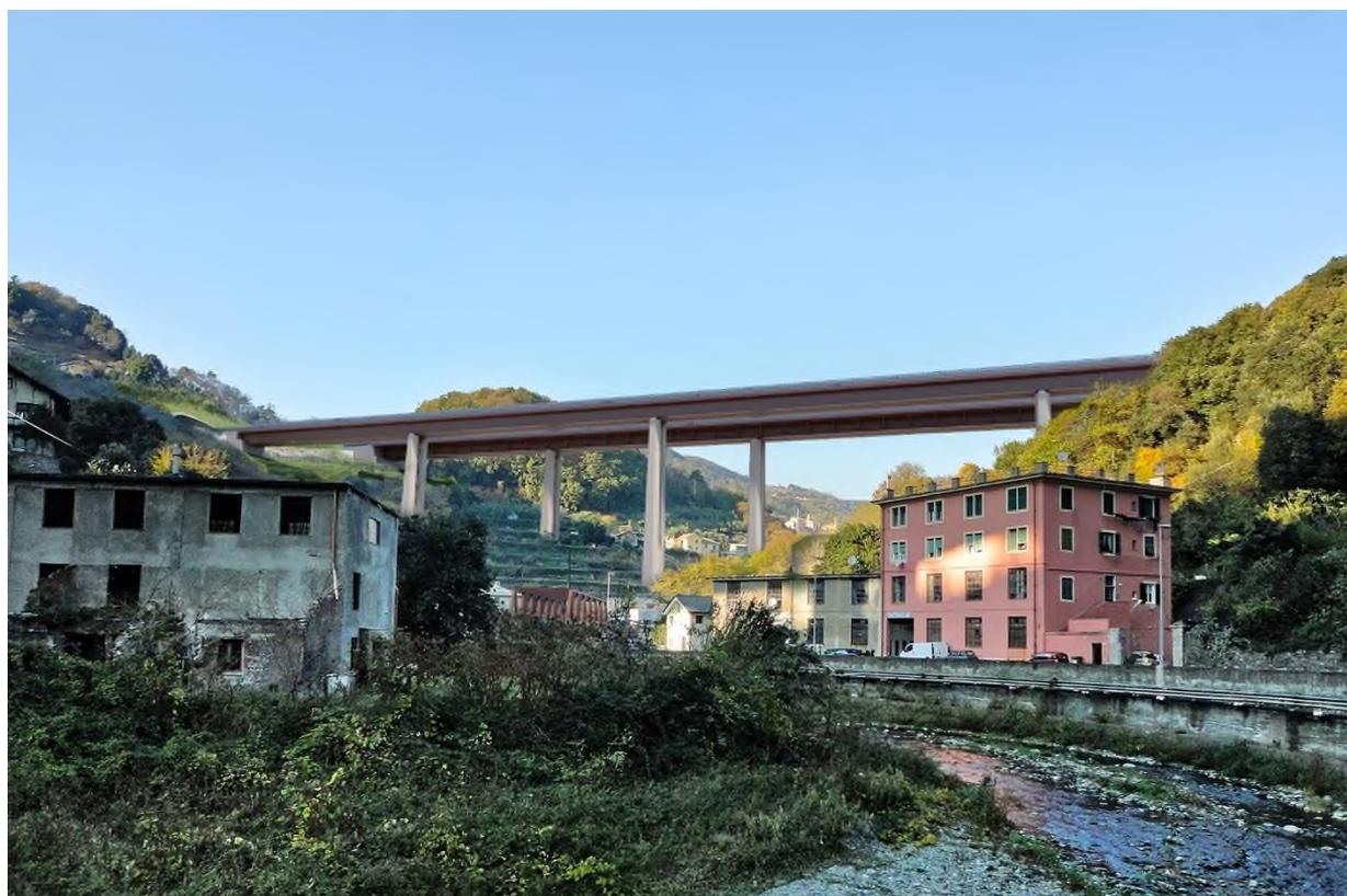
Figura 9-37. Progetto Esecutivo Viadotto Leiro, con materiale impalcato e tralicciatura pile in acciaio verniciato.
