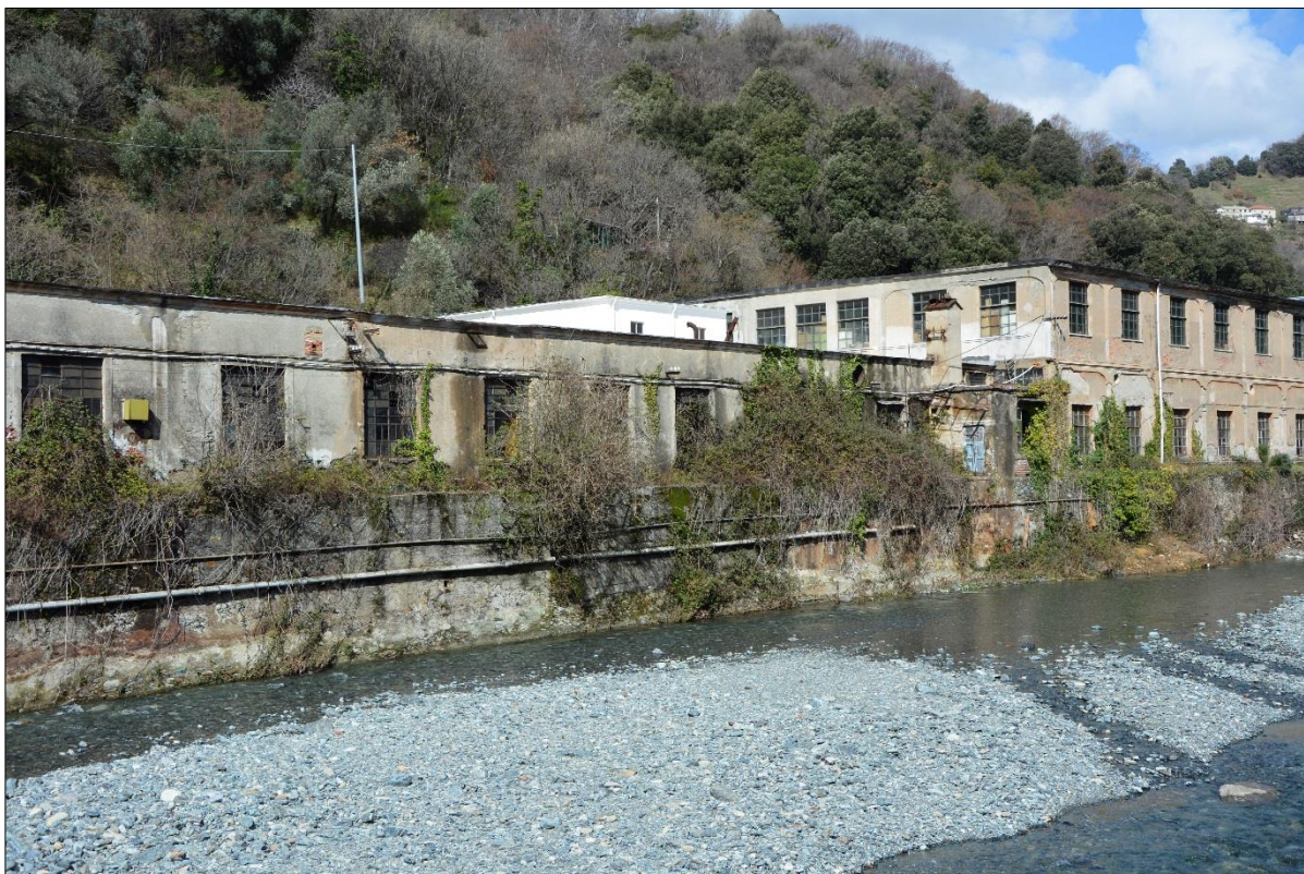
Foto 5 – edifici produttivi in disuso (fonte: elaborato 110728-LL8C-PE-A1-G01-GP01E-0-R-AUA0656-1, foto 9)
