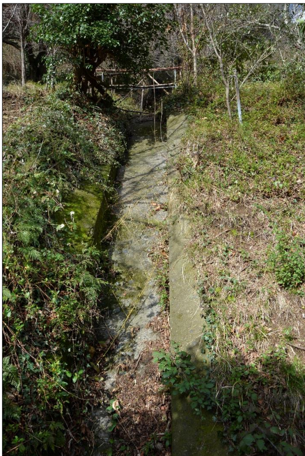
Foto 7 – tratto di corso d'acqua rivestito in calcestruzzo (fonte: elaborato 110728-LL8C-PE-A1-G01-GP01E-0-D-AUA0657-1)
