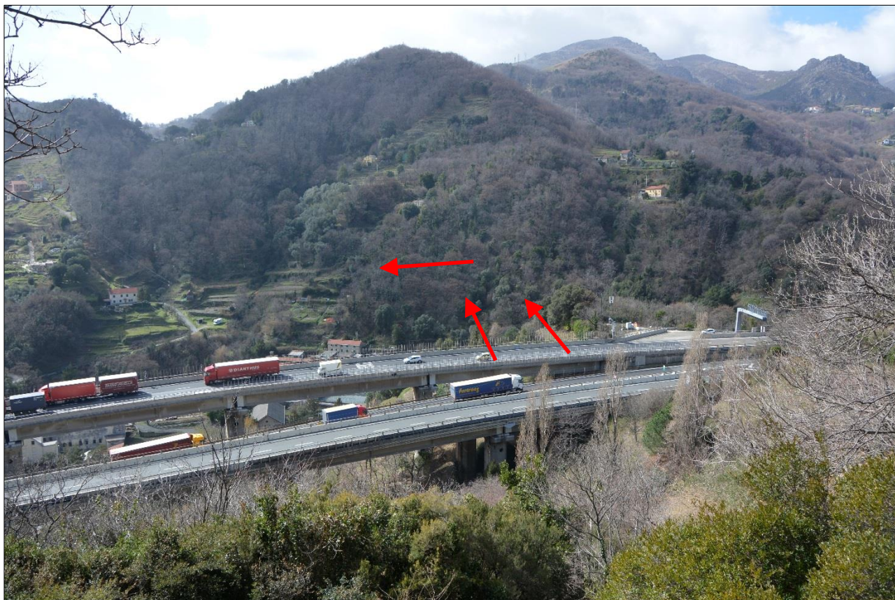
Foto 1 – Vista dell'area di intervento dal versante opposto della valle (le frecce rosse indicano le zone di imbocco), fonte elaborato: 110721-LL1A-PE-DG-IPG-00000-0-R-AUA0041-1, area Voltri zoom dal punto di scatto della foto 11
