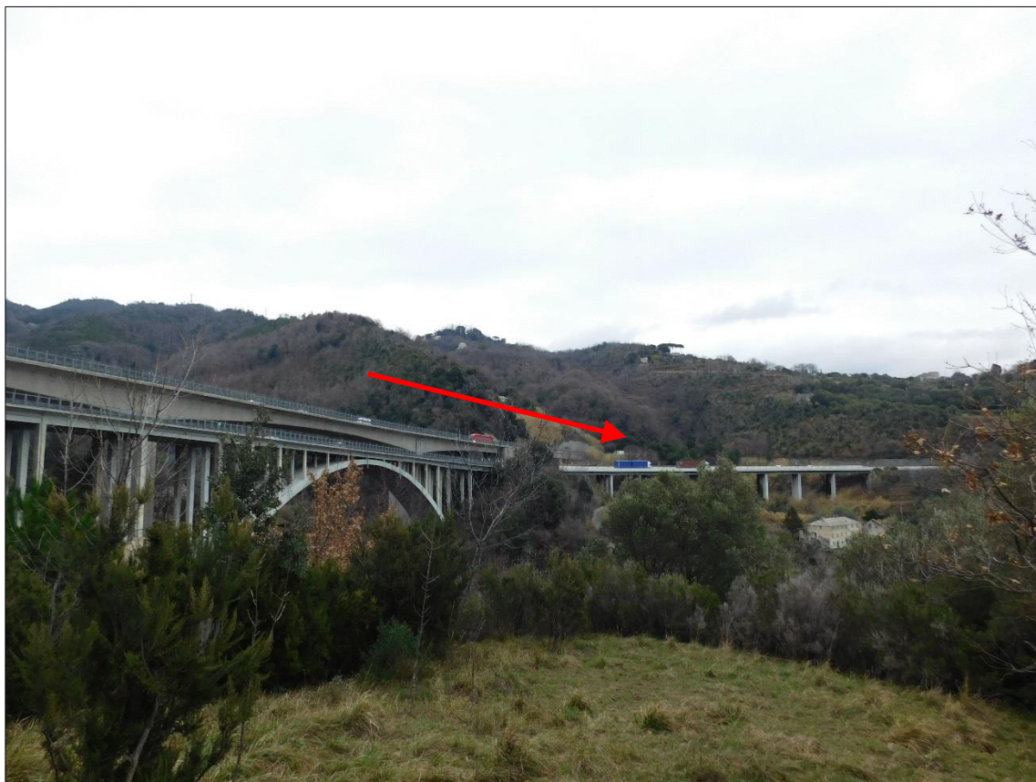
Foto 1 – Vista da lontano dell'area di intervento (con la freccia rossa indicata la zona di imbocco), fonte: elaborato 110721-LL1A-PE-DG-IPG-00000-0-R-AUA0041-1, area Vesima foto 4
