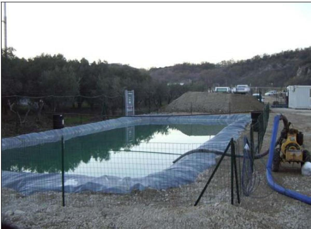
**Figura 4.19: Vascone per lo Stoccaggio in Cantiere dell'Acqua Industriale**
