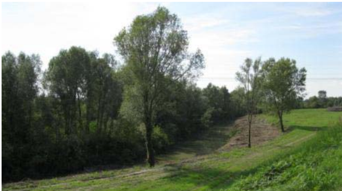
Figura 4.3: Fiume Santerno (a Nord dell'Abitato di Voltana, presso Cluster E)
