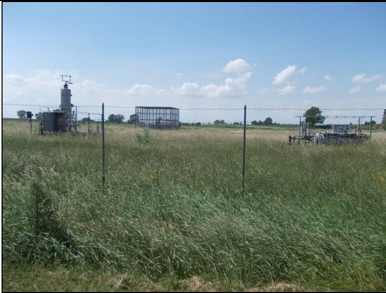
Foto 62: Cluster A: Area di intervento centrale di stoccaggio
