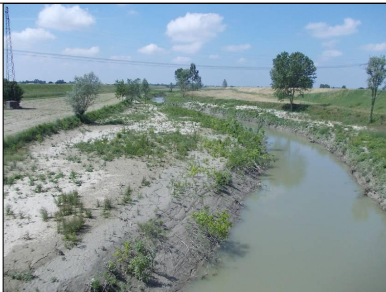
Foto 17: Fiume Santerno a valle del Ponte della S.S. 16
