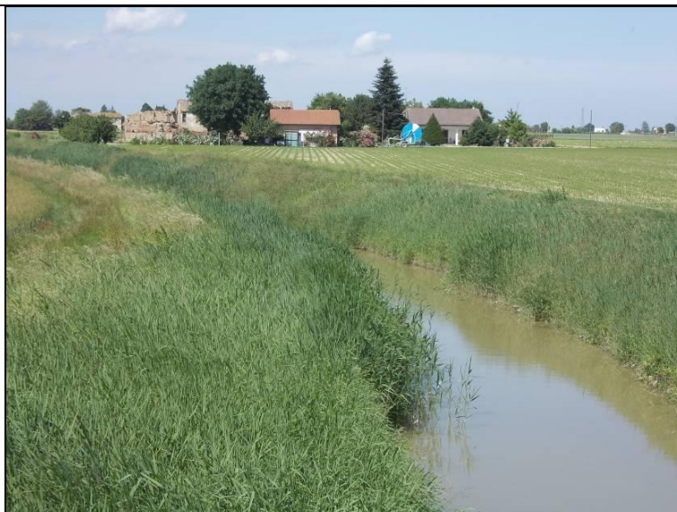
Foto 78: Canale Tratturo nel punto di attraversamento delle condotte
