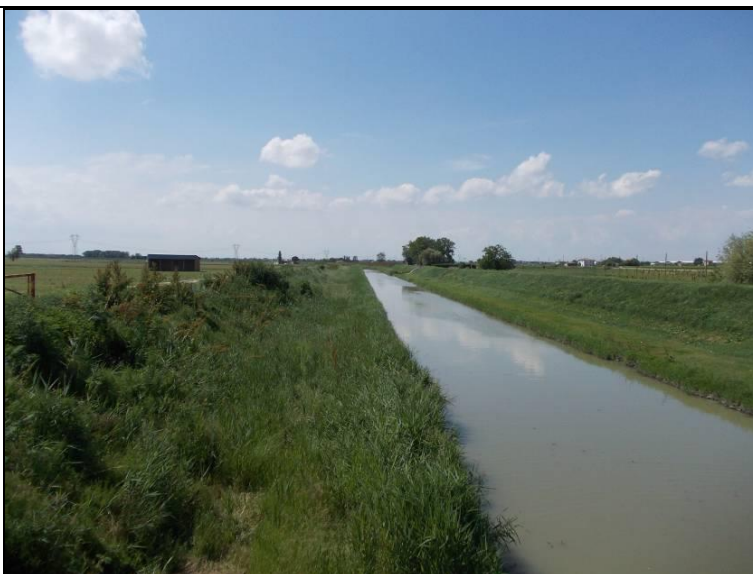
Foto 68: La Canalina nei pressi dell'Area pozzo Valledane 1 e del Cluster C
