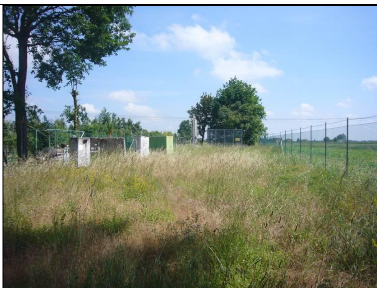
Foto 02: Area pozzo n. 13
