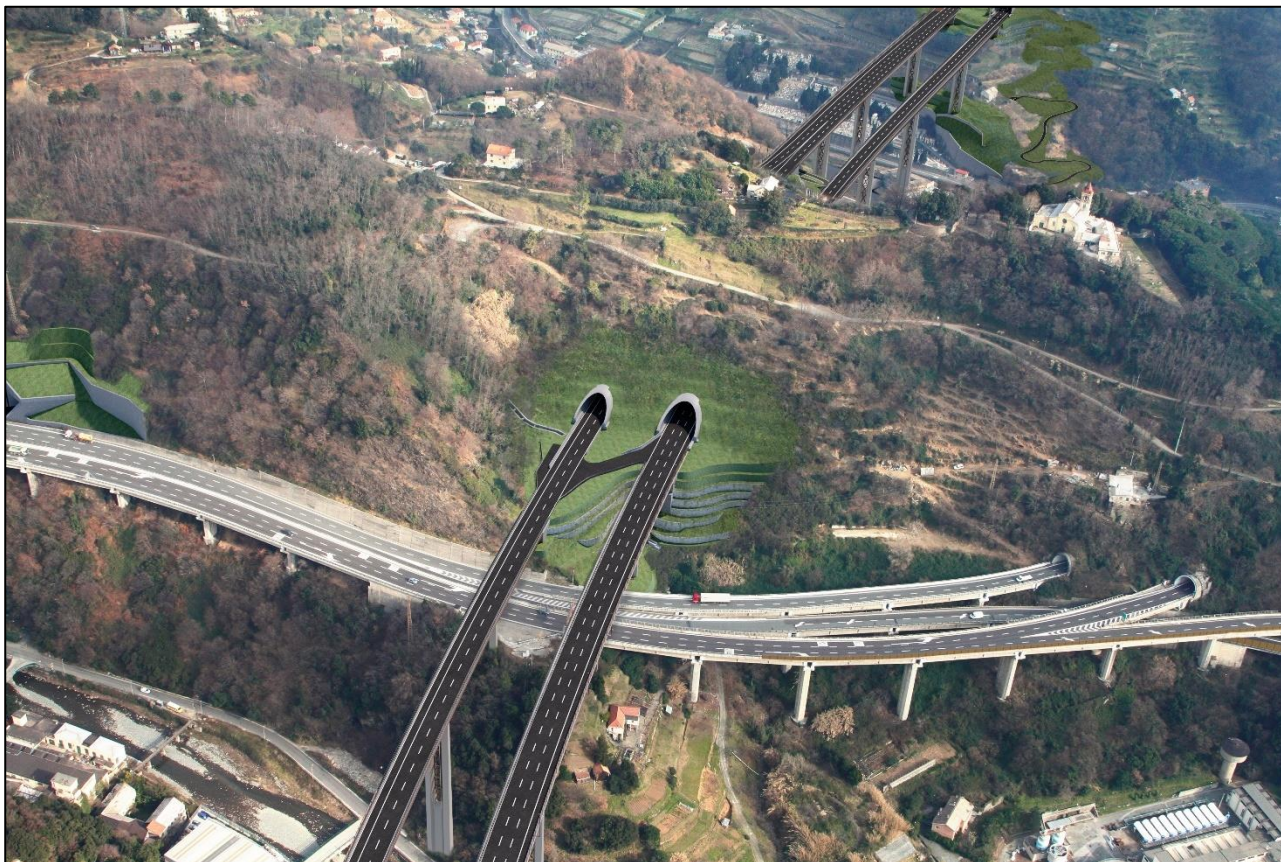
Figura 6 – foto inserimento area di imbocco a volo di uccello (fonte: elaborato 110725-LL9B-PE-DG-IPG-00000-00000-R-AUA0043-0, foglio 20/36)
