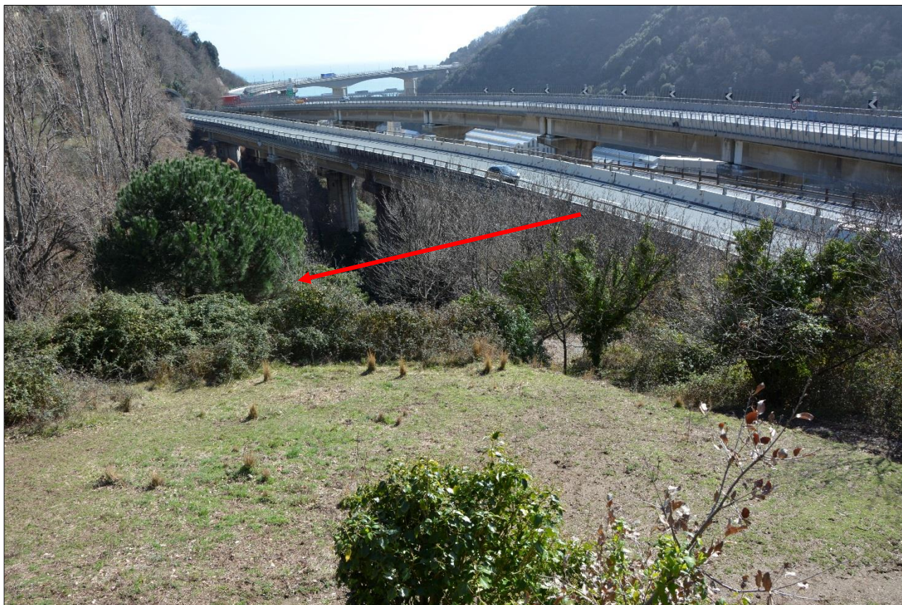
Foto 1 – Vista dall'area di intervento (indicata con freccia rossa) verso il tracciato esistente (fonte: elaborato 110728-LL8C-PE-A1-G03-GP03W-0-R-AUA1491-1, foto 8)
