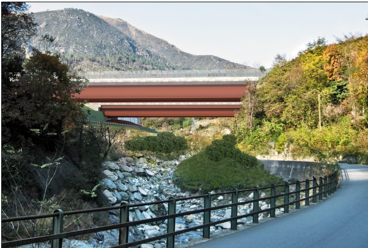
Figura 8 - foto inserimento dal fondovalle verso nuovo imbocco (fonte: elaborato 110725-LL9B-PE-DG-IPG-00000-00000-R-AUA0042-0, foto 21)
