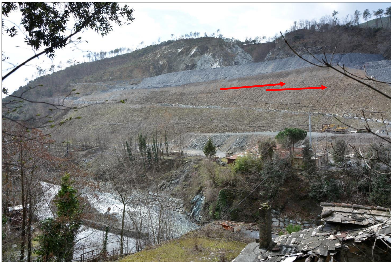
Foto 1 – Vista verso i nuovi imbocchi (indicati con freccia rossa), fonte: elaborato 110728-LL8C-PE-A1-G06-GP06E-0-R-AUA2081-1, foto 2
