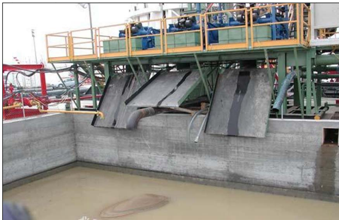
Figura 2.2: Scarto e Raccolta Detriti e Fango di Perforazione
