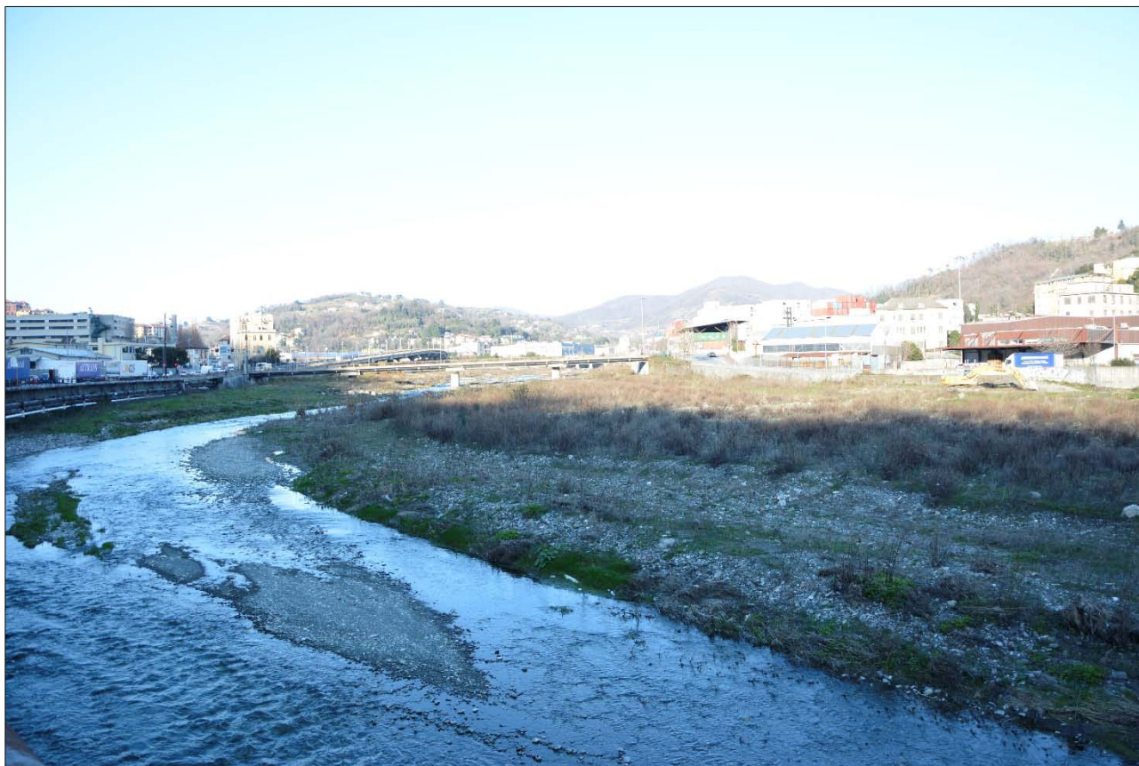
Foto 6 – vegetazione erbaceo arbustiva occasionale d'alveo di scarsa valenza (fonte: elaborato 110728-LL8C-PE-A1-G07-GP07E-0-D-AUA3003-1)
