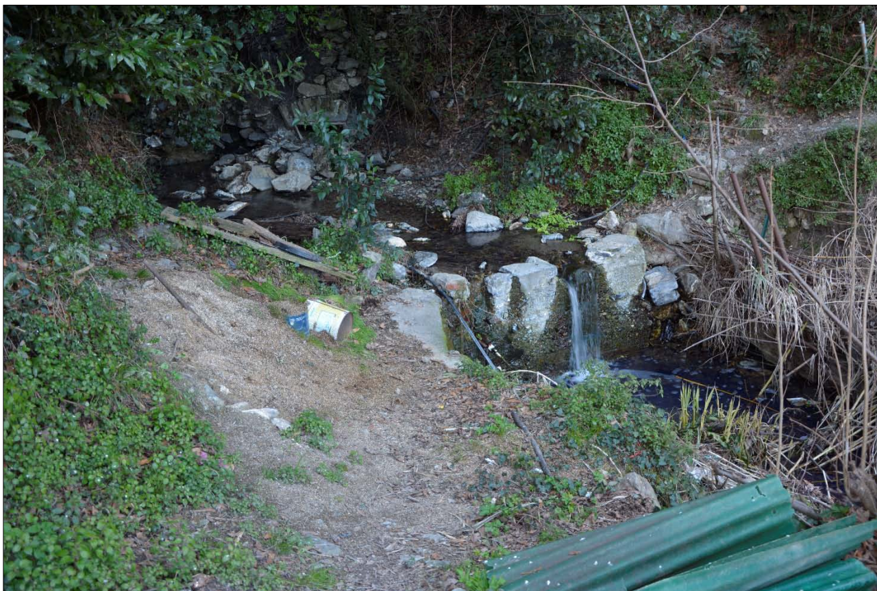
Foto 7 – briglia su corso d'acqua in alveo naturale a monte prima del tratto intubato di valle (fonte: elaborato 110728-LL8C-PE-A1-G07-GP07E-0-D-AUA3003-1)
