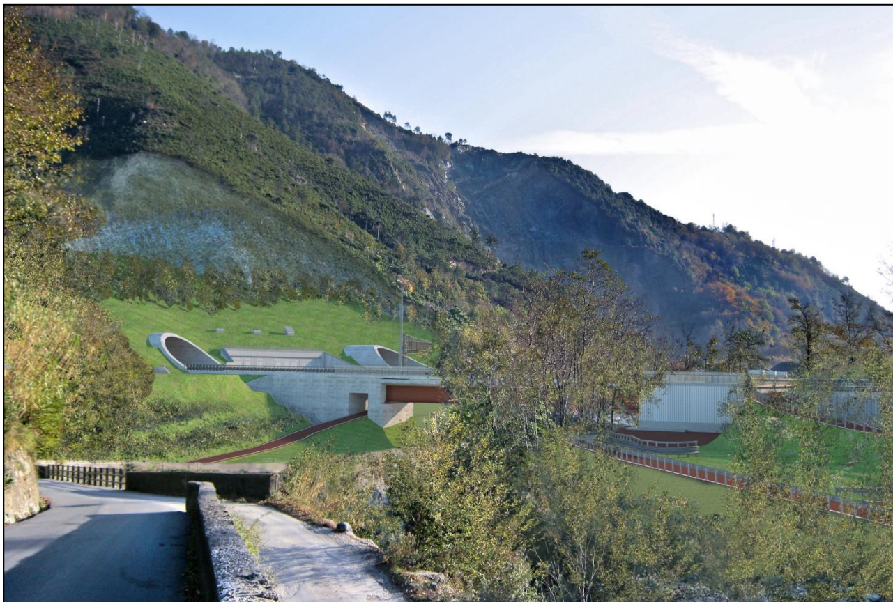
Figura 6 - foto inserimento dal fondovalle verso nuovo imbocco (fonte: elaborato 110725-LL9B-PE-DG-IPG-00000-00000-R-AUA0042-0, foto 22)
