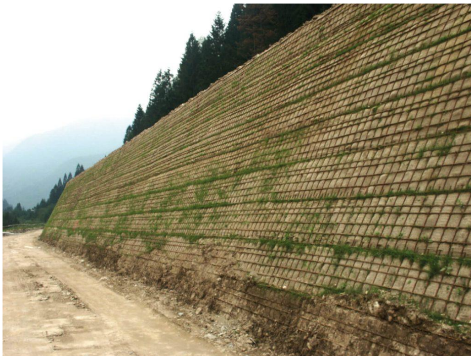
Figura 3-1. Esempio di muro in terra rinforzata
