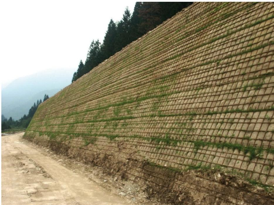
Figura 3-1. Esempio di muro in terra rinforzata
