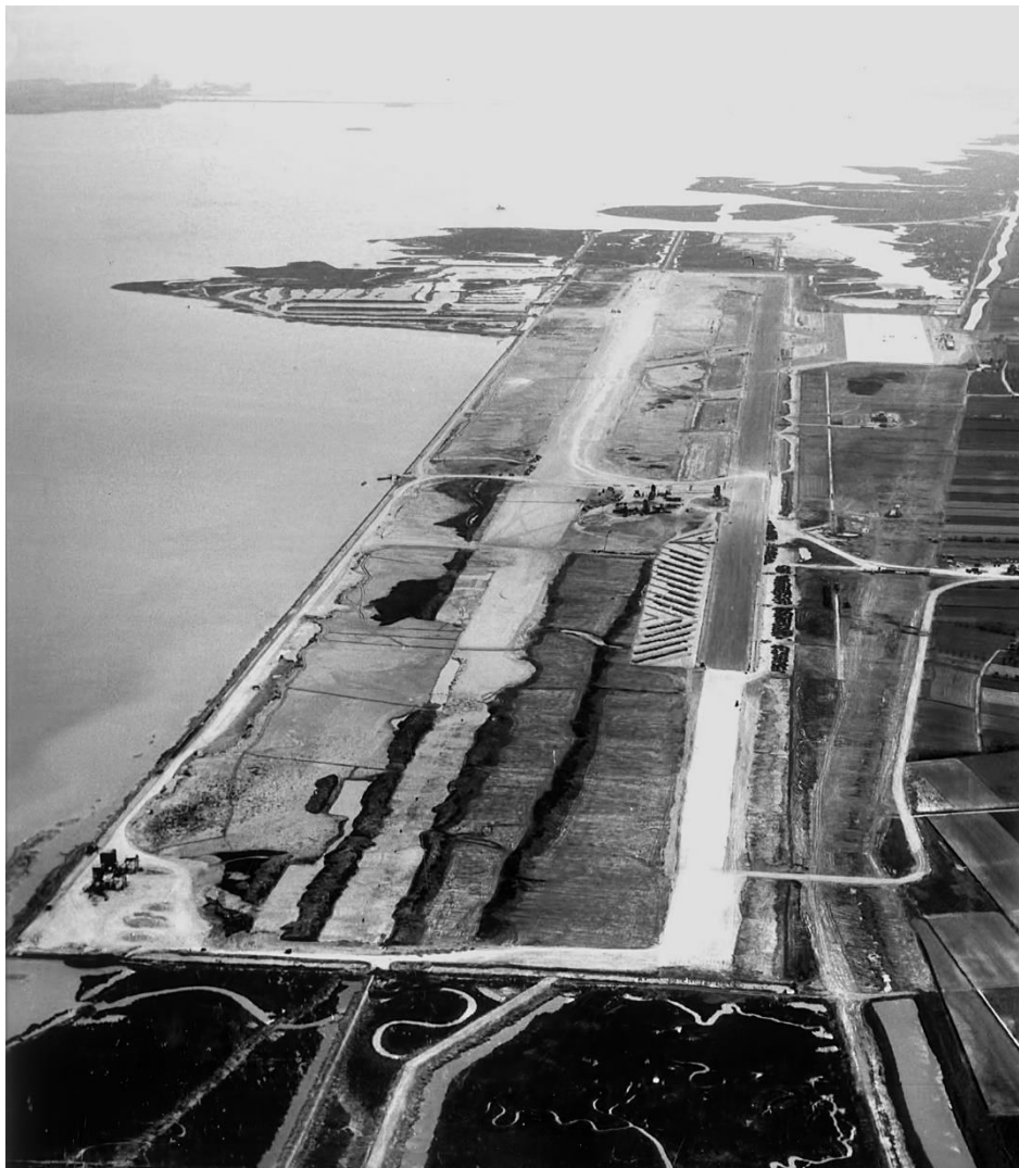
Figura 4-12 Foto scattata durante le fasi di costruzione della pista nel maggio 1960 (Fonte: Resini, 2008 11 ).
