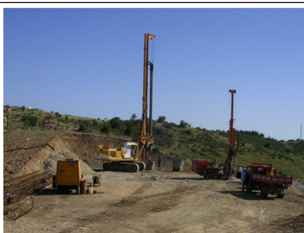
Realizzazione pali trivellati
