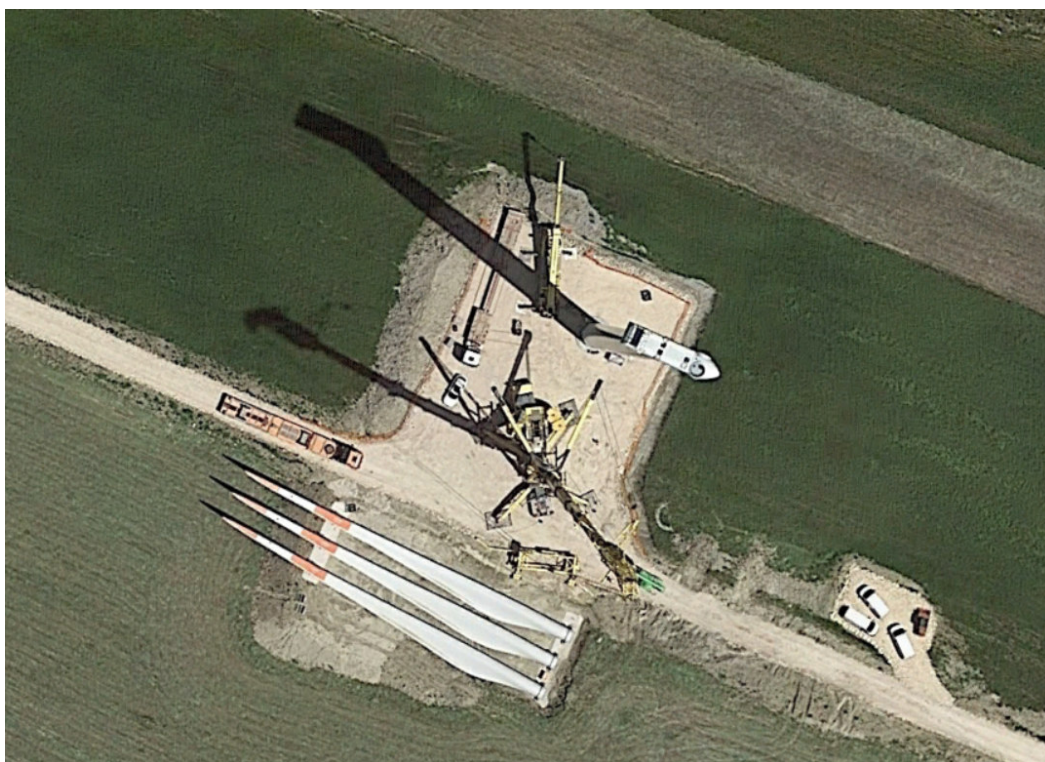
Figura 2.6 – esempio di piazzola in fase di costruzione
